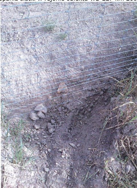
Brak wkopania siatki i wyrównania terenu.
