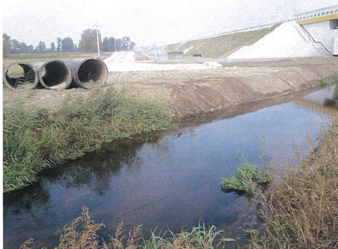
Pozostałości tymczasowego zarurowania przy rz. Malinie
