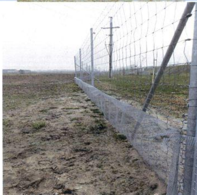
ogrodzenie z siatką dogęszczającą d= 8 x 8 mm
