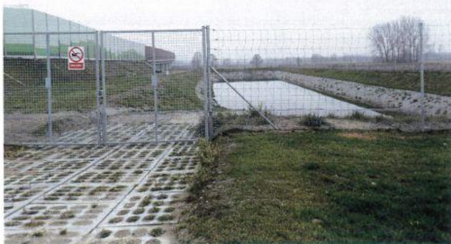
brama do Zbiornika retencyjno-infiltracyjnego nr 30
