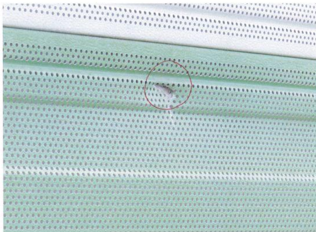
uszkodzenie paneli
