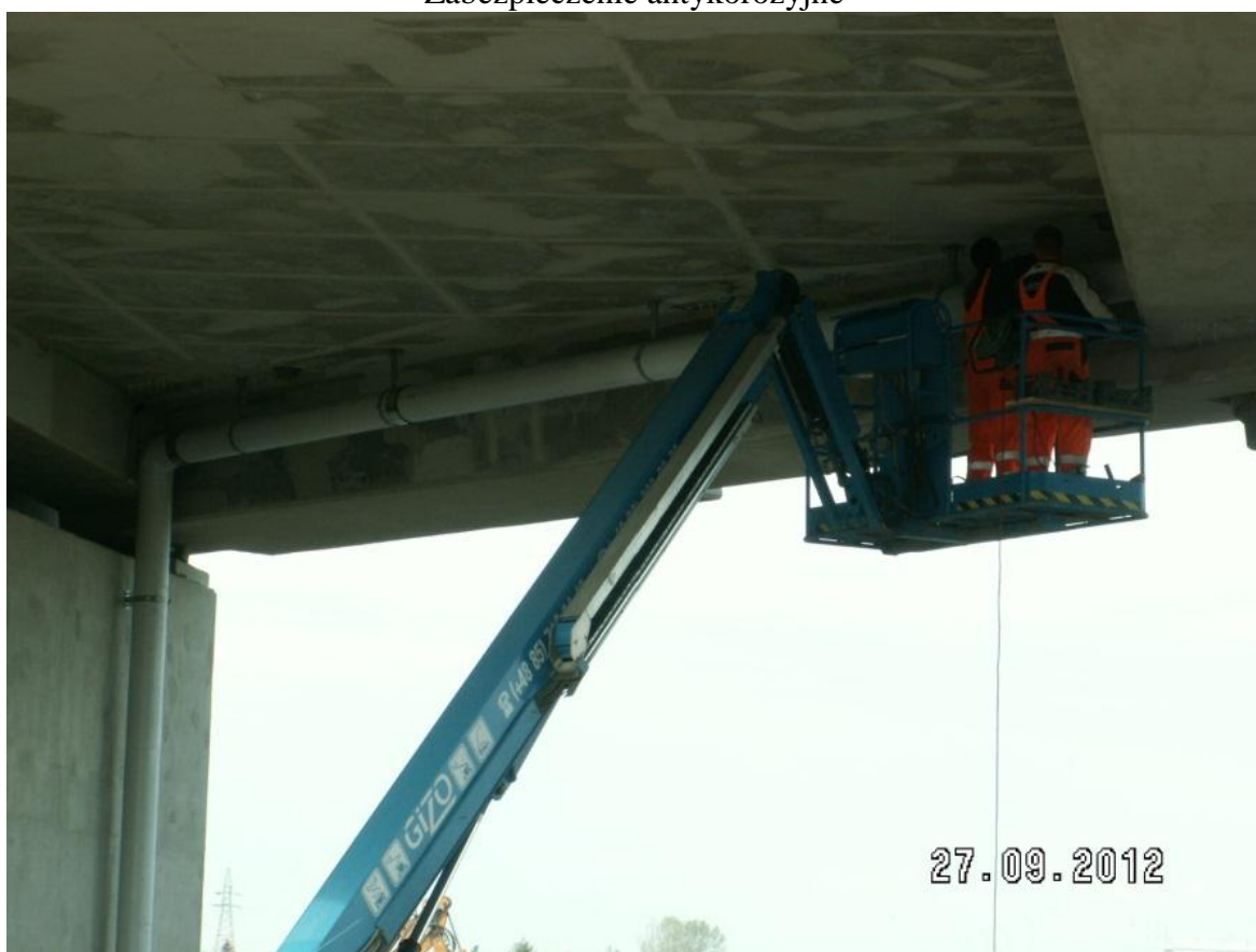
Montaż odwodnienia
