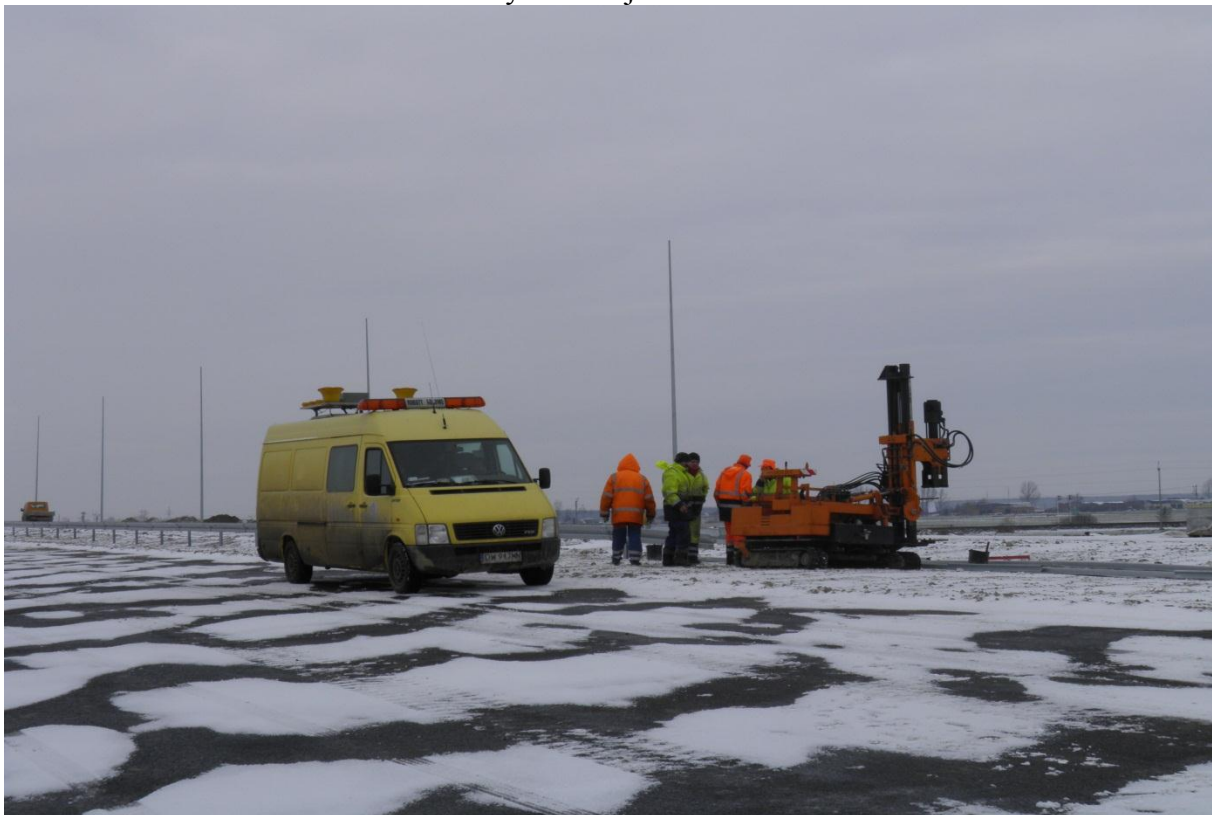
Montaż bariery stalowej SP-07 km 253+450
