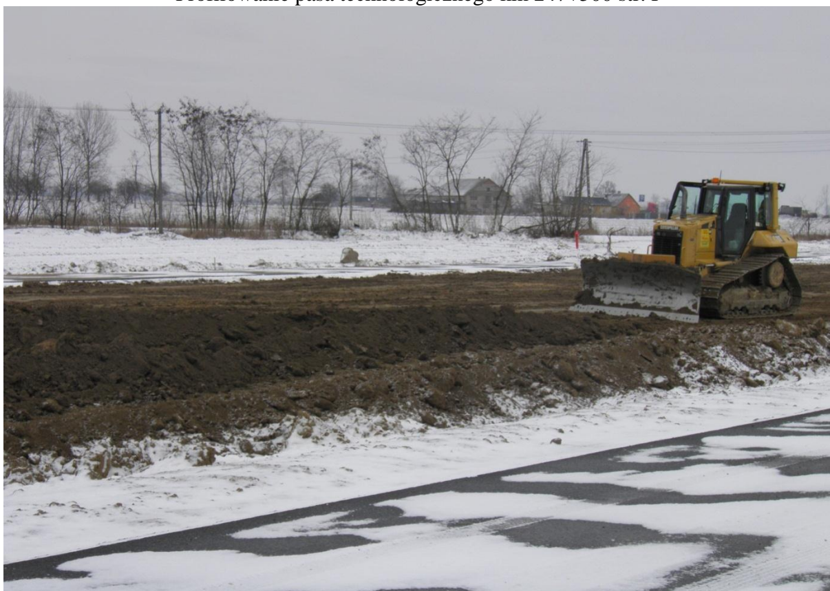
Profilowanie pasa technologicznego km 254+400 str. L
