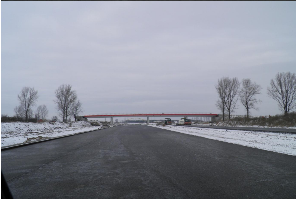
Wykonana I warstwa podbudowy z betonu asfaltowego o wysokim module sztywności km 258+870-258+990
