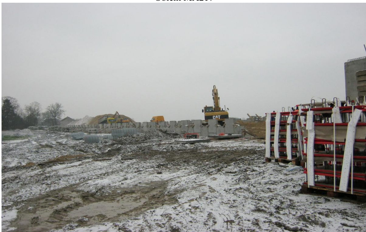
Ściana oporowa WD218
