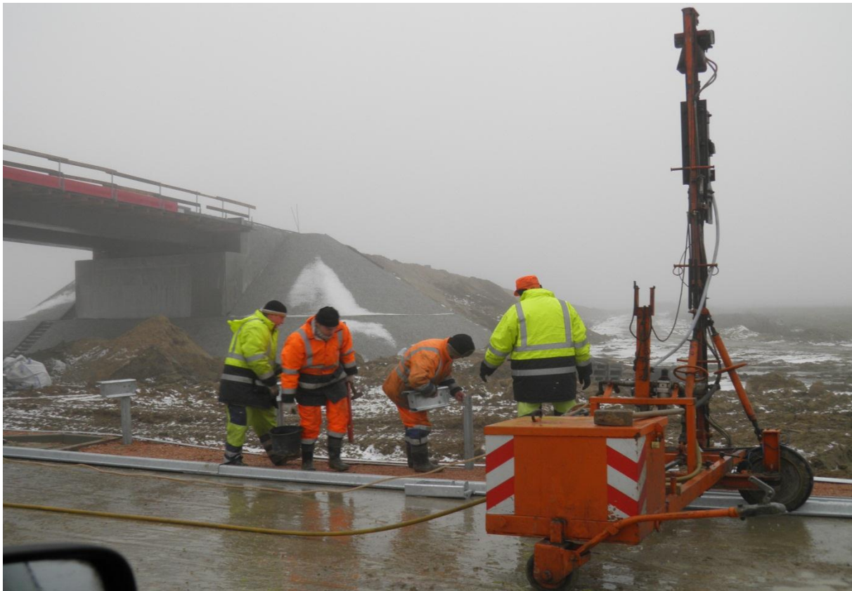
Montaż bariery stalowej SP-01 km 251+270
