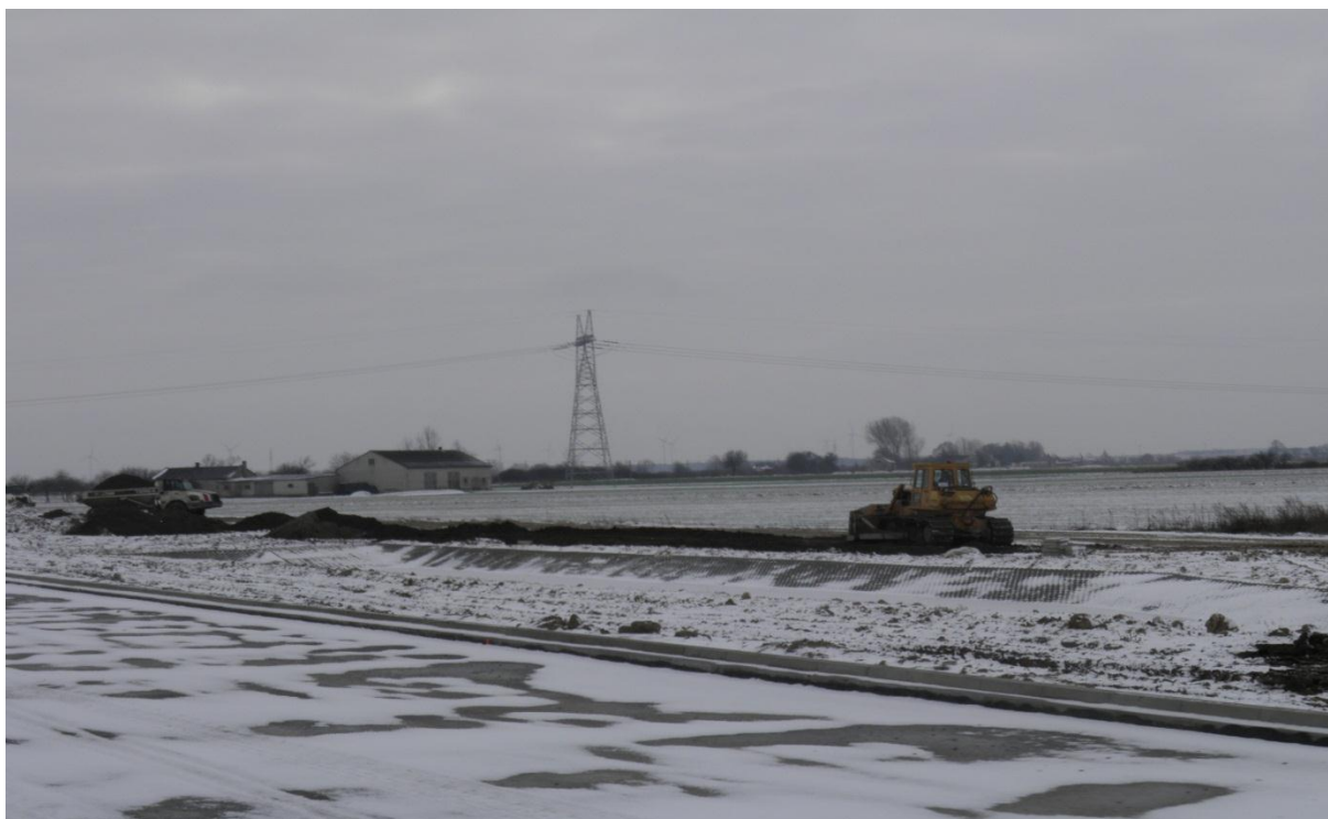
Profilowanie pasa technologicznego km 247+500 str. P
