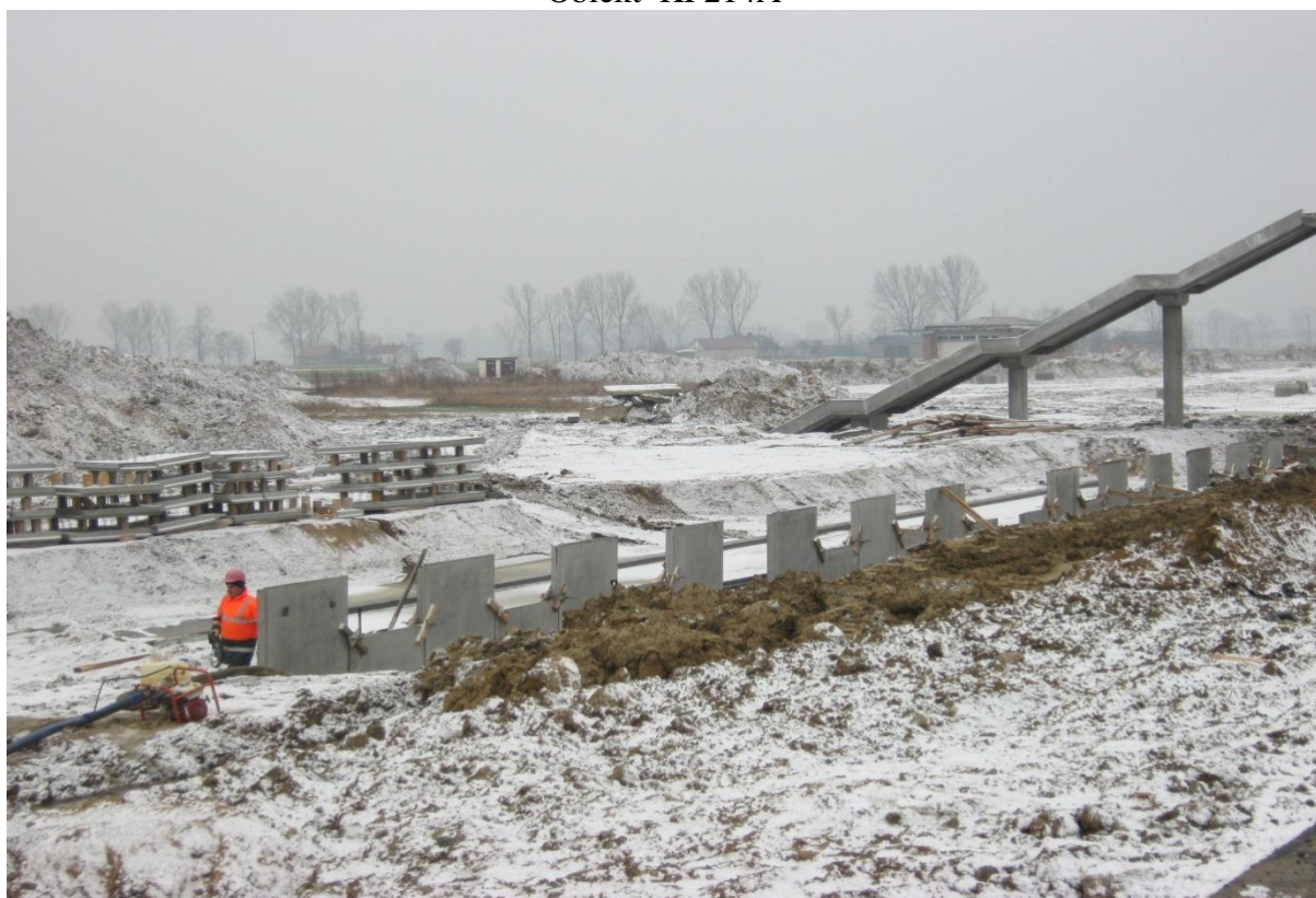
Ściana oporowa KP214A
