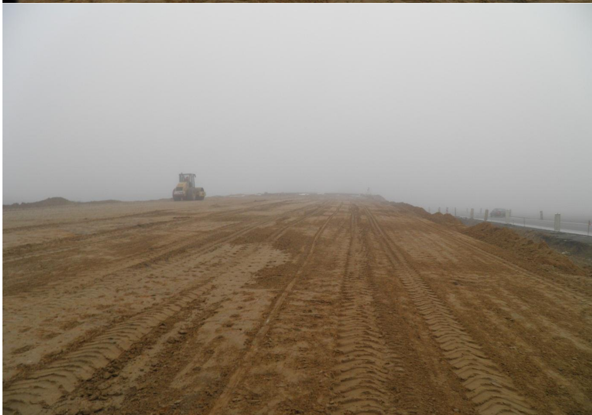
Profilowanie i zagęszczanie górnej warstwy nasypu DK92 km 1+250-1+370
