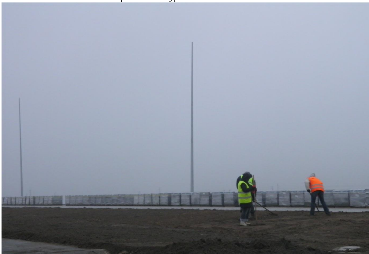
Humusowanie pasa środkowego km 253+500
