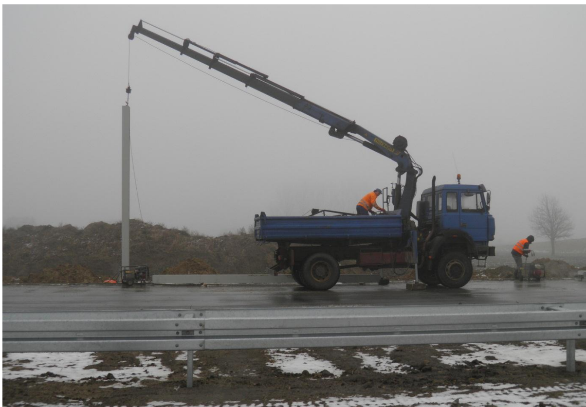
Montaż słupa: Ekran EA2 km 250+800 - 251+950
