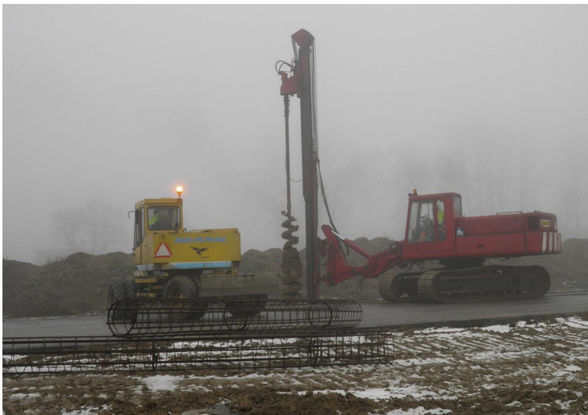
Odwiert pali fundamentowych: Ekran EA4 km 254+450 - 255+480
