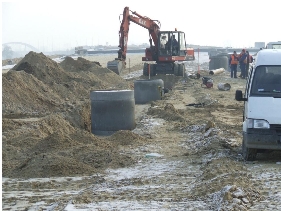
Budowa kanalizacji KD8
