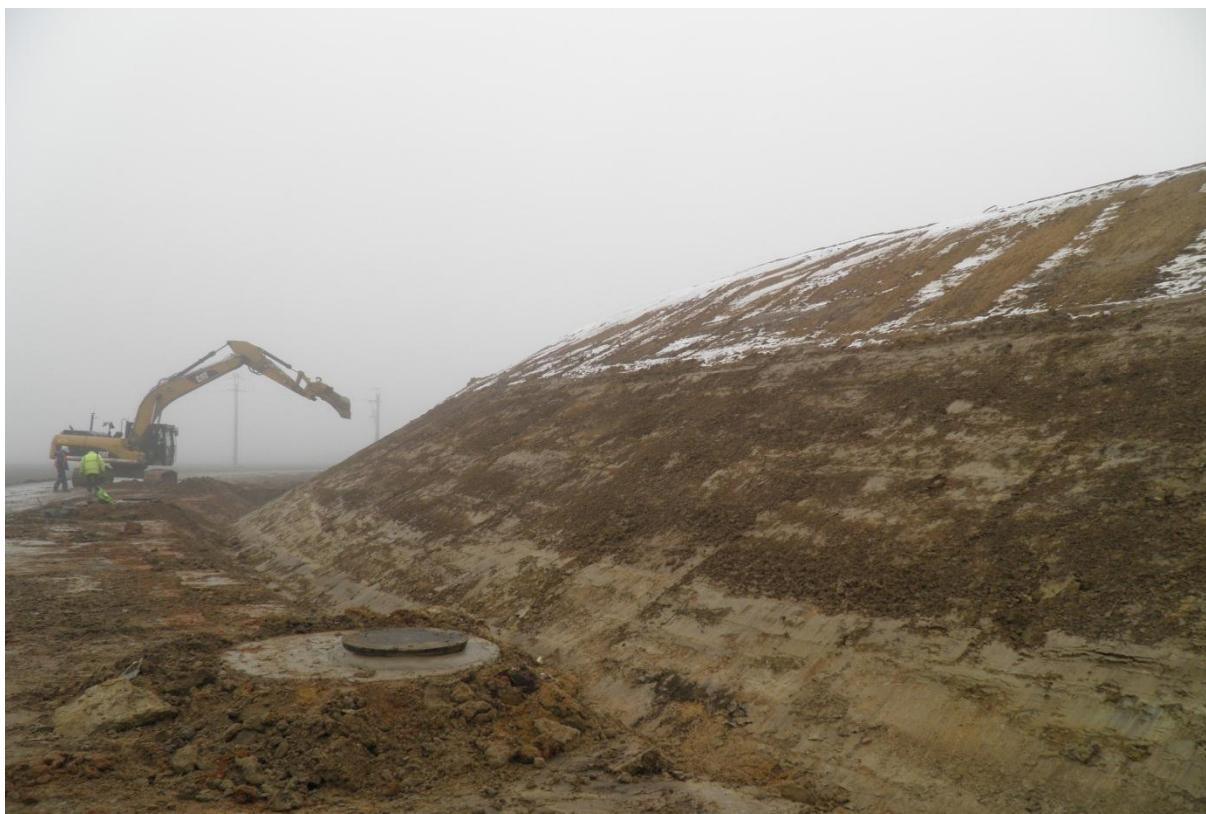
Skarpowanie nasypu ŁBC km 0+200 str. L
