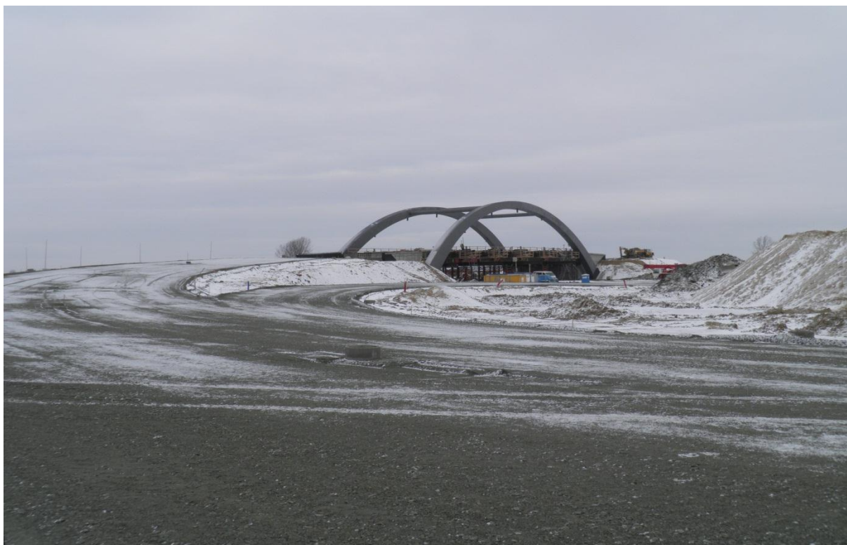
Wykonana I warstwa podbudowy z kruszywa łamanego 0/31,5 stabilizowanego mechanicznie Łącznica BC km 0+504-0+650 , Łącznica C1
