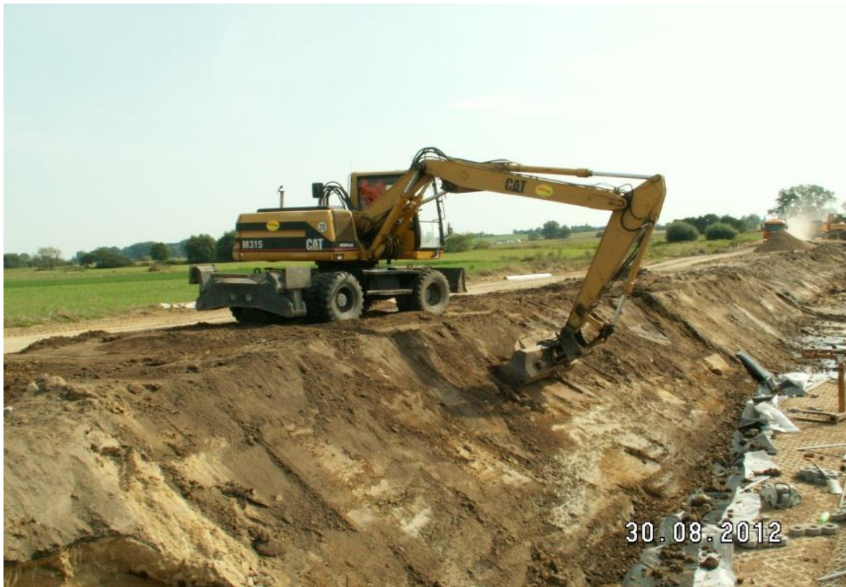
Budowa zbiornika ZB20
