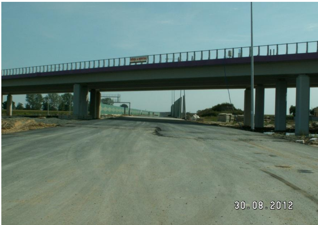
Podbudowa i warstwa wiążąca.
