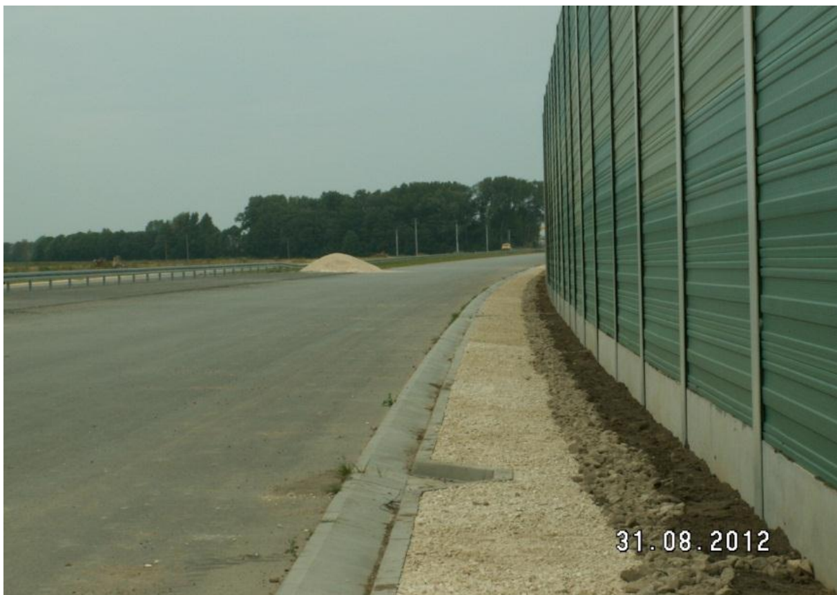
Drenaż przy ekranach.
