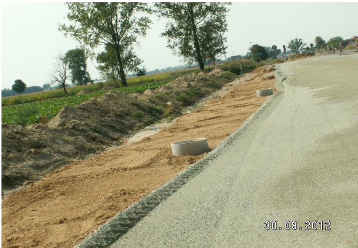
Stabilizacja mechaniczna DK92
