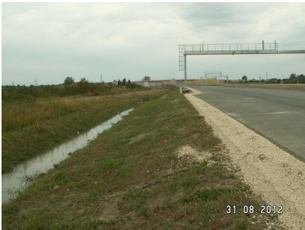
Wzmocnienie poboczy kruszywem.
