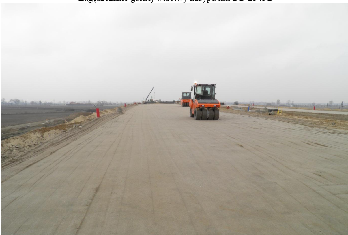
Zagęszczanie górnej warstwy nasypu km 253+000-253+150
