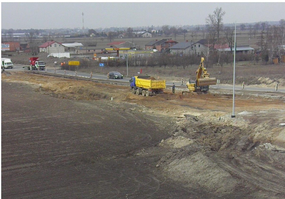
Rozbiórka i korytowanie drogi krajowej nr 92 km 0+450-0+530
