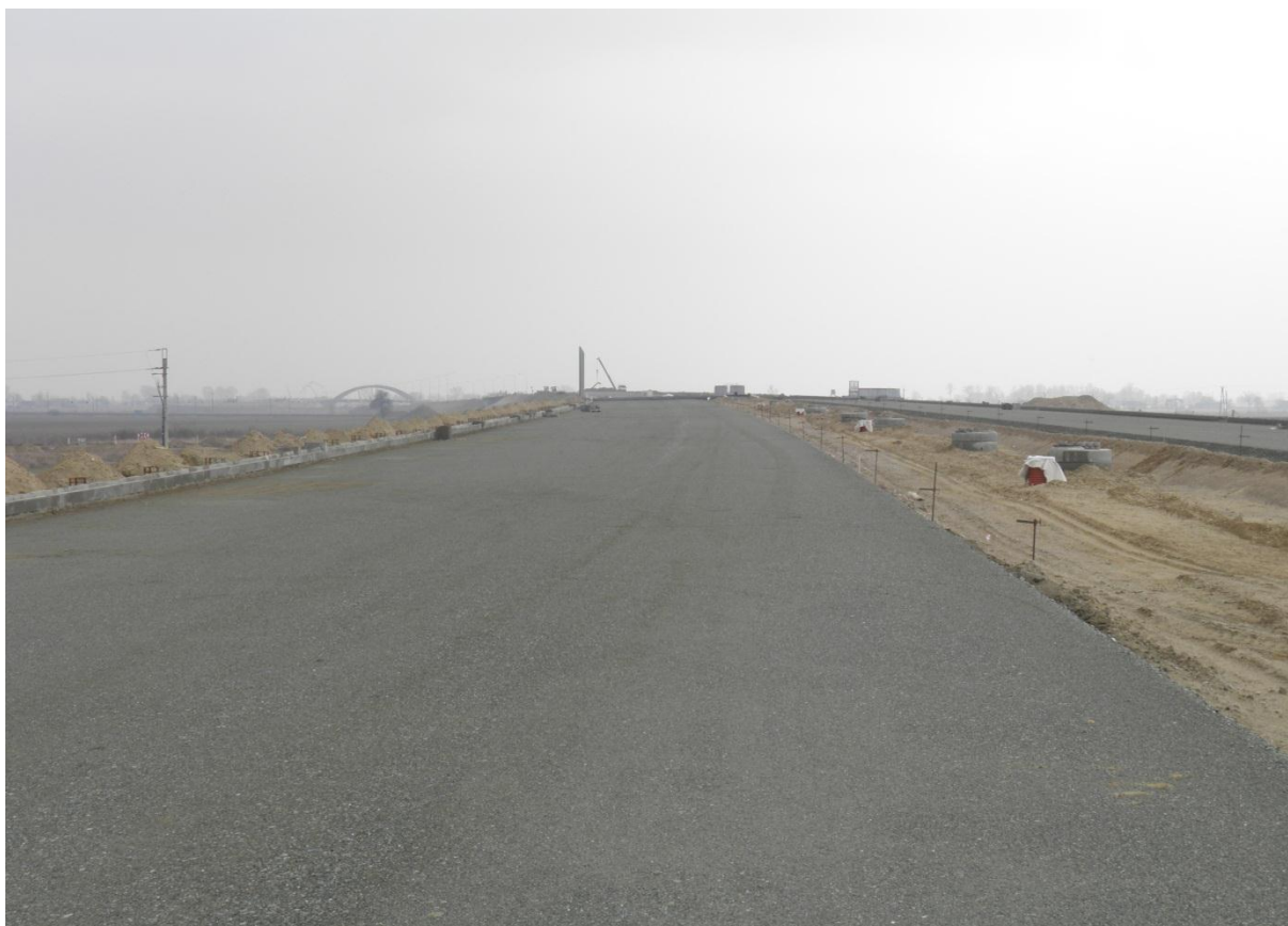
Warstwa podbudowy z kruszywa łamanego 0/31,5 stabilizowanego mechanicznie km 252+140-252+385 str. L i P.
