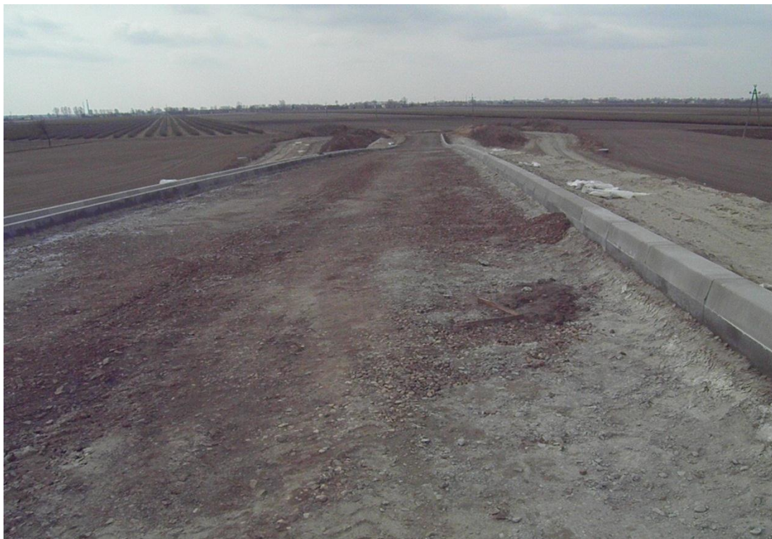
Krawężnik betonowy wym. 20x30 oraz ułożony ściek przykrawężniowy z elementów betonowych trójkątnych na najjeździe na obiekt WD 204 str. P (km 0+300-0+440)
