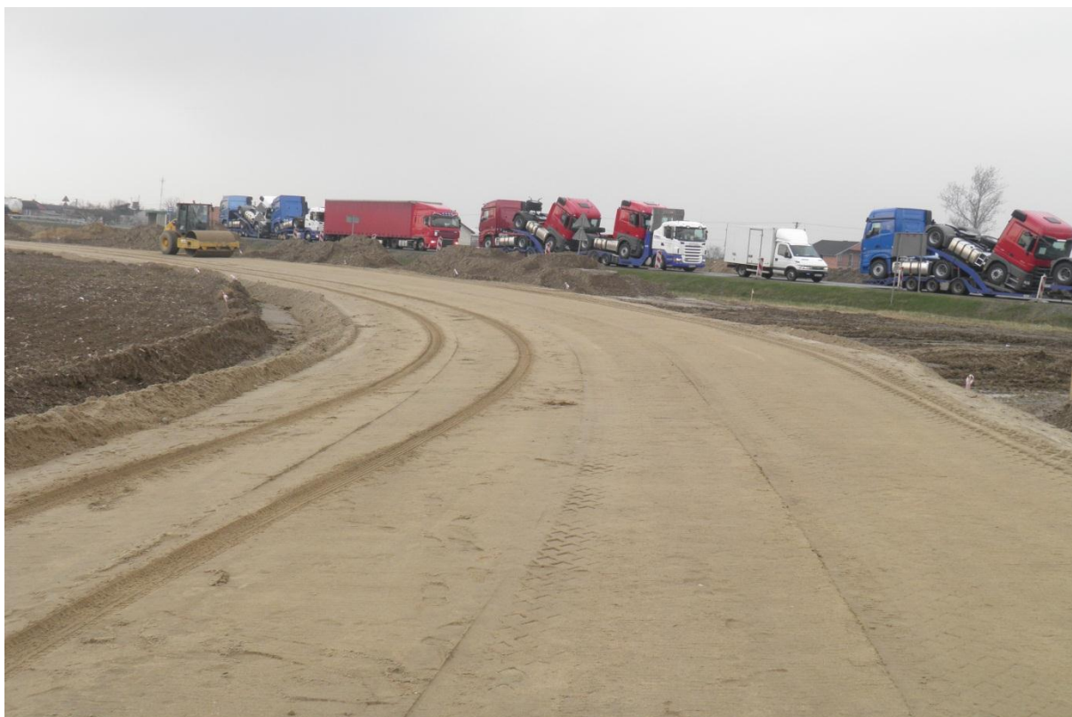
Zagęszczanie górnej warstwy nasypu km DD 254PB
