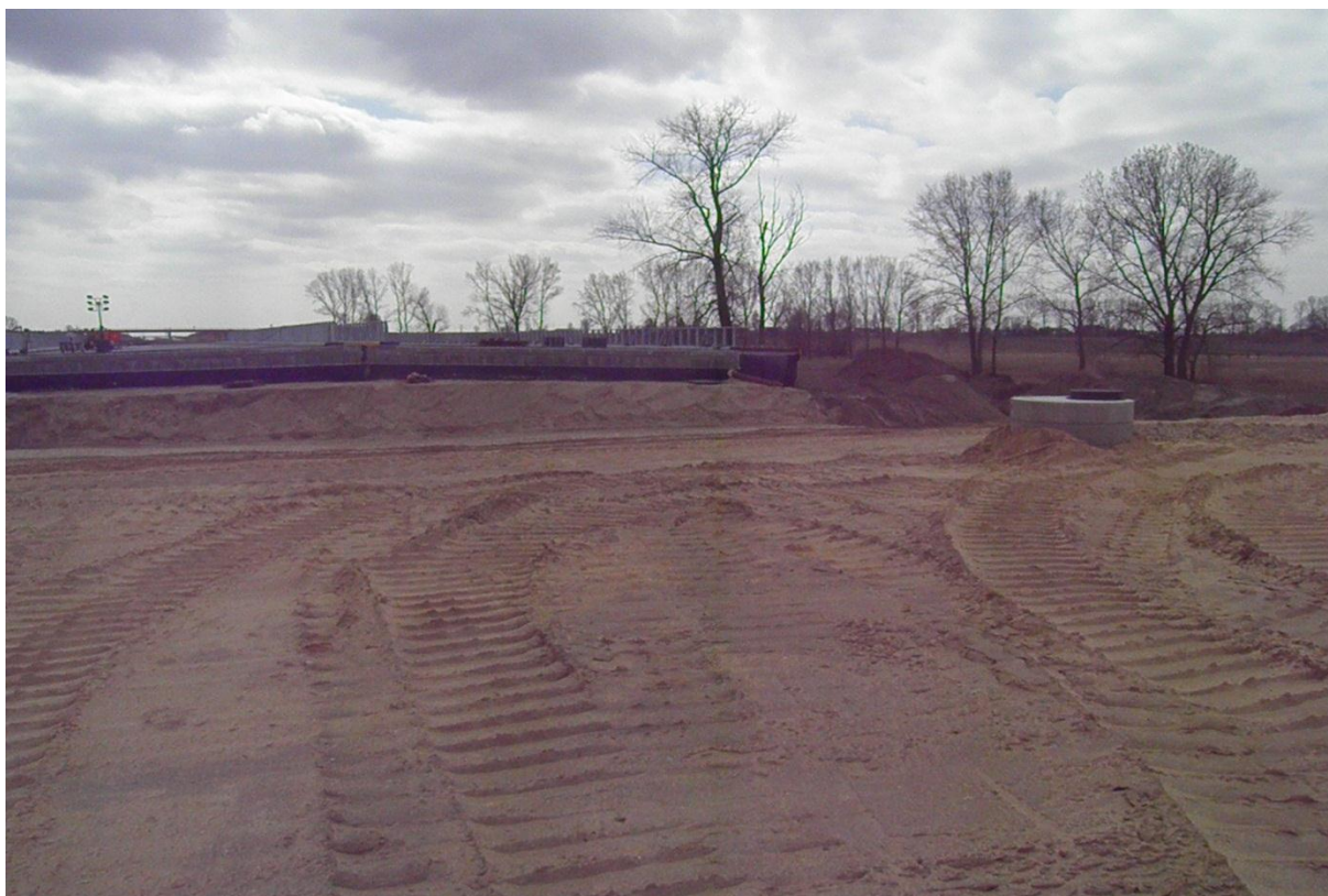
Wykonanie warstwy nasypu z gruntu dowiezionego z dokopu w km 259+150-259+350, 259+640-259+640-259+670 (tereny zalewowe rz. Ochni)
