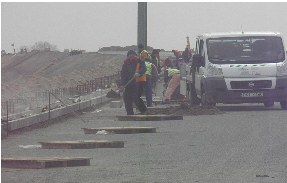
Układanie ścieku przykrawężniowego z elementów betonowych trójkątnych km 252+140-252+385
