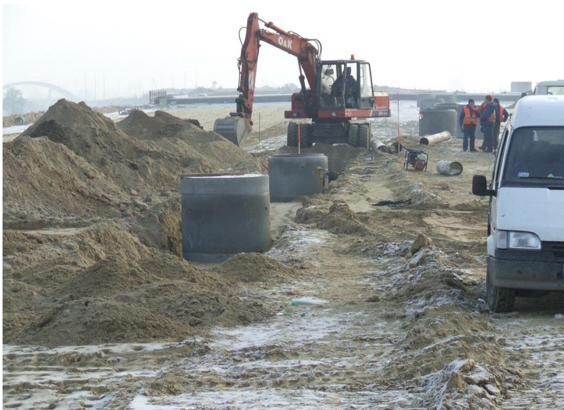
Budowa kanalizacji KD8
