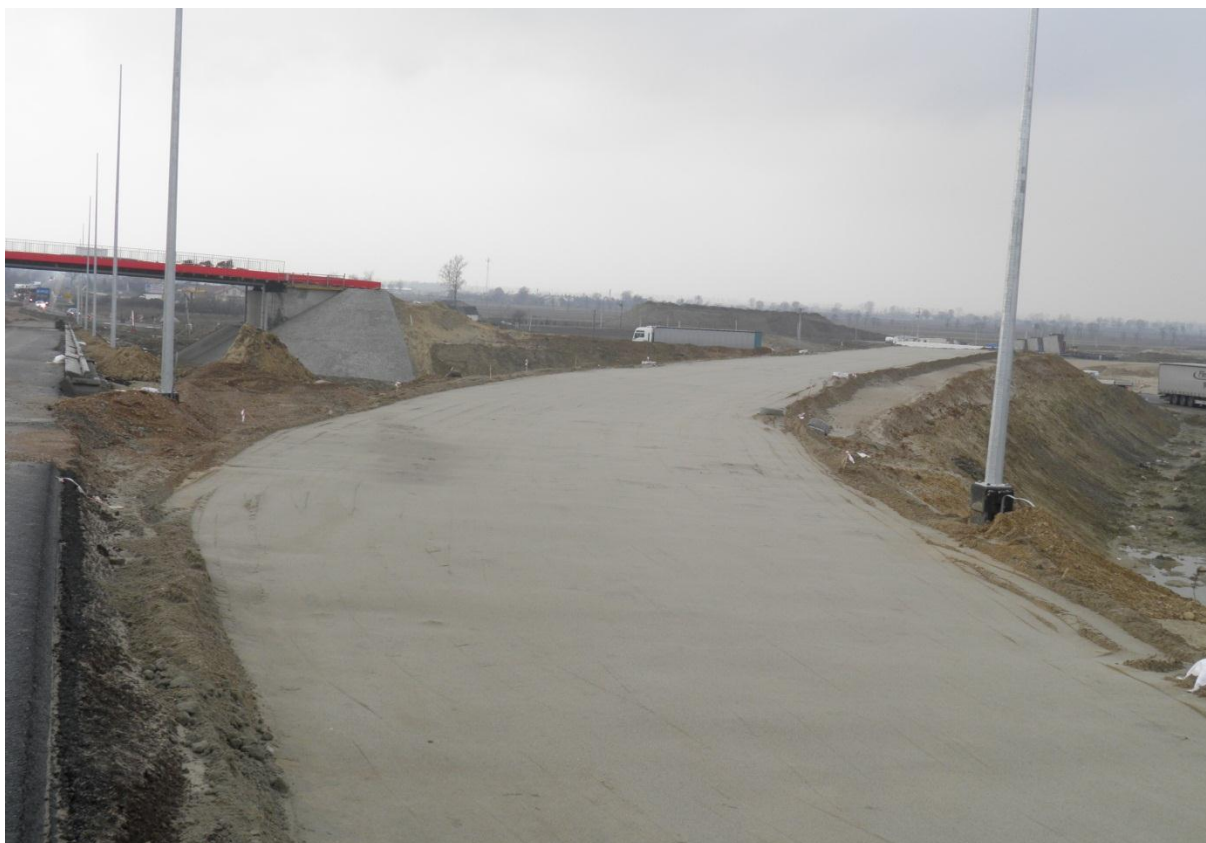
Górna warstwa nasypu łącznica B2
