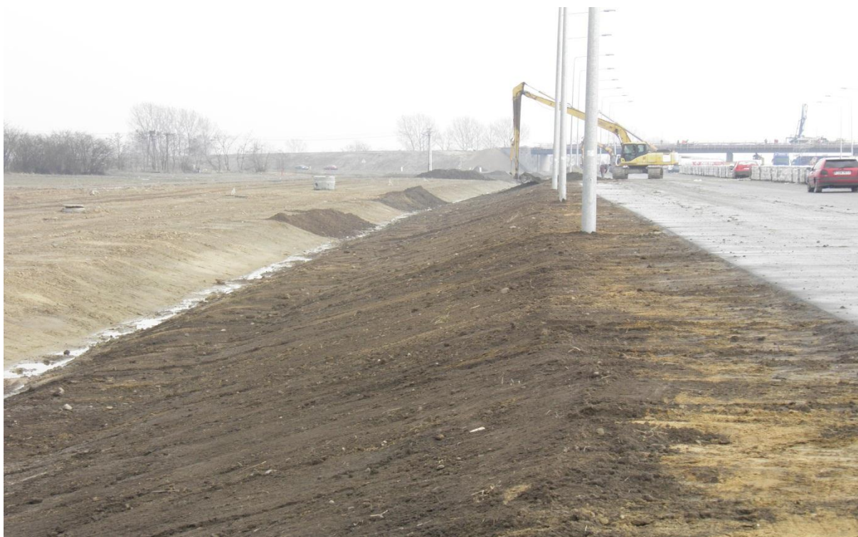
Humusowanie skarp w km 253+800-254+400
