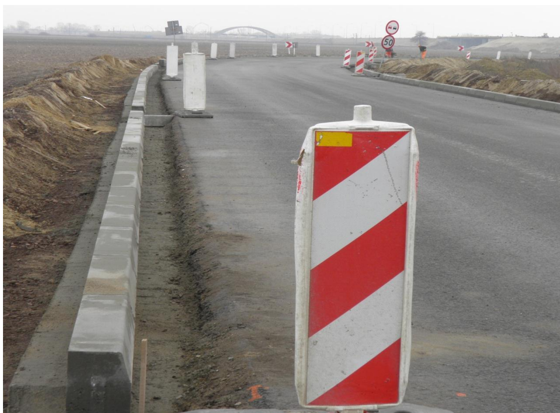
Krawężnik betonowy wym. 20x30 przy drodze powiatowej 2124E
