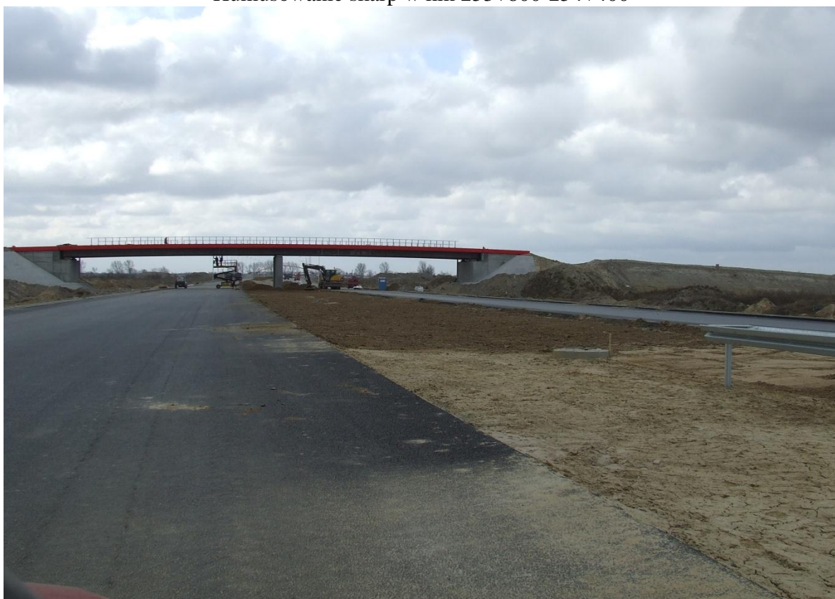
Humusowanie pasa rozdziału w km 256+800
