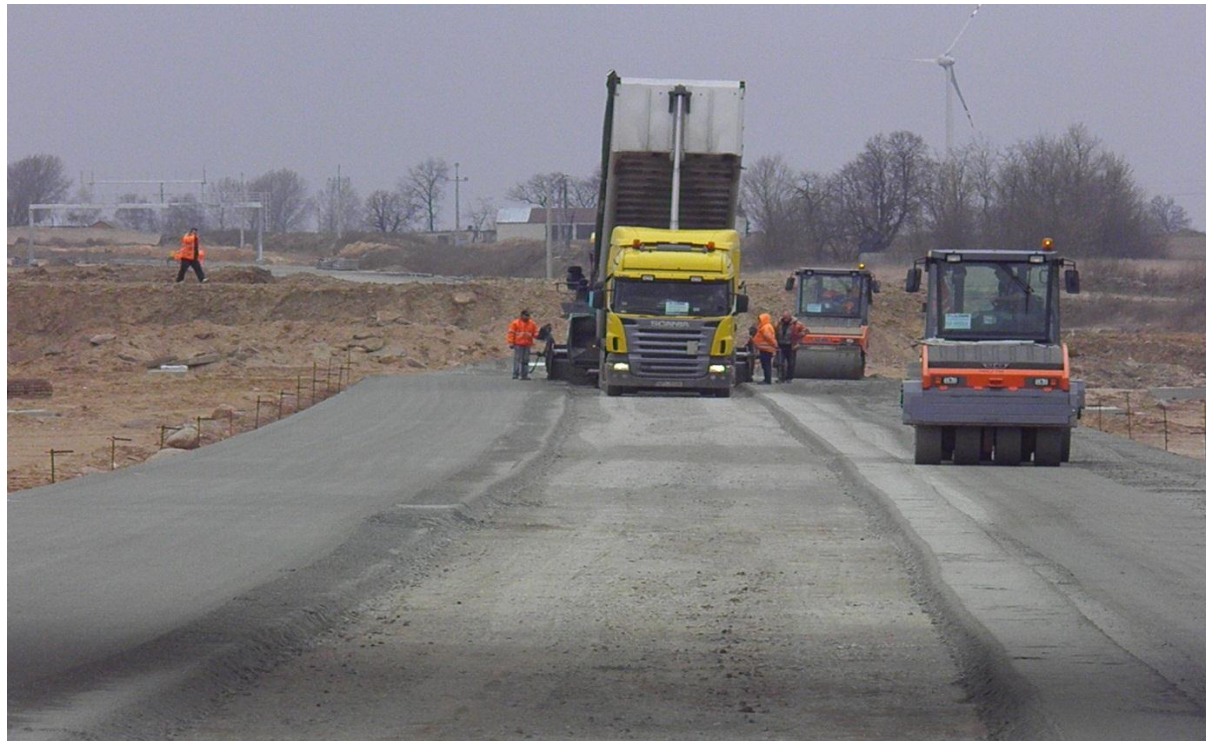
Wykonanie warstwy podbudowy z kruszywa łamanego 0/31,5 stabilizowanego mechanicznie km 256+640-256+830 str. L i P.
