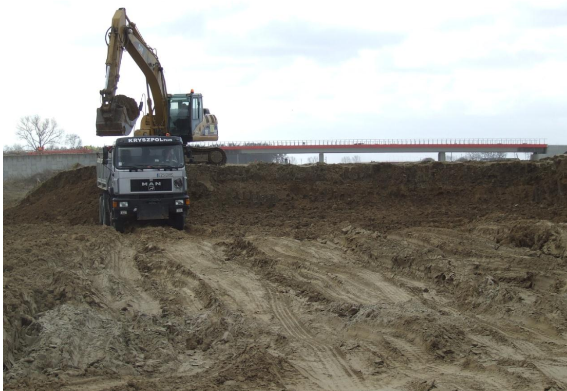
Rozbiórka nasypu przeciążającego w km 256+500-256+600
