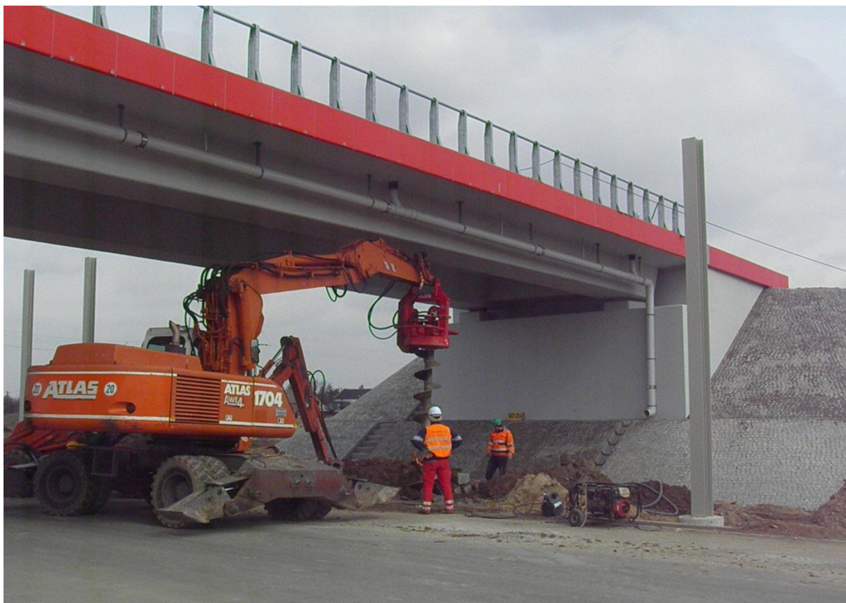
Odwiert pali fundamentowych Ekran EA1
