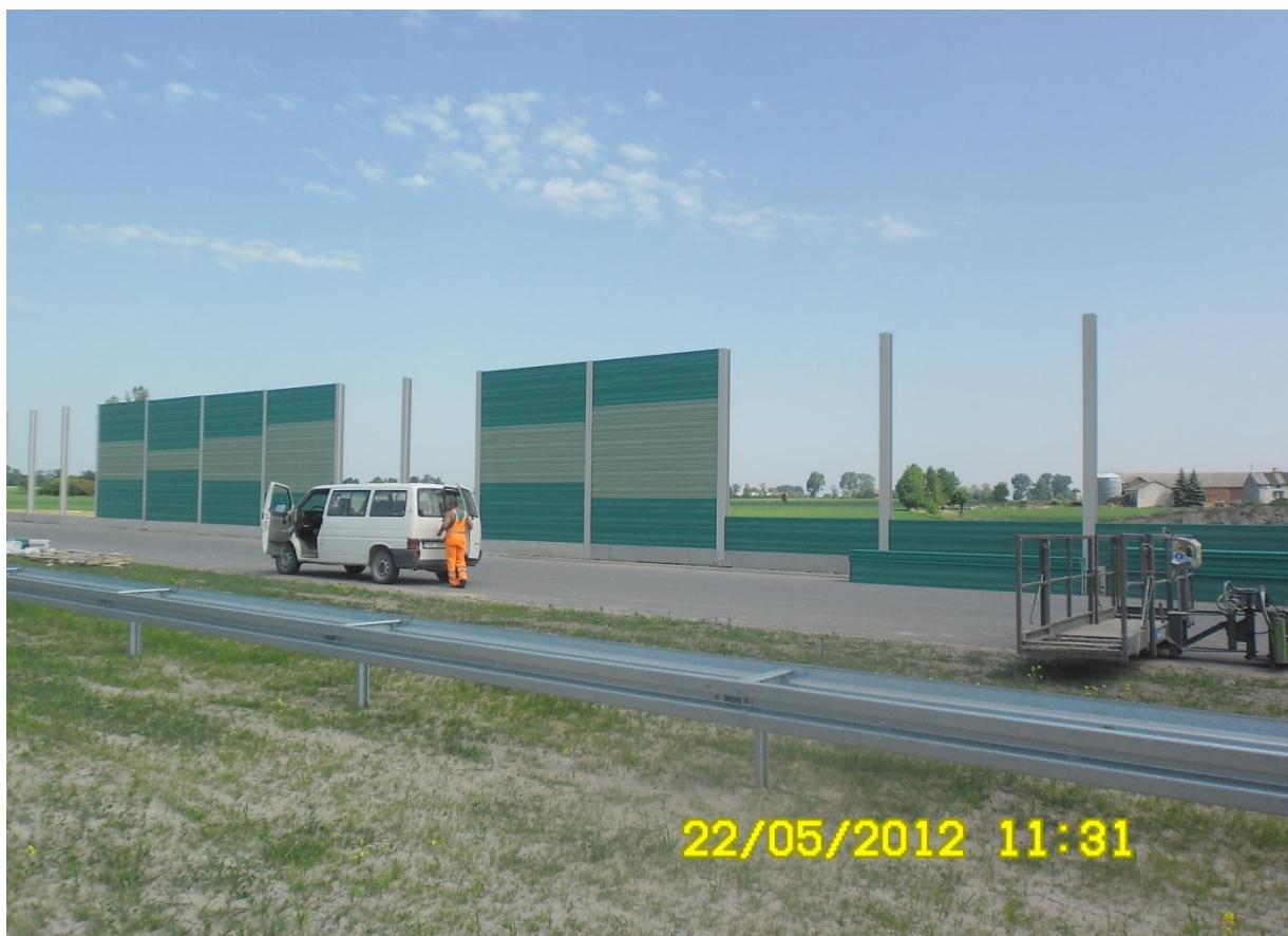
km 247+000 montaż paneli ekranów akustycznych
