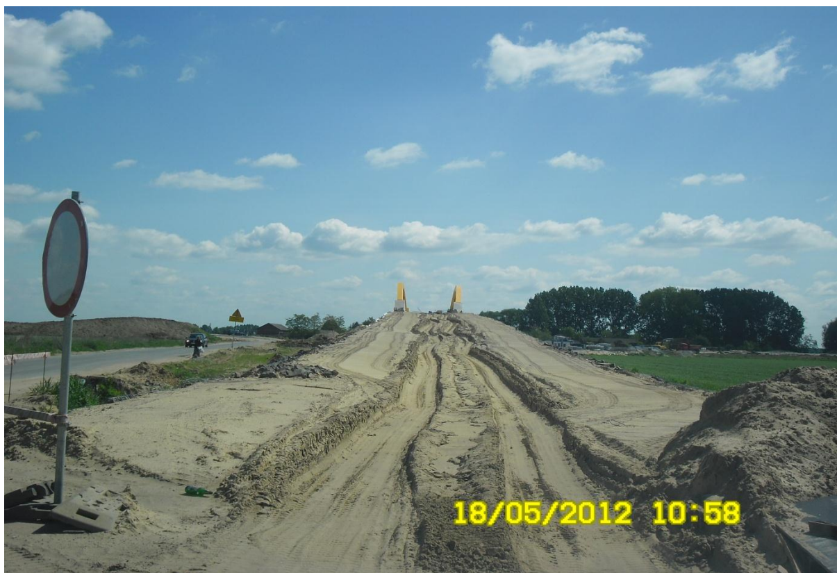
WD 203 - nasyp przy obiekcie od strony zachodniej
