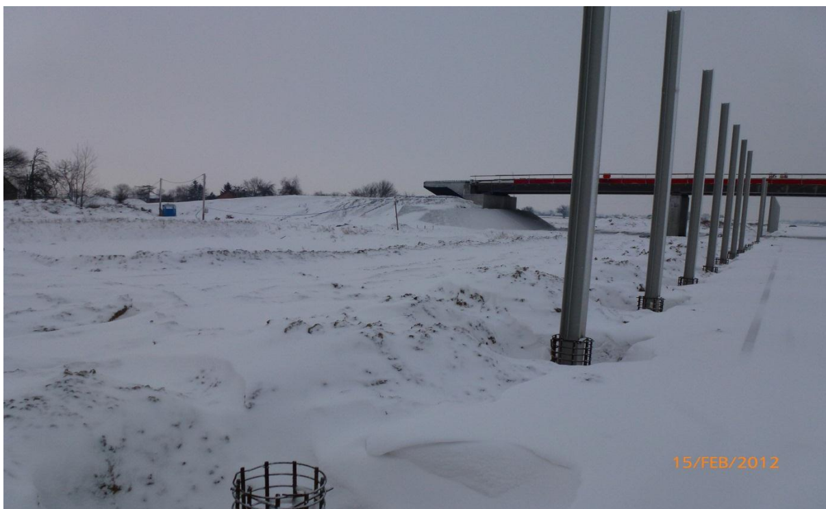
Zamontowane słupy na ekranie EA 2 km 250+800-251+950
