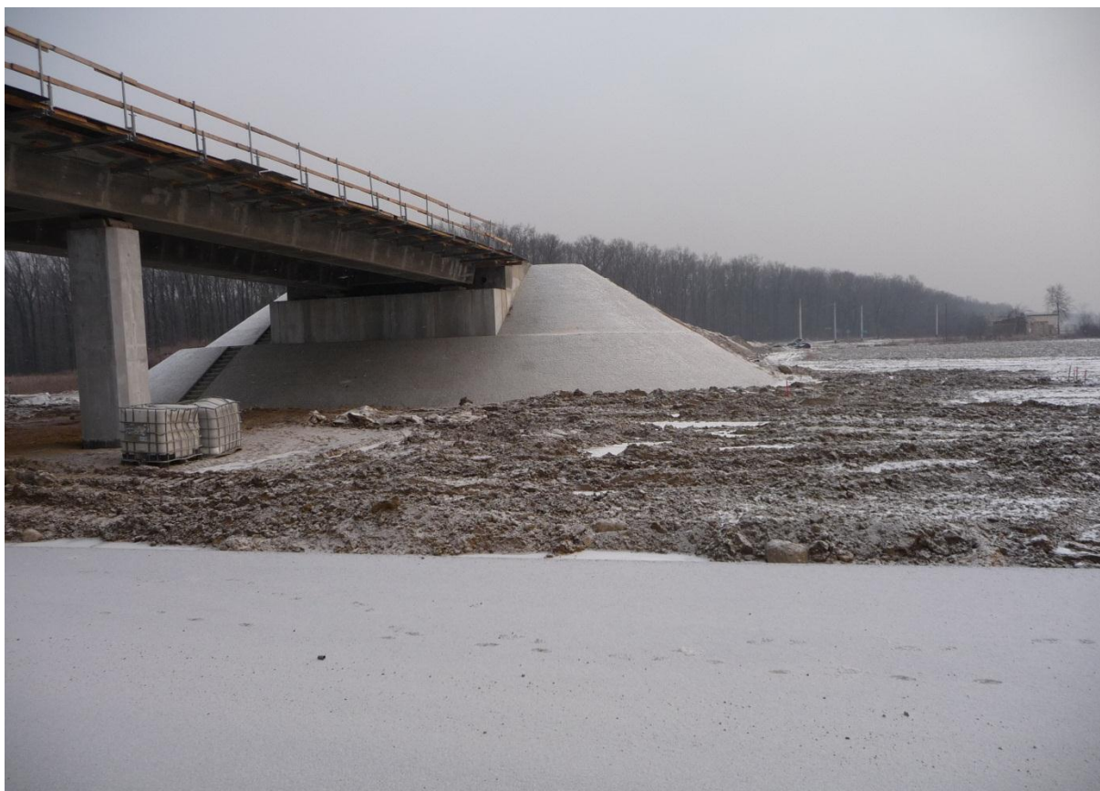
WD 206 umocniony stożek kamienna kostka granitową
