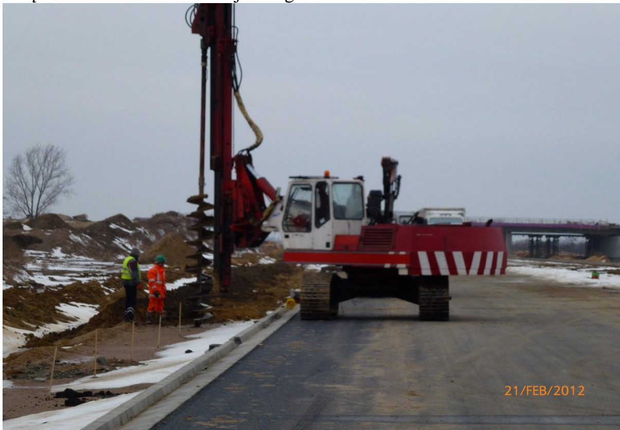
Odwiert pali fundamentowych Ekran EA3 km 254+450 - 255+480
