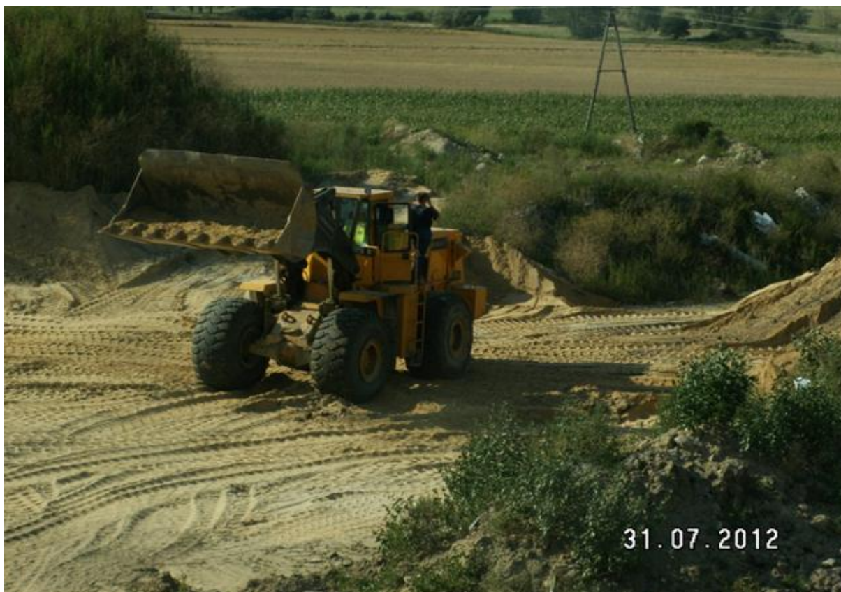
Wykonanie nasypu z dokopu. Najazd na WD218 str P
