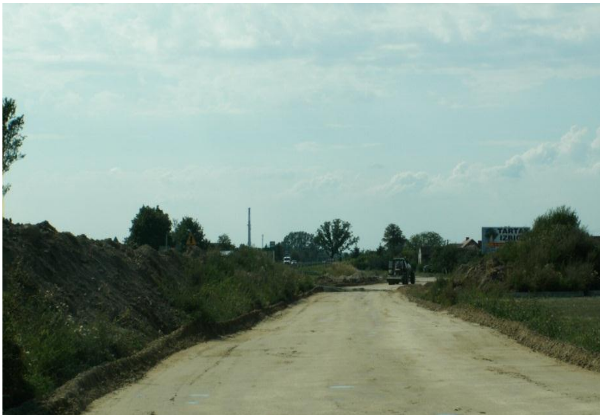
Warstwa gruntu stabilizowanego cementem R_m = 2,5 \text{ MPa} DD 254Pa
