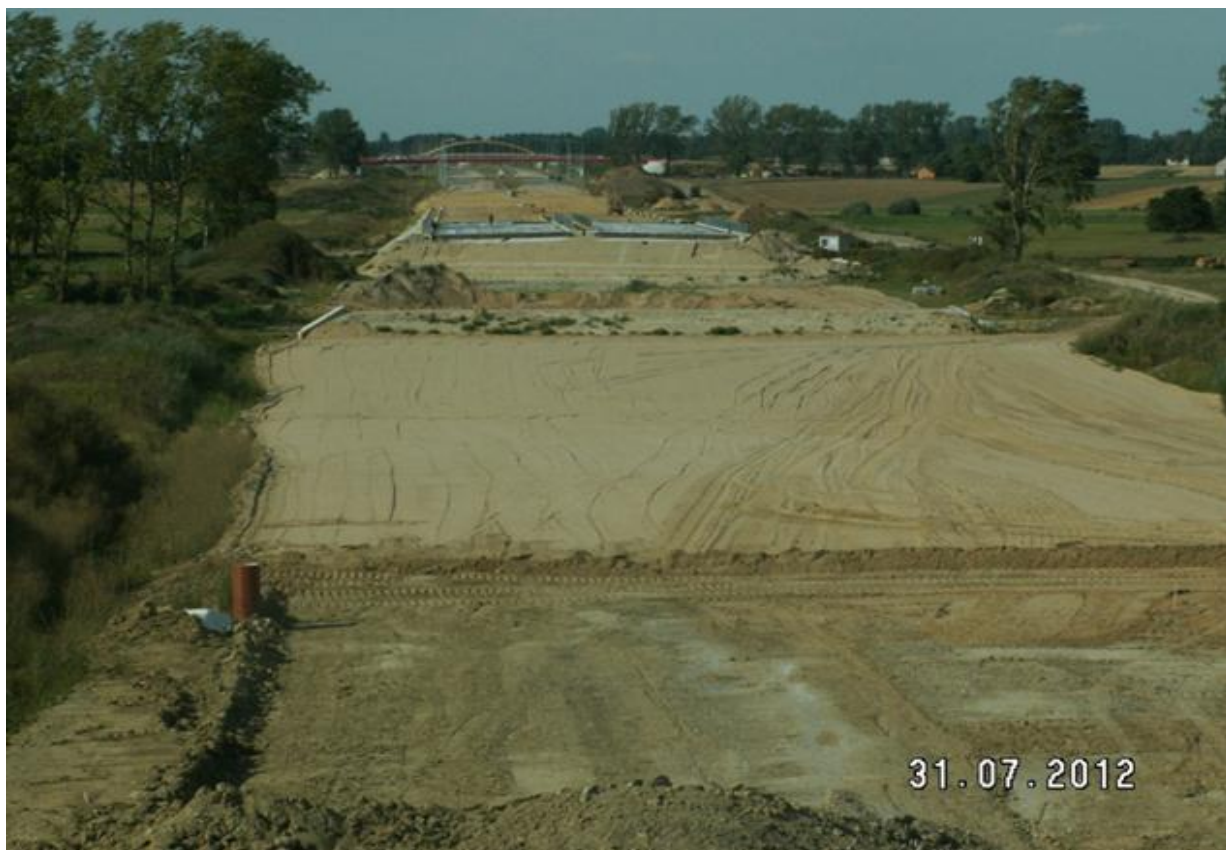
Koryto pod materac km 259+160-259+190
