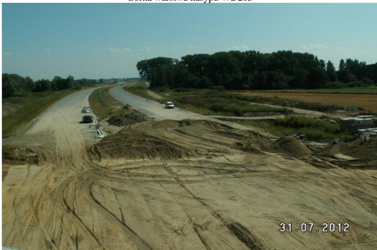
Korytowanie pod nasyp WD203
