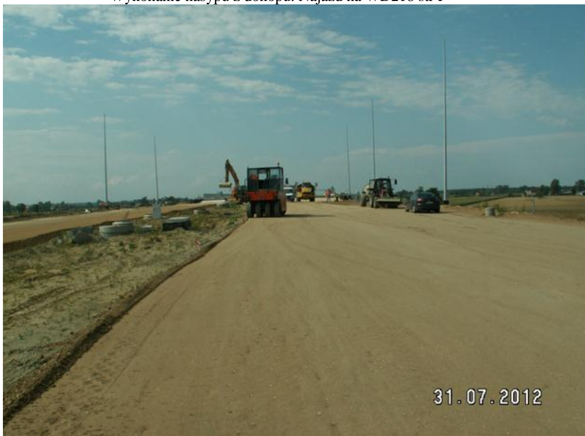
Wykonanie górnej warstwy nasypu km 252+901-253+300
