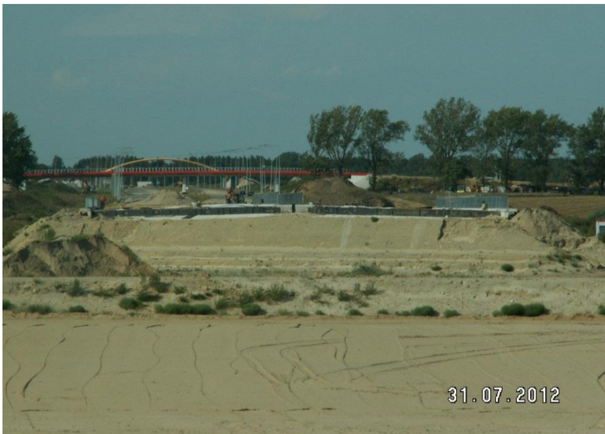
Wyprofilowanie warstwy nasypu MA217
