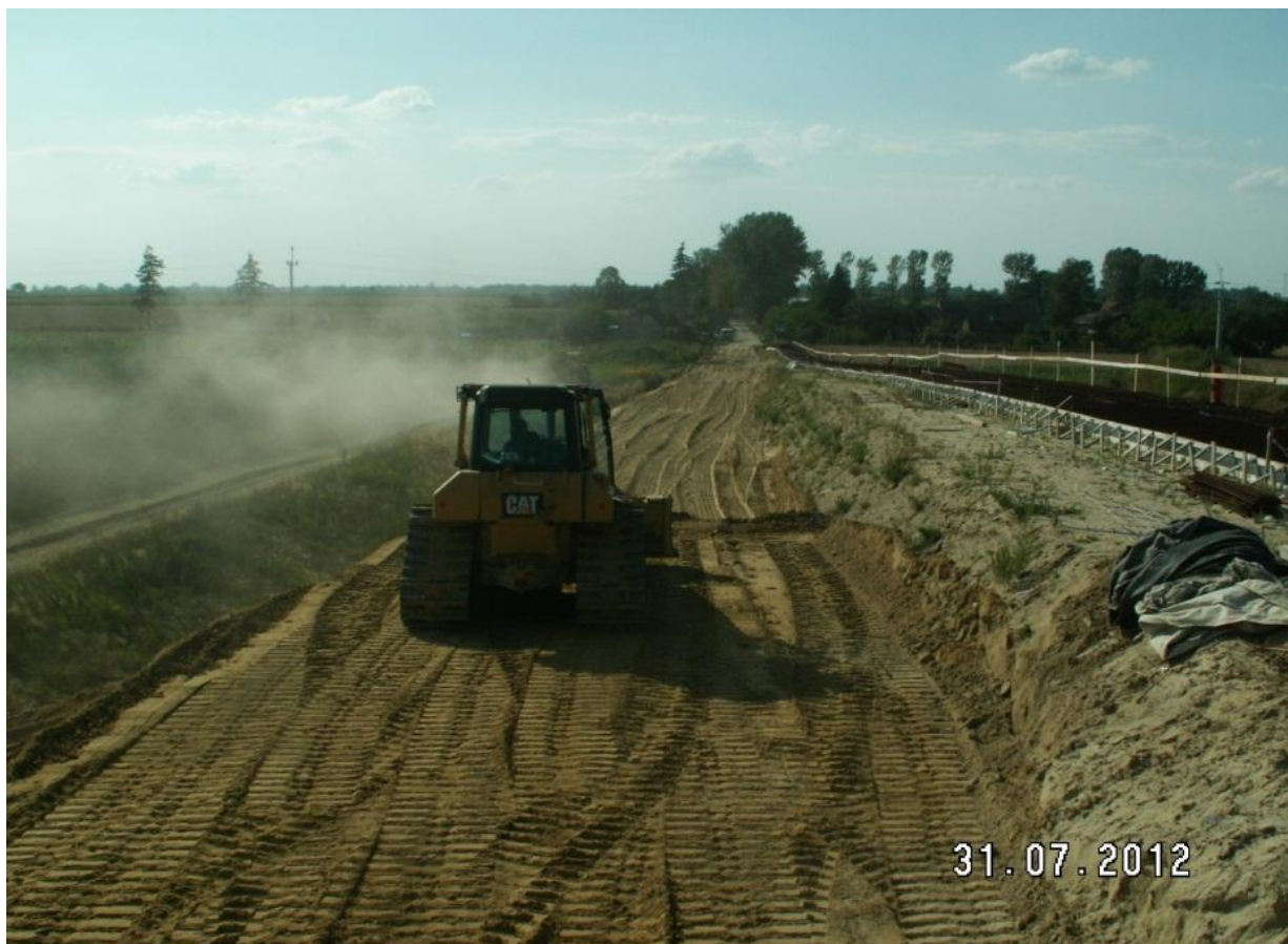
Wykonanie nasypu z dokopu WD218 str P
