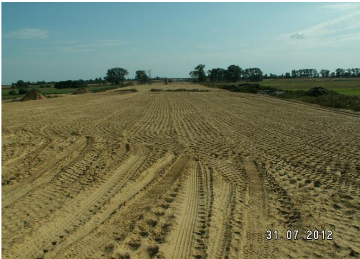
Nasyp z dokopu km 259+100-259+600
