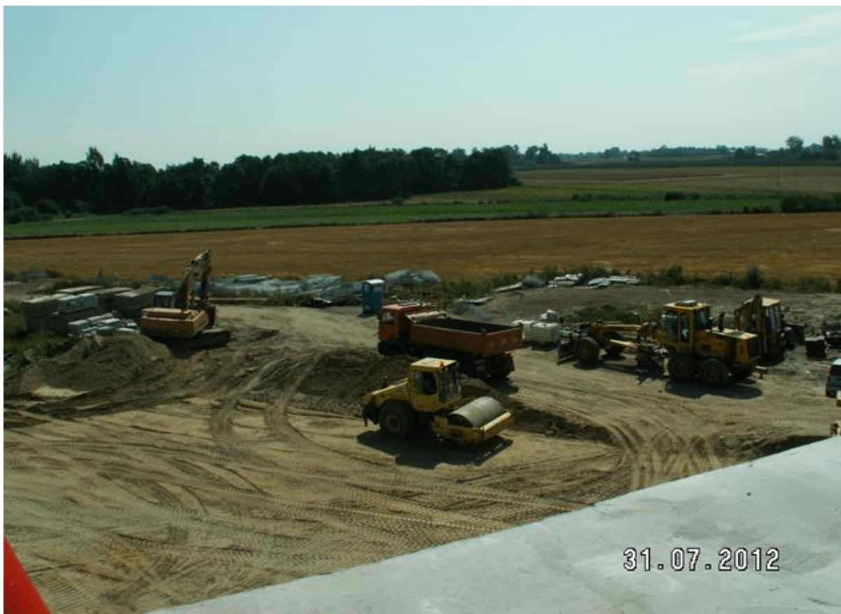
Odhumusowanie trasy głównej WD203
