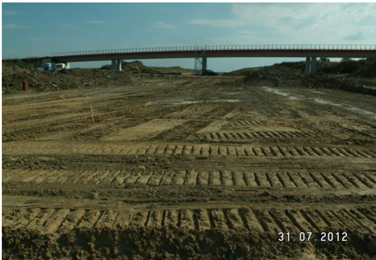
Koryto pod materac km 260+150-190
