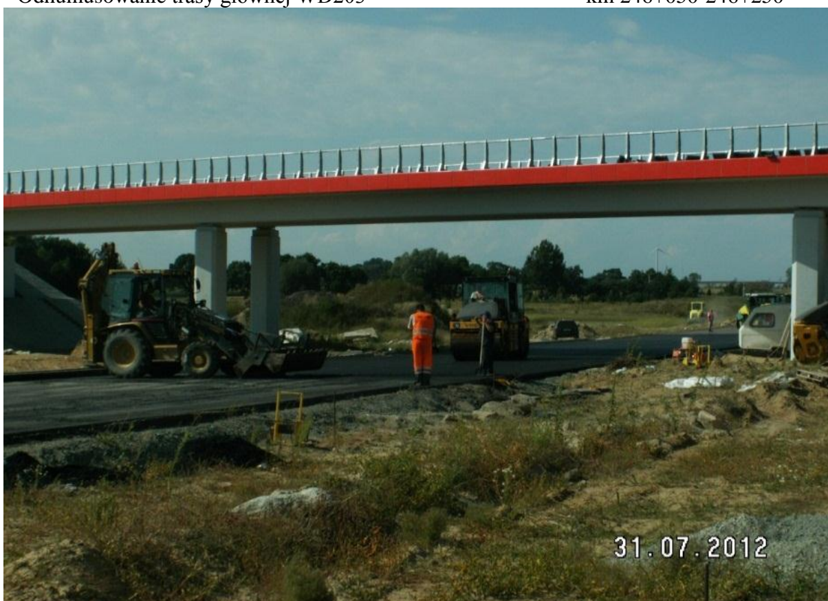
Warstwa podbudowy z BA
