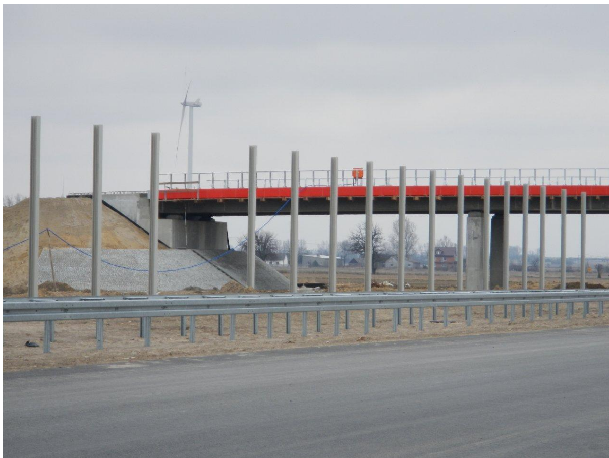
WD 207, bariery energochłonne, słupy ekranów akustycznych
