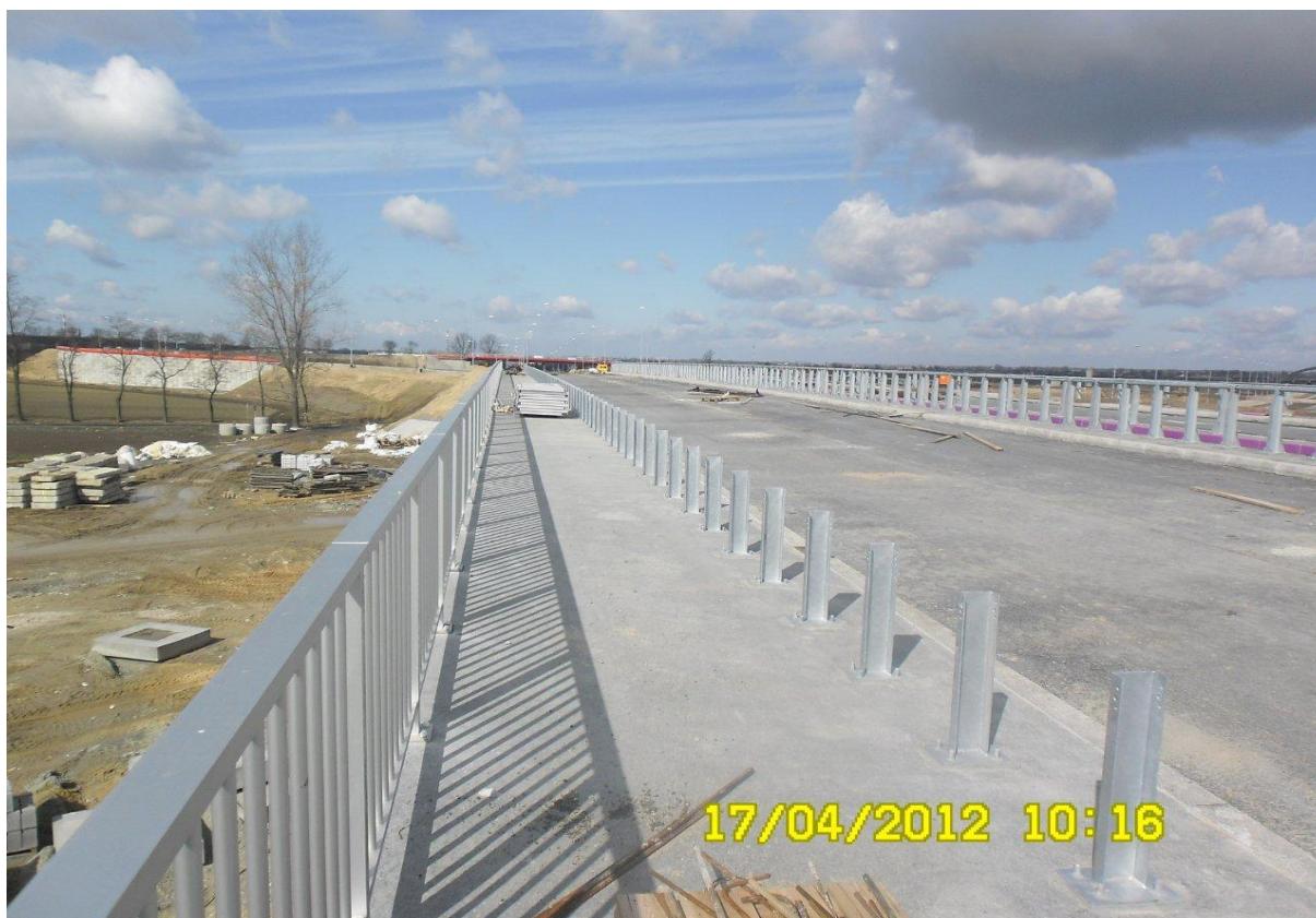
WD-211 (wiadukt w ciągu DK92)
