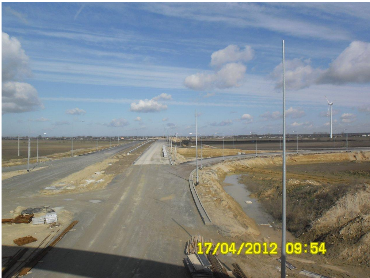
km 253+500 (Łącznica na węźle Kotliska)
