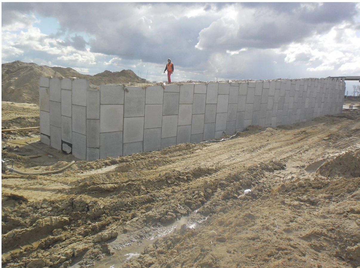
Ściana oporowa - najazd dla wózków inwalidzkich na kładkę KP-214A
