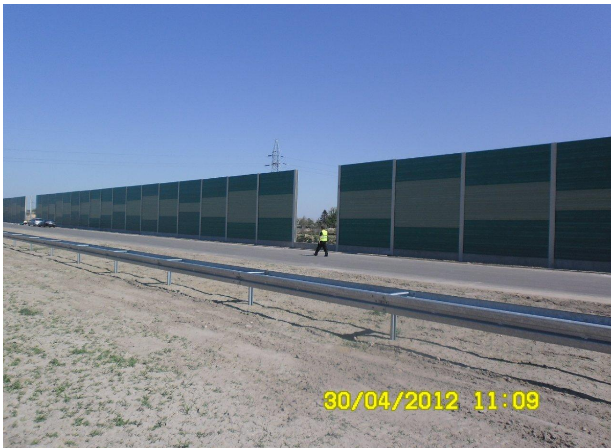
ekrany akustyczne km 251+750
