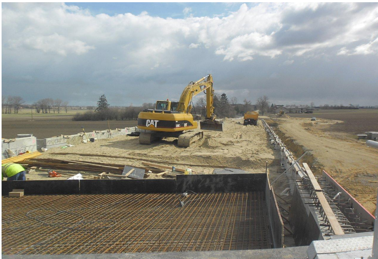
Ściana oporowa WD218
