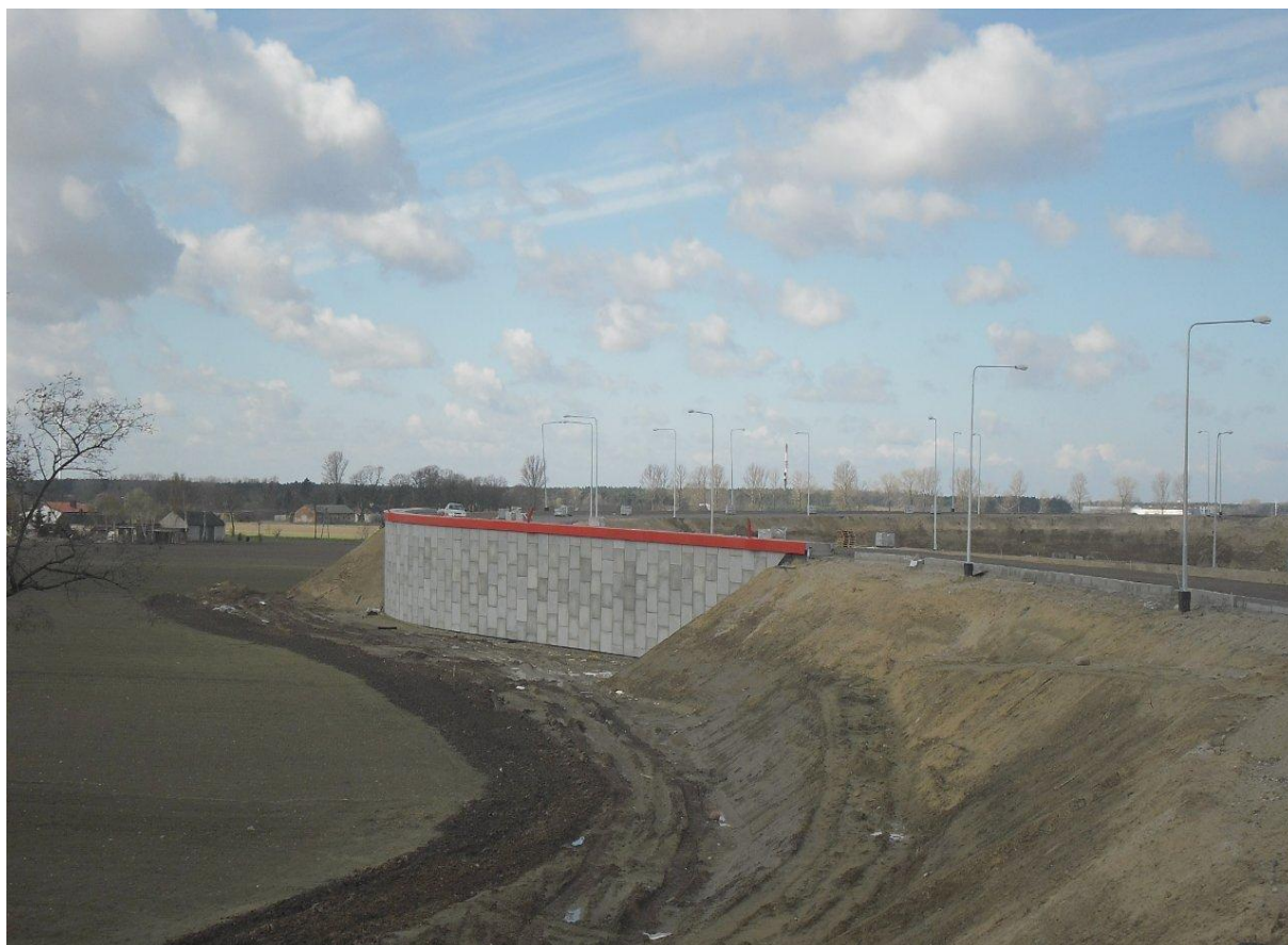
Węzeł Kotliska - Ściana oporowa
