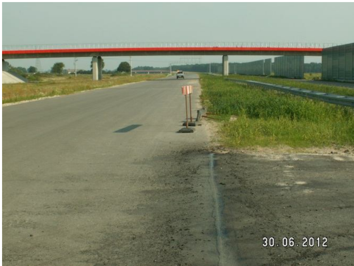
Naprawa spękań warstw bitumicznych
