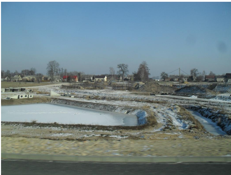
Fot 4. Zimowe warunki uniemożliwiają prace przy zbiornikach ekologicznych..
