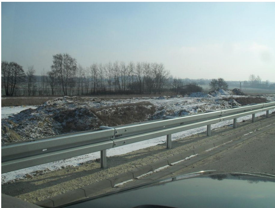
Fot1. Hałdy humusu km 285+400.
