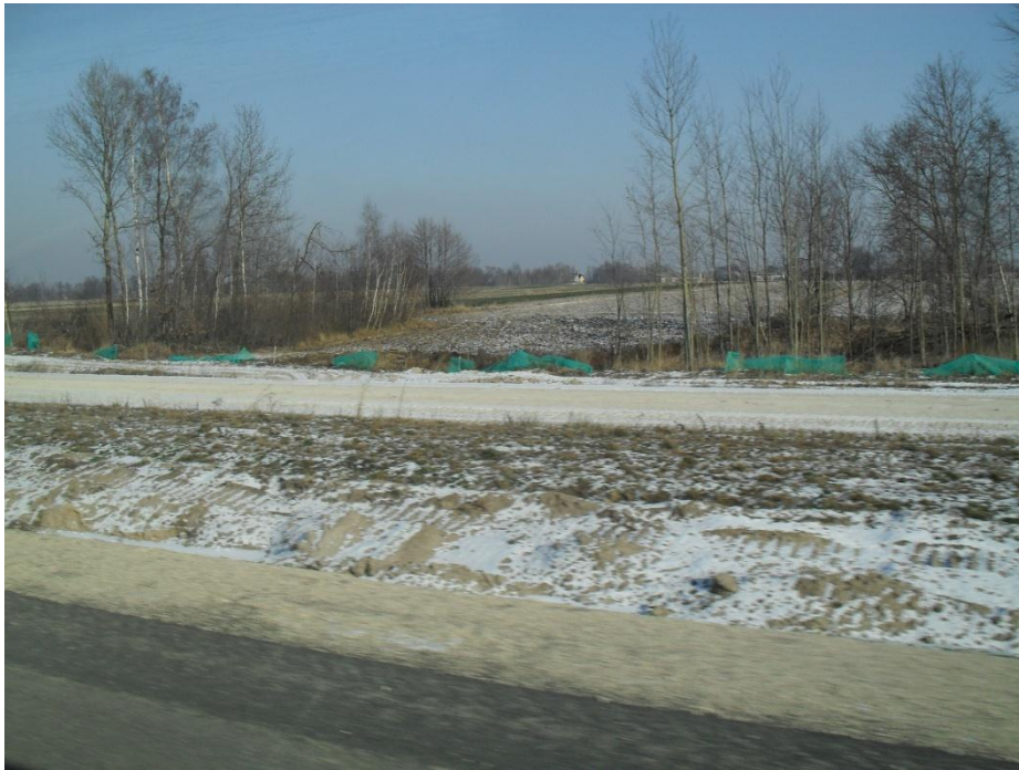
Fot3. Ogrodzenie stanowiska 120 wymagające naprawy przed wiosenną migracją płazów.
