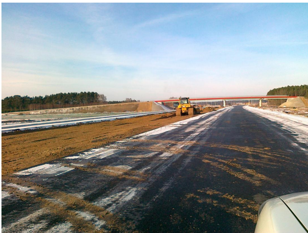
Zdjęcie 3. Roboty w pasie rozdziału przy WD-236, 17.01.2012
