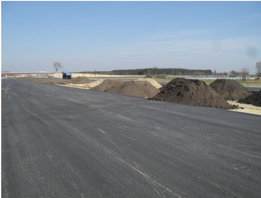
Fot2. Humusowanie pasa środkowego, km 283+ 100.
