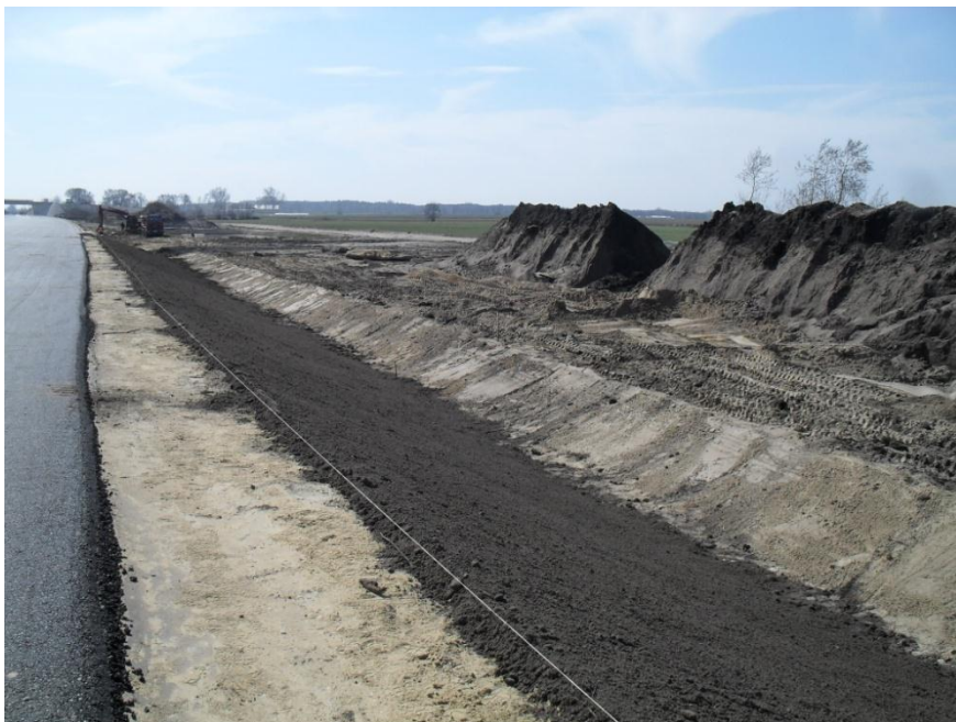
Fot1. Humusowanie nasypu w km 279+200.
