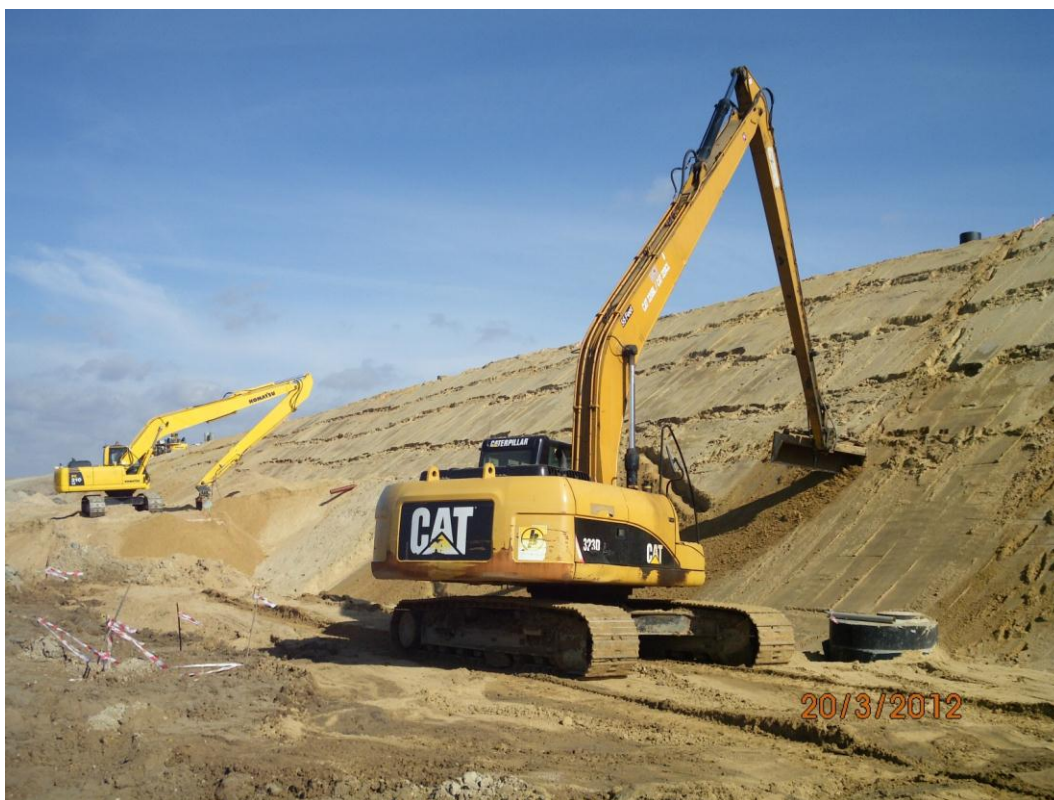
Zdjęcie 4. Profilowanie skarp nasypu przy WA-241, 20.03.2012
