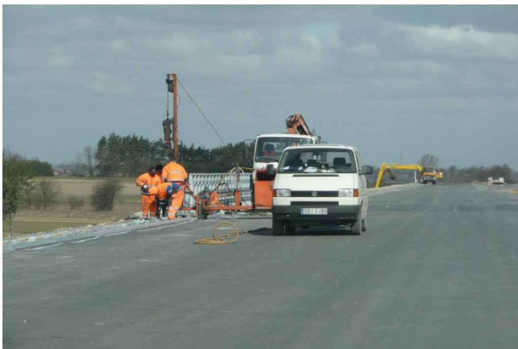
Zdjęcie 7. Montaż barier przy WA-240, 29.03.2012
