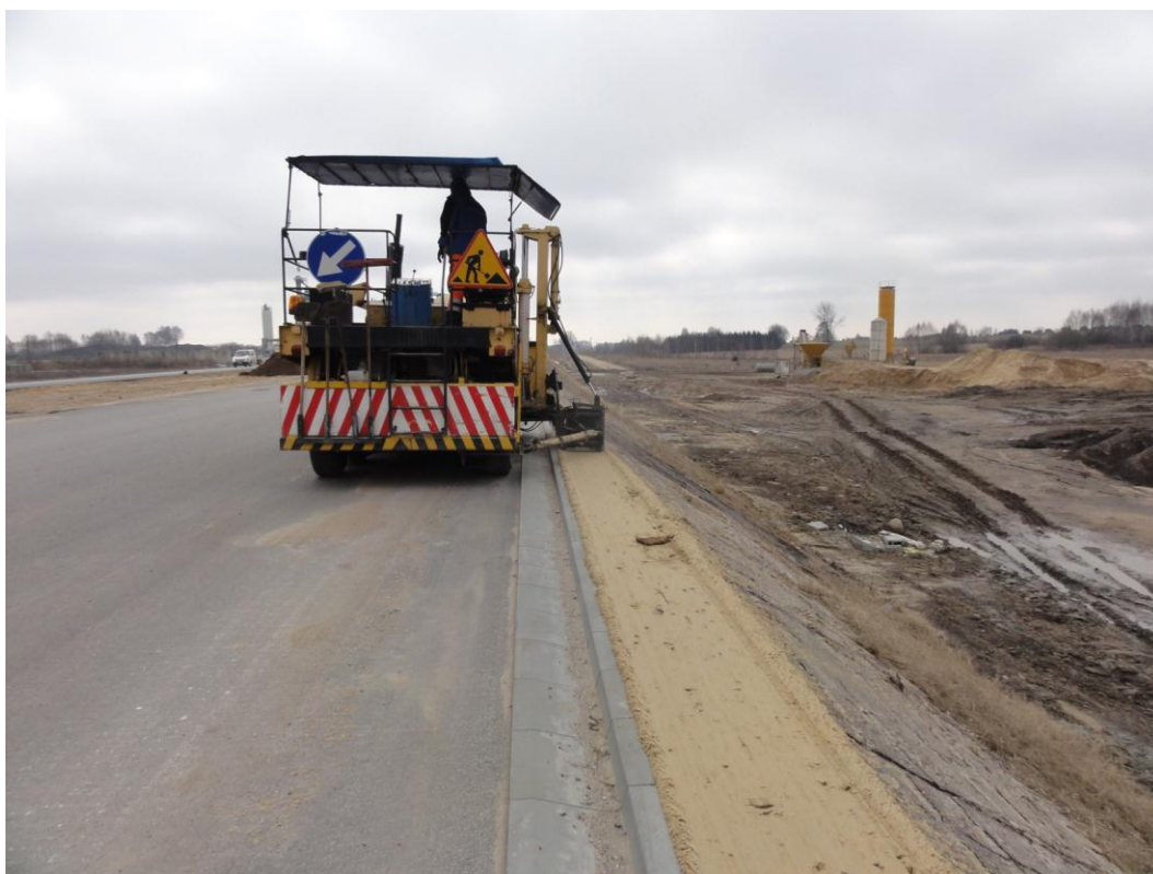
Zdjęcie 3. Przygotowanie pobocza pod bariery przy obiekcie WD-240, 20.03.2012
