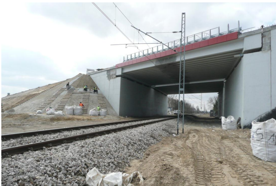
Zdjęcie 11. Brukowanie stożków na obiekcie WA-241, 22.03.2012
