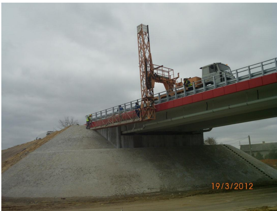
Zdjęcie 12. Uszczelnianie silikonem desek gzymsowych na WD-239, 19.03.2012
