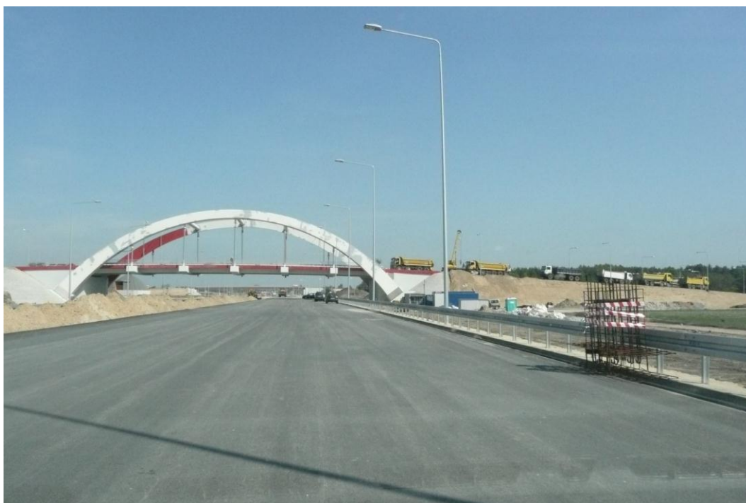
Zdjęcie 1. Przygotowanie do próbnego obciążenia WD-231, 23.05.2012
