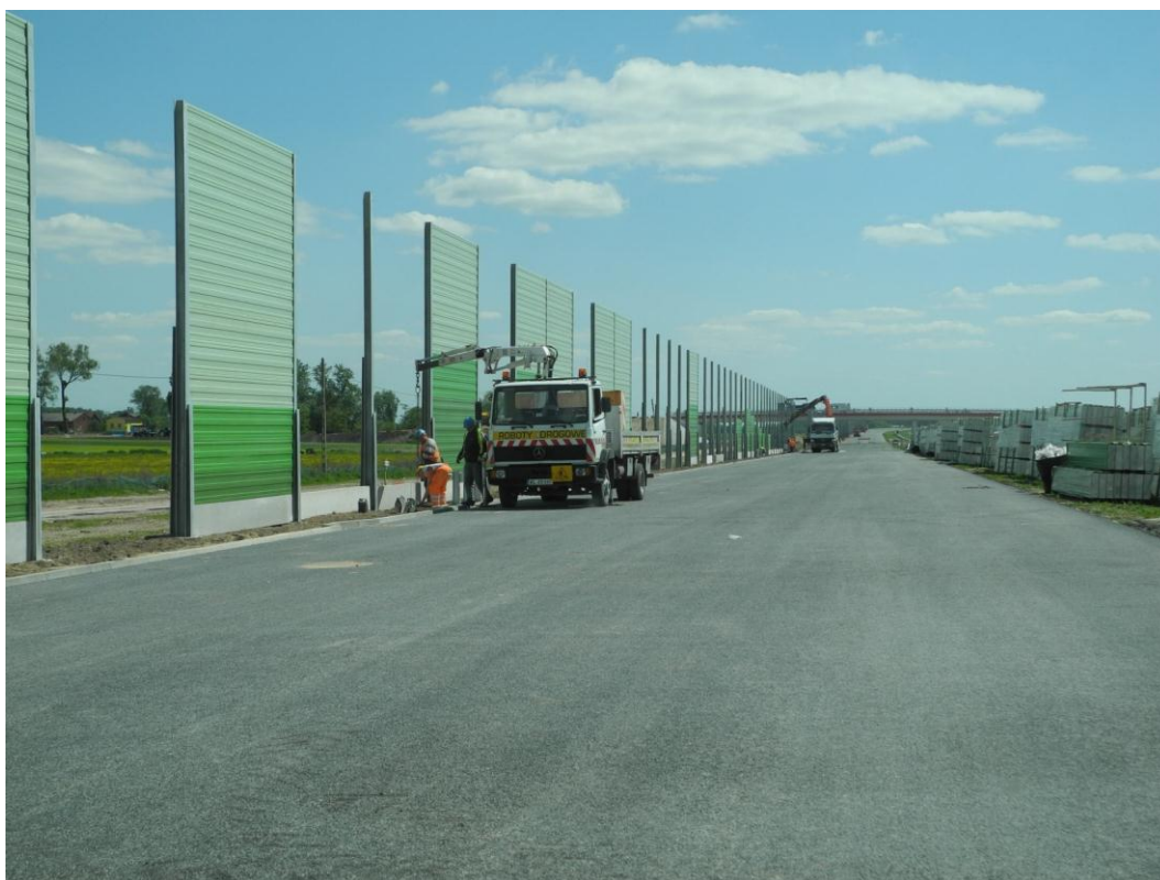
Zdjęcie 8. Montaż paneli ekranów akustycznych przy WD-229
