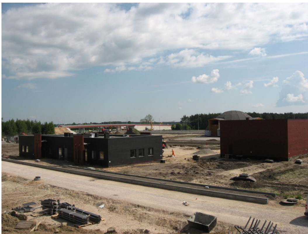
Zdjęcie 10. Budynek warsztatowy, 23.05.2012
