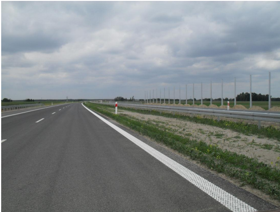
Fot1. Przygotowanie do montażu ekranów akustycznych w km 281+300.
