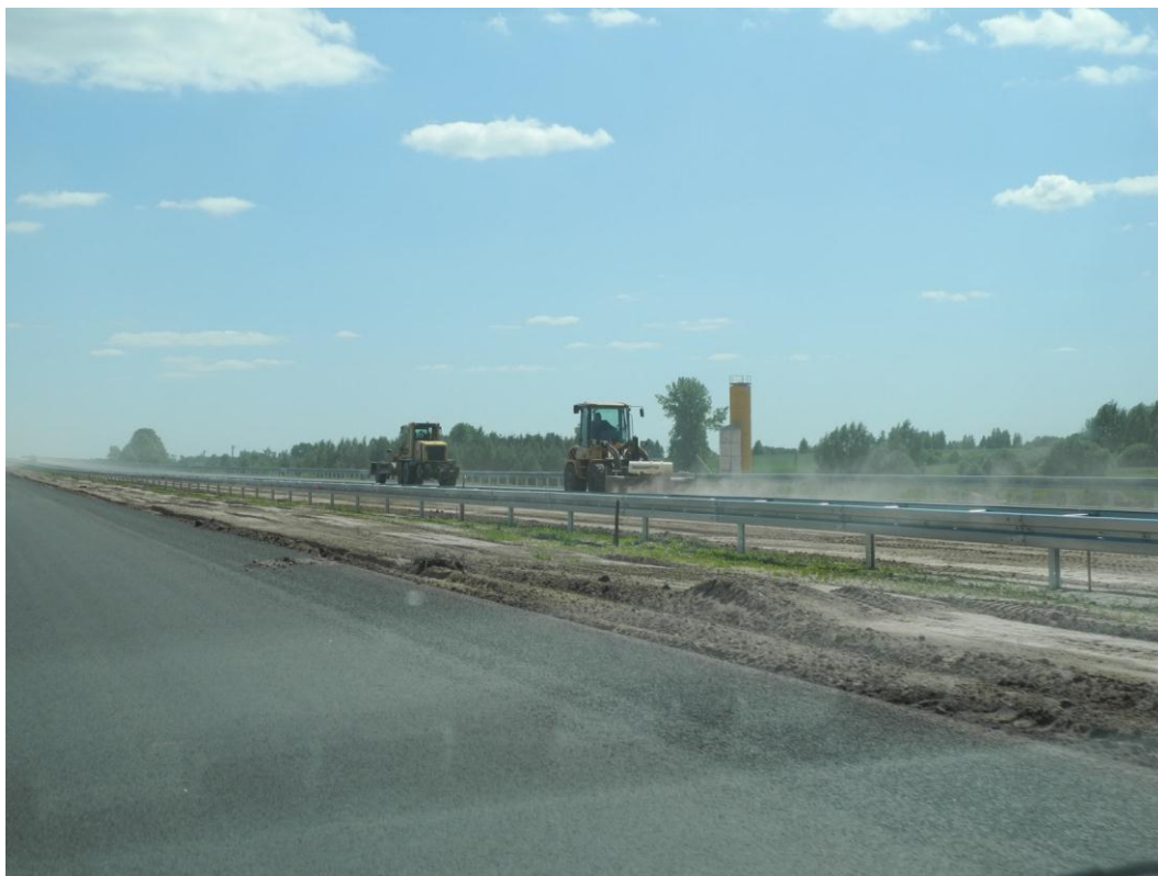
Zdjęcie 3. Czyszczenie powierzchni pod malowanie oznakowania poziomego przy WA-240
