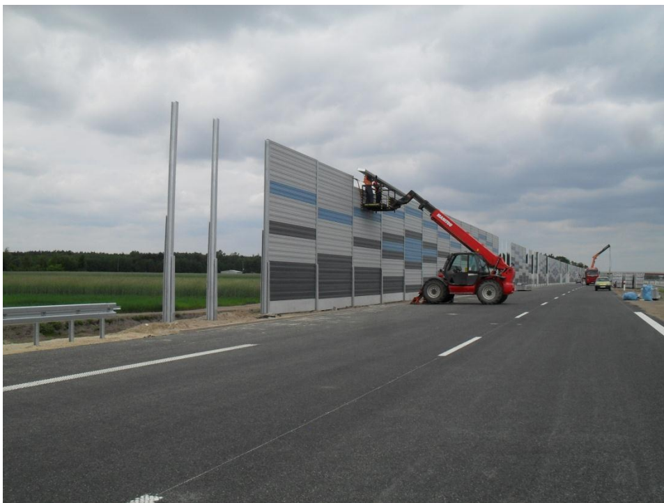
Fot 4. Montaż ekranów akustycznych na wysokości 279+700.
