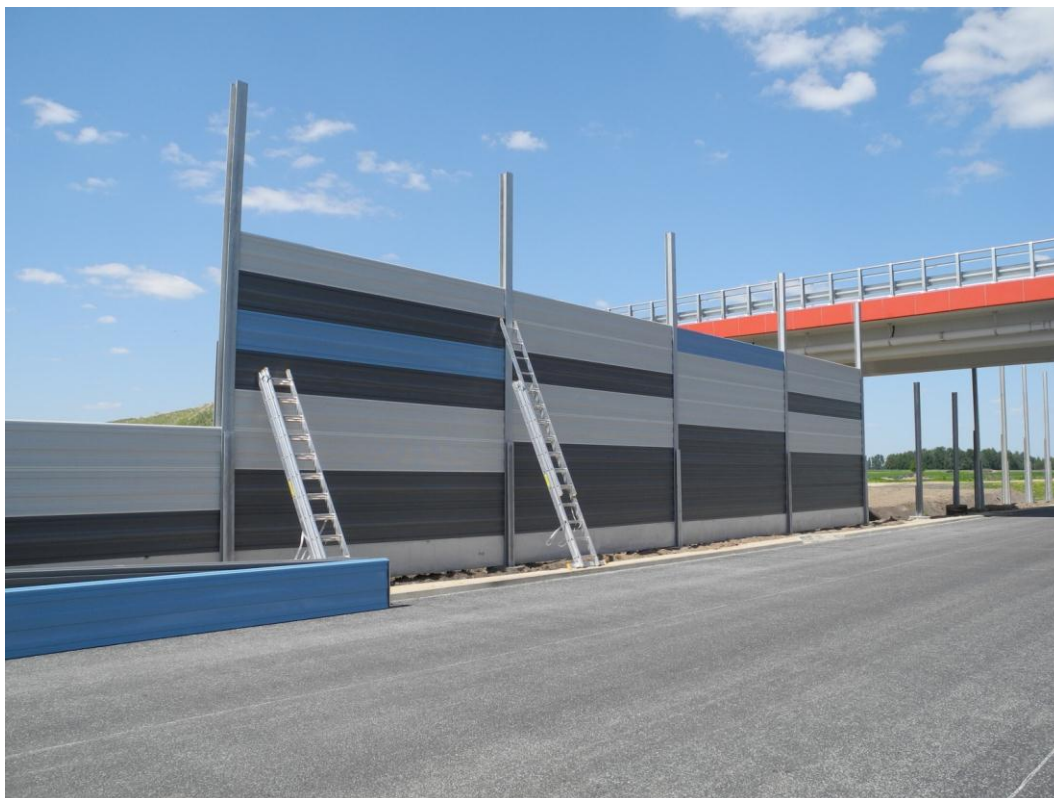
Zdjęcie 7. Ekrany akustyczne przy WD-232
