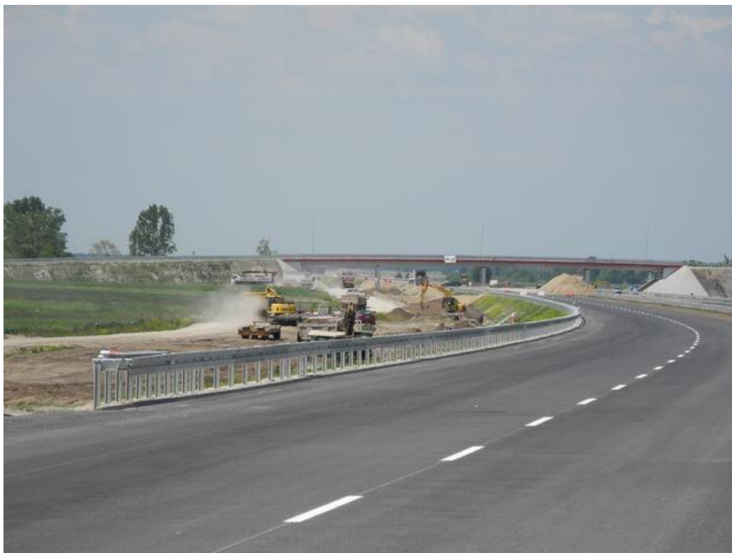
Zdjęcie 5. Widok na ciąg główny przy PZ-239A
