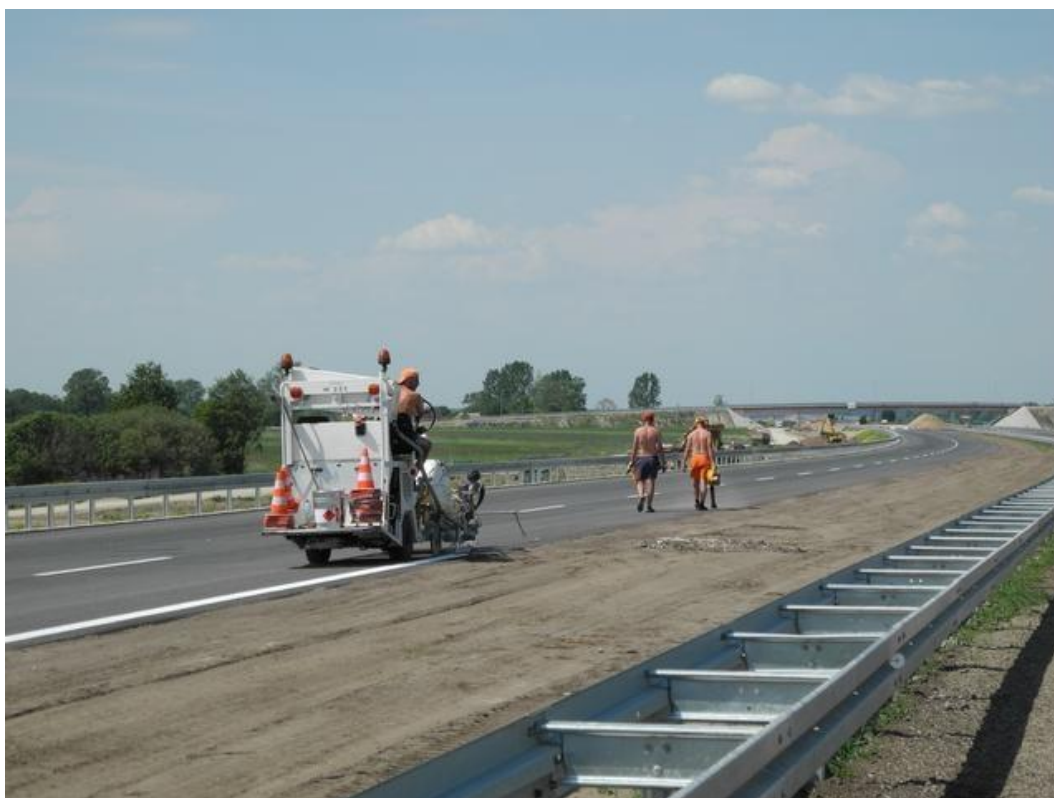
Zdjęcie 4. Malowanie oznakowania poziomego, okolice PZ-239A
