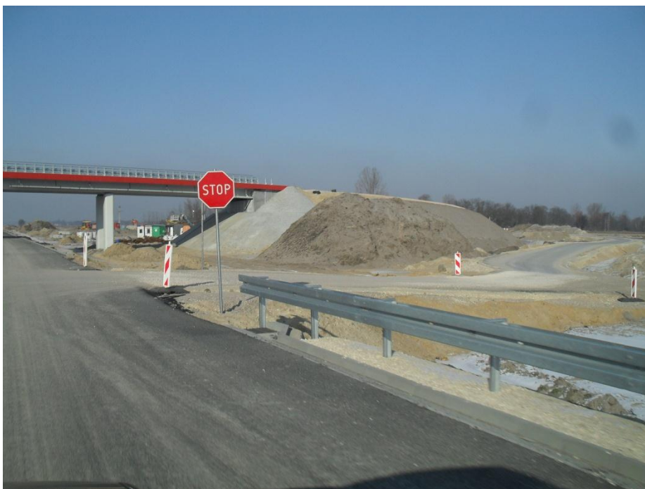
Fot2. Tymczasowy przejazd przez autostradę km 281+ 050.
