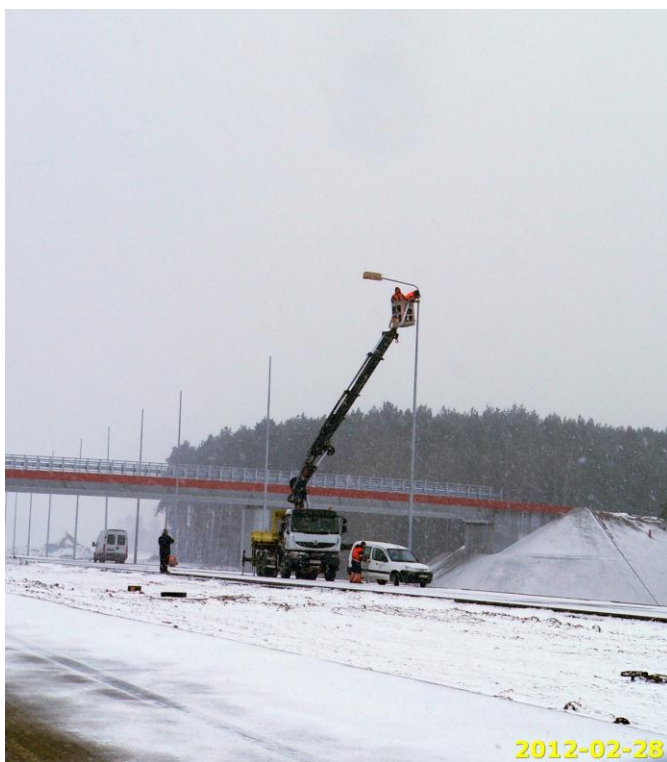
Zdjęcie 4. Realizacja oświetlenia w ciągu autostrady, 28.02.2012
