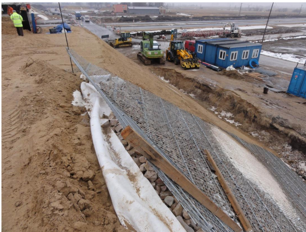
Zdjęcie 8. Najazd na WD-230, strona lewa, skarpa zbrojona gabionami, 22.02.2012
