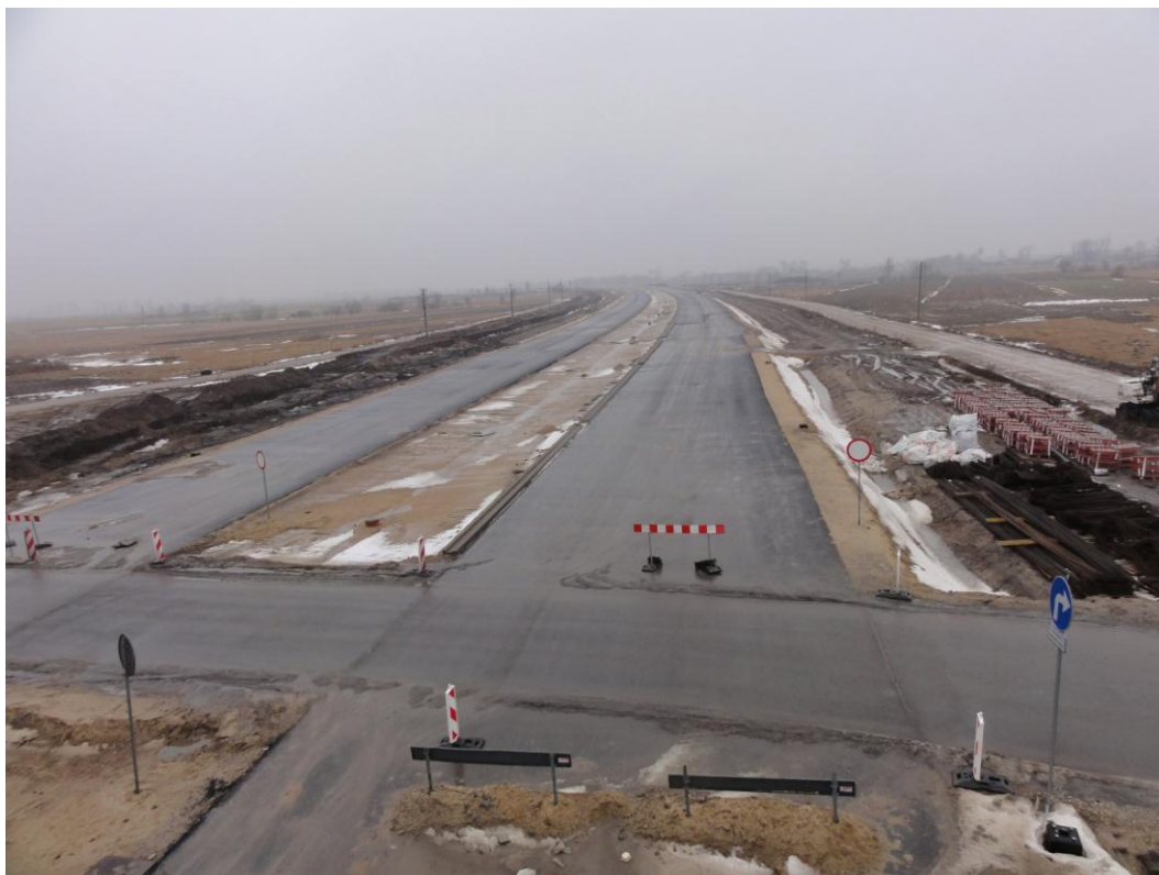
Zdjęcie 1. Widok na ciąg główny z obiektu WD-230 w kierunku Kutna, 22.02.2012
