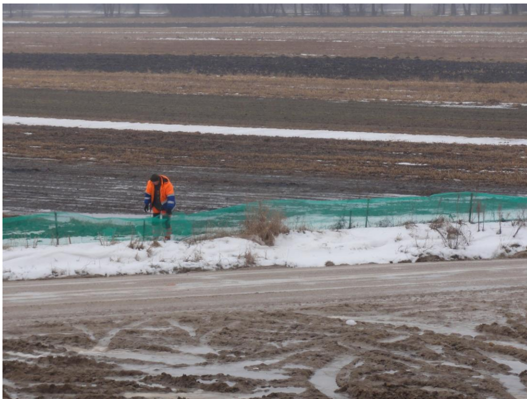
Zdjęcie 3. Naprawa płotków w km 287, 22.02.2012
