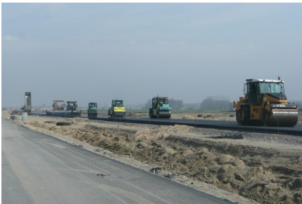
Zdjęcie 3. Układanie masy przy WD-237, 20.04.2012
