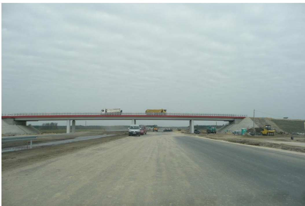
Zdjęcie 6. Próbnne obciążenie na WD-237, 18.04.2012
