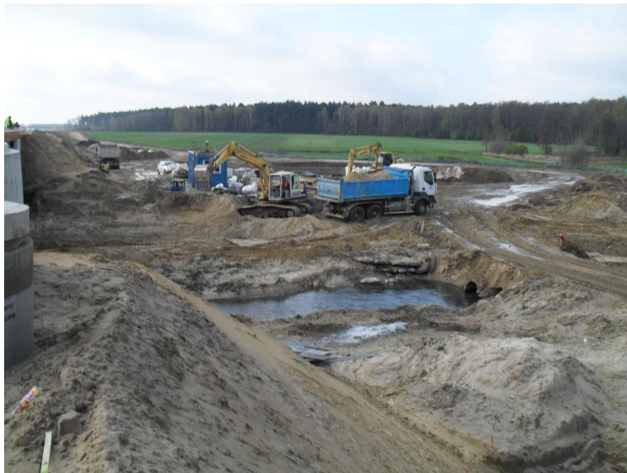
Fot3. Przekładanie koryta rzeki Maliny.
