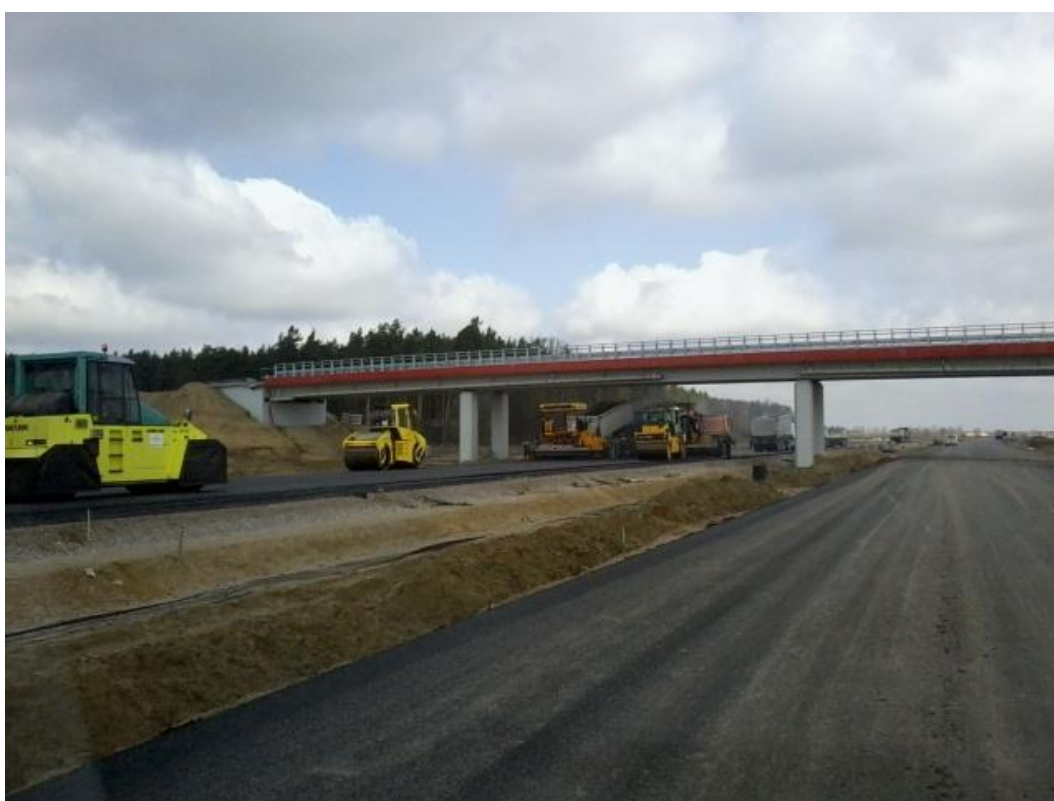
Zdjęcie 4. Układanie masy przy WD-237, 20.04.2012
