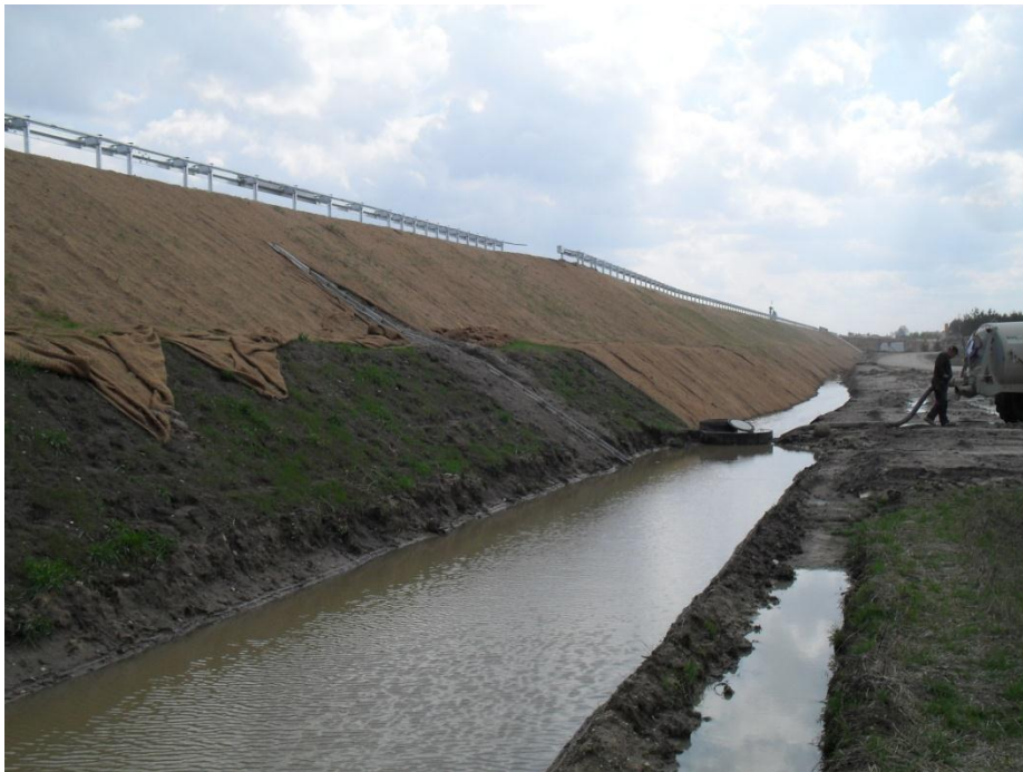
Fot1. Zakładanie mat kokosowych na nasypie w km 283+100.
