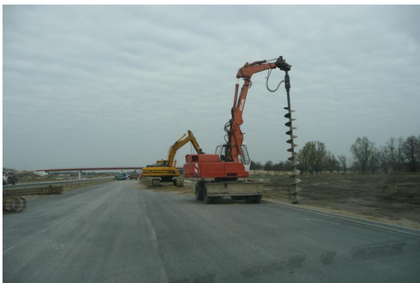
Zdjęcie 14. Wiercenie otworów pod słupy ekranów akustycznych w okolicach WD-232, 18.04.2012
