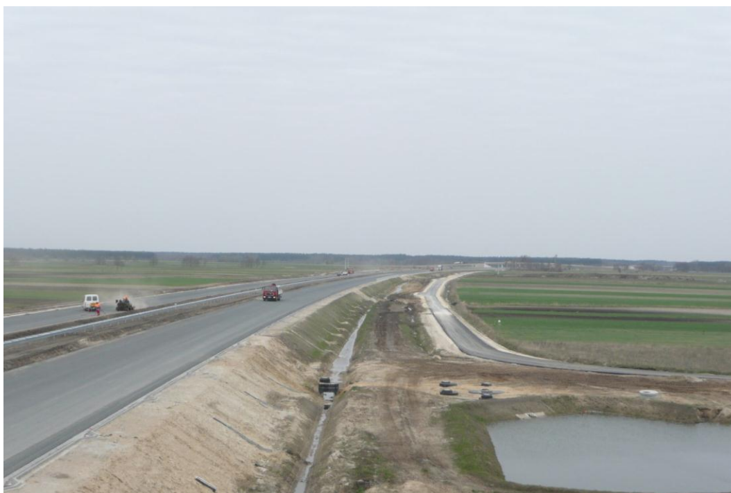
Zdjęcie 1. Widok na ciąg główny z obiektu WD-238 w kierunku WD-231, 18.04.2012
