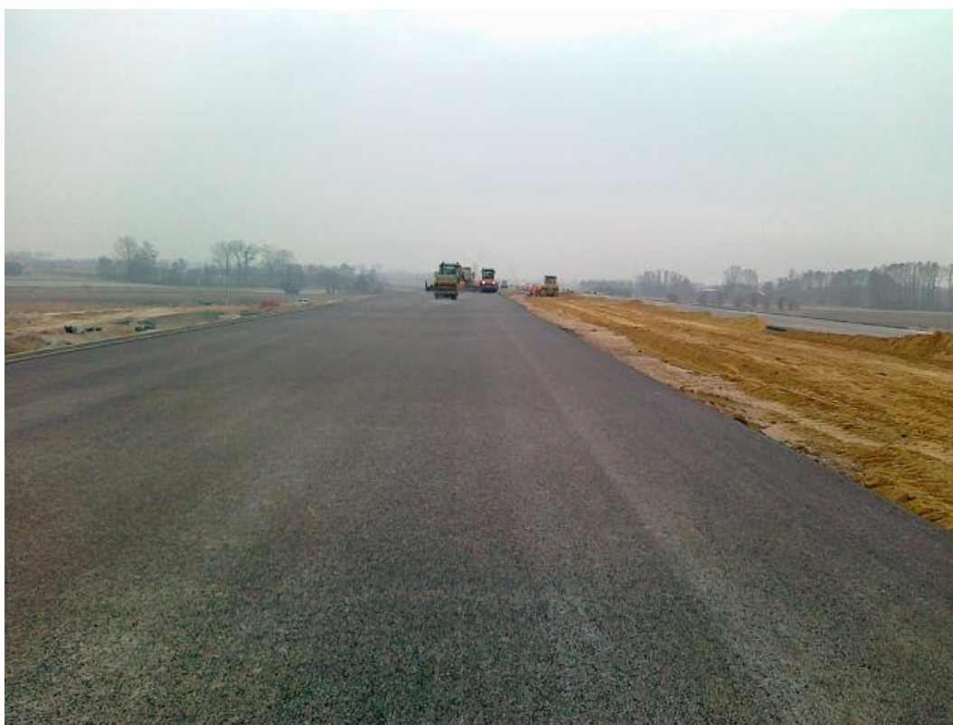
Zdjęcie 2. Warstwa wiążąca w km 287+915 – 288+880, 21.12.2011
