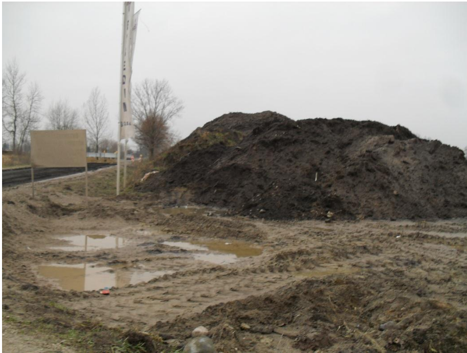
Fot3. Hałdy humusu sukcesywnie wbudowywanego w nasyp autostrady.
