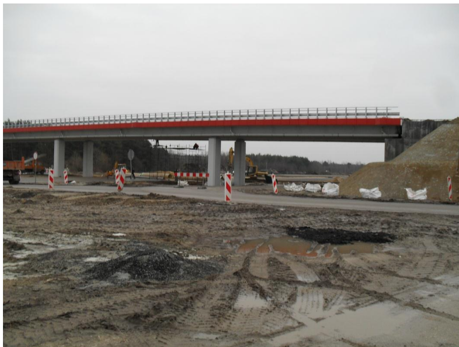
Fot1. Konstrukcja wiaduktu drogowego na drodze 703.
