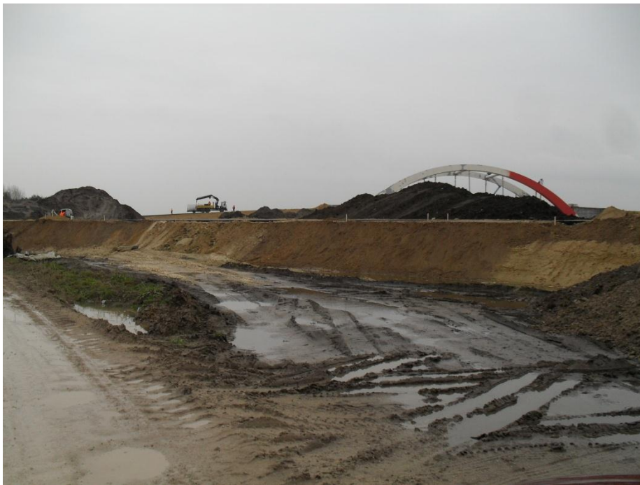
Fot 4. Budowa wiaduktu WD-231.
