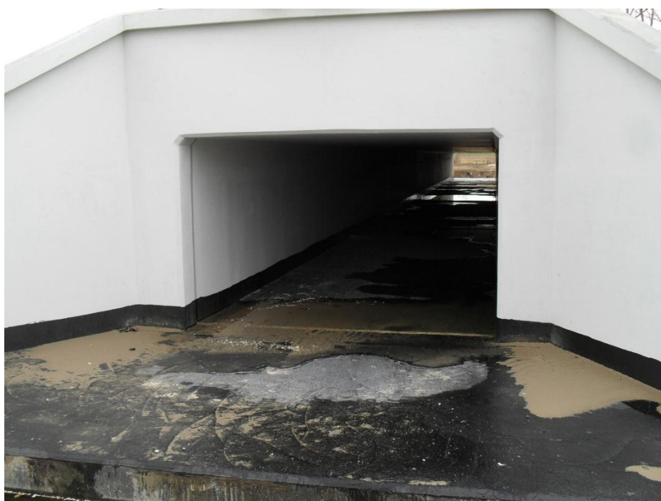
Fot2. Przepust P-6 niedostosowany jeszcze do roli przejścia dla zwierząt..
