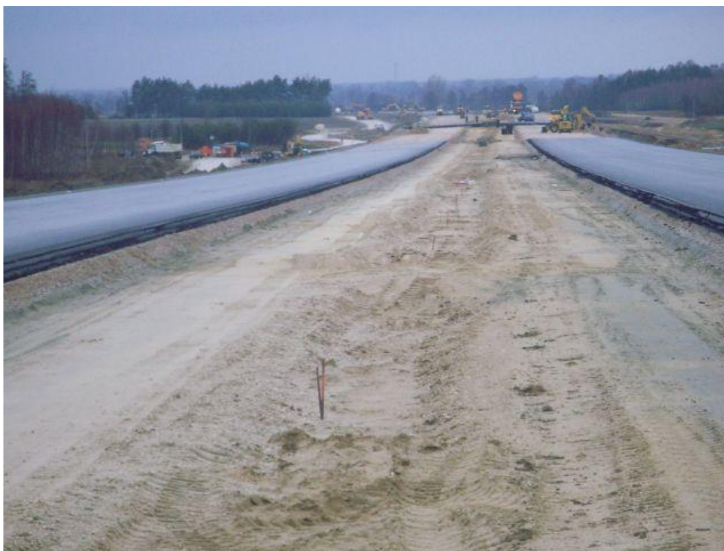
Zdjęcie 1. Widok na ciąg główny z obiektu PZ-239A, 07.12.2011
