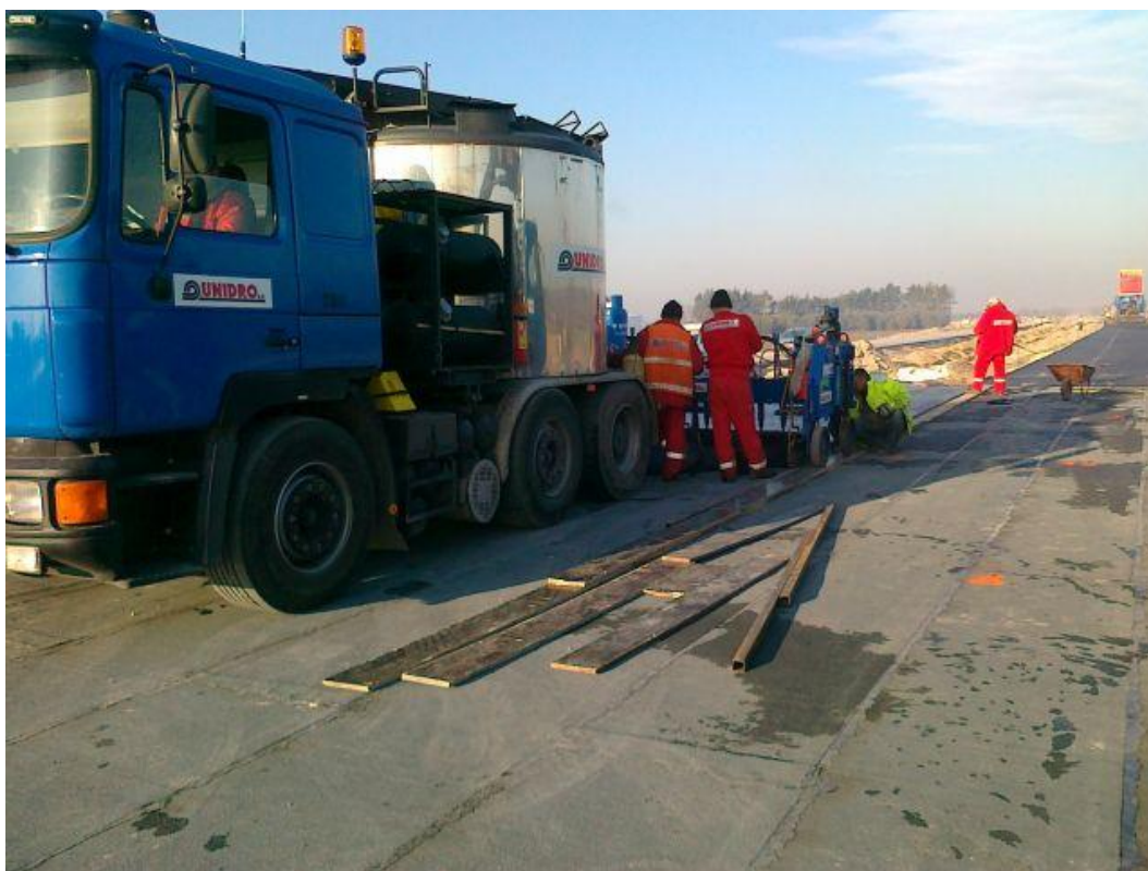
Zdjęcie 12. Ekipa układająca asfalt twardo lany na obiekcie PZ-239B, 12.12.2011
