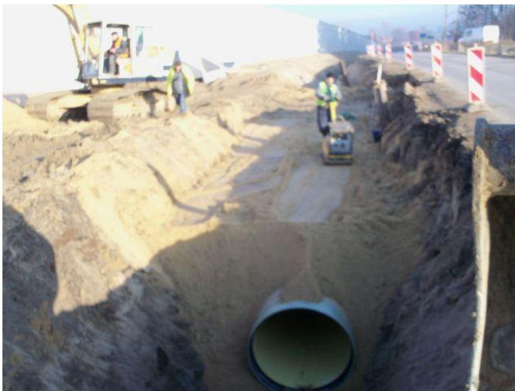
Zdjęcie 6. Zagęszczanie obsypki w rowie M, 12.12.2011
