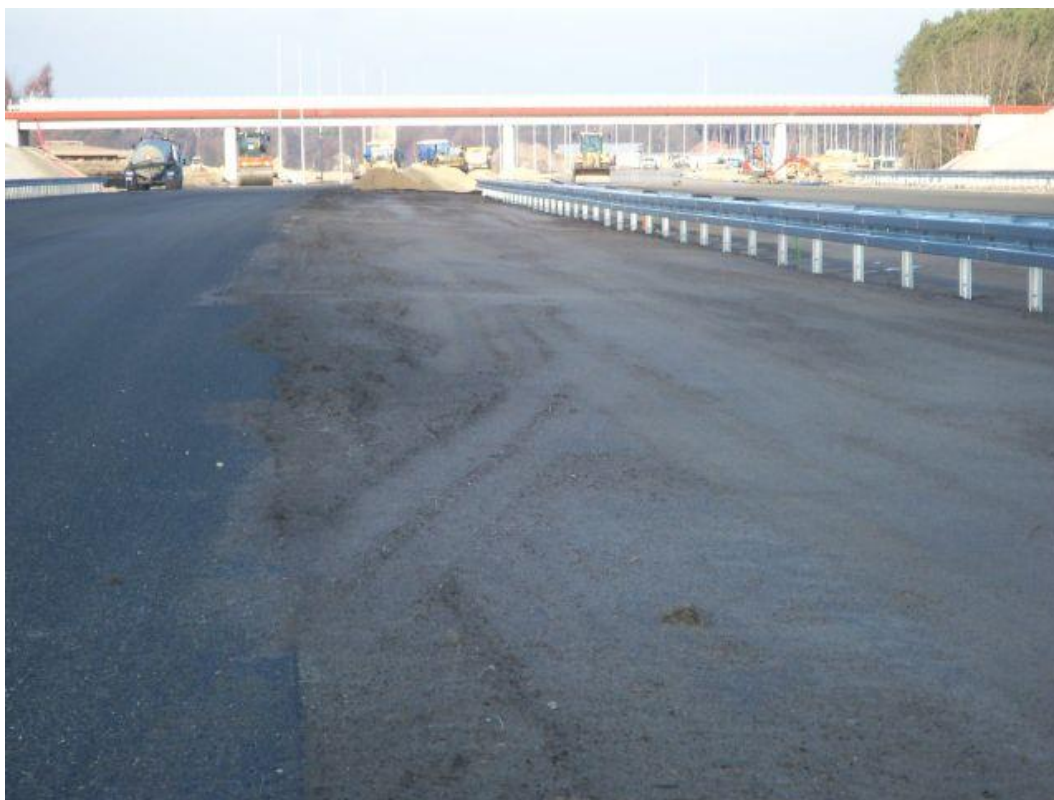
Zdjęcie 4. Bariery w pasie rozdziału przy WD-236, 17.12.2011
