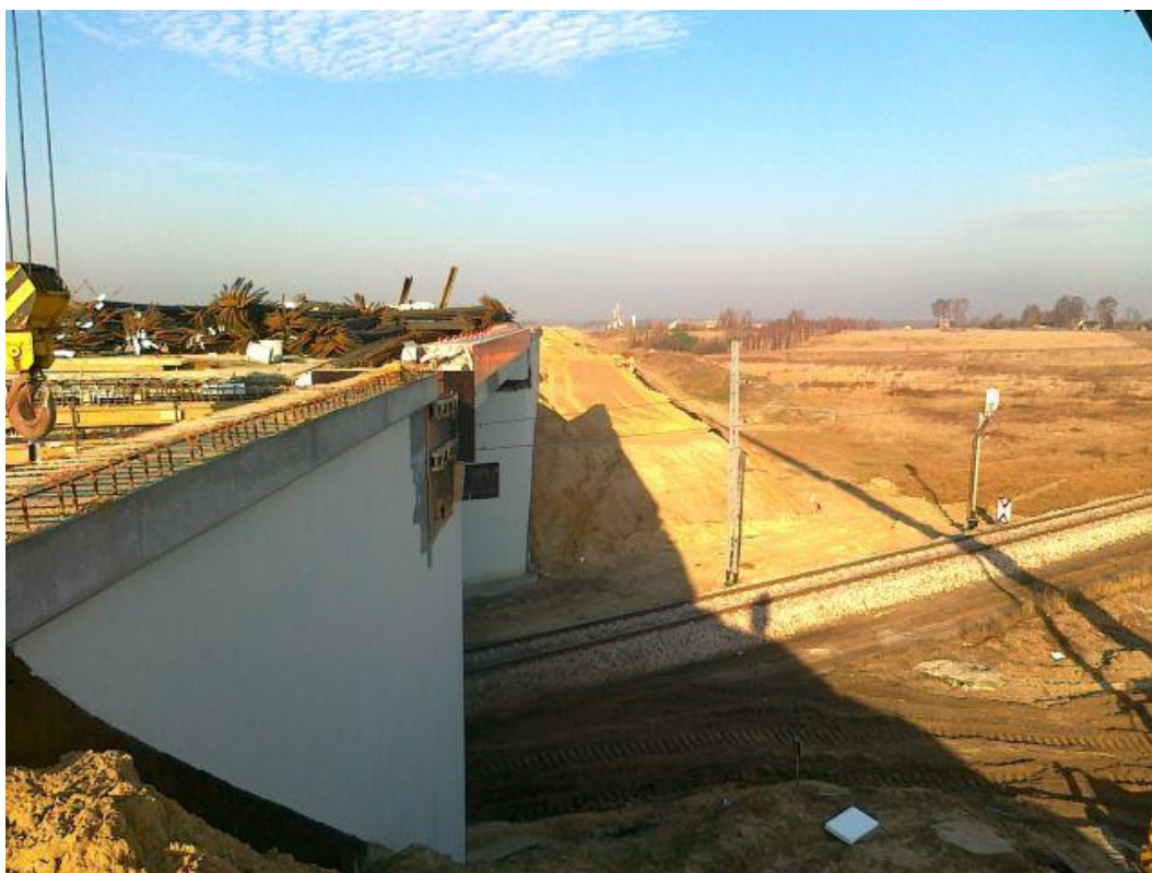
Zdjęcie 11. Skarpy nasypu, obiektu WA-241, str., L, 12.12.2011
