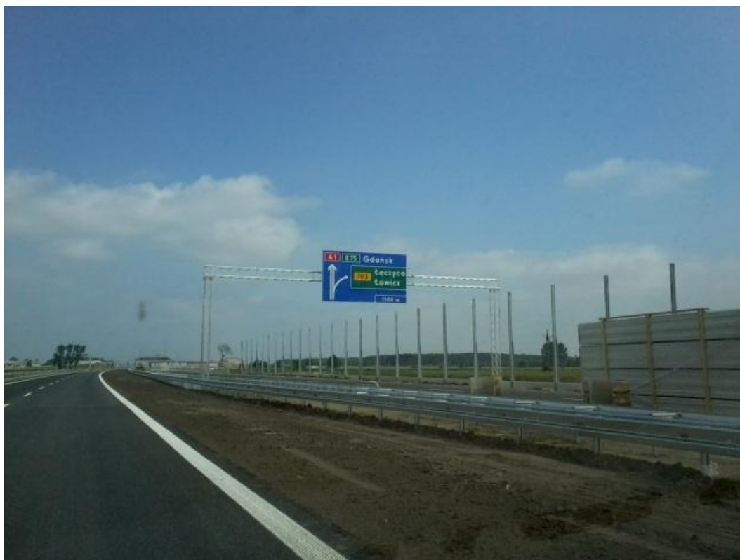
Zdjęcie 5. Widok na ciąg główny przy PZ-239A
