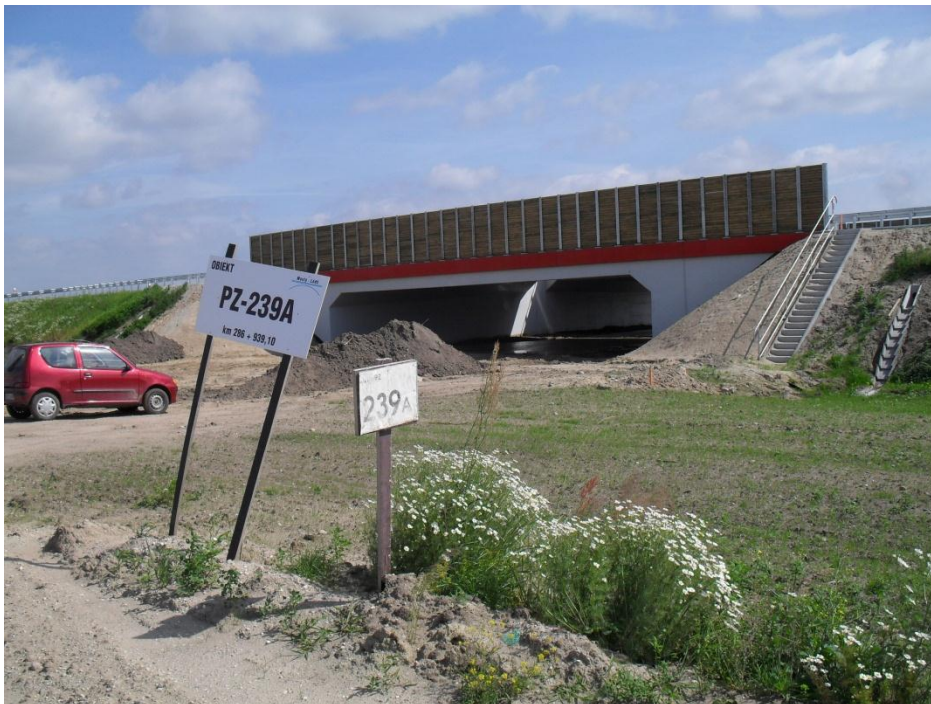
Fot 4. Prace ziemne przy przejściu dla zwierząt PZ 239a.
