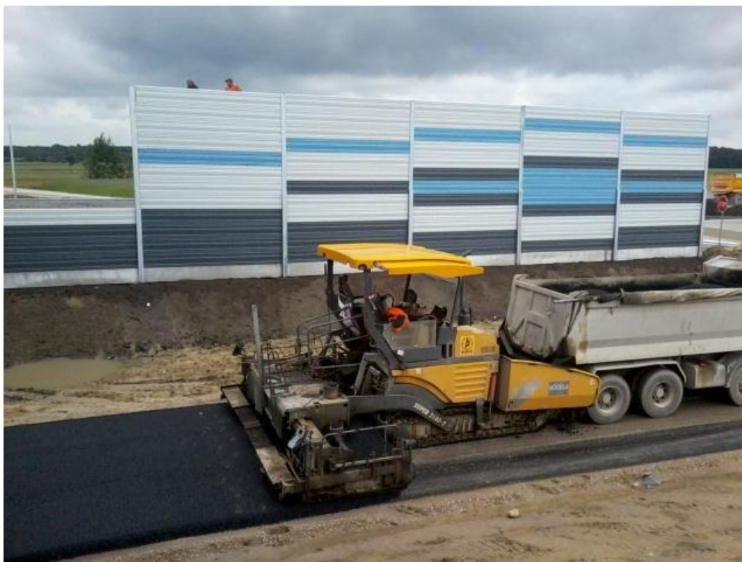
Zdjęcie 6. Widok z obiektu WD-239 na drogę serwisową, 13.06.2012
