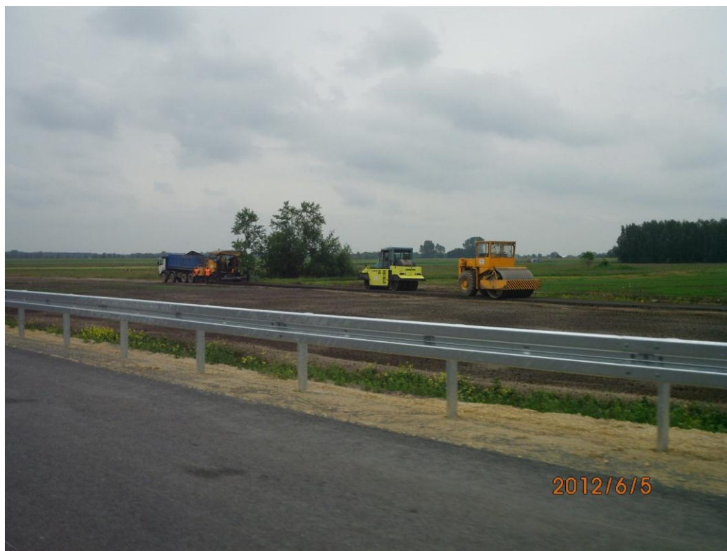
Zdjęcie 7. Droga serwisowa, 05.06.2012
