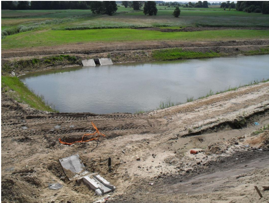
Fot3. Zbiorniki ppoż i ekologiczne są zasiedlone przez płazy.
