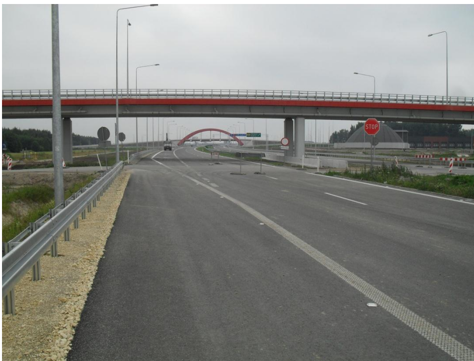
Fot1. Większość prac budowlanych została zakończona. Widok na węzeł Piątek i wiadukt WD230.
