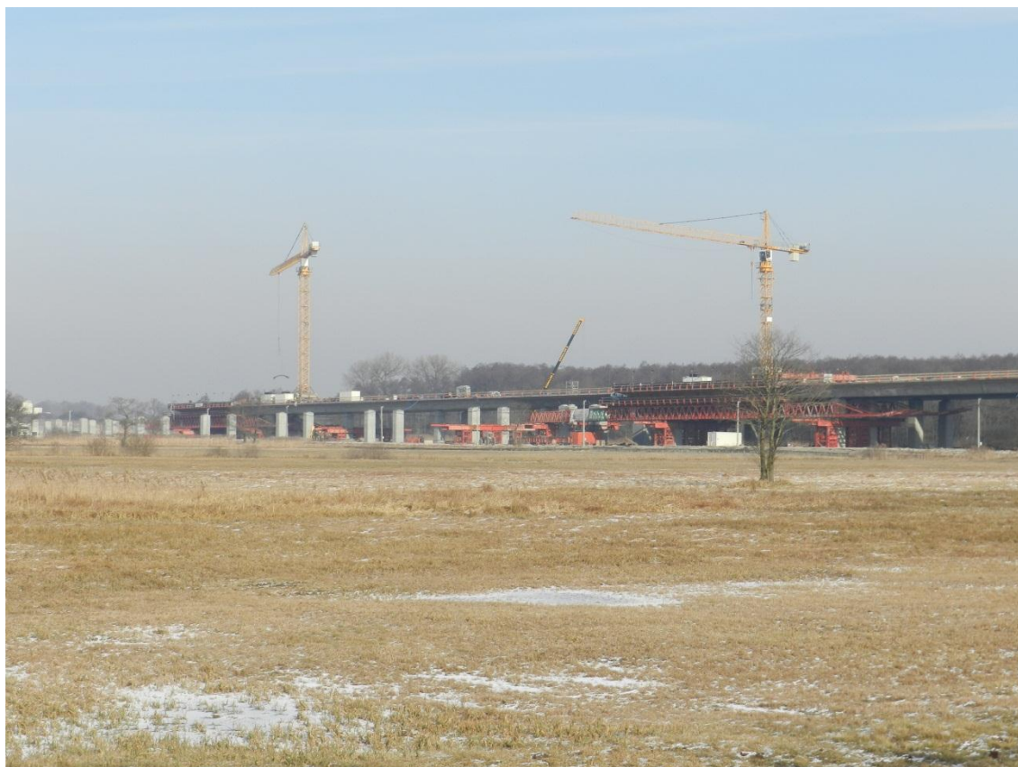
Fot. 20 Wykonywanie ustroju nośnego estakady E-221 dwoma niezależnymi wózkami
