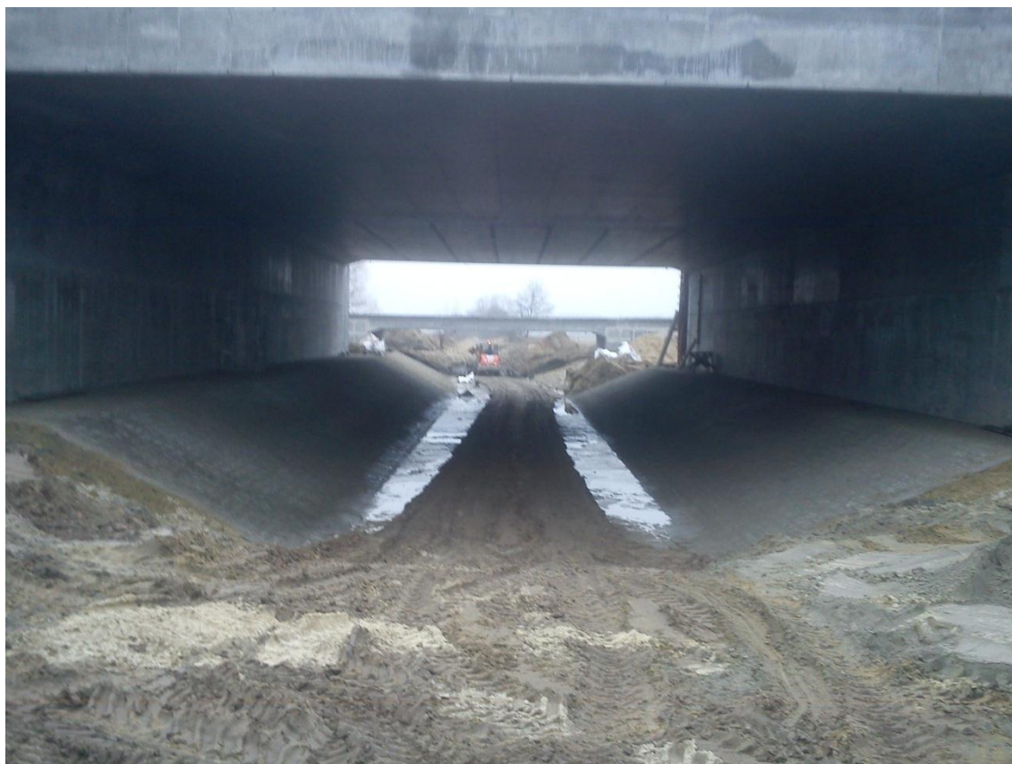
Fot. 9 Wykonanie obruku koryta rzeki Moszczenica pod obiektem MA-228 10.01.2012
