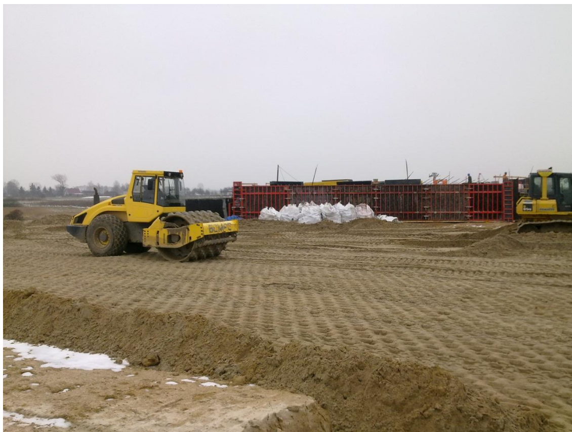
Fot. 15 Prowadzenie prac na nasypie do obiektu MA-228 od strony pn. 18.01.2012
