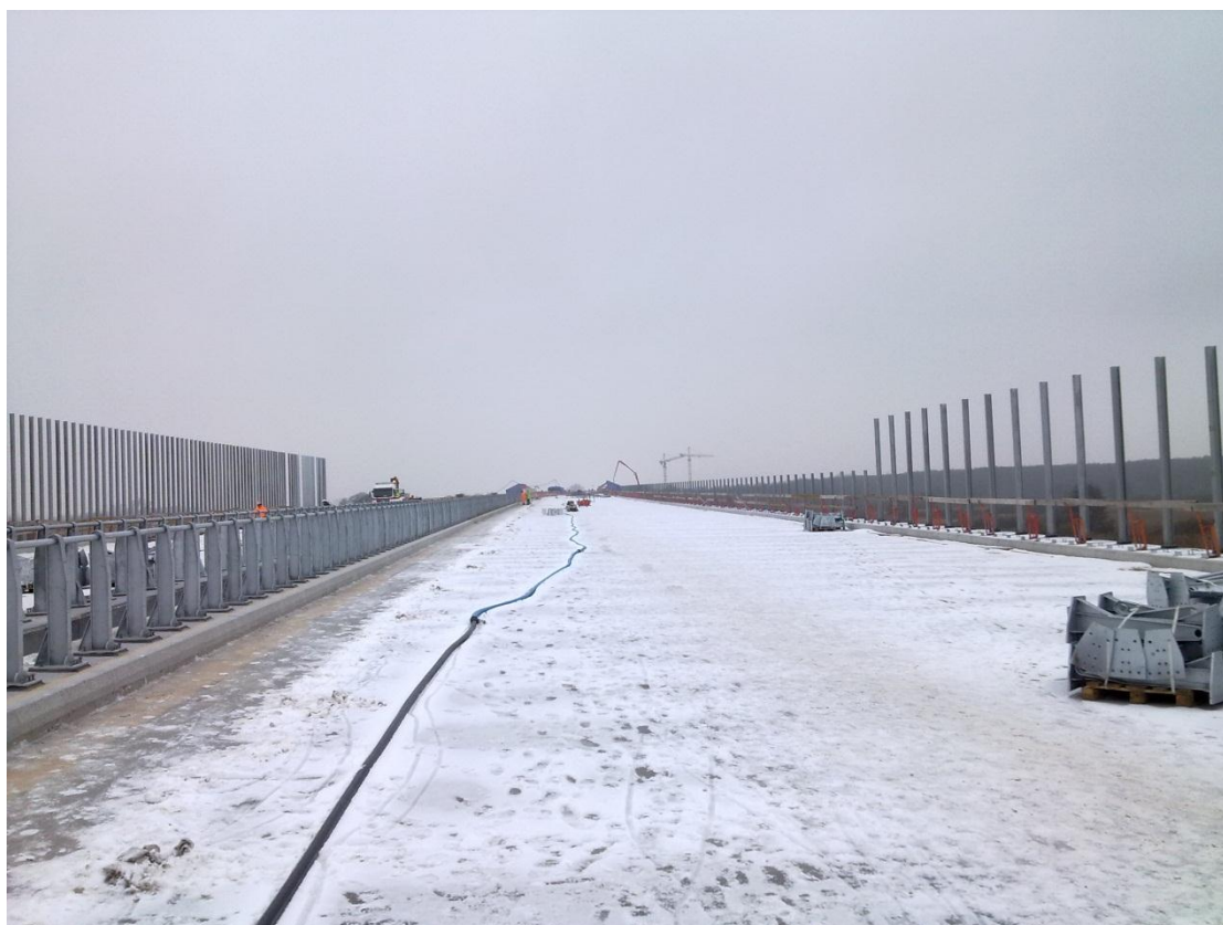
Fot. 16 Montaż słupków do ekranów akustycznych i bariereporęczny na estakadzie E-221 18.01.2012
