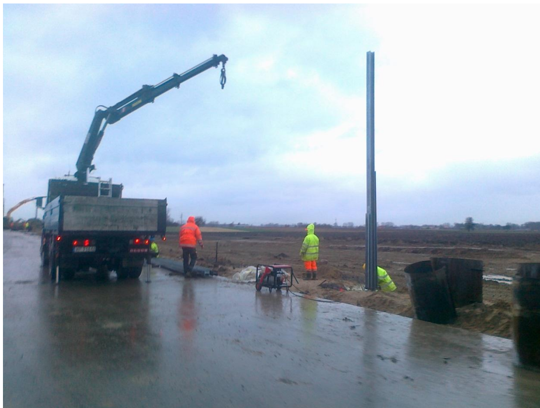
Fot. 2 Montaż słupów ekranów 05.01.2012
