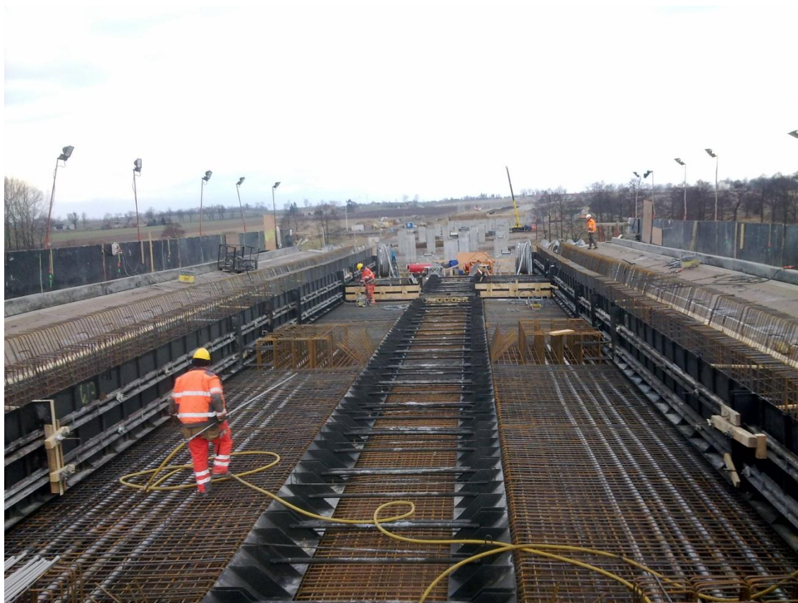
Fot. 6 Przygotowanie do betonowania 1 etapu ustroju nośnego E-221, nitka L 09.01.2012
