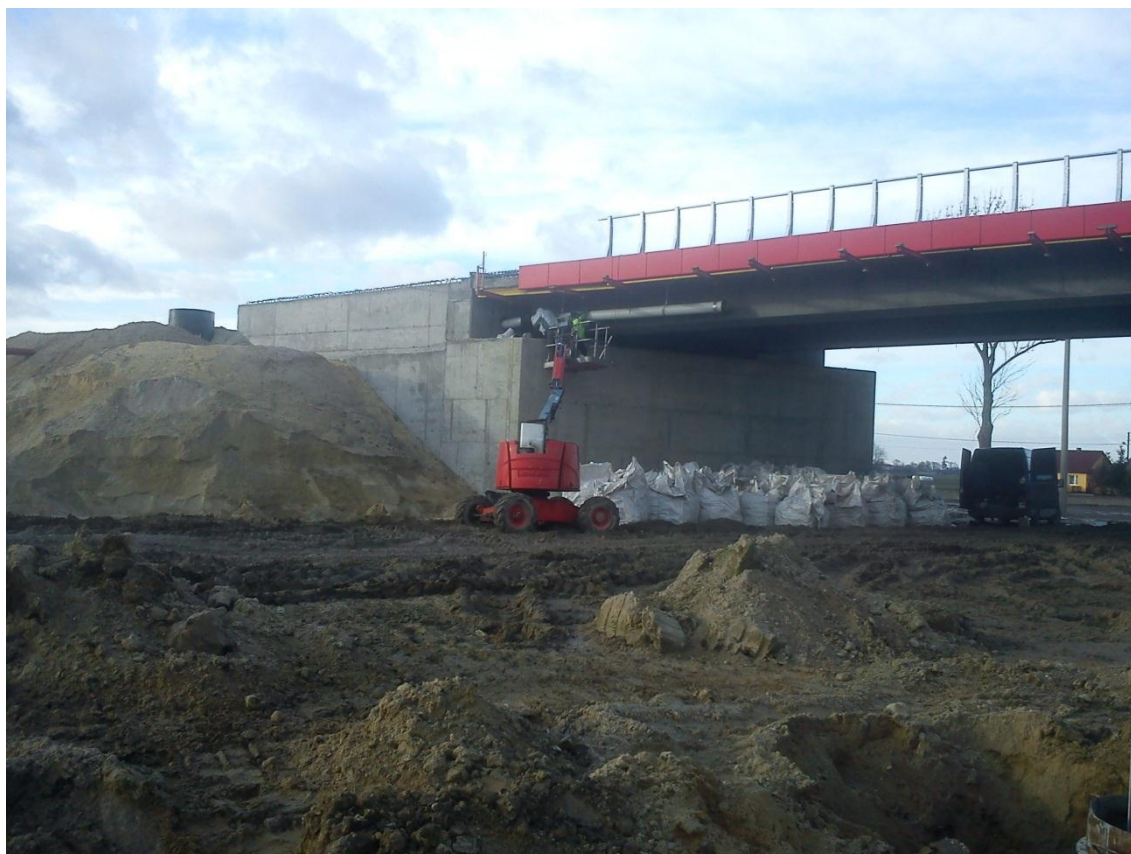
Fot. 5 Montaż kolektora odwadniającego na obiekcie WD-220 04.01.2012
