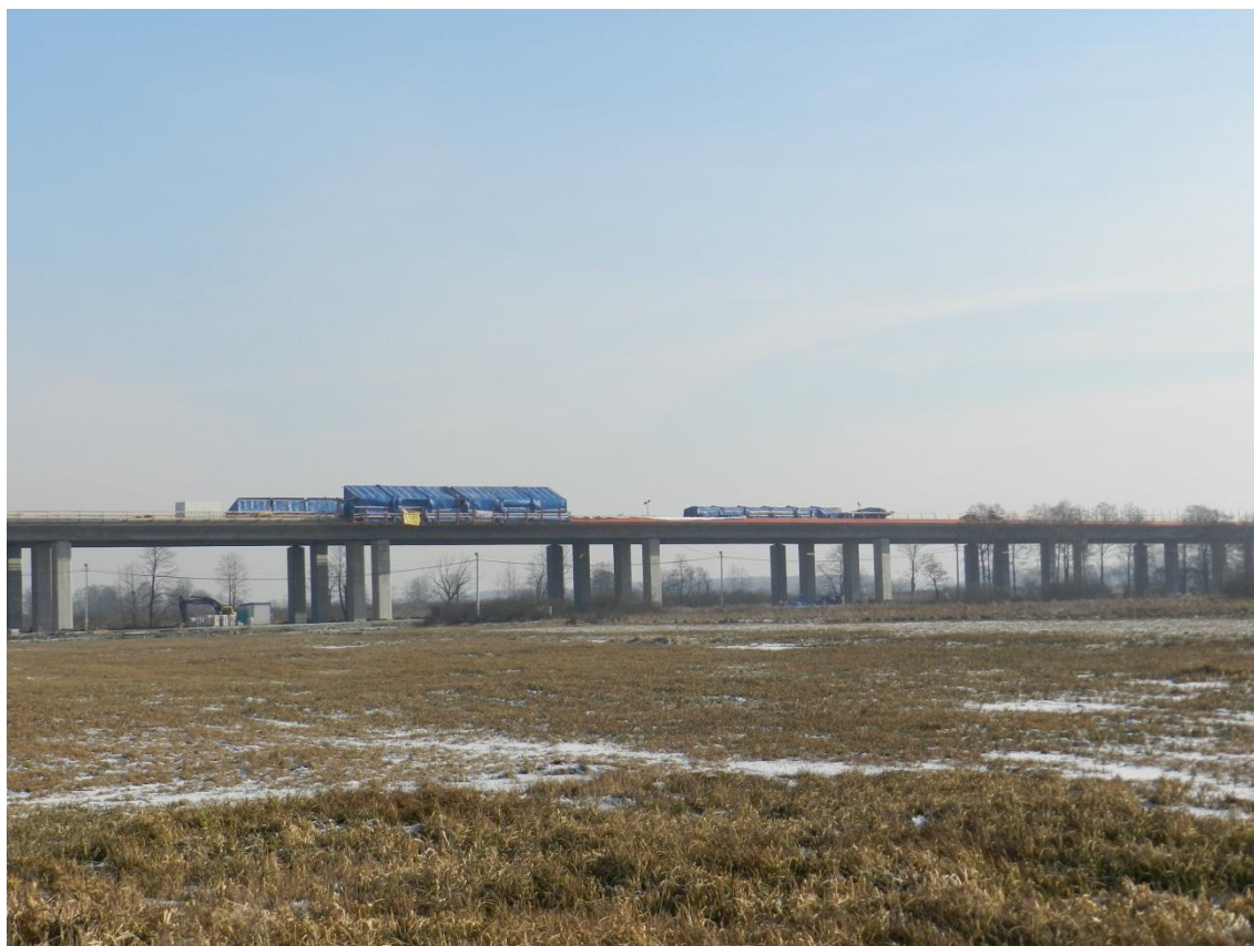
Fot. 17 Wykonywanie kap chodnikowych i montaż desek gzymsowych na E-221 31.01.2012
