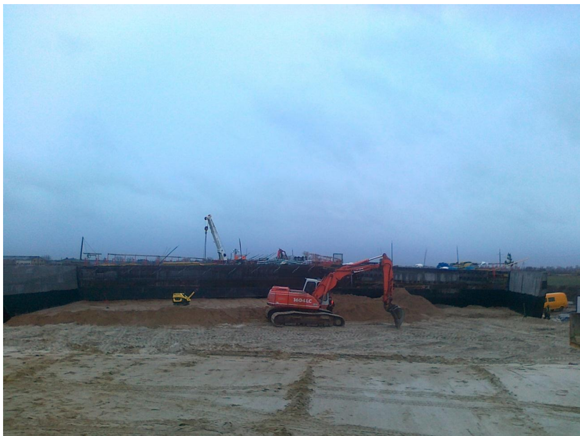
Fot. 10 Zasyпка przyczółka MA228 05.01.2012
