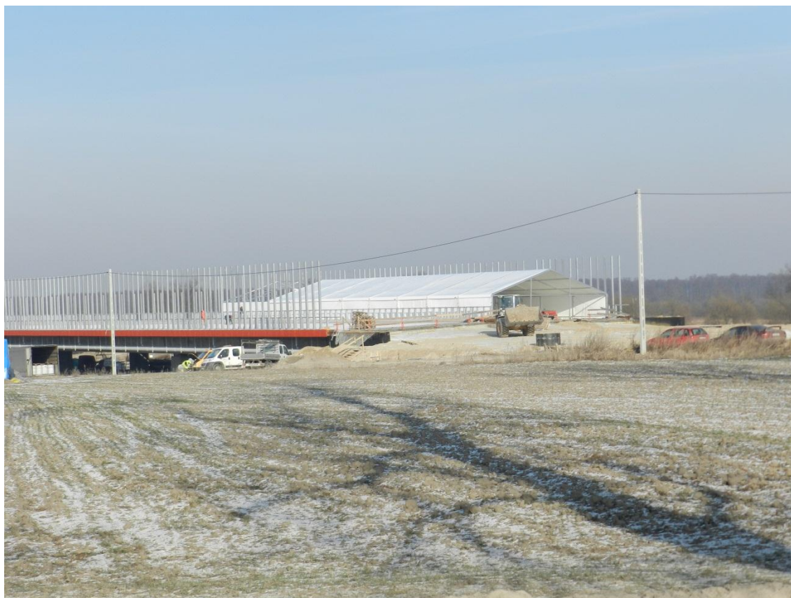
Fot. 19 Ogrzewany namiot układania hydroizolacji na ustroju nośnym E-221 31.01.2012
