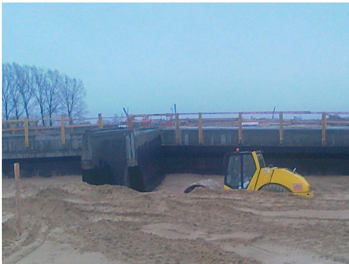
Fot. 11 Wykonywanie zasyпки PG225 05.01.2012
