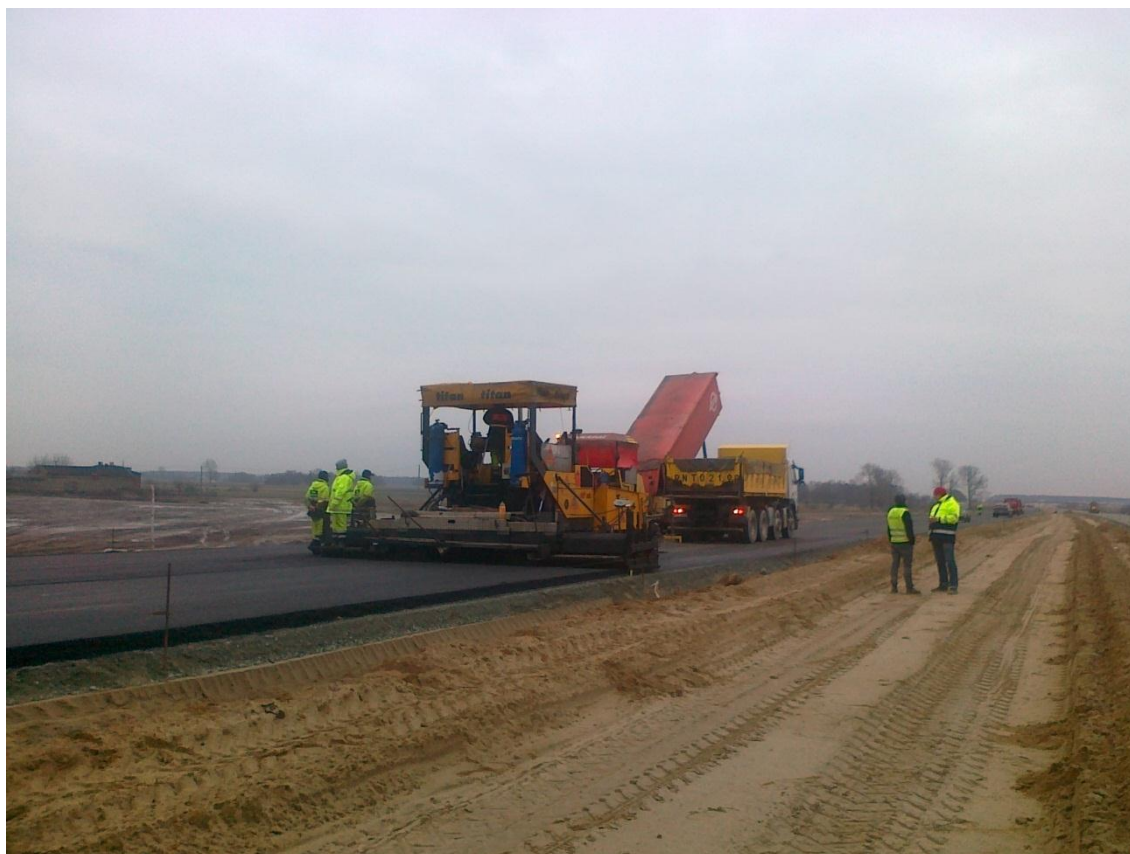
Fot. 13 Podbudowa bitumiczna 269+300 11.01.2012
