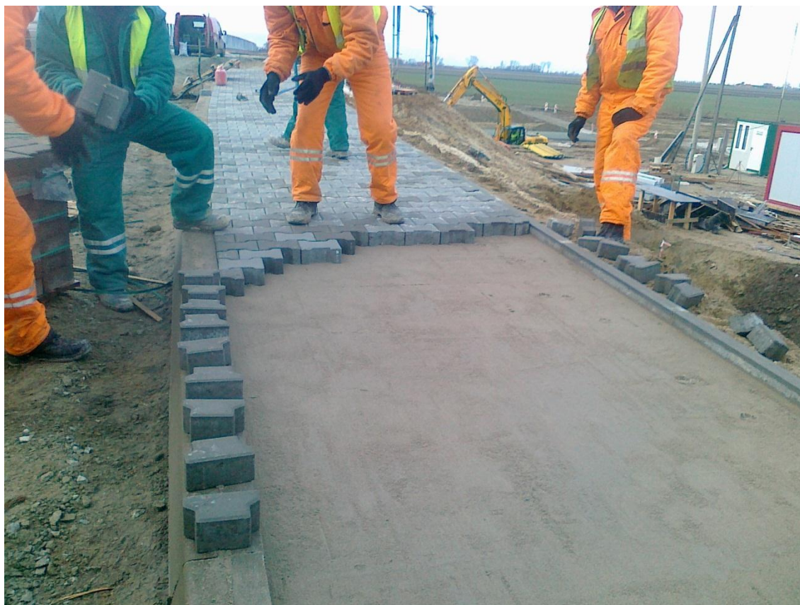
Fot. 3 Układanie chodnika na dojeździe WD219 06.01.2012
