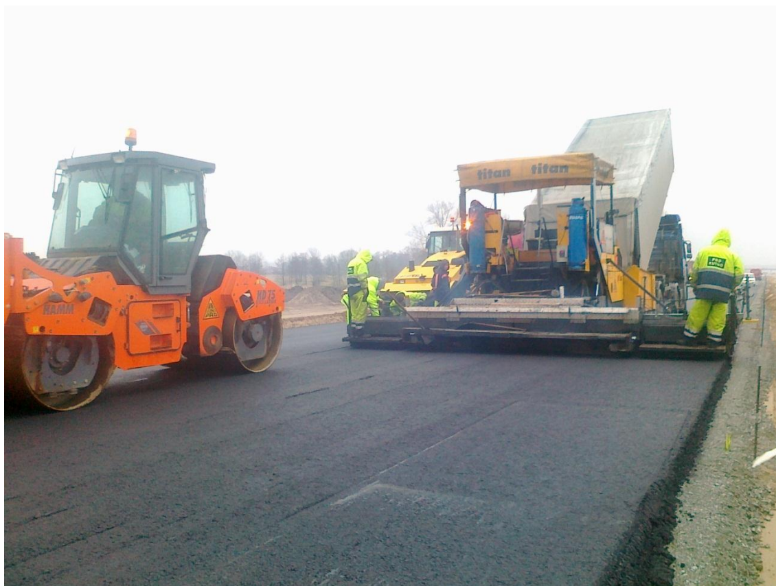
Fot. 14 Podbudowa bitumiczna 269+200 12.01.2012
