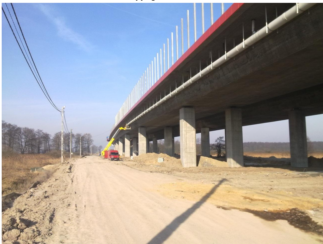
Fot. 18 Montaż kolektora odwadniającego na estakadzie E-221 31.01.2012
