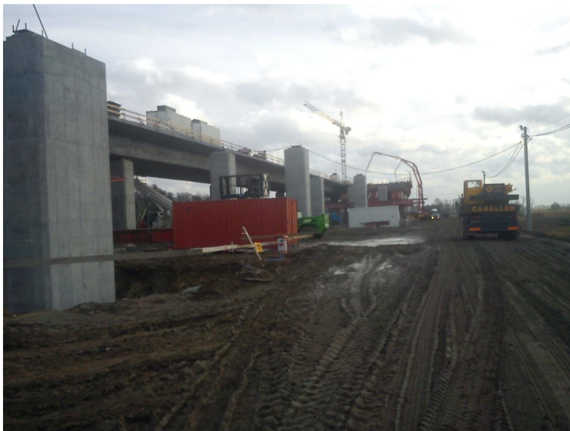
Fot. 4 Betonowanie taktu 25 - etap 1 na nitce prawej estakady E-221 04.01.2012
