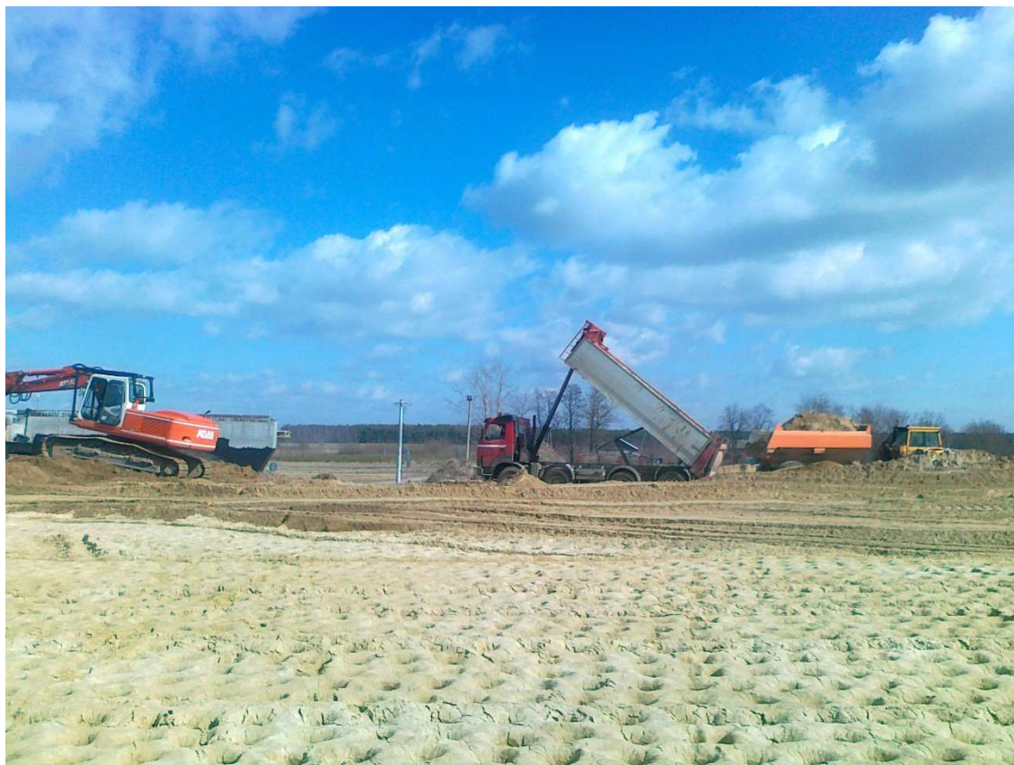
Fot. 5 Zasyпка przyczółków PG226A 19.03.2012
