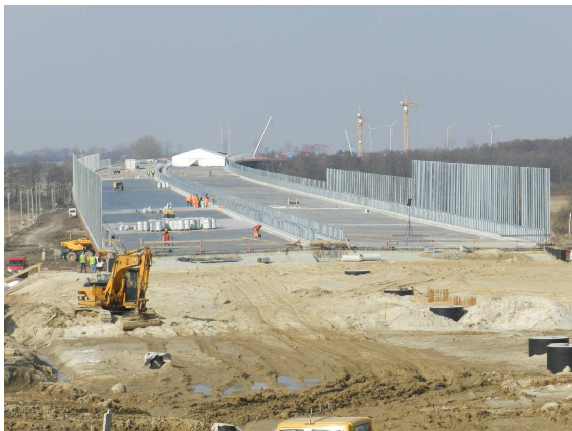
Fot. 12 Widok na estakadę od strony przyczółka pd 07.03.2012
