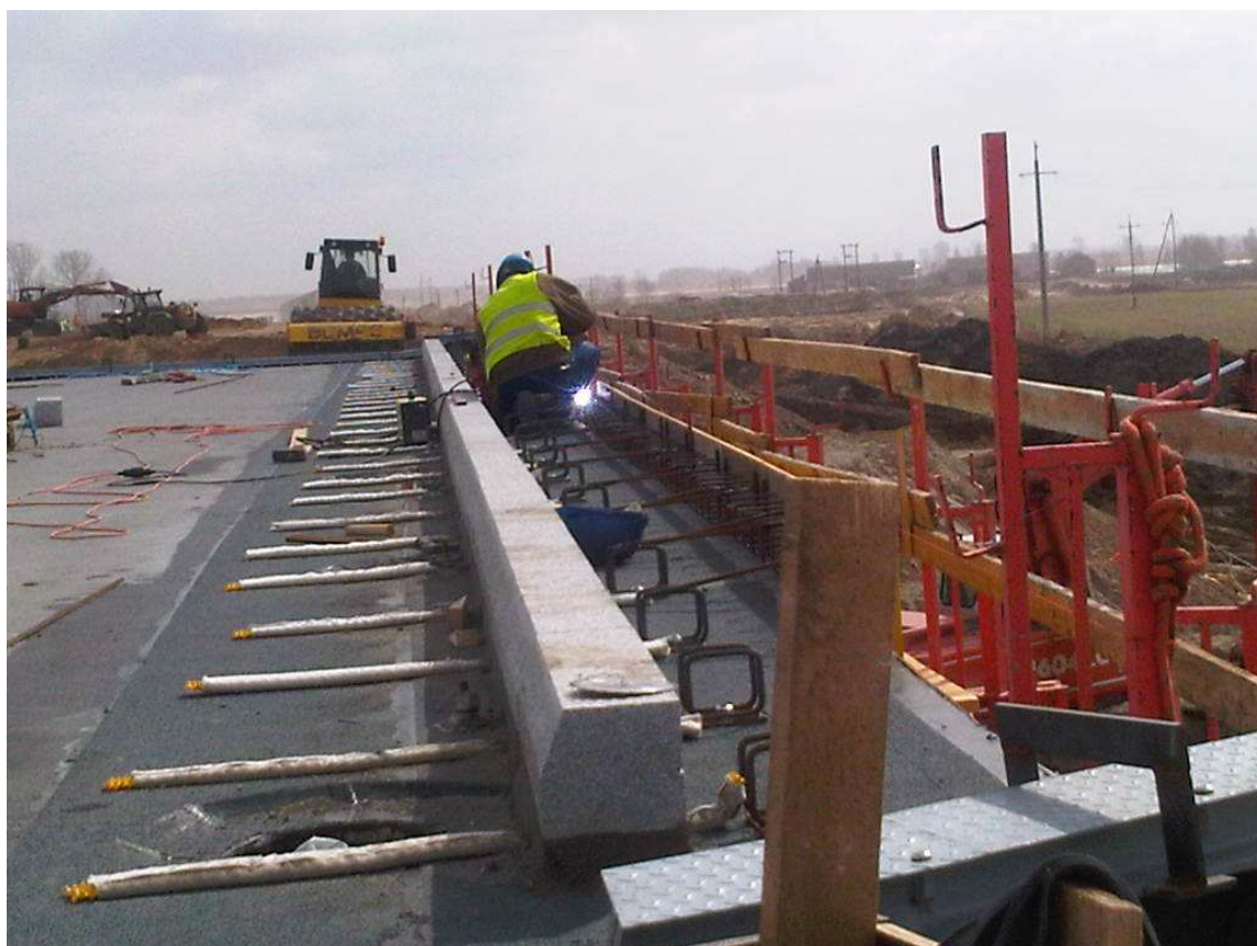
Fot. 16 Układanie krawężników i montaż desek gzymsowych na MA-228 29.03.2012
