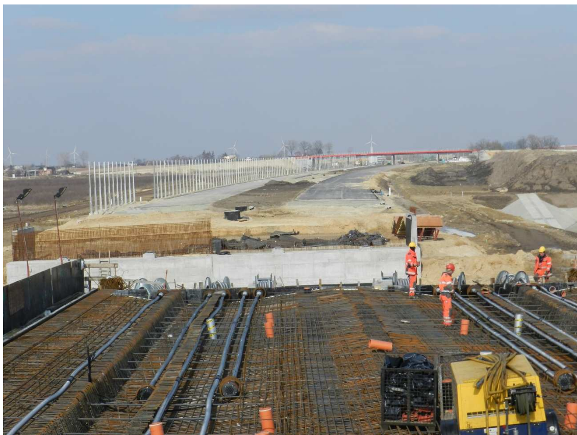
Fot. 10 układanie kabli sprężających - takt 37, nitka lewa E221 07.03.2012
