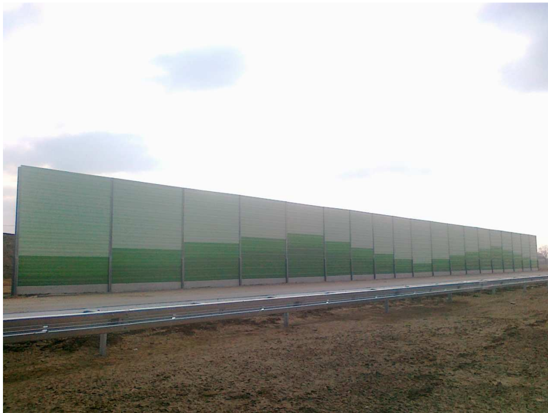
Fot. 1 Ekran akustyczny E11 07.03.2012
