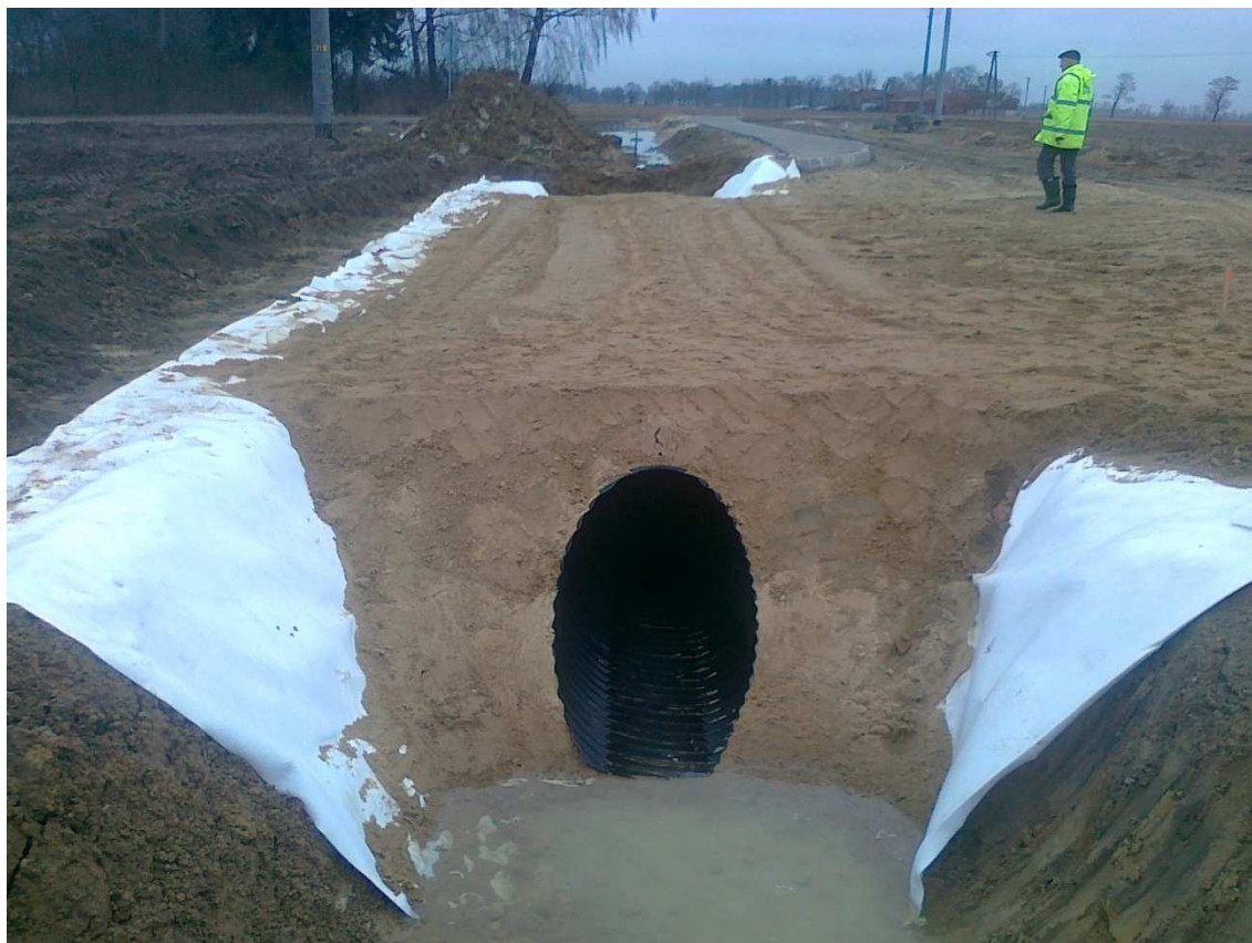
Fot. 3 Przepust przy drodze dojazdowej do WD219 14.03.2012
