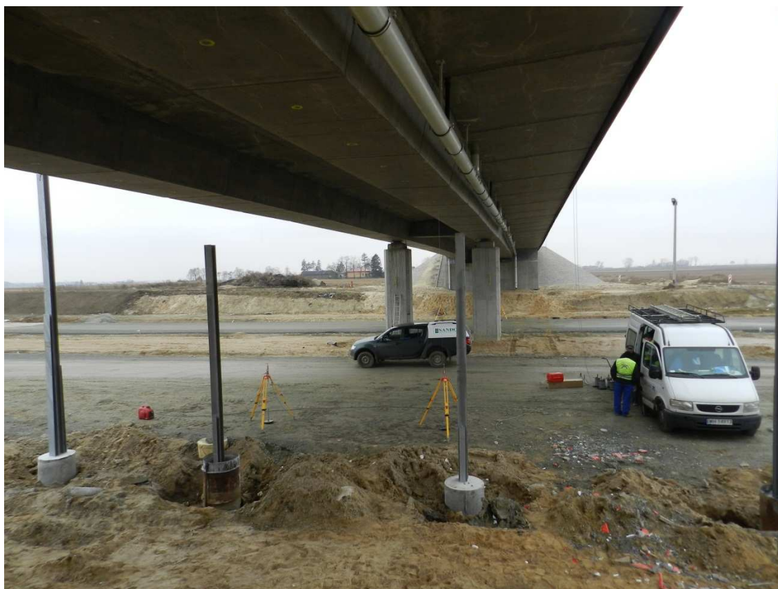
Fot. 17 Wykonywanie próbnych obciążeń statycznych na wiadukcie WD-219 15.03.2012
