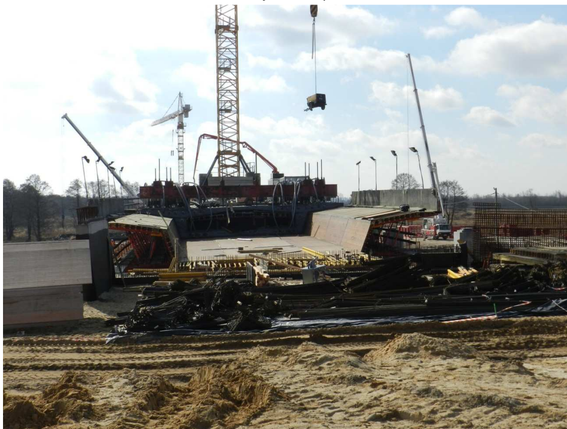
Fot. 18 Deskowanie taktu 39 nitki lewej estakady E-221 20.03.2012
