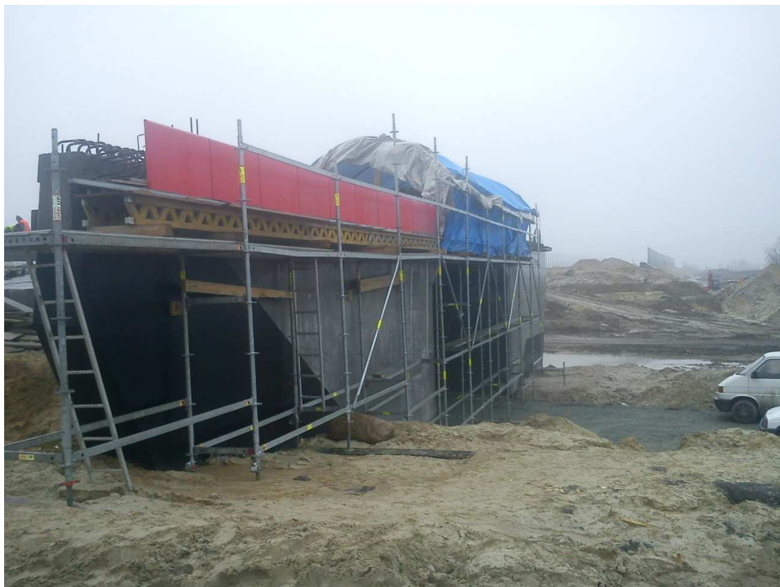
Fot. 9 Montaż desek gzymsowych, krawężników i zbrojenie kap na PG-225 01.03.2012
