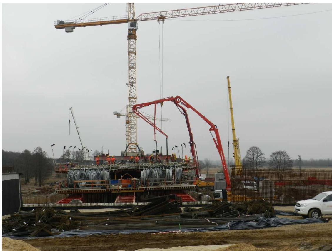
Fot. 13 Brtonowanie taktu 38 na nitce lewej estakady E-221 15.03.2012
