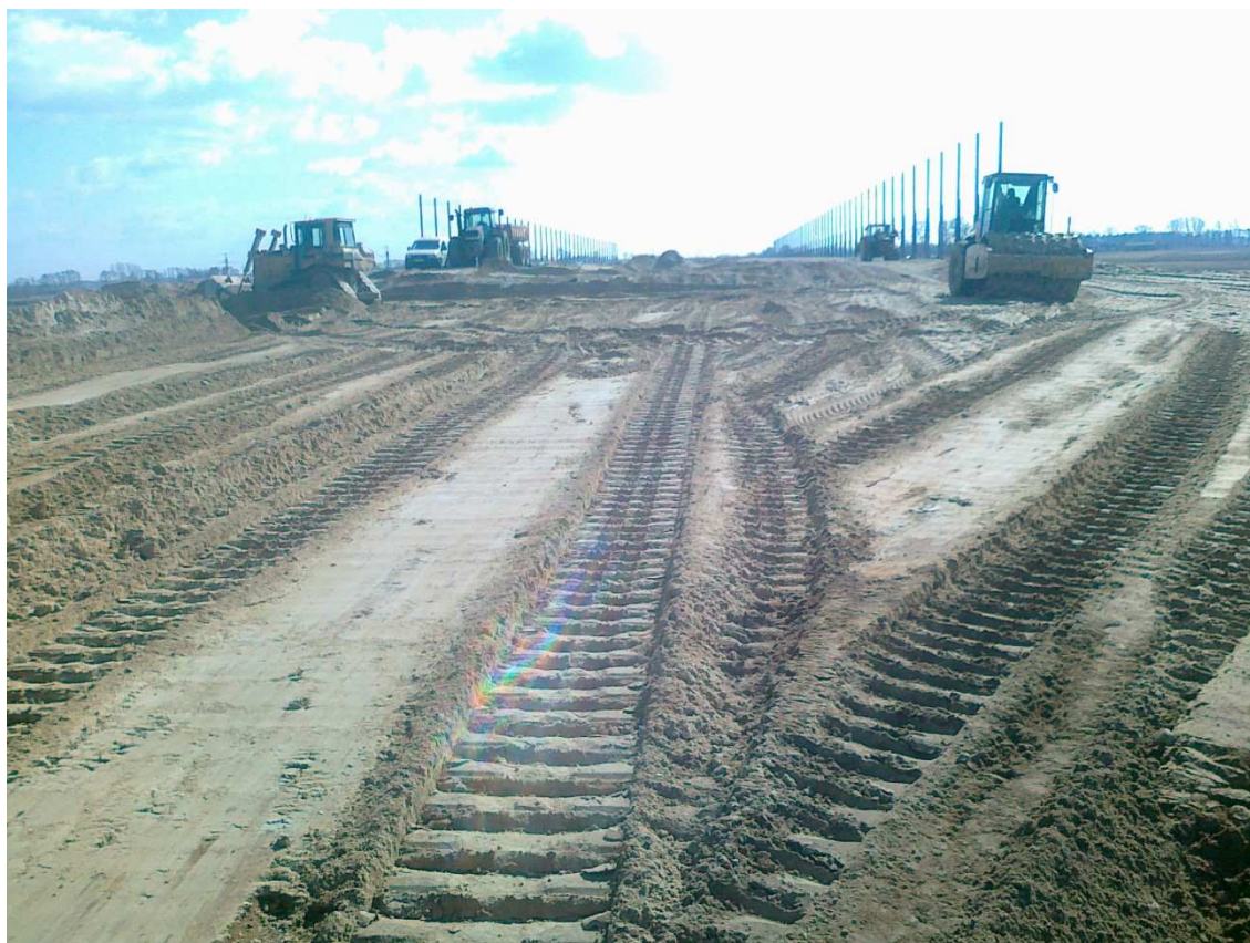
Fot. 6 Budowa nasypu 267+300 19.03.2012
