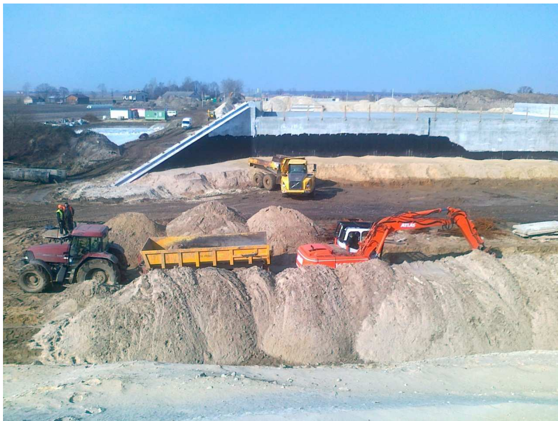
Fot. 2 Budowa nasypu 266+800 08.03.2012
