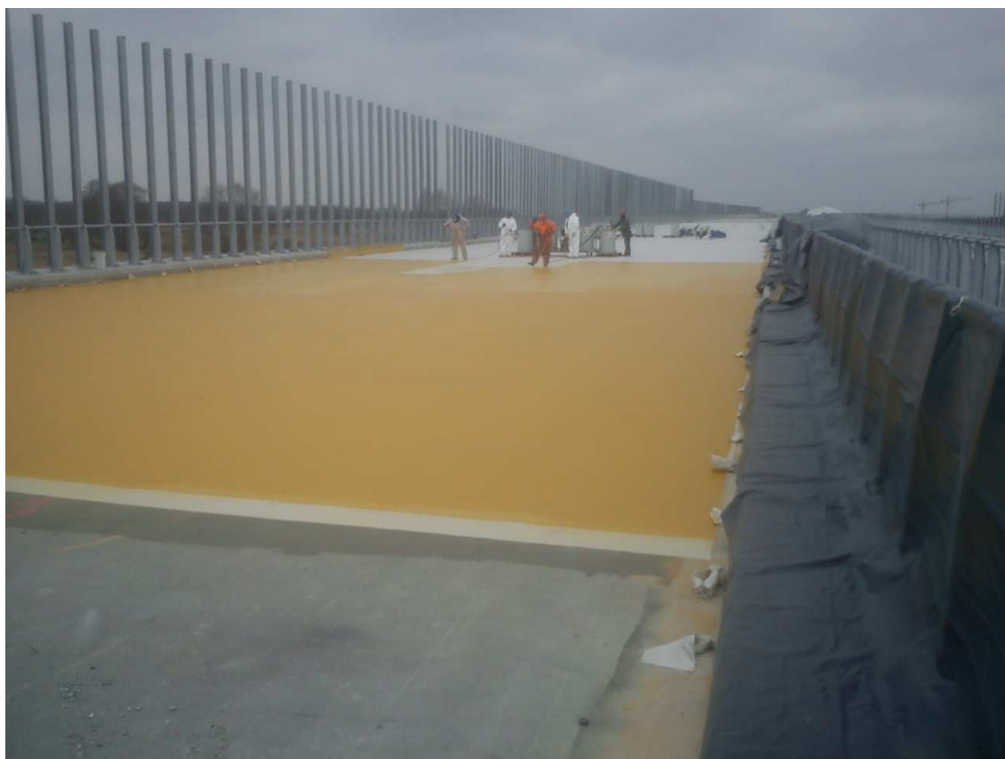
Fot. 14 Układanie izolacji ELIMINATOR na płycie ustroju nośnego - E-221 21.03.2012
