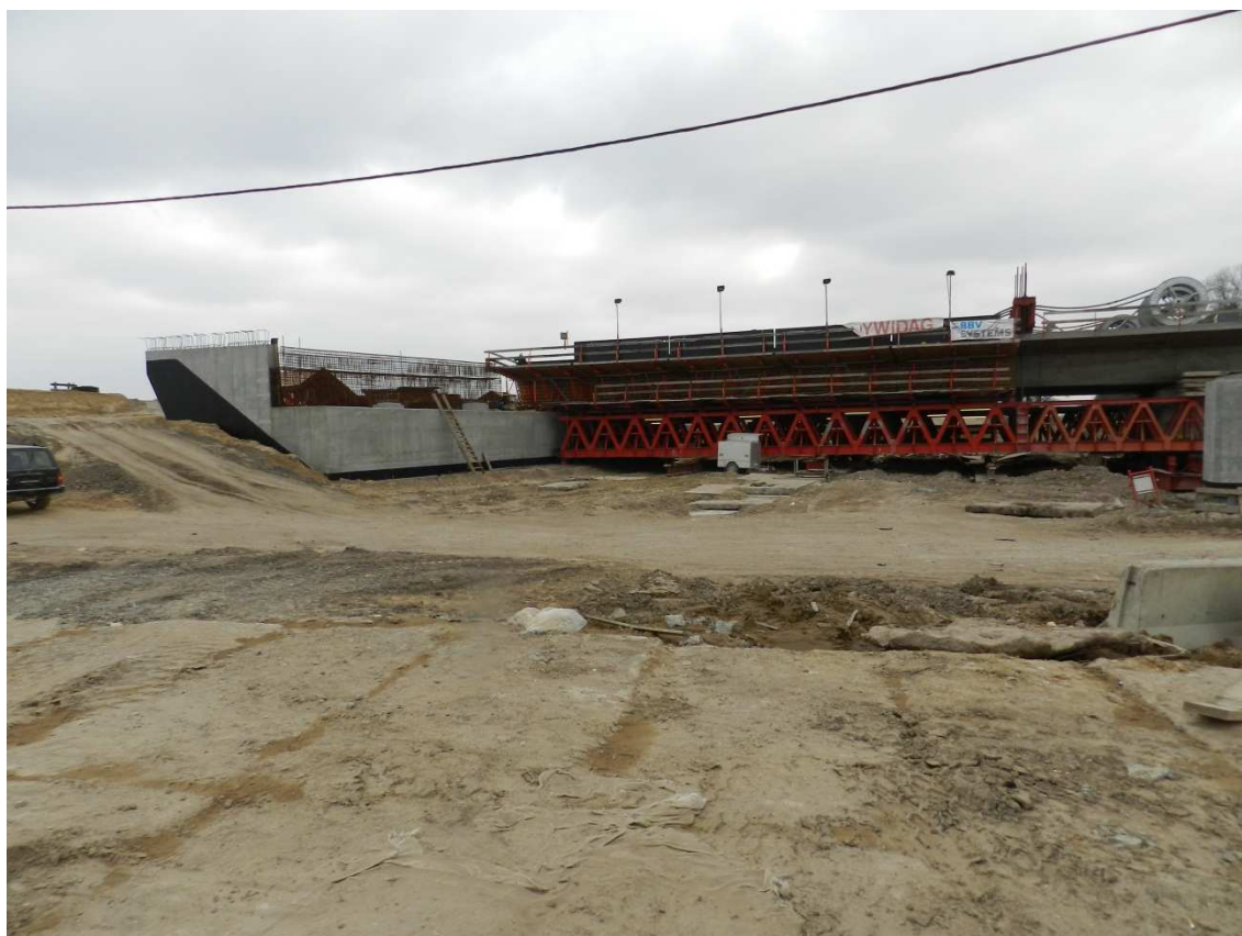
Fot. 20 Wózek do wykonywania ustroju nośnego na ostatnim taccie E-221 21.03.2012
