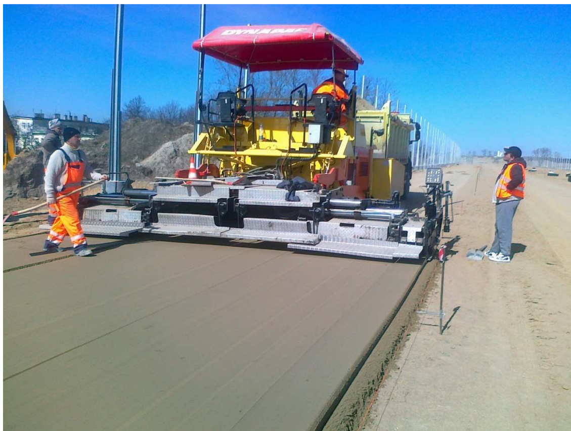
Fot. 8 Wykonywanie stabilizacji 266+400 26.03.2012
