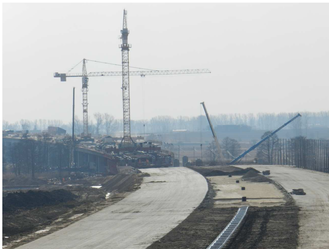
Fot. 11 Prace na estakadzie E-221 od strony przyczółka pn 07.03.2012
