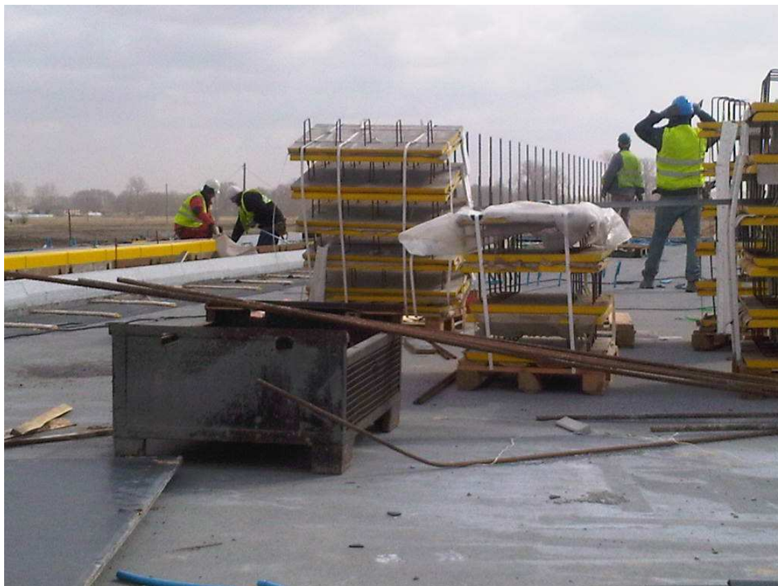
Fot. 15 Montaż desek gzymsowych na moście przez rzekę Malinkę, MA-228 29.03.2012
