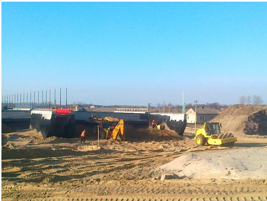
Fot. 7 Zasyпка przyczółków PG225 23.03.2012
