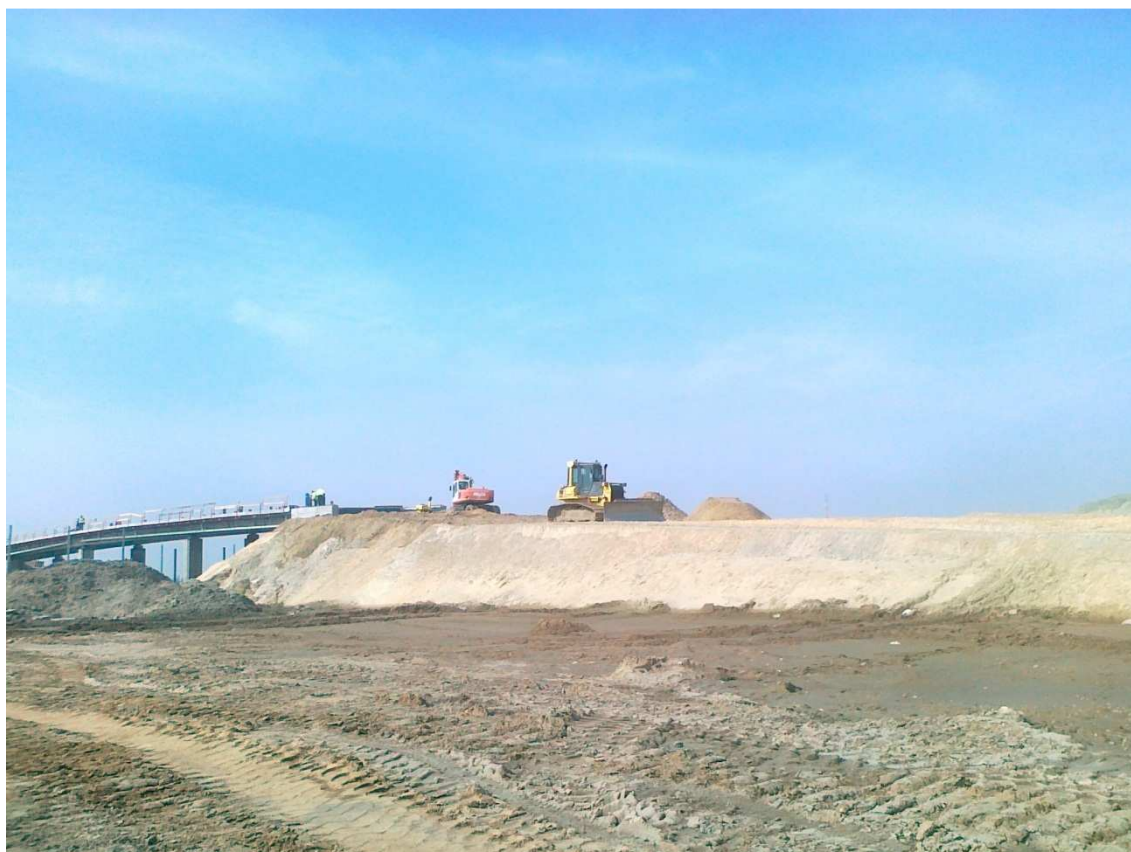
Fot. 4 Budowa nasypu przy obiekcie WD227 27.03.2012
