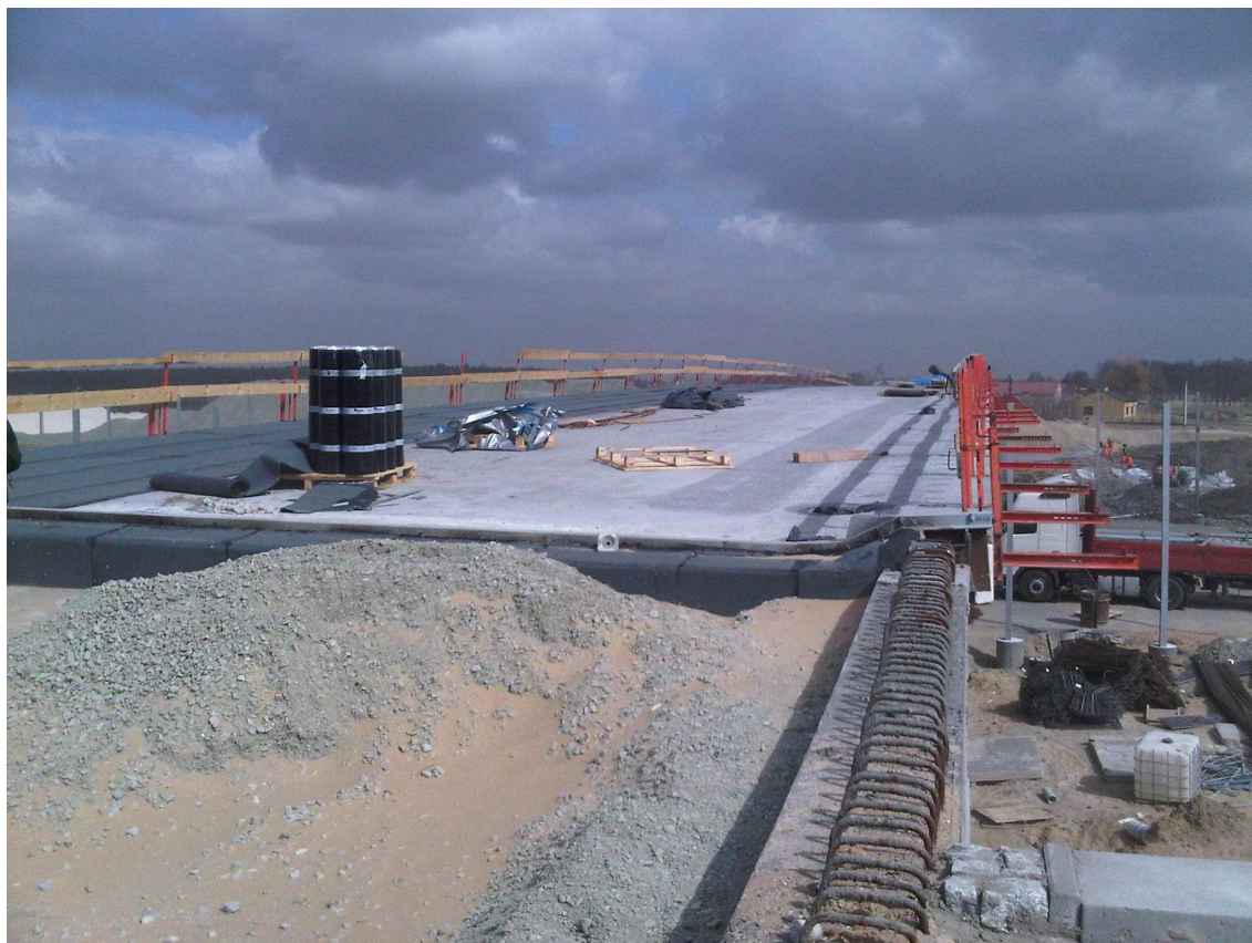
Fot. 19 Układanie hydrizolacji na ustroju nośnym wiaduktu WD-227 29.03.2012
