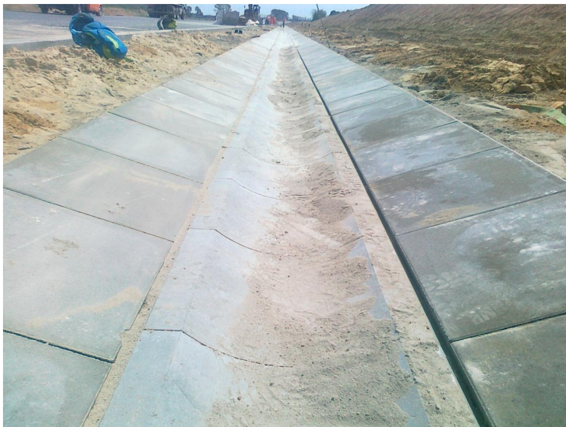
Fot. 5 Ściek korytkowy 265+600 11.05.2012
