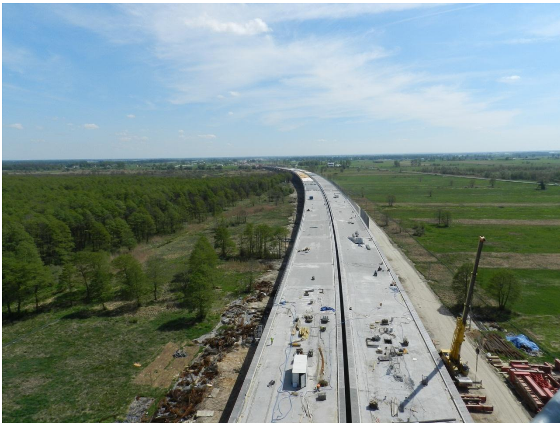
Fot. 2 Widok na estakadę E-221 09.05.2012
