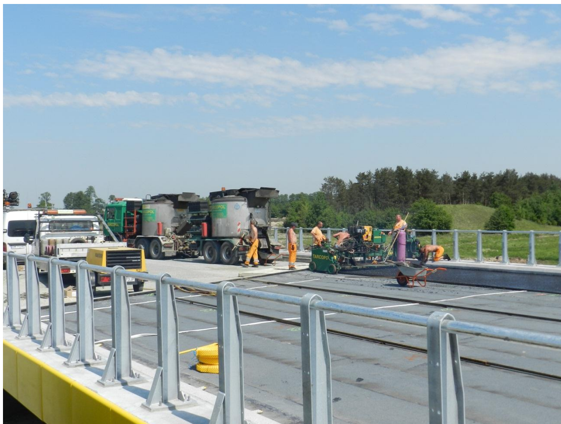
Fot. 11 Układanie asfaltu twardolanego na moście MA-228 22.05.2012
