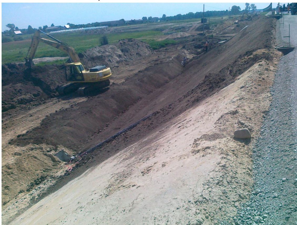
Fot. 12 Humusowanie skarp 268+800 22.05.2012
