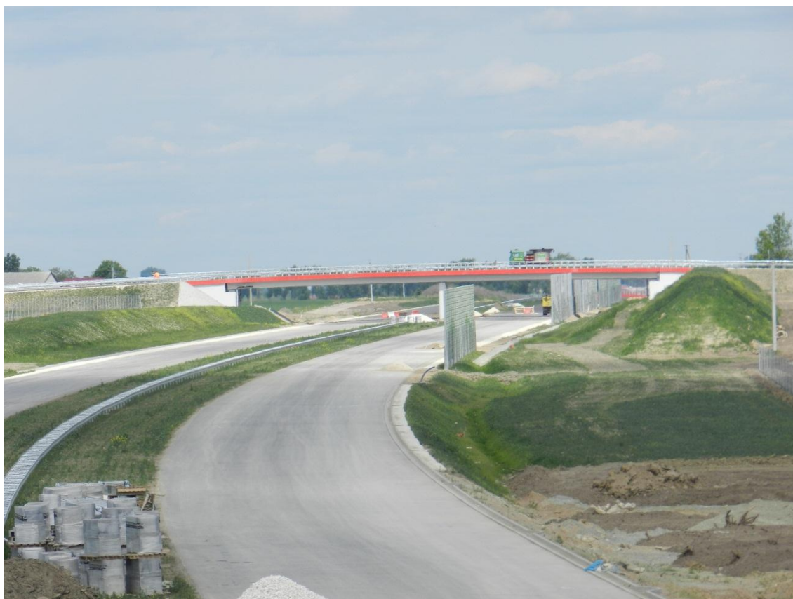
Fot. 19 Wiadukt WD-219 30.05.2012
