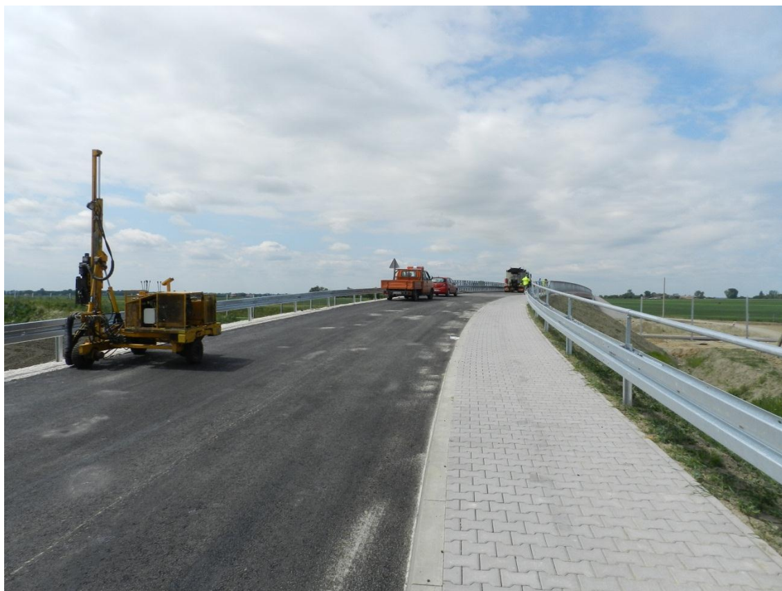
Fot. 17 Zabijanie barier drogowych na dojeździe do wiaduktu WD-219 30.05.2012
