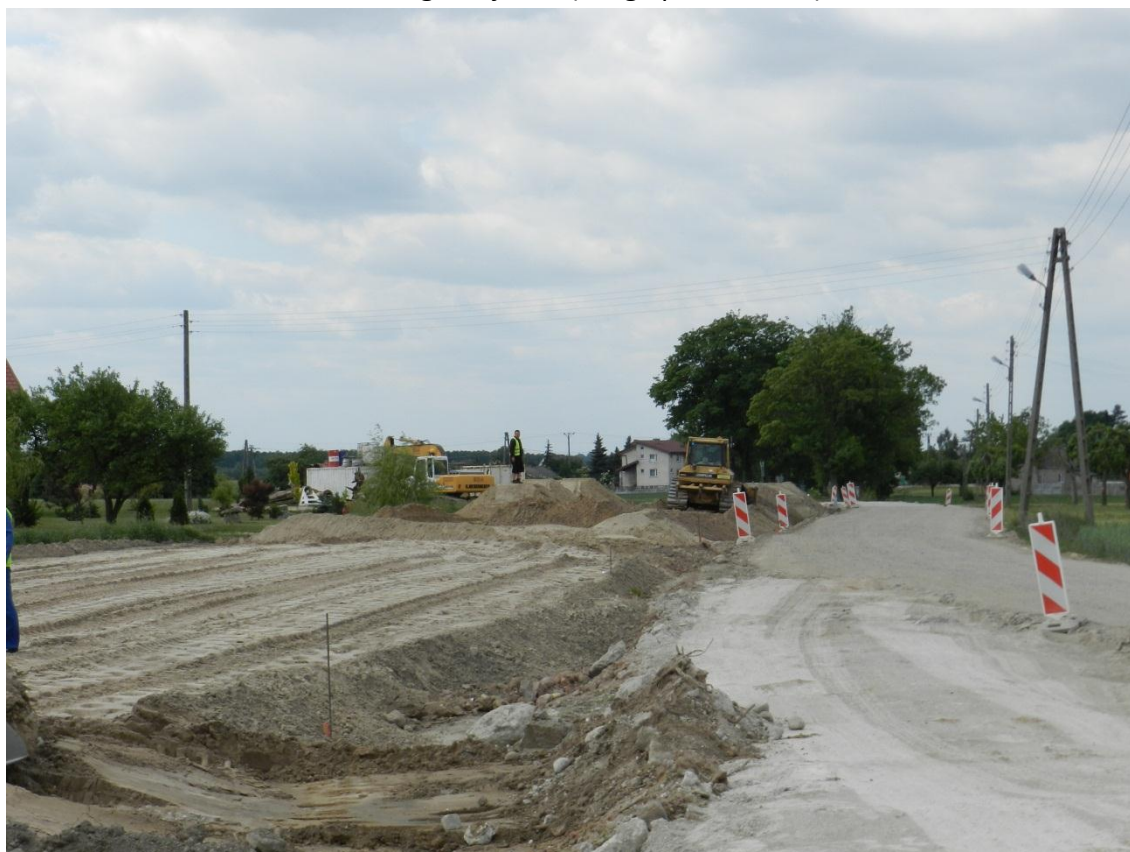
Fot. 20 Przebudowa zachodniego dojazdu (droga pow. 2112E) do wiaduku WD-220 31.05
