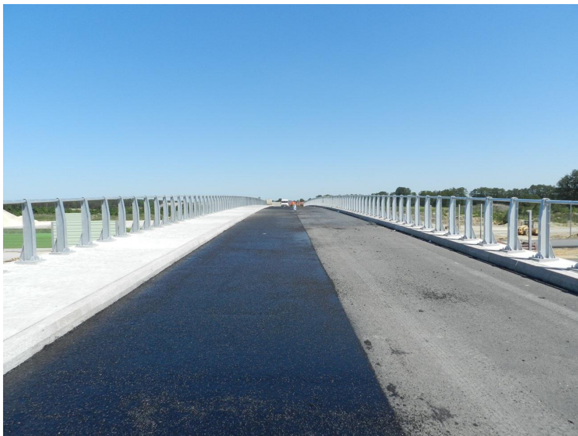
Fot. 13 Układanie asfaltu twardolanego na wiadukcie WD-227 24.05.2012
