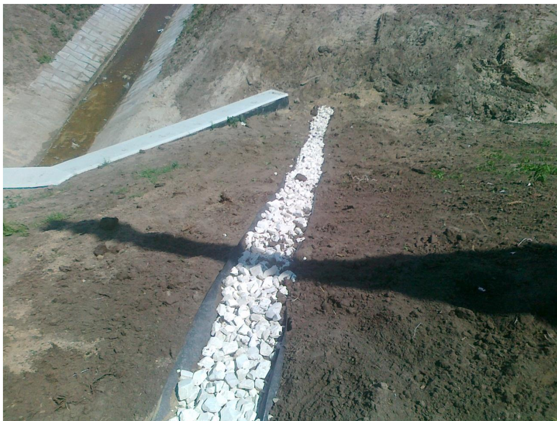
Fot. 9 Drenaż na skarpie 21.05.2012
