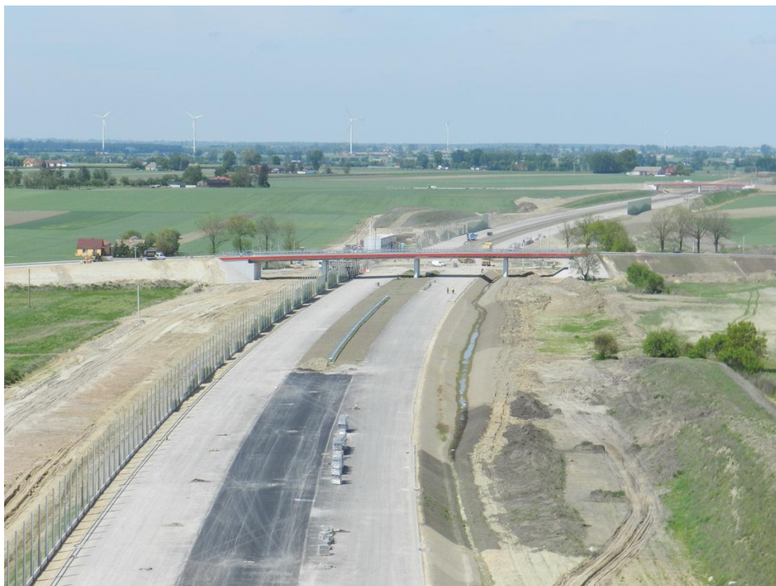
Fot. 3 Wiadukty drogowe WD-220 i WD-219 09.05.2012
