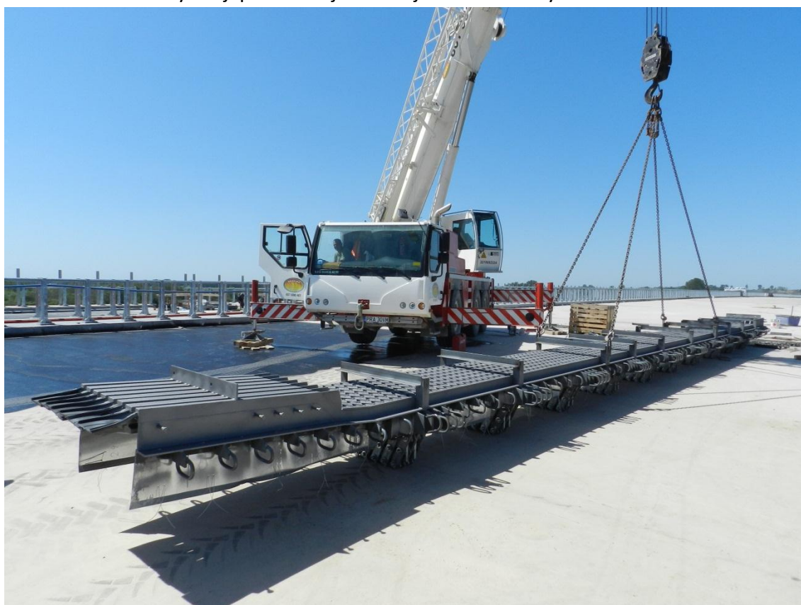
Fot. 14 Montaż dylacji pośredniej na lewej nitce estakady E-221 24.05.2012
