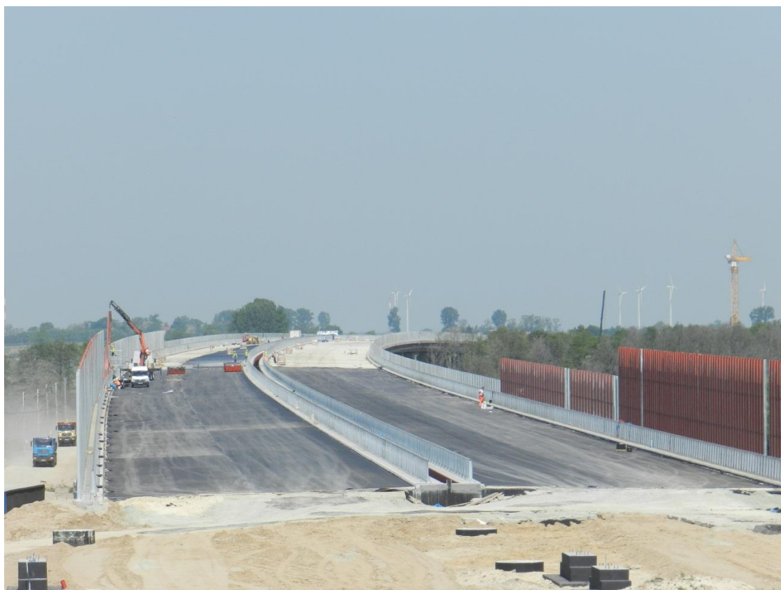
Fot. 10 Montaż ekranów na estakadzie E-221 22.05.2012
