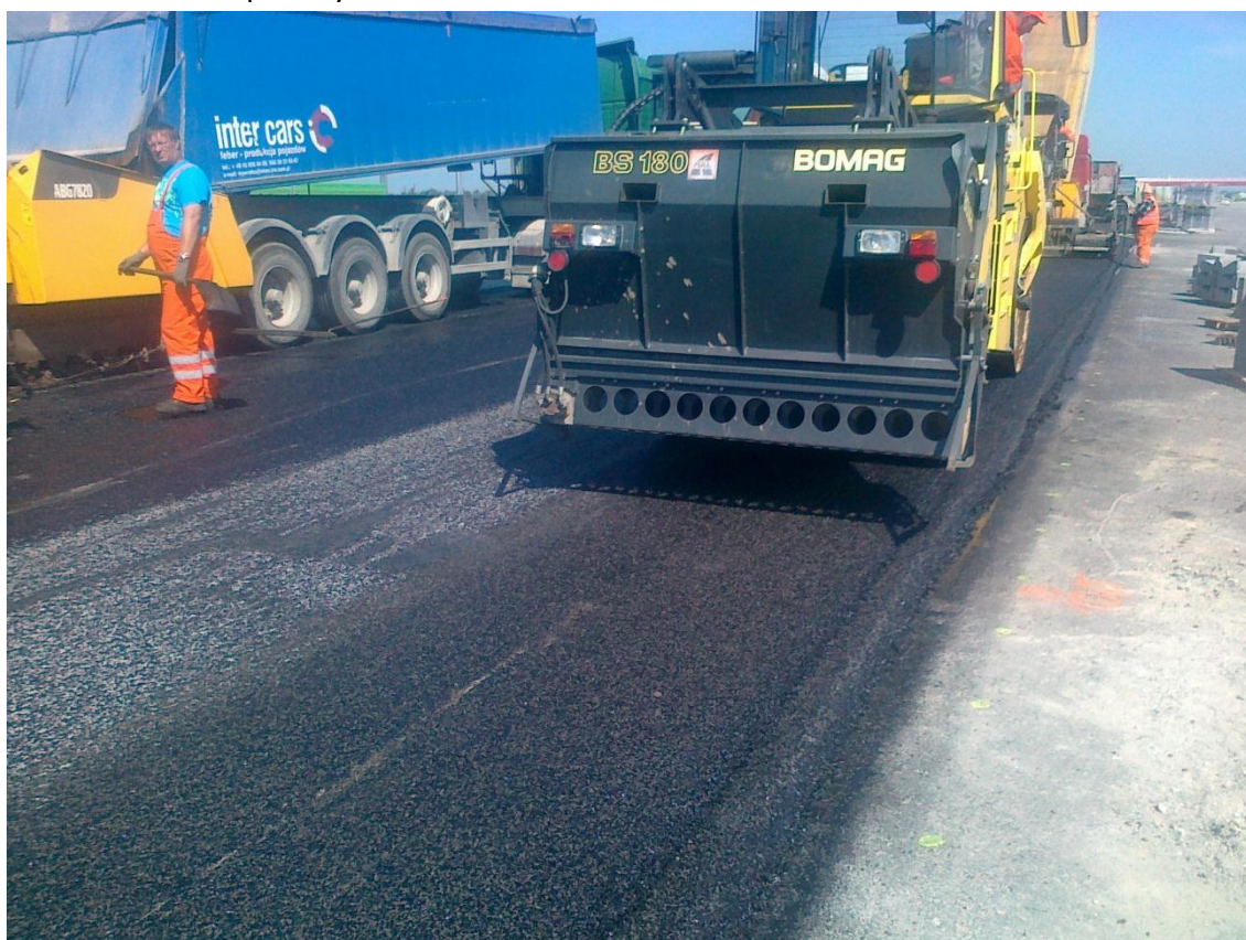
Fot. 8 Odcinek próbny SMA 263+000 19.05.2012
