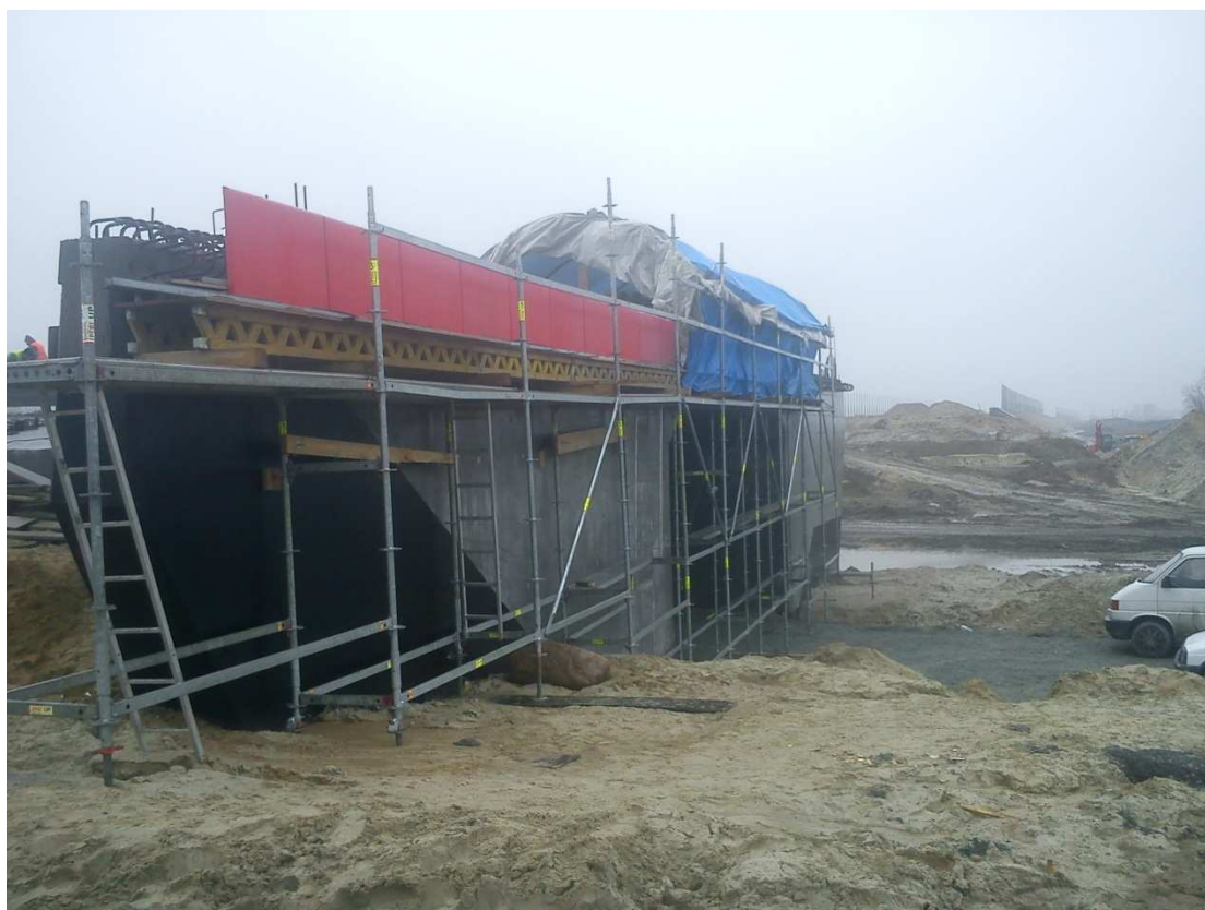
Fot. 20 Montaż desek gzymsowych, układanie krawężników i zbrojenie kap chodnikowych na obiekcie PG-225 29.02.2012
