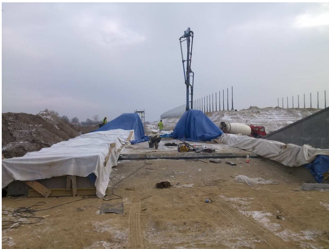
Fot. 12 Betonowanie kap chodnikowych na moście MD-226A 14.02.2012
