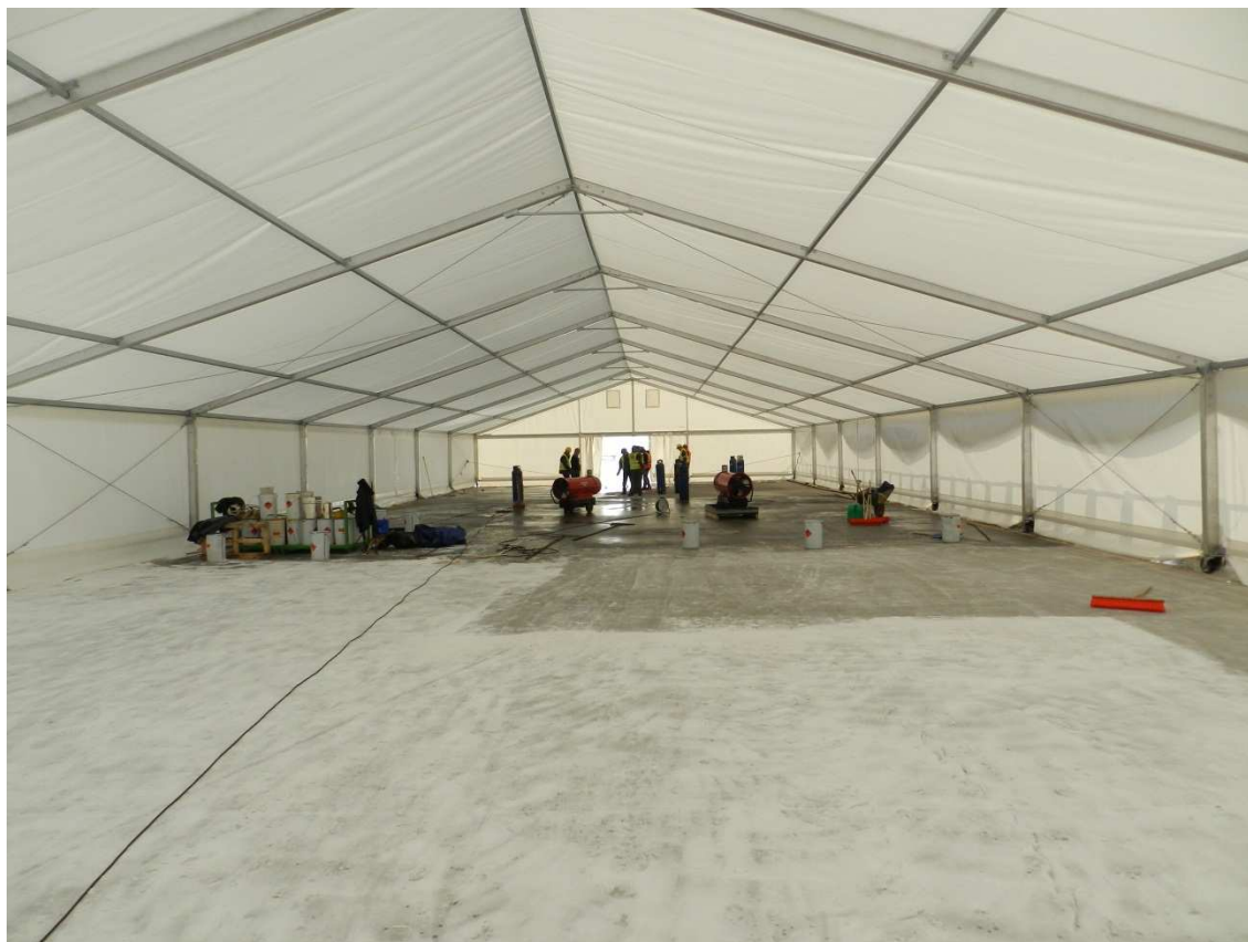
Fot. 7 Przygotowywanie podłoża do układania hydroizolacji na E-221 16.02.2012
