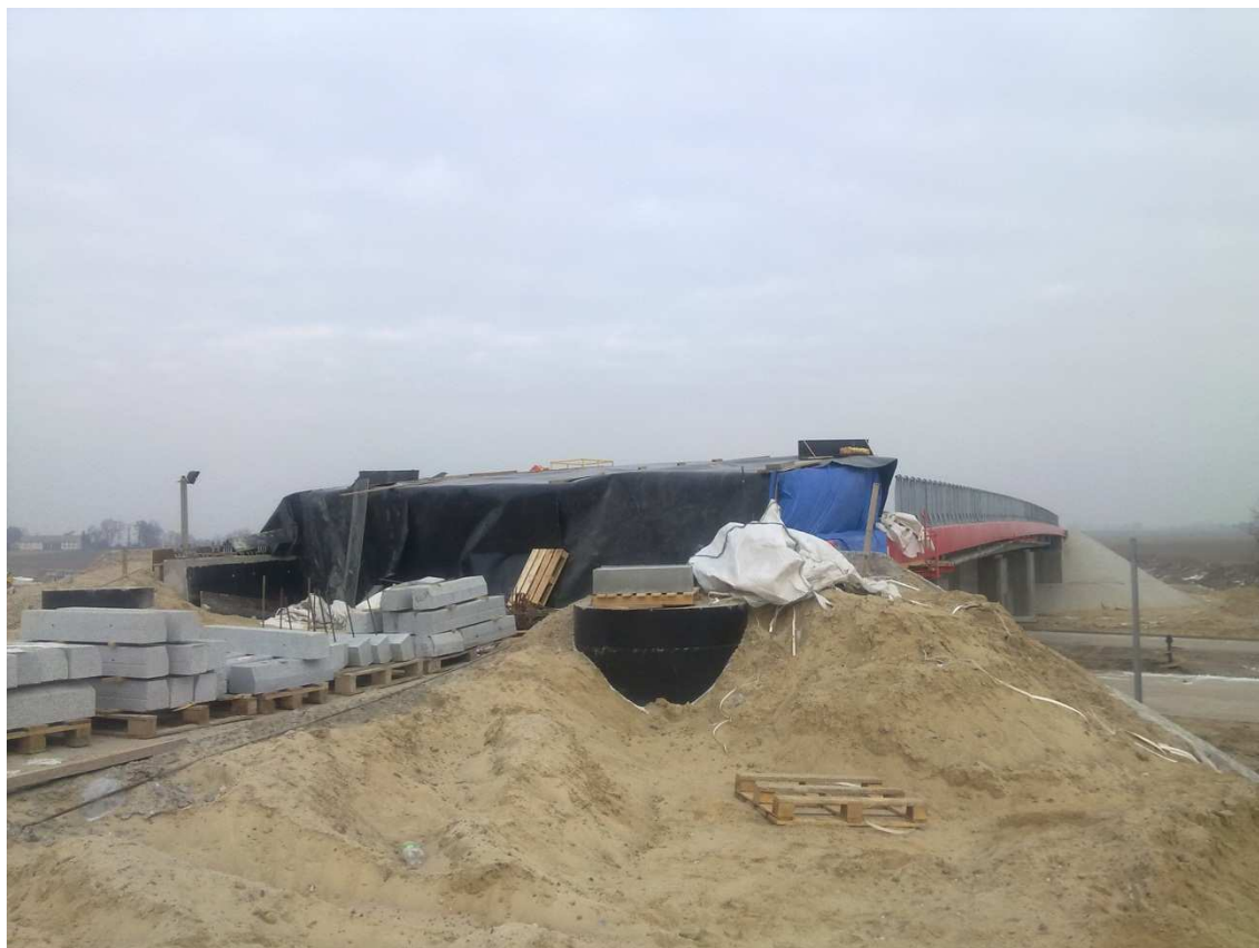
Fot. 11 Prowadzenie robót pod ogrzewanym namiotem na obiekcie WD-220 14.02.2012
