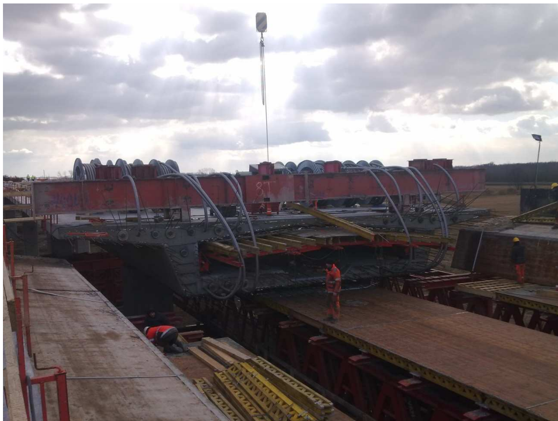
Fot. 17 Przesuw rusztowania pod ustrój nośny na estakadzie E-221 27.02.2012
