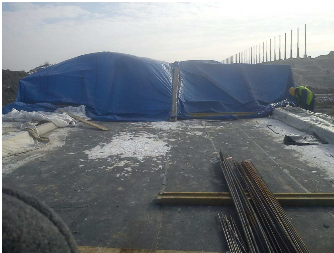
Fot. 1 Kapy chodnikowych pod ogrzewanym namiotem na obiekcie MD-226A 08.02.2012
