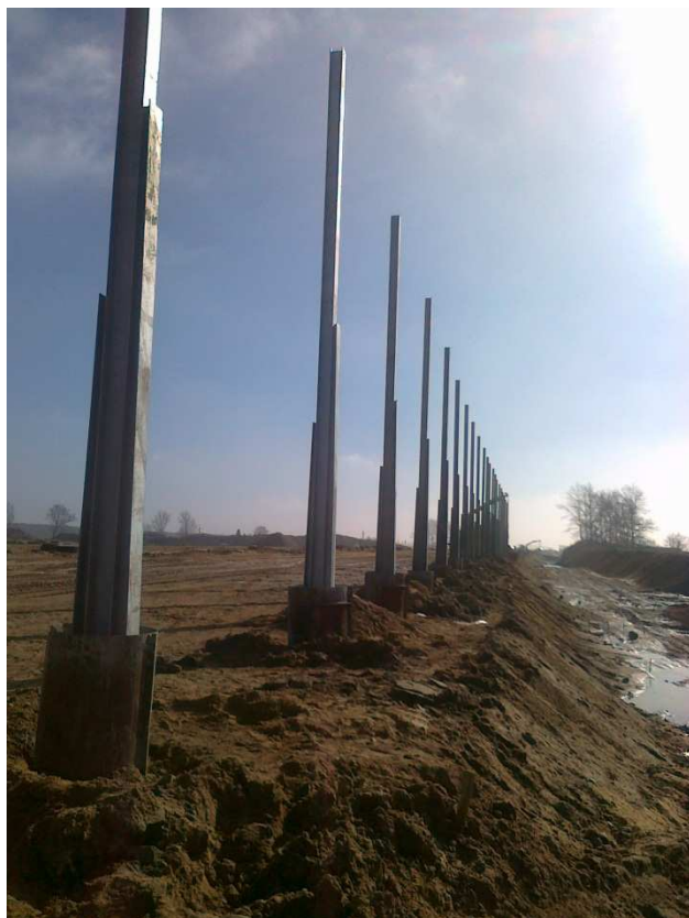
Fot. 19 Słupy pod ekrany akustyczne 29.02.2012
