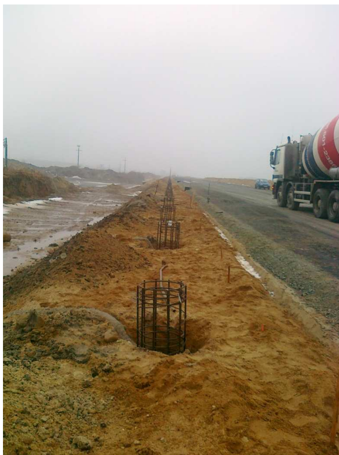
Fot. 13 Pale pod ekrany akustyczne 22.02.2012
