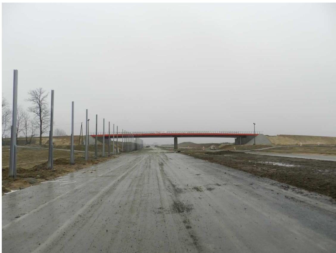
Fot. 18 Widok na wiadukt drogowy WD-219 29.02.2012
