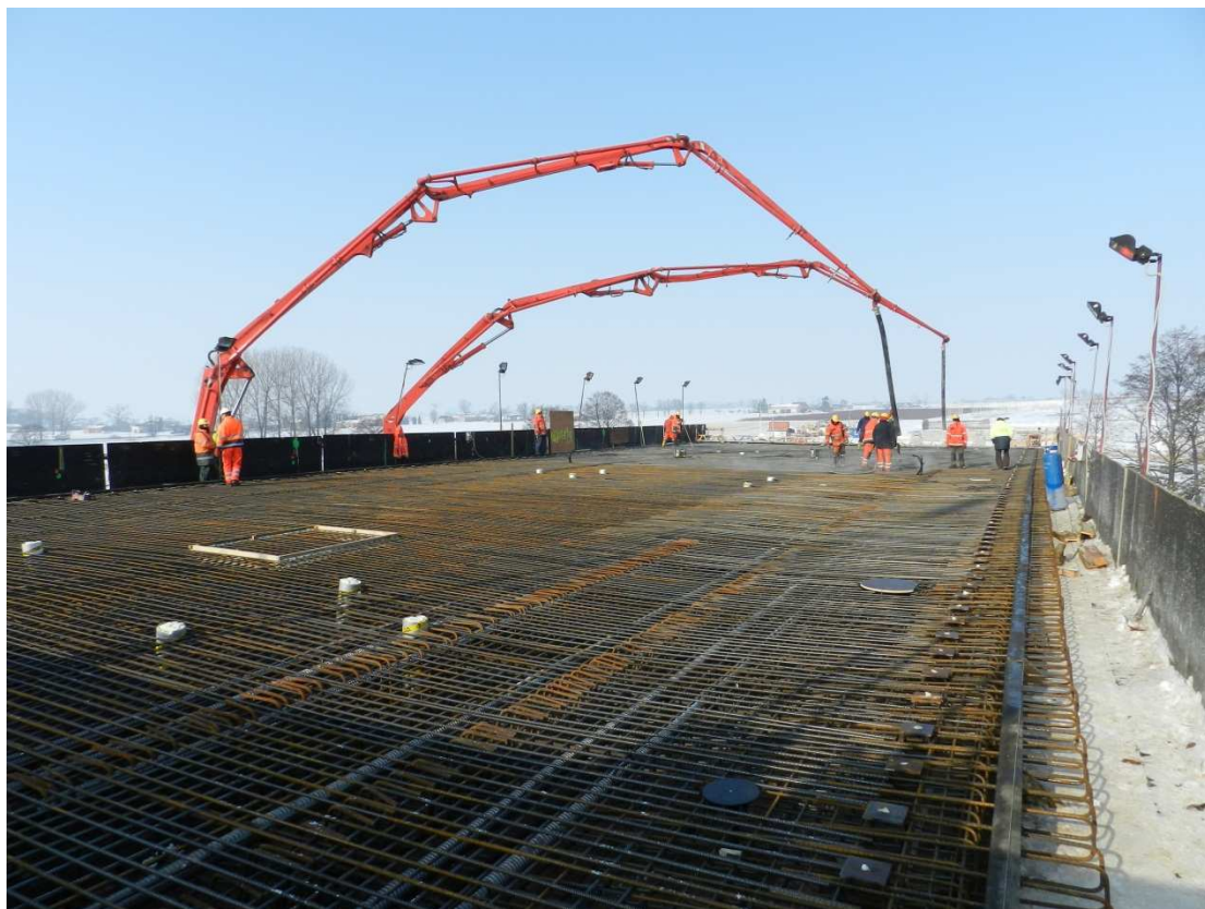
Fot. 5 Betonowanie płyty górnej (etap 2) na estakadzie E-221, nitka lewa 16.02.2012
