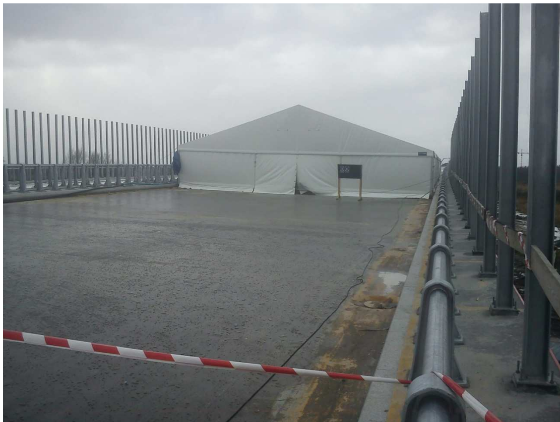
Fot. 8 Układanie izolacji pod ogrzewanym namiotem na E-221 20.02.2012
