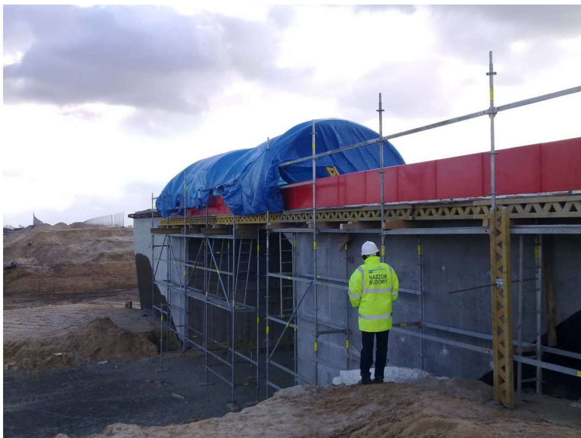
Fot. 16 Wykonywanie kap chodnikowych pod namiotem na PG-226A 27.02.2012
