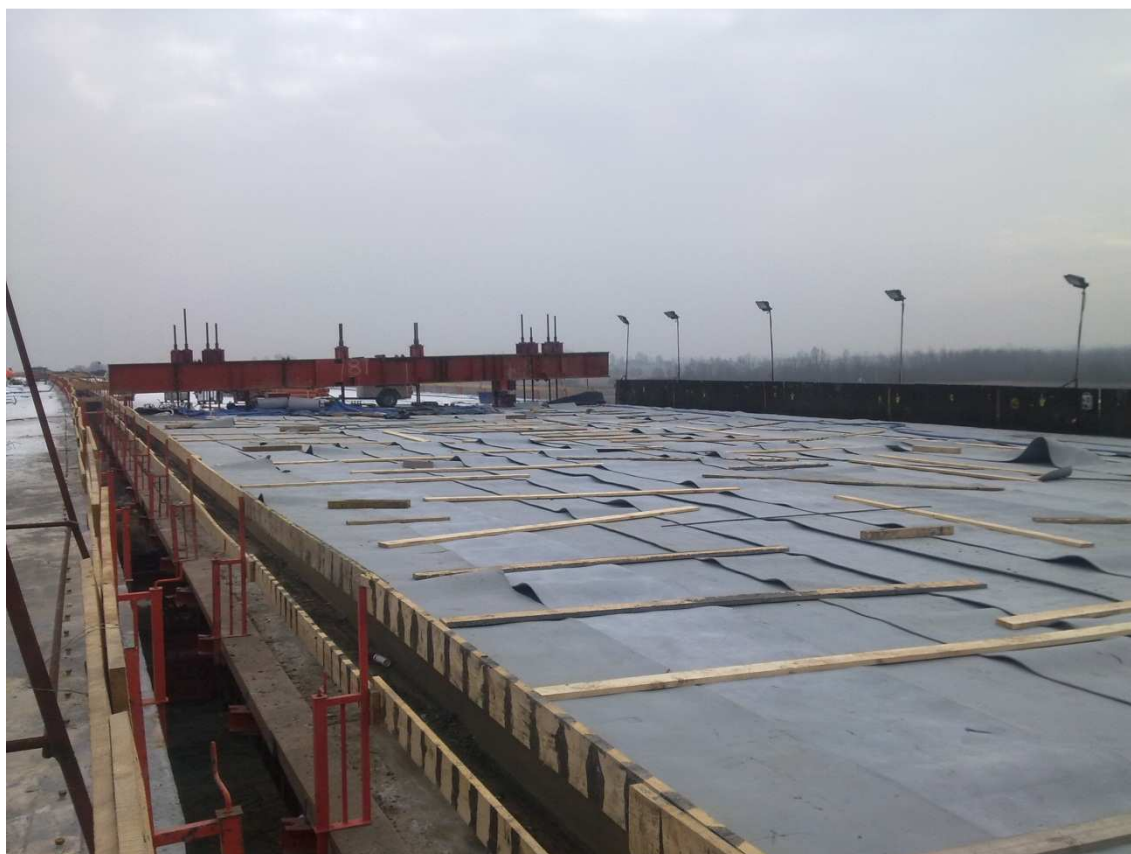
Fot. 4 Zabezpieczenie płyty górnej po betonowaniu matami grzewczymi, E-221 14.02.2012
