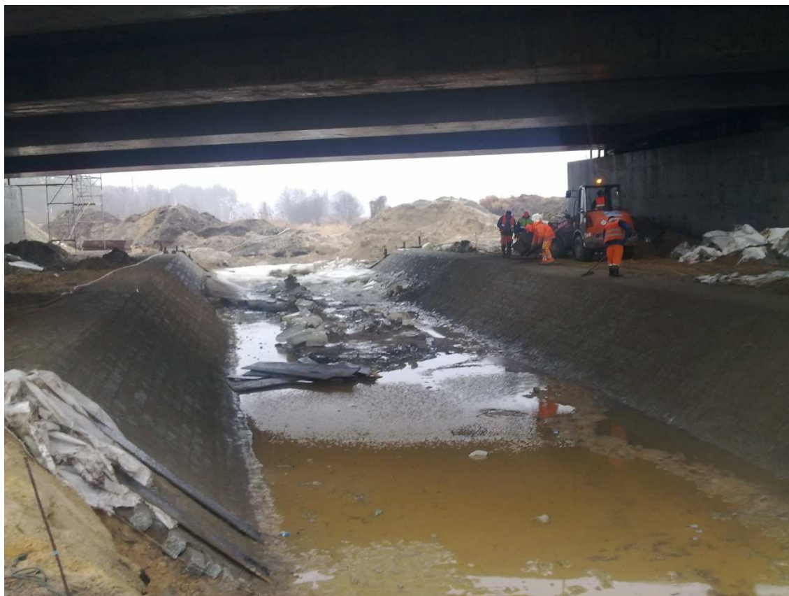
Fot. 9 Umacnianie koryta rzeki Malinka pod obiektem MA-228 22.02.2012
