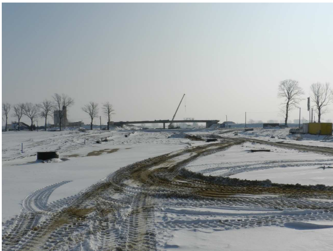
Fot. 10 Widok na WD-224 16.02.2012
