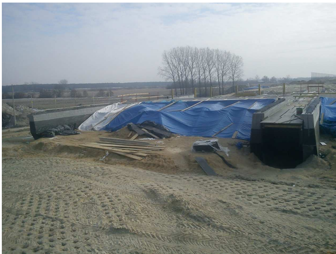
Fot. 2 Płyty przejściowe pod nagrzanym namiotem na obiekcie PG-225 08.02.2012
