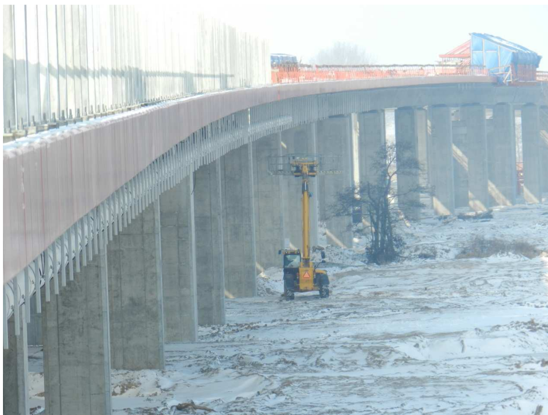
Fot. 6 Montaż kolektora odwadniającego i wykonywanie kap chodnikowych pod namiotem na estakadzie E-221 16.02.2012
