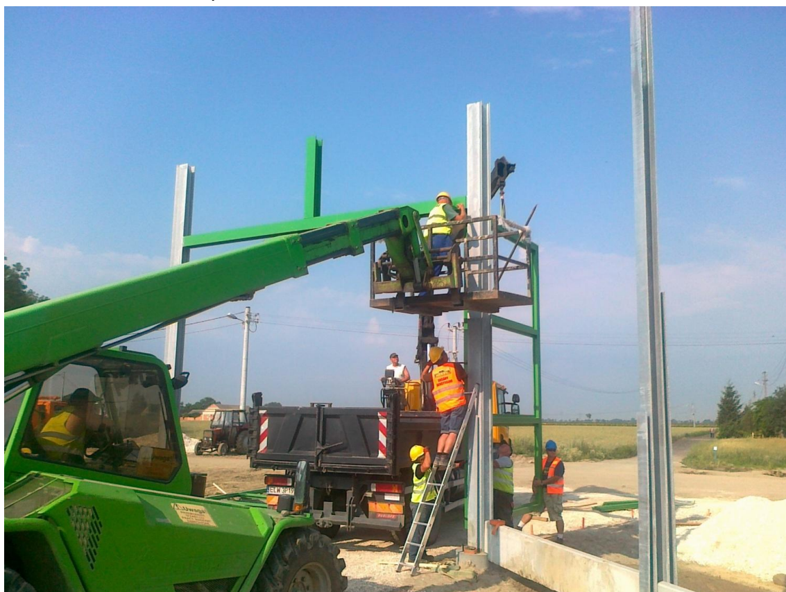
Fot. 10 Montaż bramy 06.07.2012
