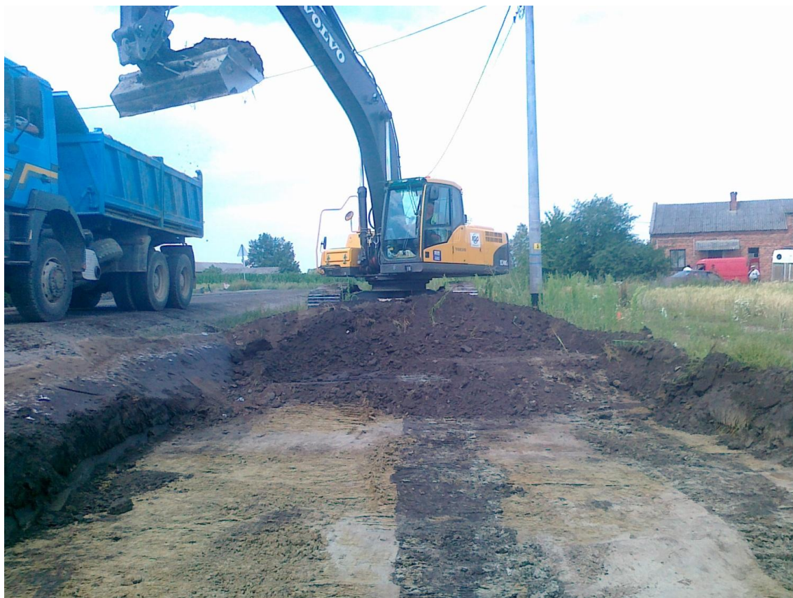
Fot. 13 Roboty ziemne na najeździe do WD-227 07.07.2012
