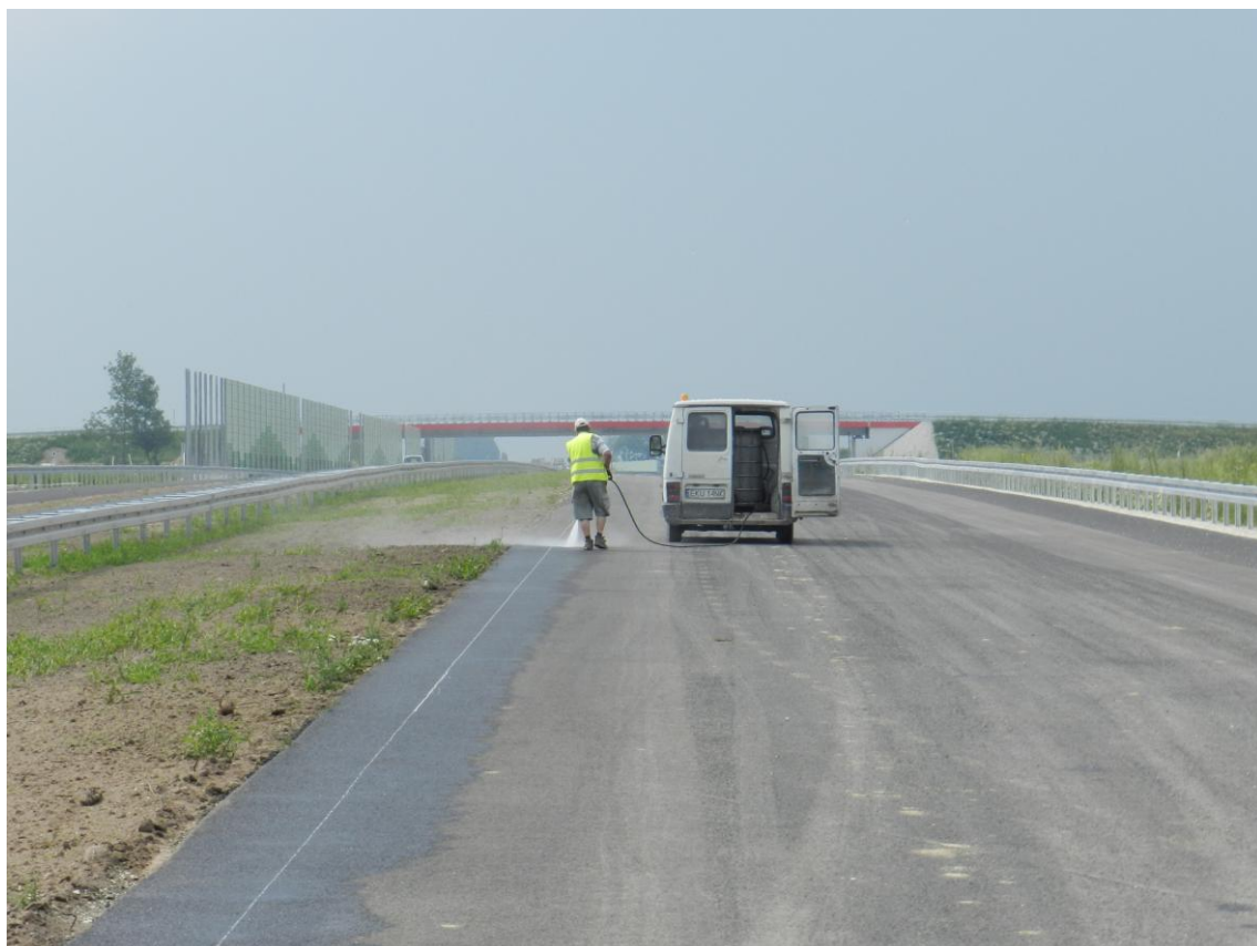
Fot. 11 Trasowanie i oczyszczanie powierzchni pod oznakowanie poziome 06.07.2012
