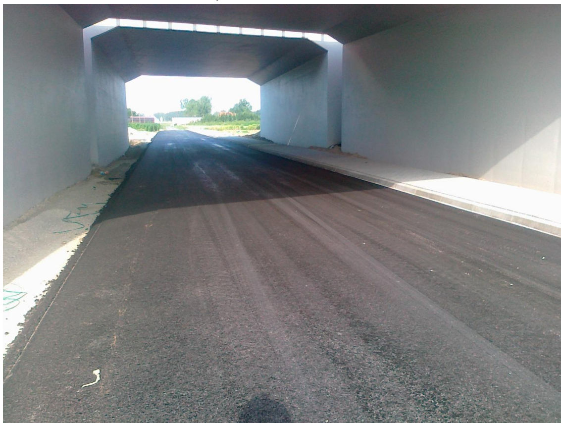
Fot. 14 Warstwa ściernalna z BA pod PG-226A 09.07.2012
