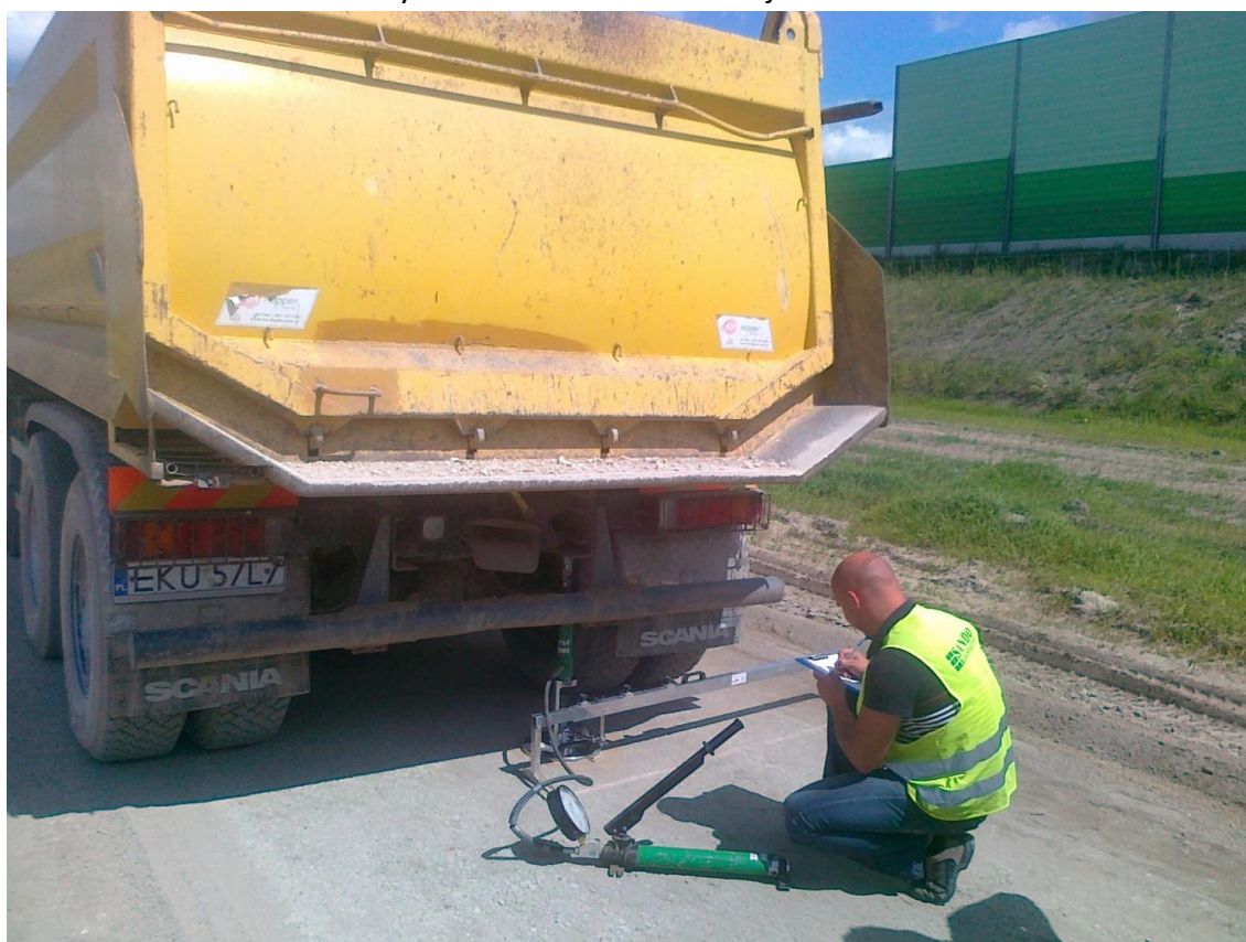
Fot. 18 Badanie VSS kruszywa na drodze serwisowej 14.07.2012
