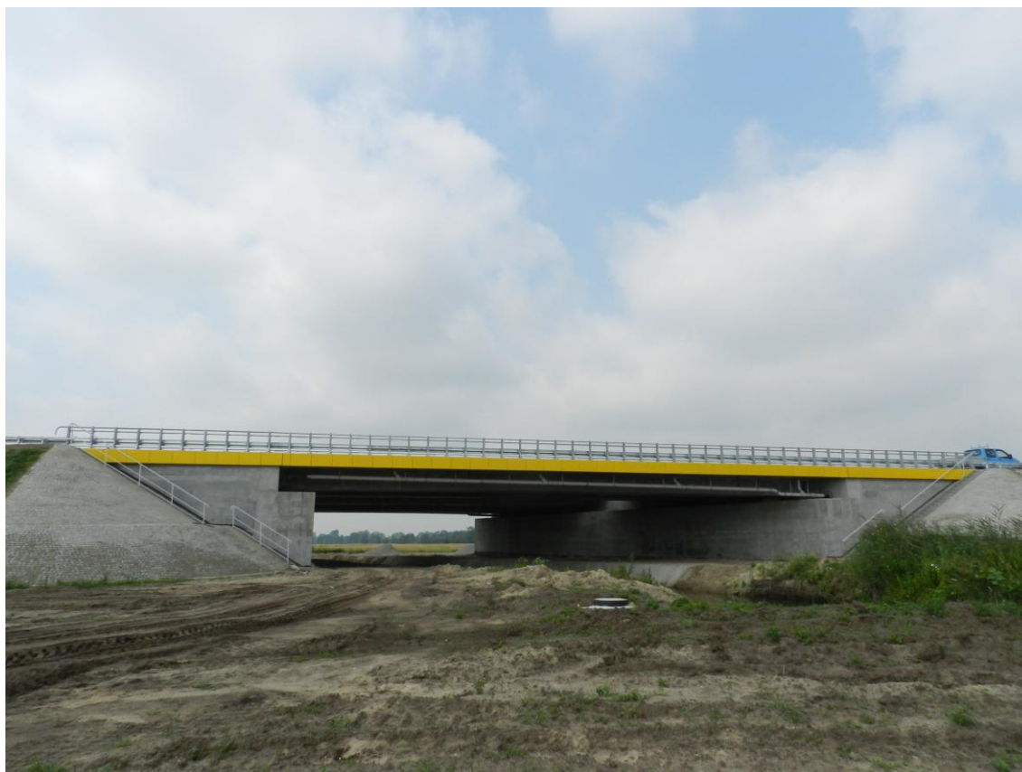
Fot. 7 Widok na most autostradowy MA-228 03.07.2012
