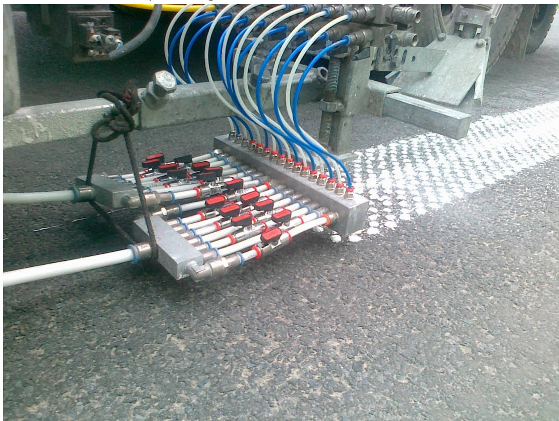
Fot. 20 Oznakowanie poziome grubowarstwowe 18.07.2012
