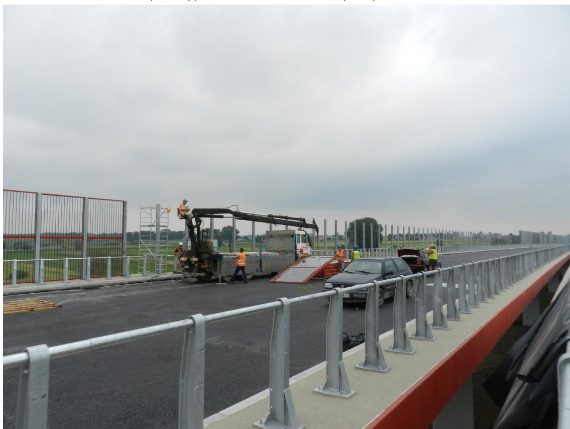
Fot. 4 Montaż szklanych wypełnień ekranów akustycznych na estakadzie E-221 03.07.2012
