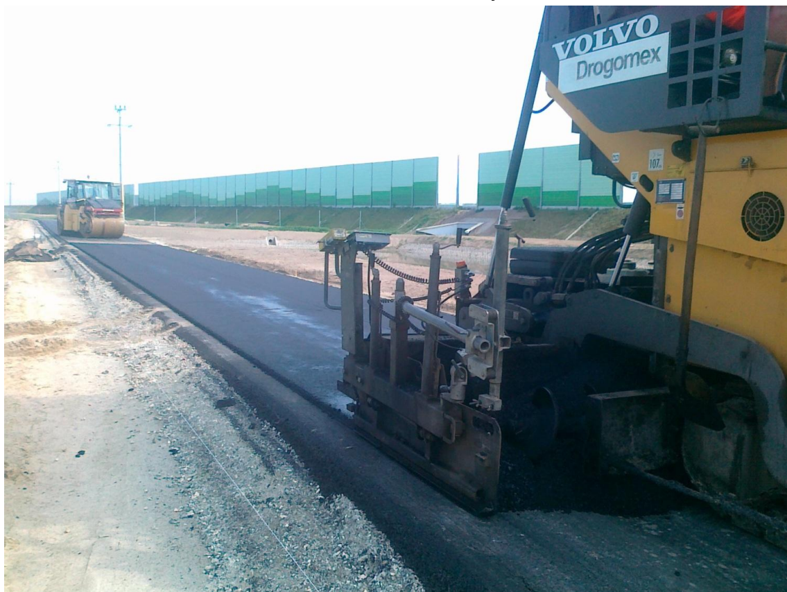
Fot. 12 Warstwa ścieralna z BA na drodze serwisowej 268+500 07.07.2012
