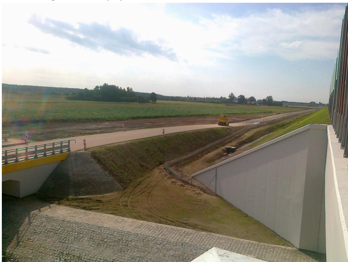
Fot. 16 Droga serwisowa przy MD-226A 09.07.2012
