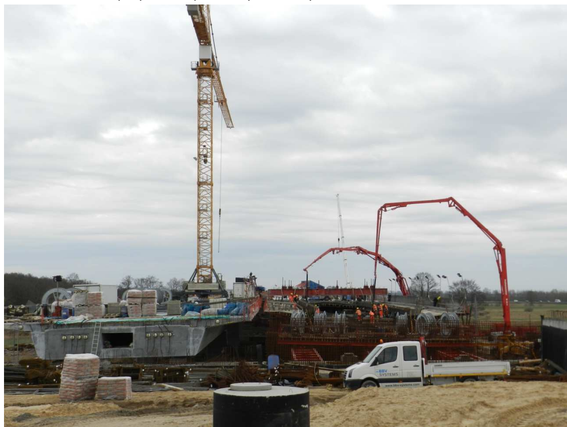
Fot. 8 Widok na przyczółek północny estakady E-221
