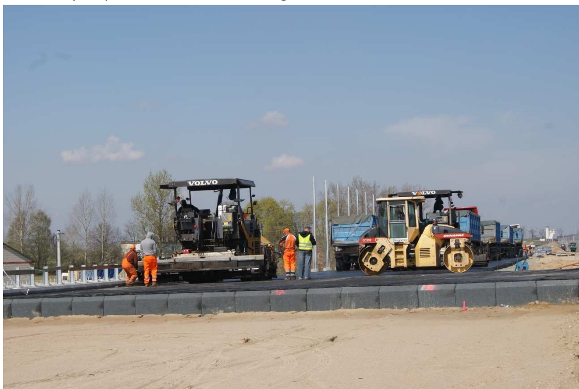
Fot. 18 Wykonywanie asfaltu twardolanego na PG-225 24.04.2012
