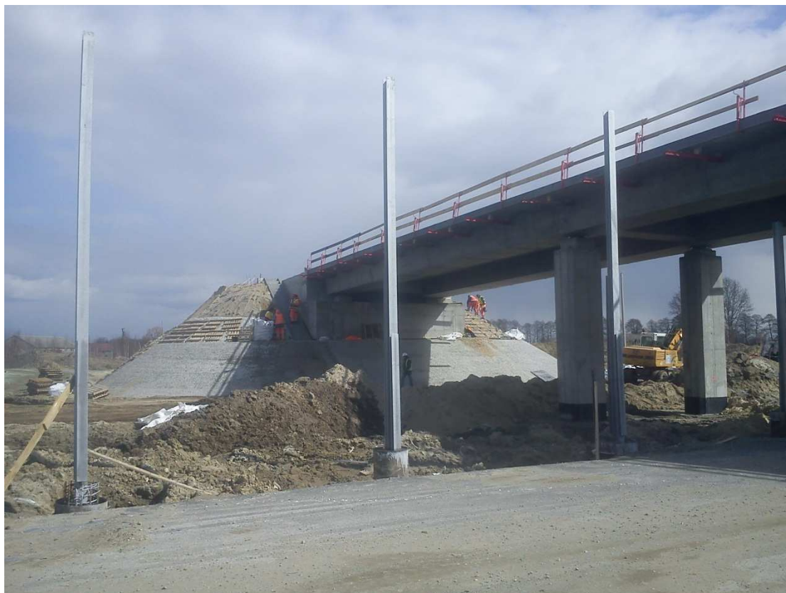
Fot. 2 Wykonywanie obruku stożka przyczółka na wiadukcie WD-227 02.04.2012
