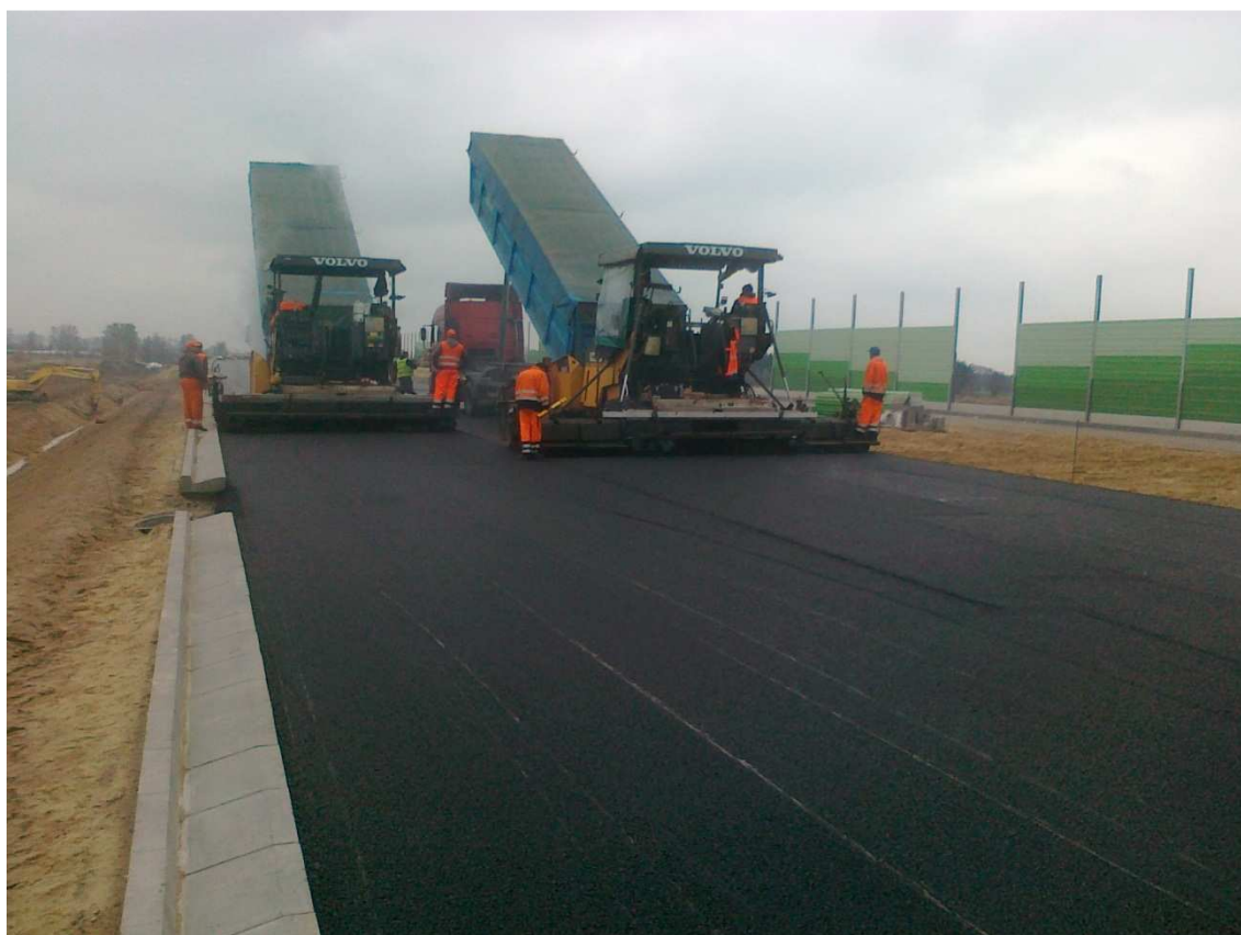
Fot. 12 Podbudowa bitumiczna 269+300 JP 19.04.2012
