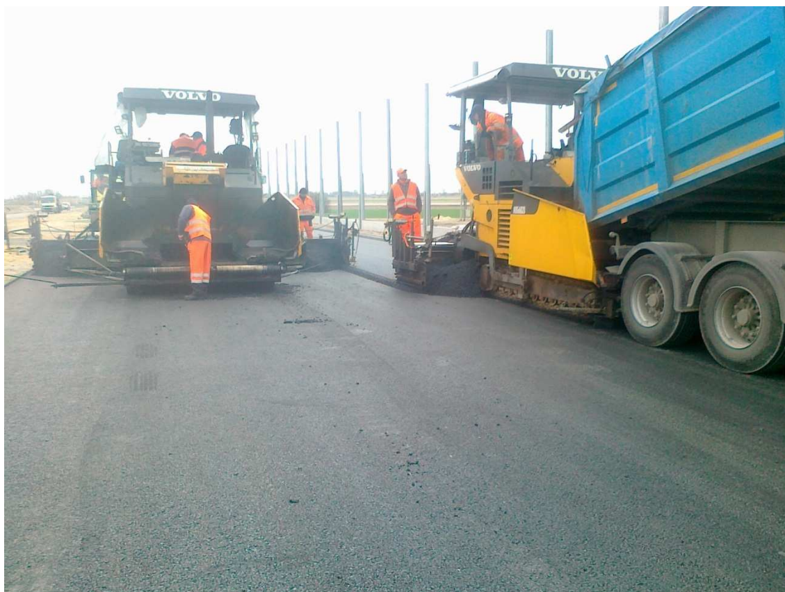
Fot. 9 Podbudowa bitumiczna 266+100 18.04.2012
