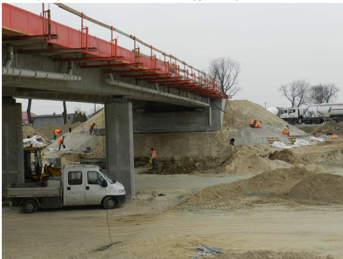
Fot. 6 Wykonywanie umocnienia stożków kostką granitową na obiekcie WD-224 12.04.12
