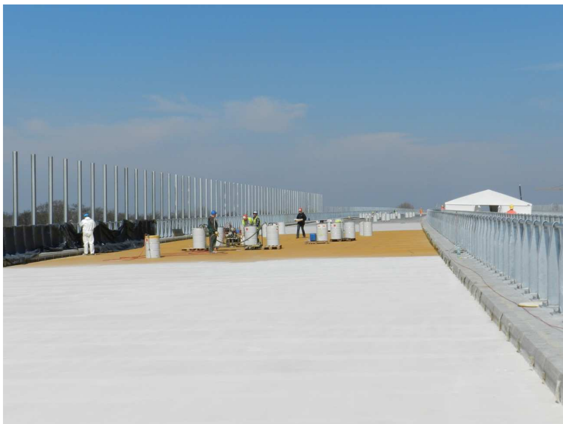
Fot. 19 Wykonywanie izolacji natryskowej ELIMINATOR na przęsłach estakady E-221 24.04
