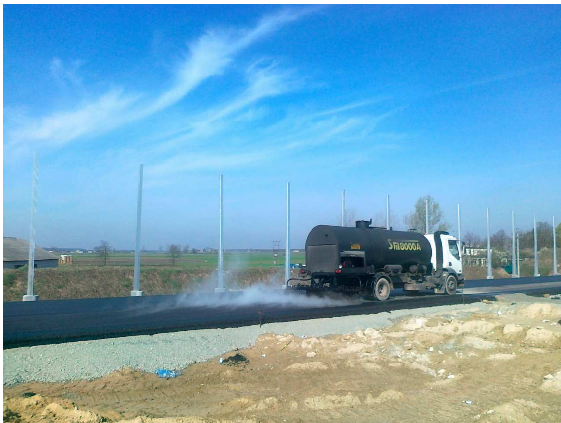
Fot. 16 Skropienie podbudowy 266+400 JP 24.04.2012
