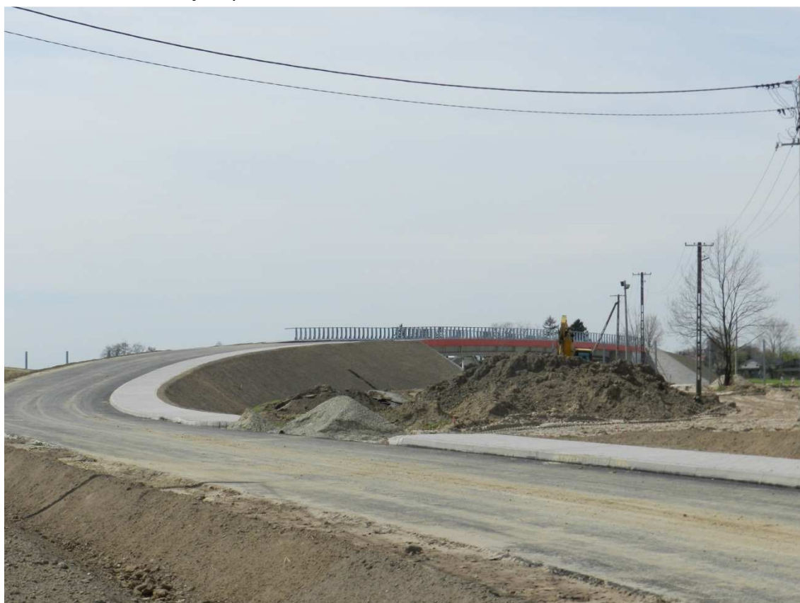
Fot. 20 Widok na najazdy do obiektu WD-219 29.04.2012
