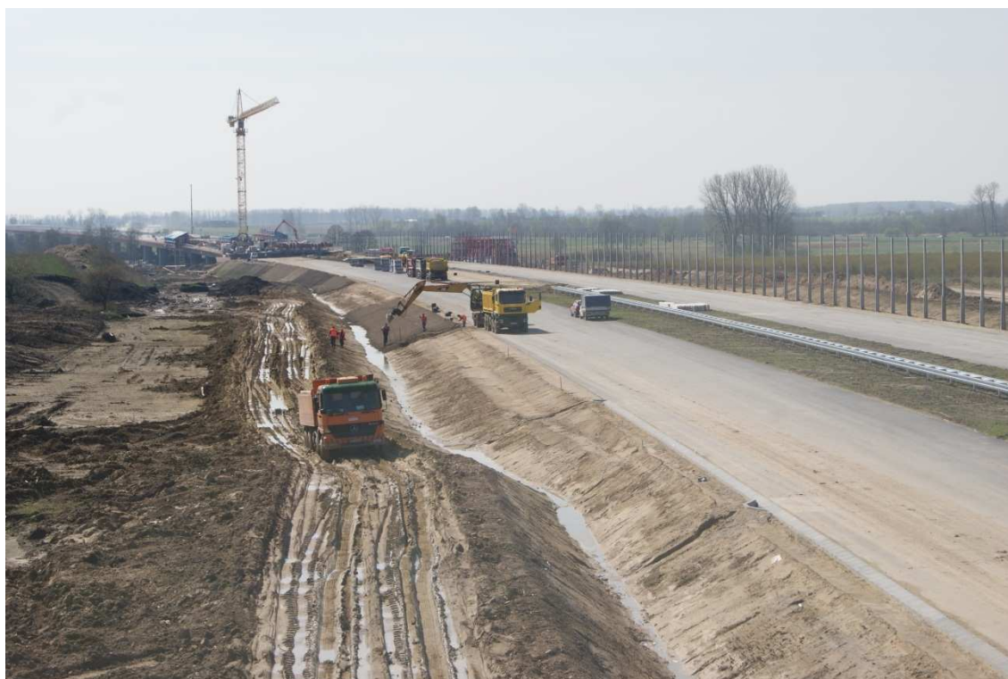
Fot. 14 Humusowanie i obsiew skarp drogowych 24.04.2012
