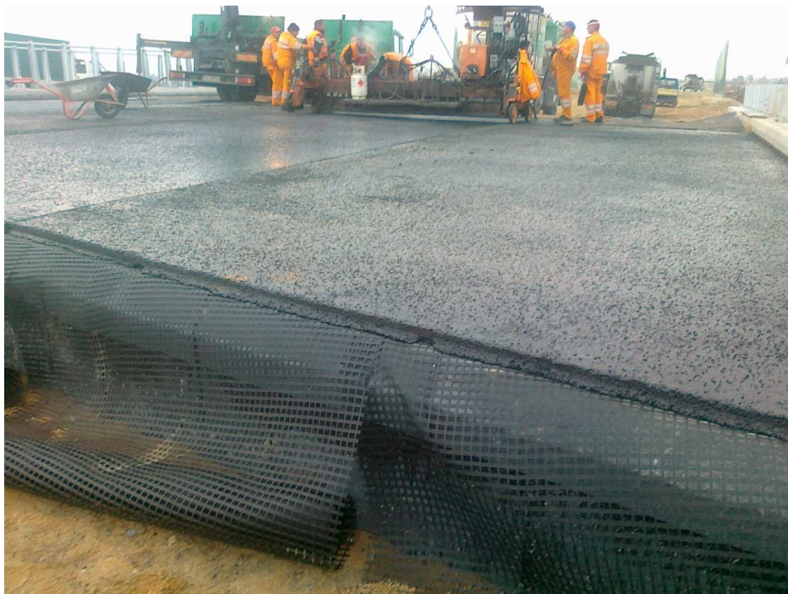
Fot. 10 Asfalt twardolany PG226A 19.04.2012
