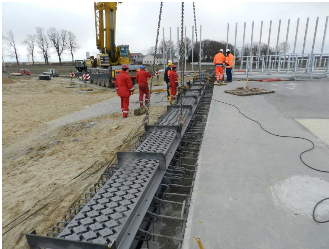
Fot. 1 Montaż dylatacji na przyczółku pd. lewej nitki E-221 02.04.2012
