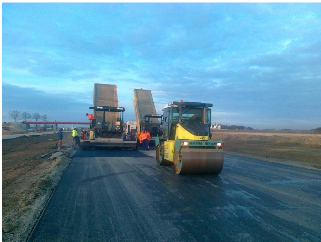
Fot. 9 Układanie warstwy bitumicznej 262+800 15.12.2011
