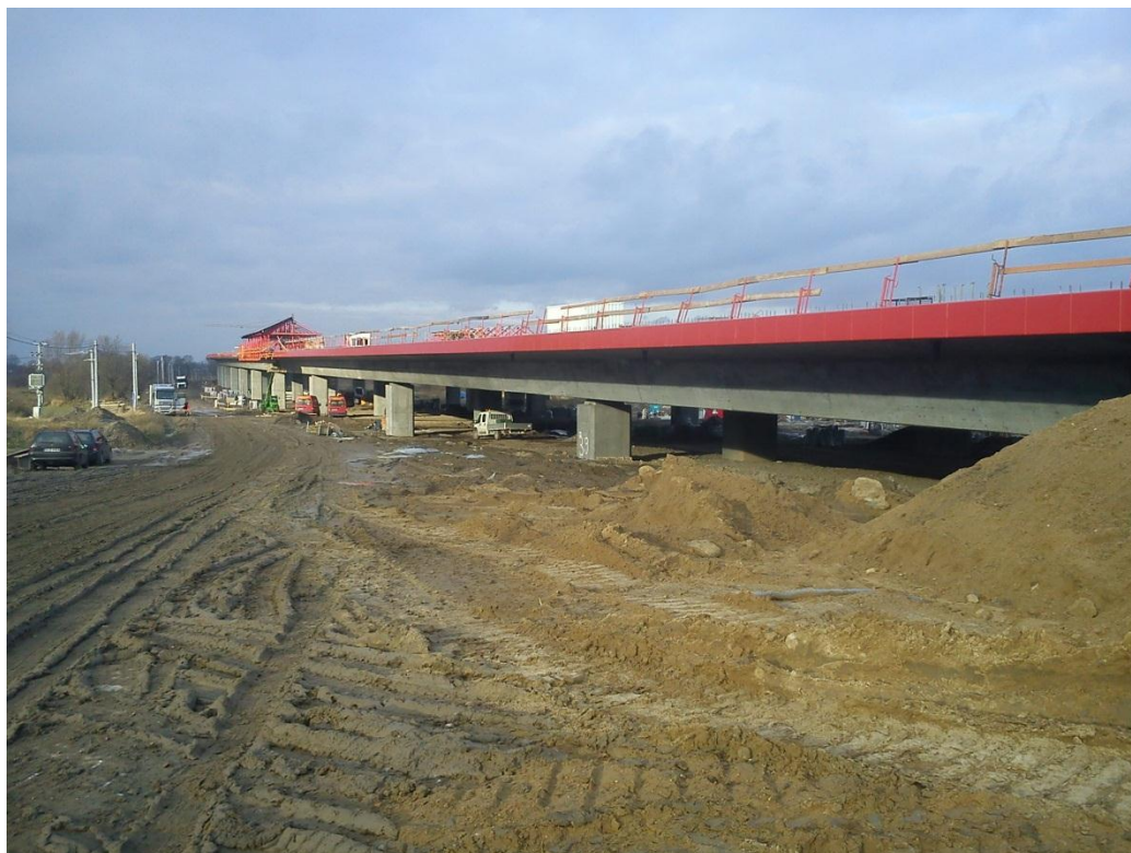
Fot. 2 Wykonywanie kap chodnikowych i montaż desek gzymsowych na E-221 06.12.2011
