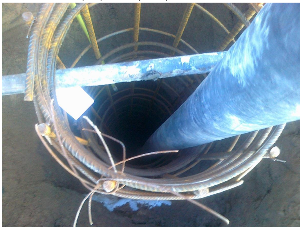
Fot. 8 Betonowanie pała pod ekrany akustyczne 12.12.2011
