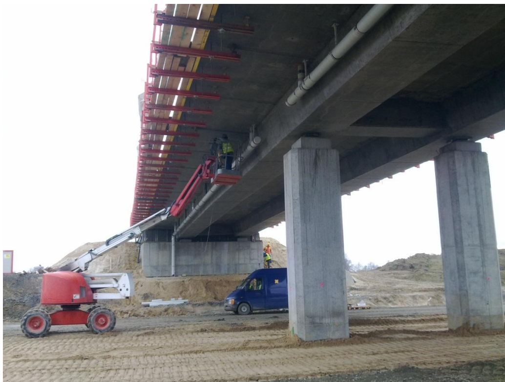
Fot. 11 Montaż kolektora odwadniającego na wiadukcie WD-219 14.12.2011
