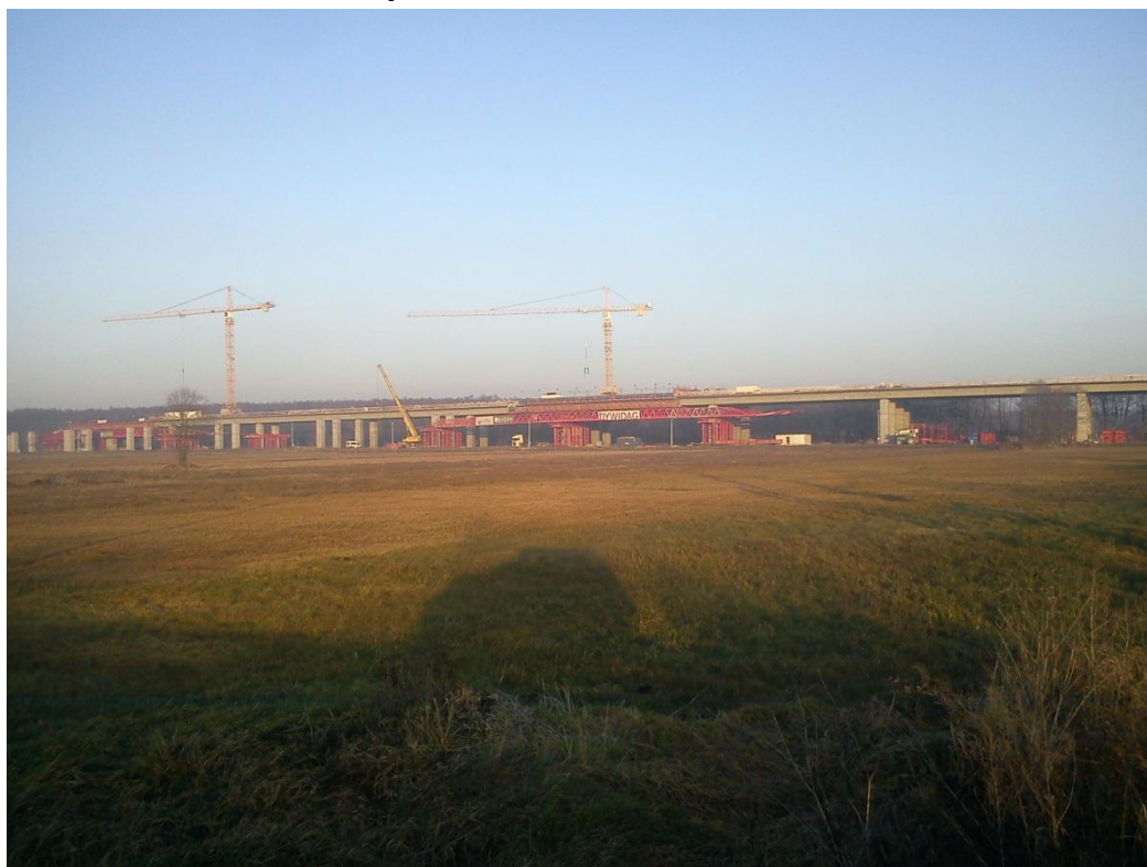
Fot. 14 Widok na estakadę E-221 20.12.2011
