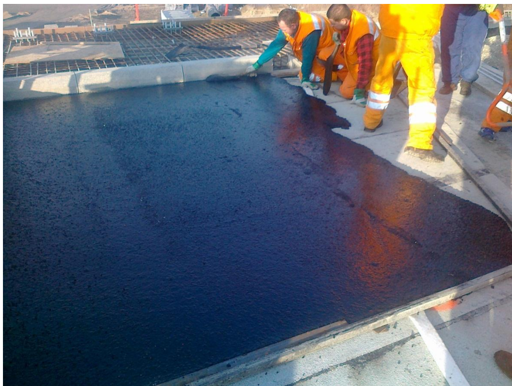
Fot. 13 Warstwa wiążąca z asfaltu twardolanego 20.12.2011
