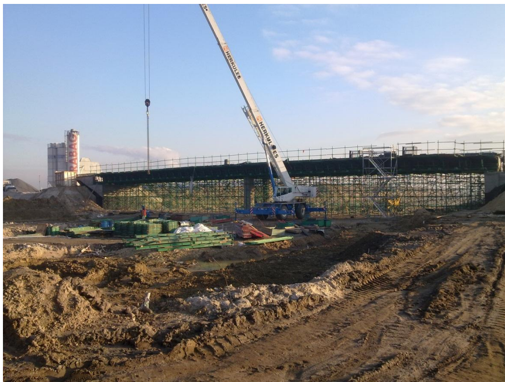
Fot. 15 Widok na wiadukt drogowy WD-224 20.12.2011
