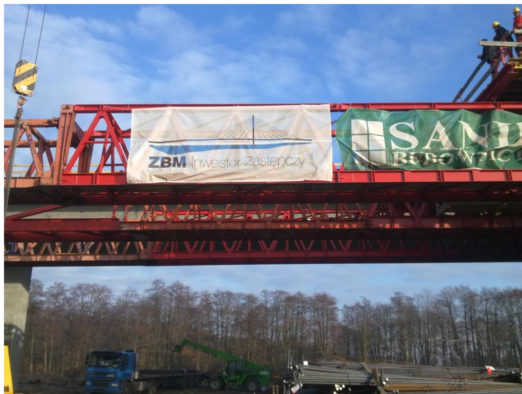
Fot. 17 Estakada E-221 widok na wózek do wykonywania przęseł 20.12.2011
