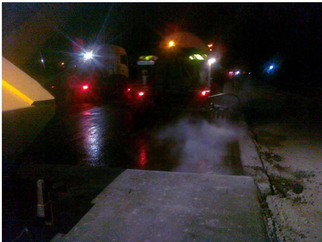
Fot. 1 Skropienie podbudowy 262+800 03.12.2011
