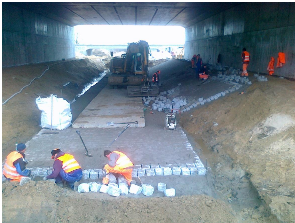
Fot. 12 Brukowanie koryta rzeki Moszczenica 16.12.2011
