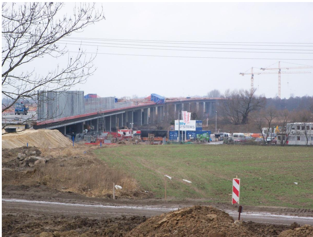
Fot. 20 Wykonywanie kap chodnikowych i montaż ekranów akustycznych na E-221 29.12.2011
