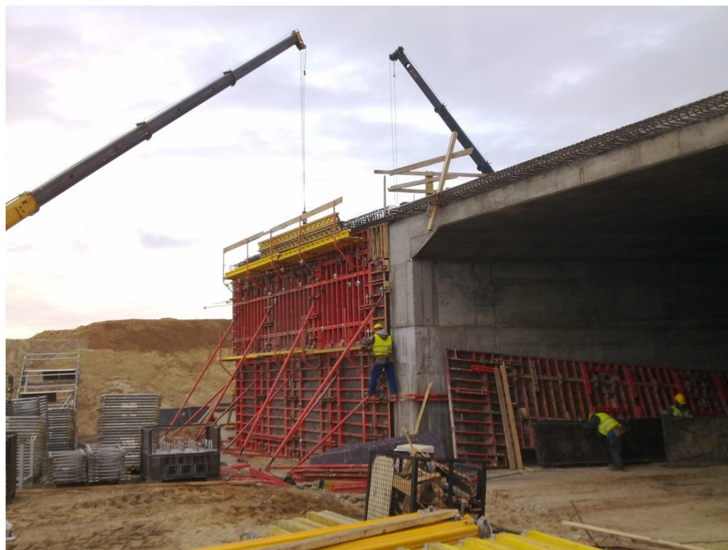
Fot. 5 Deskowanie skrzydła obiektu PG-226A 06.12.2012
