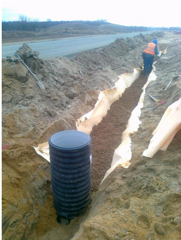
Fot. 3 Drenaż w pasie rozdziału 262+800 06.12.2011
