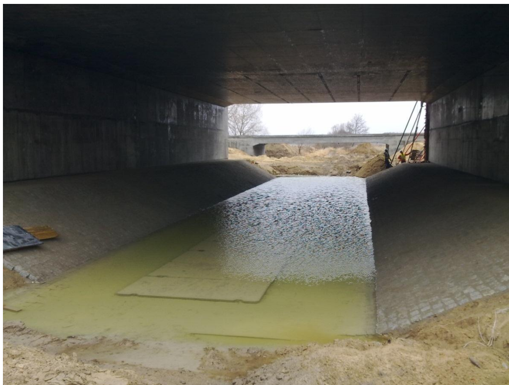
Fot. 19 Wykonanie obruku koryta rzeki Moszczenicy pod obiektem MA-226 28.12.2011
