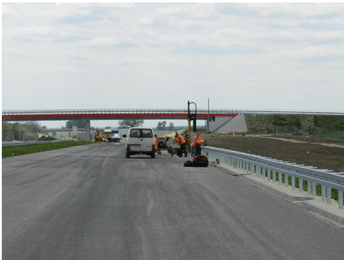
Fot. 15 Wbijanie barier drogowych w km 231+500 06.06.2012
