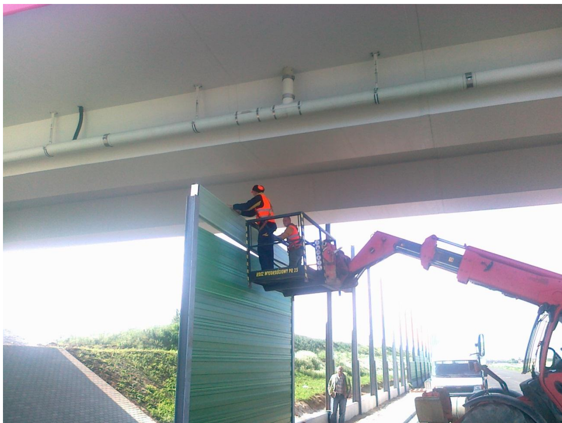
Fot. 6 Montaż paneli ekranów pod WD219 15.06.2012
