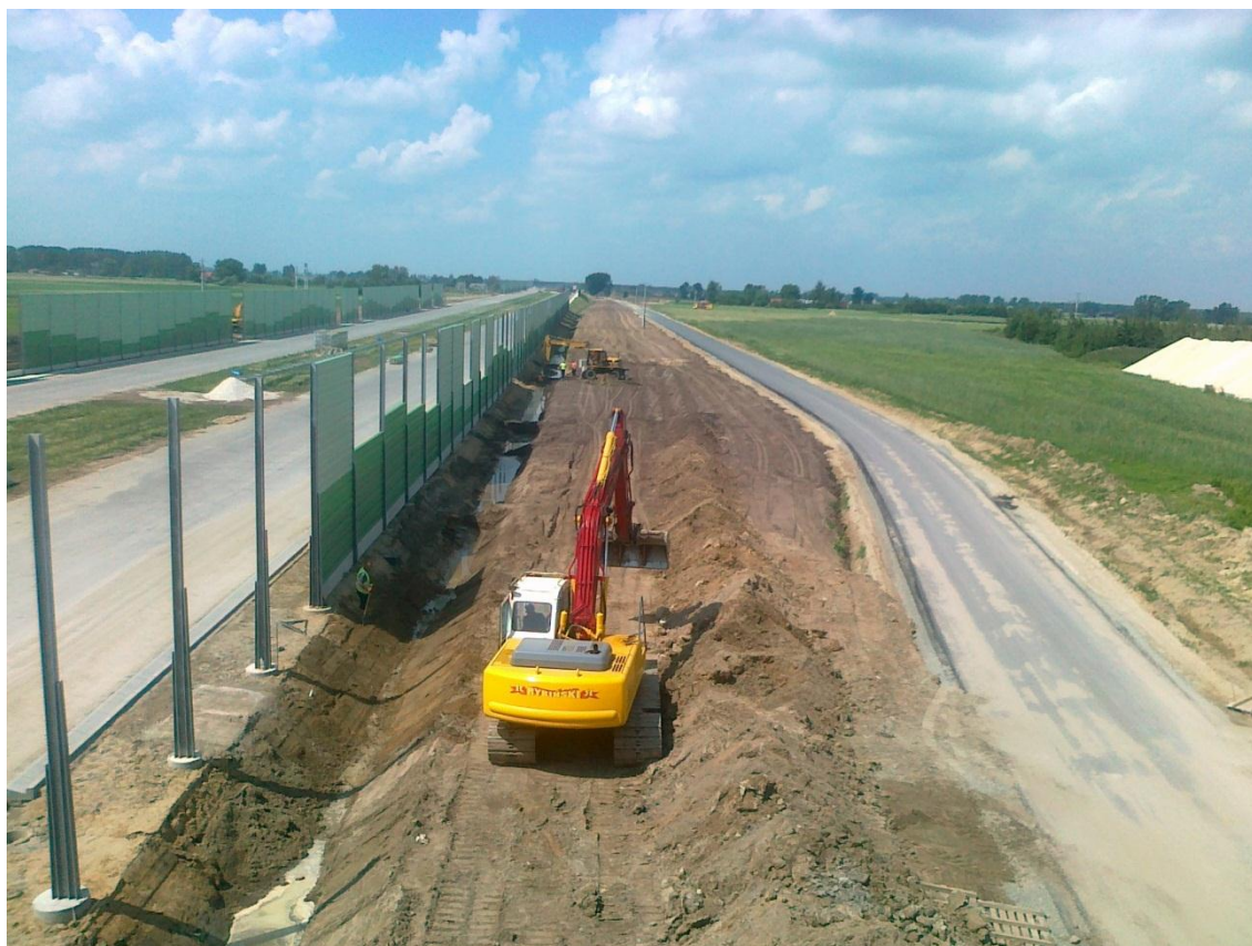
Fot. 7 Profilowanie terenu i rowów 268+000 12.06.2012
