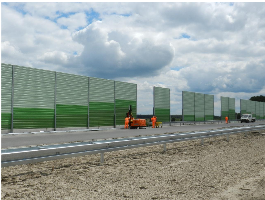
Fot. 20 Wbijanie barier energochłonnych 26.06.2012
