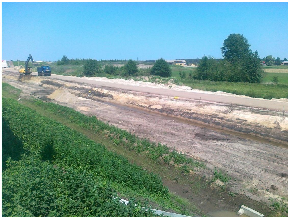
Fot. 8 Wykop pod zbiornik ZB35 18.06.2012
