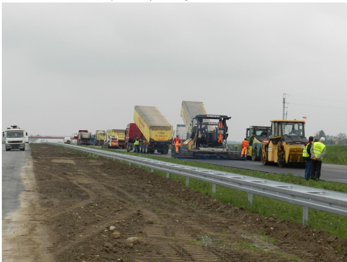
Fot. 14 Układanie warstwyścieralnej z SMA grubości 4 cm 04.06.2012
