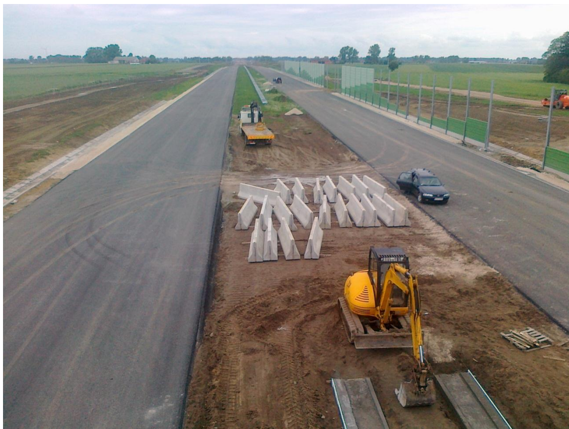
Fot. 4 Montaż barier betonowych pod WD219 11.06.2012
