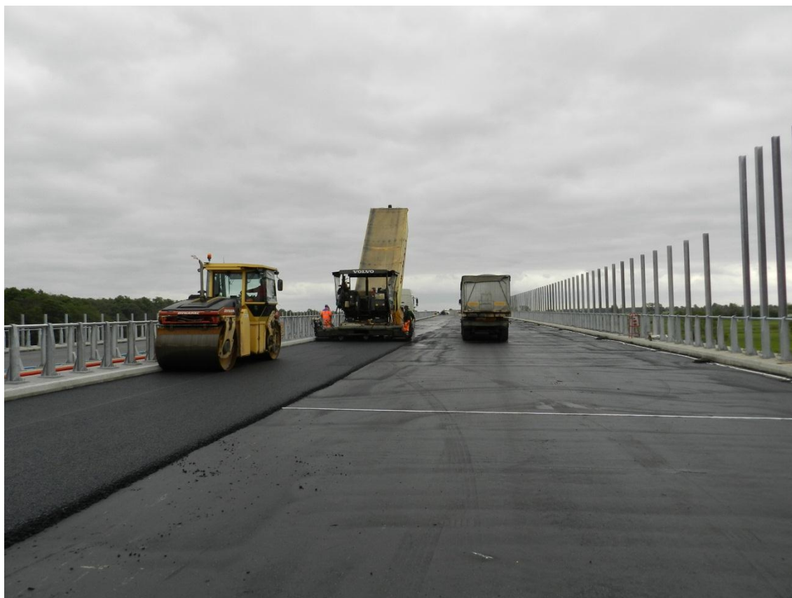
Fot. 17 Układanie warstwy wiążącej na prawej nitce estakady E-221 26.06.2012
