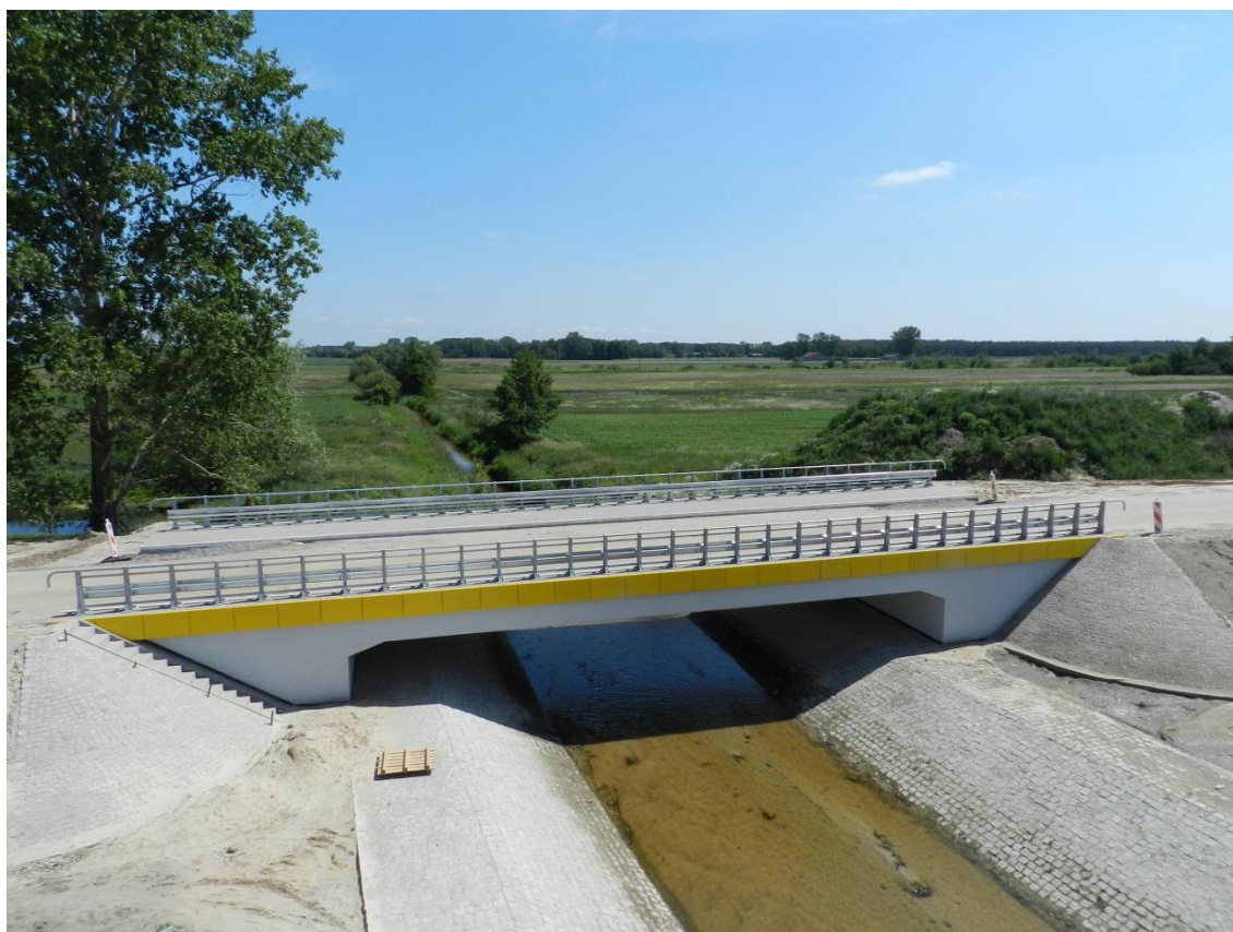
Fot. 18 Widok na most MD-226A 19.06.2012
