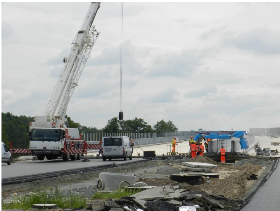
Fot. 13 Monaż dylatacji na przyczółku północnym estakady E-221 13.06.2012
