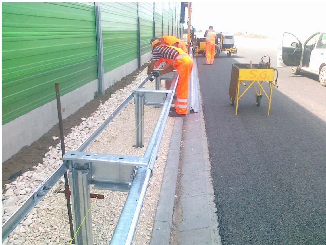
Fot. 5 Montaż barier stalowych 269+700 JL 12.06.2012
