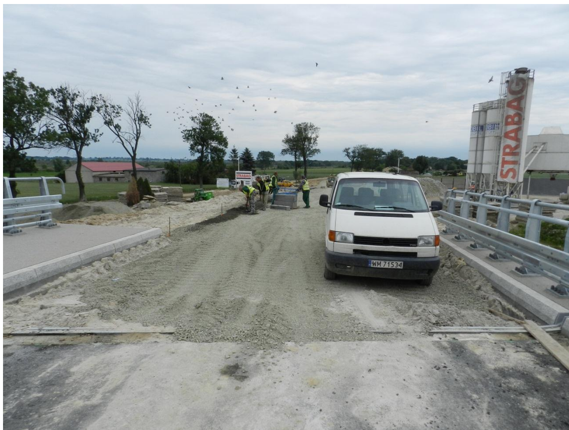
Fot. 19 Montaż krawężników na wschodnim dojeździe do WD-224 20.06.2012
