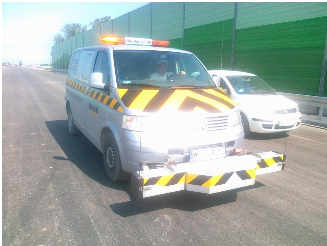
Fot. 10 Badanie równości warstwy wiążącej 19.06.2012
