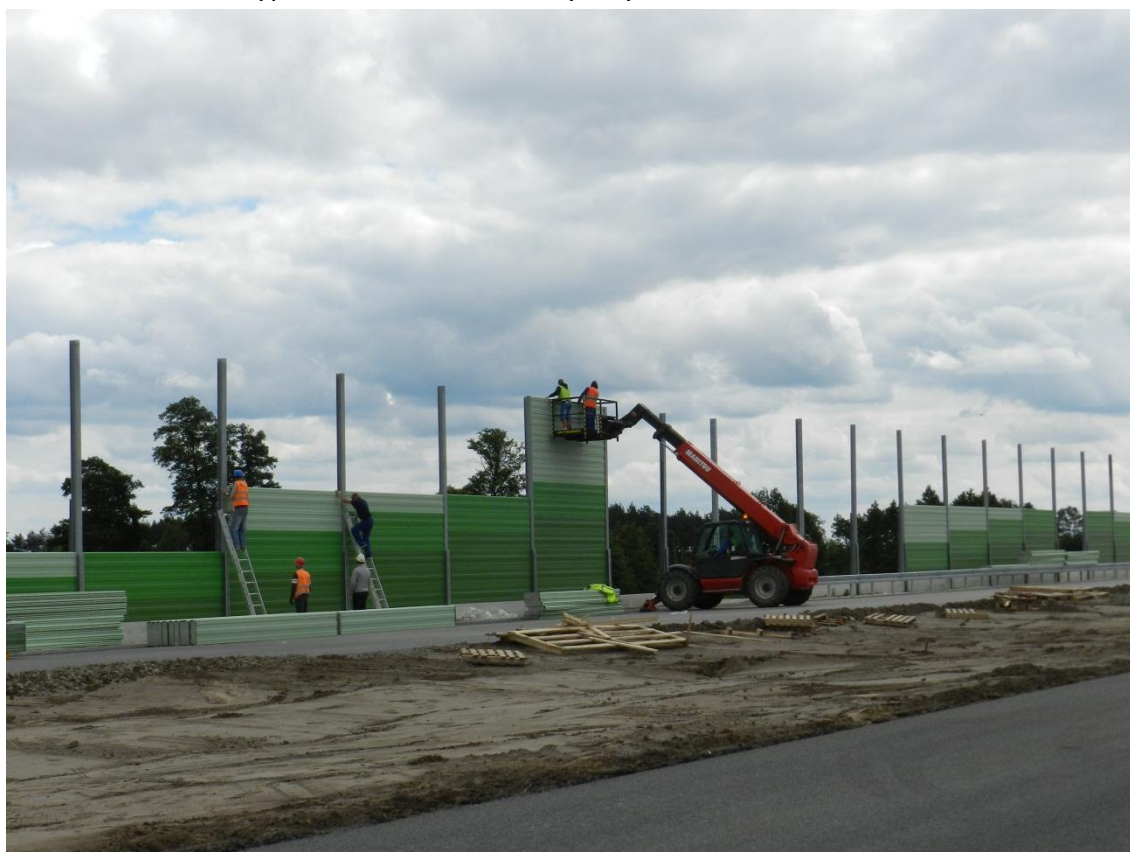
Fot. 16 Montaż wypełnień ekranów akustycznych 16.06.2012
