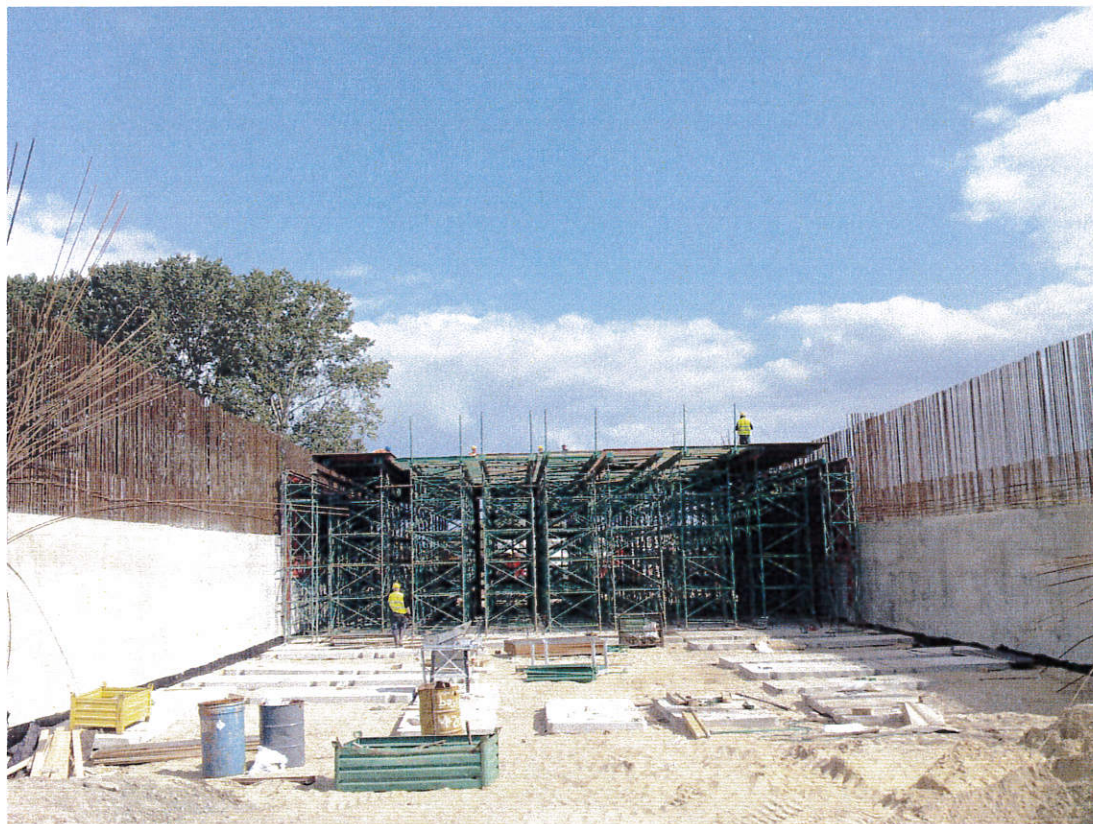
Fot. 15 Montaż rusztowania na moście autostradowym MA-226 14.09.2011
