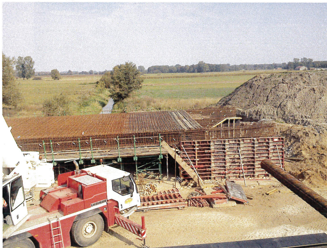
Fot. 18 Praca zbrojarskie na obiekcie MD-226A 27.09.2011
