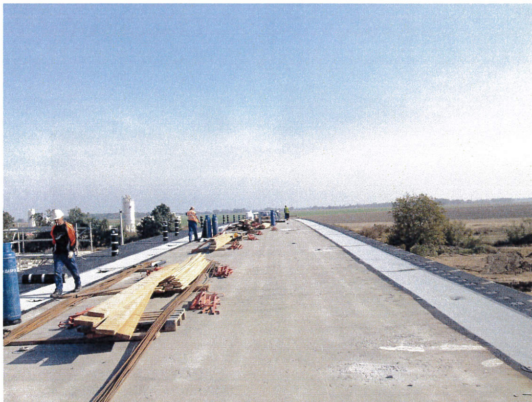
Fot. 19 Układanie hydroizolacji na ustroju nośnym wiaduktu WD-220 29.09.2011
