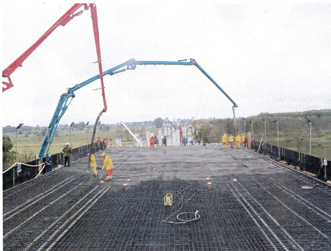
Fot. 12 Betonowanie płyty górnej ustroju nośnego estakady E-221, nitka lewa, takt 14 08.9.2011
