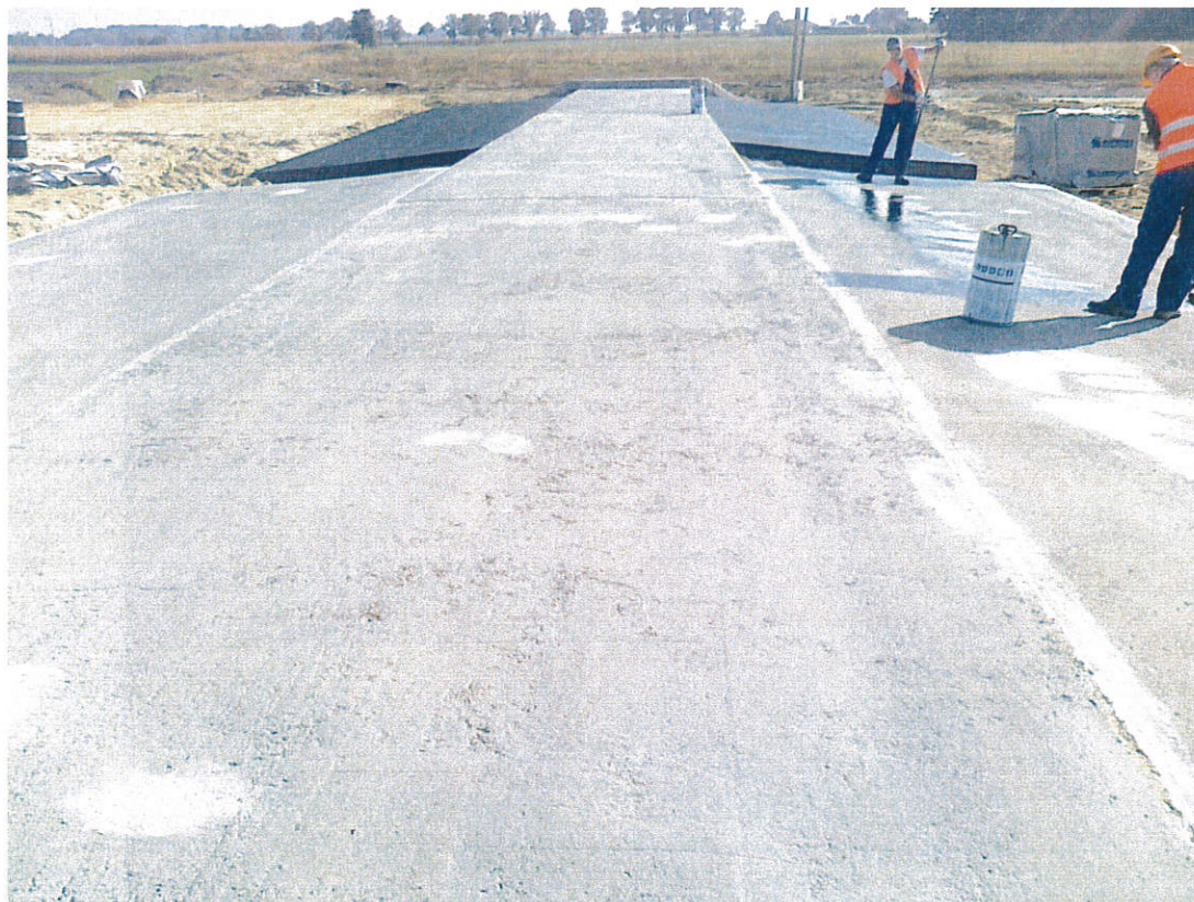
Fot. 7 Przepust P19 gruntowanie 26.09.2011
