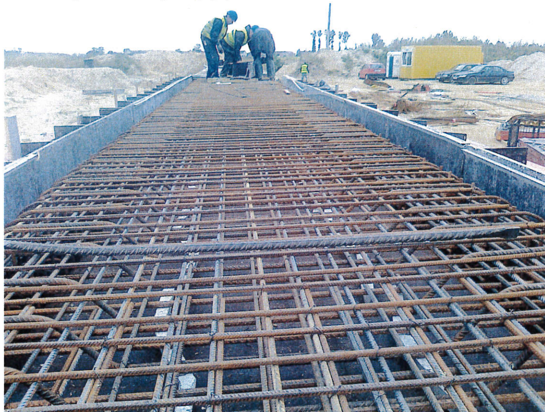
Fot. 5 Przepust P24 zbrojenie płyty 07.09.2011
