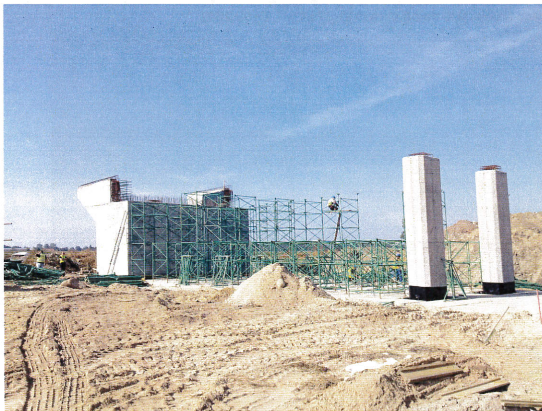
Fot. 20 Ustawianie rusztowania pod ustrój nośny WD-227 29.09.2011
