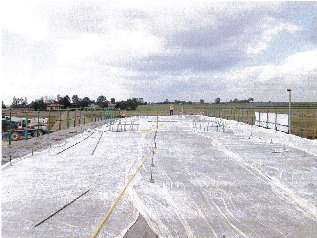
Fot. 13 Pielęgnacja obiektu WD-219 po zabetonowaniu ustroju nośnego 14.09.2011
