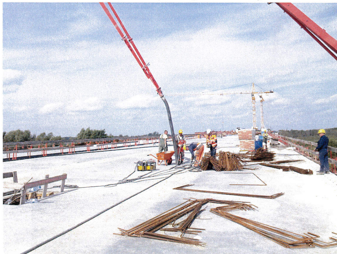
Fot. 10 Betonowanie dewiatorów ustroju nośnego na nitce lewej, E-221 1.09.2011
