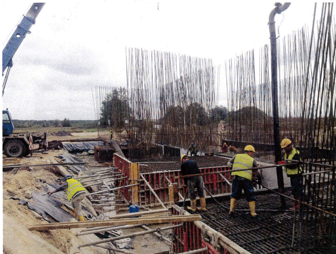
Fot. 16 Betonowanie skrzydła stopy fundamentowej na obiekcie PG-226A 20.09.2011
