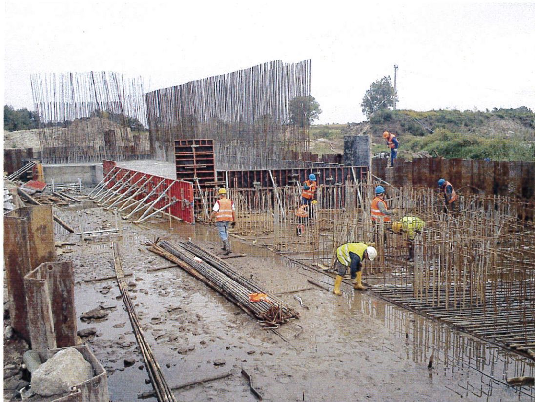
Fot. 17 Praca zbrojarskie na stopie fundamentowej mostu autostradowego MA-228 20.09.2011
