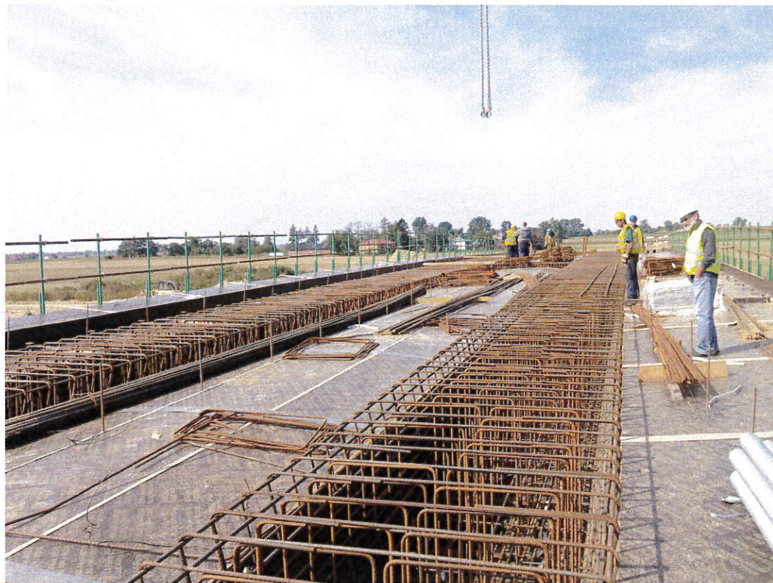
Fot. 9 Zbrojenie ustroju nośnego wiaduktu drogowego WD-219 1.09.2011
