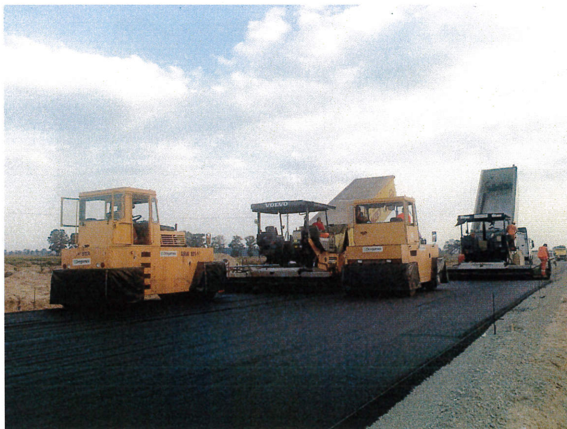
Fot. 4 Podbudowa bitumiczna 262+100 05.09.2011
