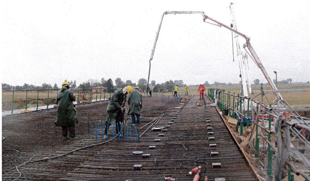
Fot. 12 Betonowanie płyty górnej ustroju nośnego estakady E-221, nitka lewa, takt 14 08.9.2011
