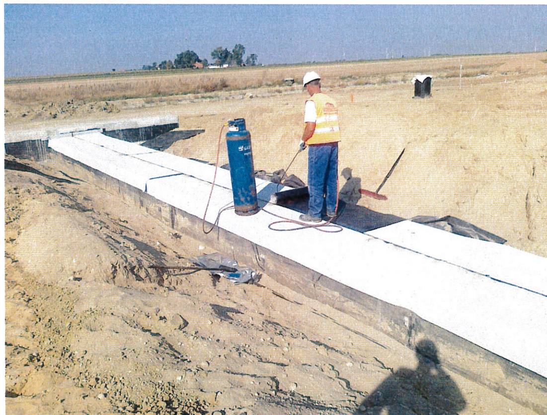
Fot. 6 Przepust P18 izolacja 26.09.2011
