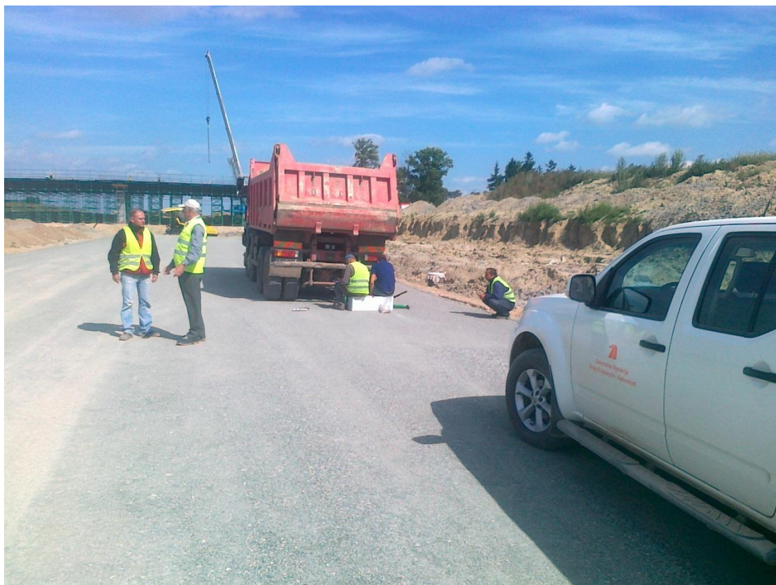
Fot. 3 Badania kontrolne podbudowy z kruszywa GDDKIA 261+700 30.08.2011
