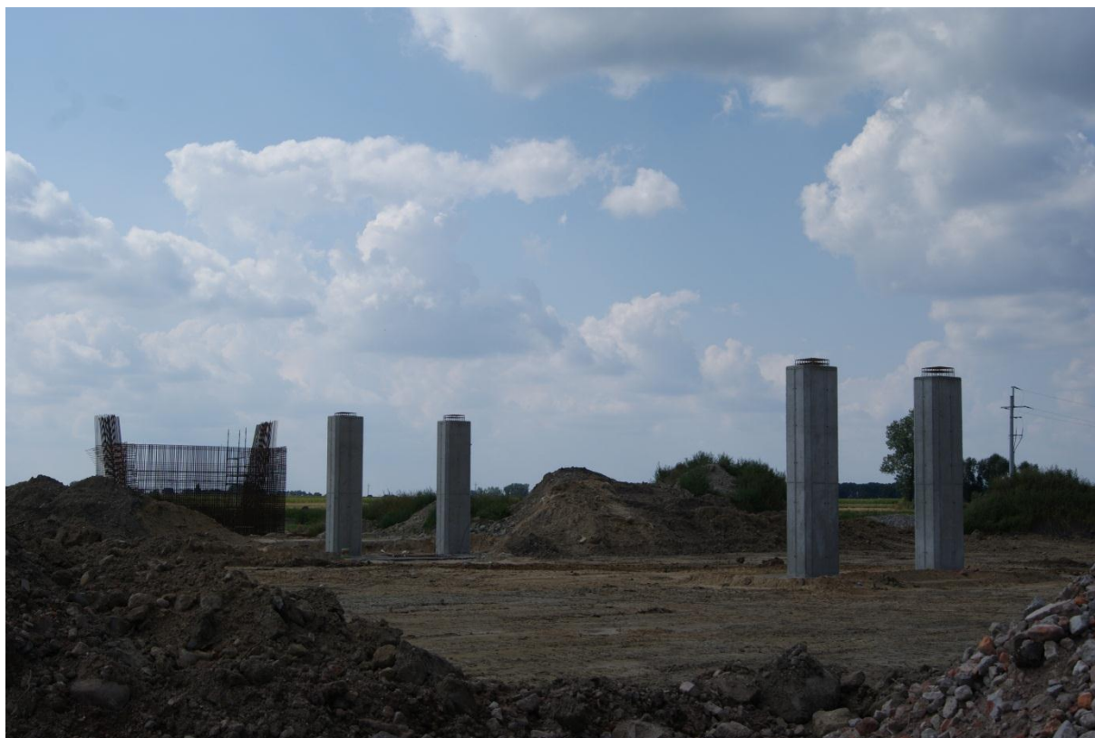
Fot. 17 Wiadukt drogowy WD-224 16.08.2011
