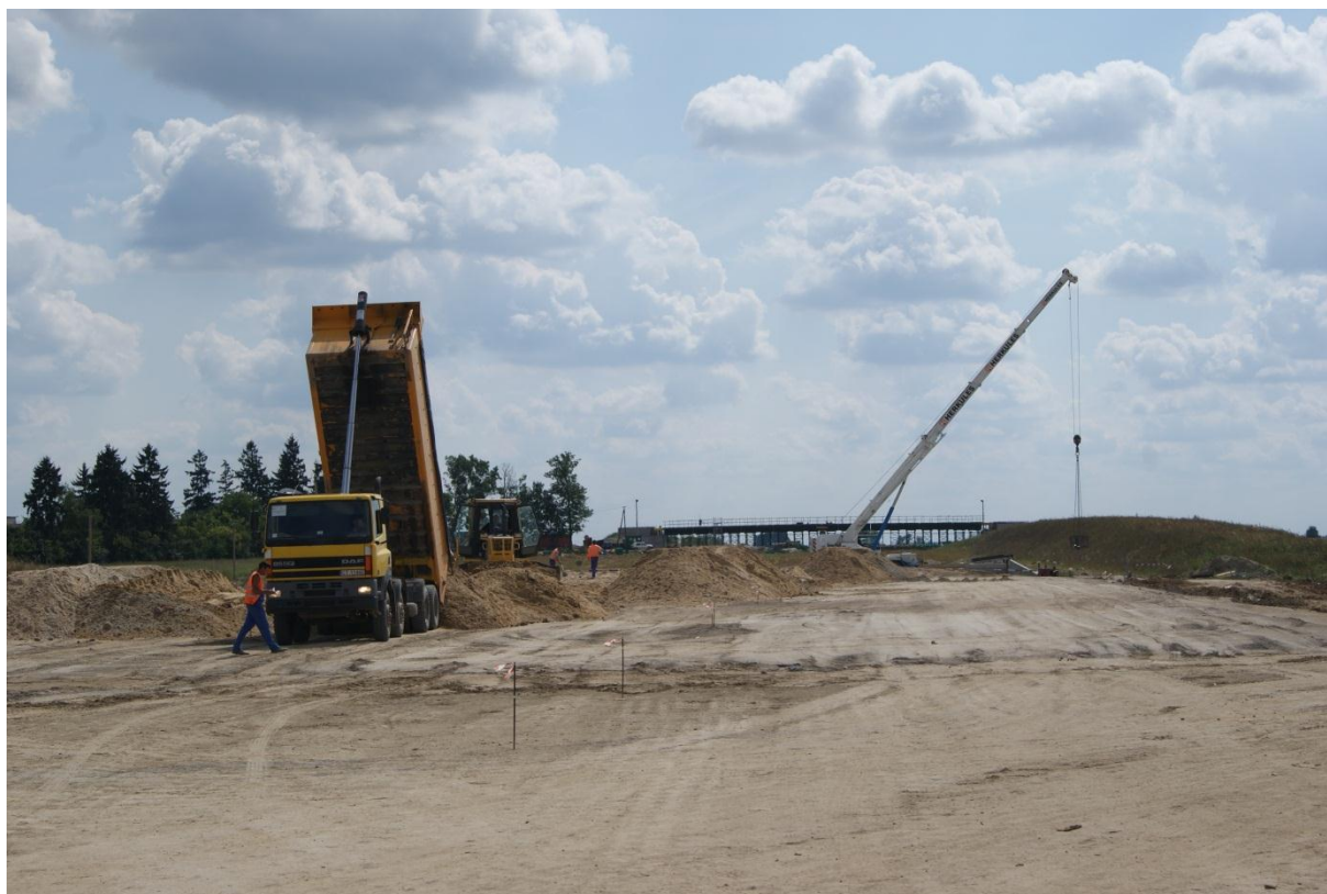
Fot. 18 Budowa nasypu km 261+500, w tle wiadukt drogowy WD-219 16.08.2011
