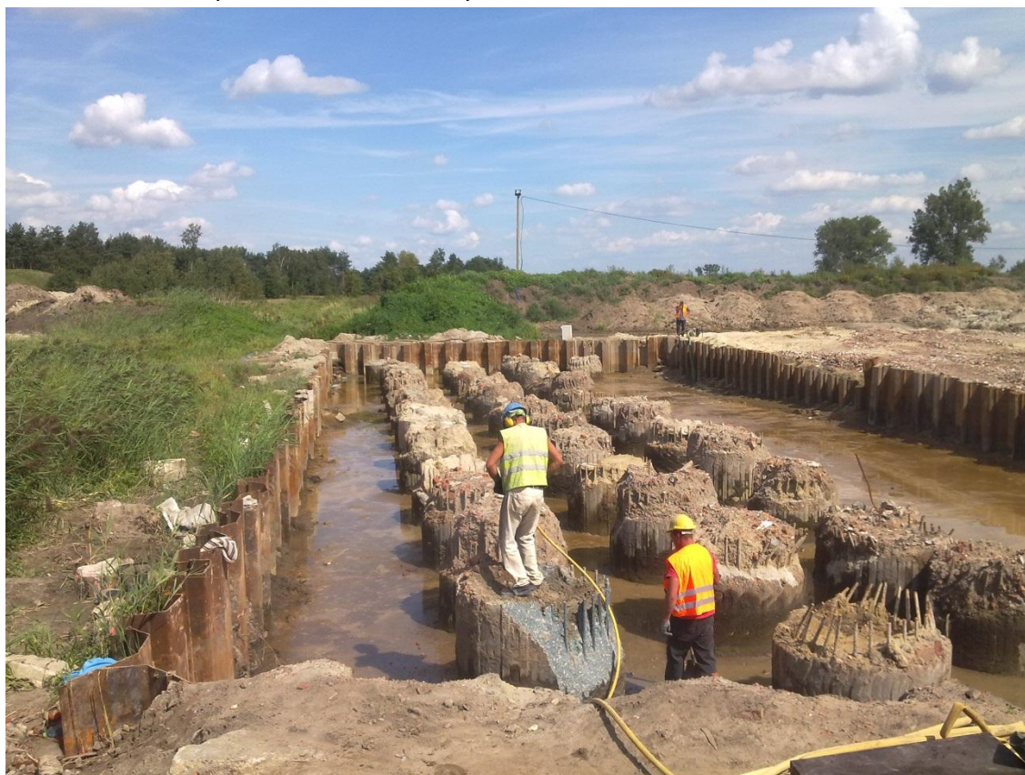
Fot. 14 Skuwanie pali wielkośrednicowych E-221 29.08.2011
