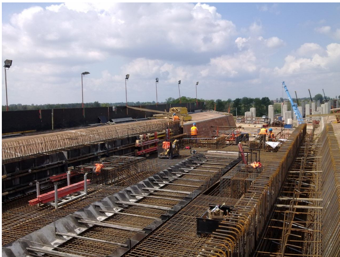
Fot. 5 Przygotowanie do betonowania taktu 9, etap 1 na estakadzie E-221 01.08.2011
