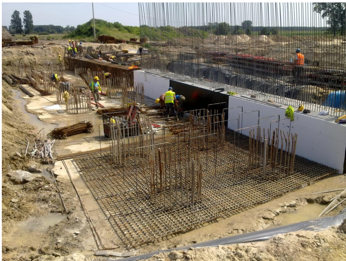
Fot. 11 Zbrojenie fundamentu przejścia gospodarczego PG-225 23.08.2011
