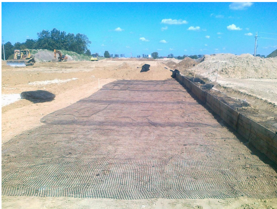
Fot. 2 Zbrojenie nasypu 266+800 04.08.2011
