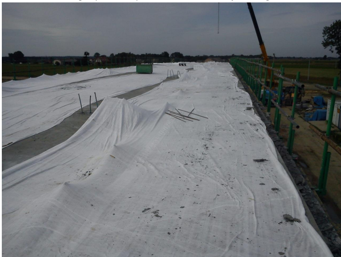
Fot. 8 Wiadukt drogowy WD-220 po zabetonowaniu ustroju nośnego 12.08.2011
