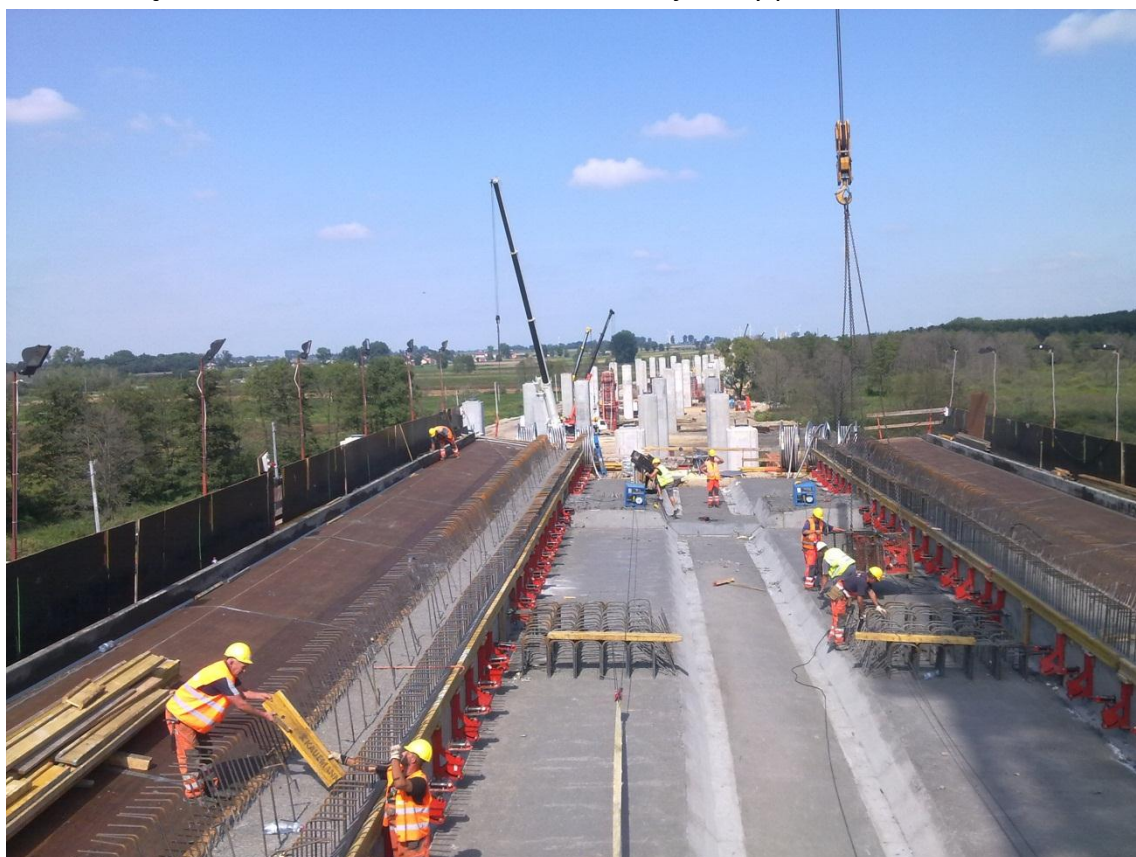
Fot. 10 Przęsło 12 nitka lewa, estakada E-221, ustrój nośny po zabetonowaniu 23.08.2011
