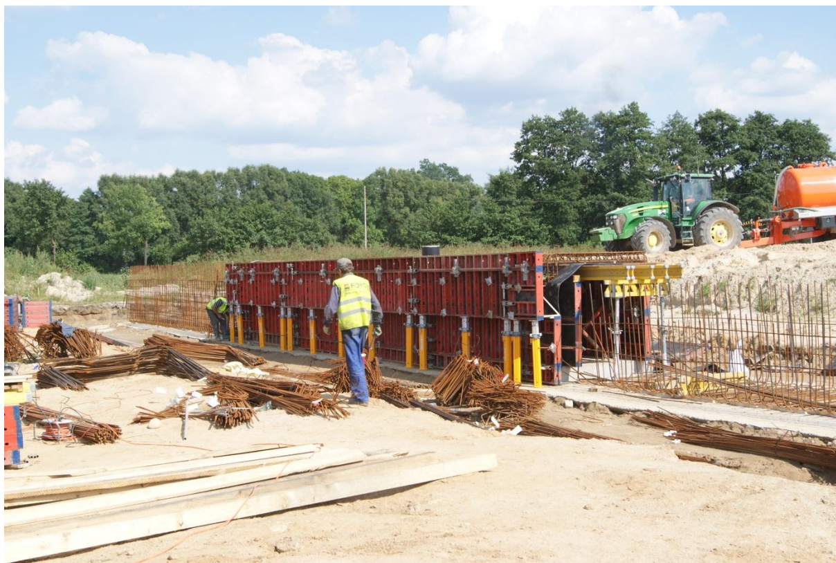
Fot. 20 Zbrojenie i szalowanie przepustu 16.08.2011
