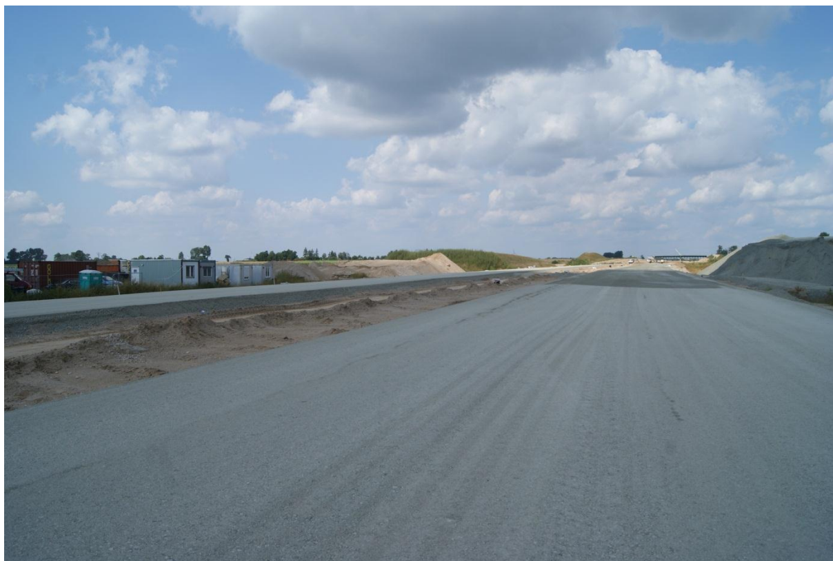
Fot. 15 Stabilizacja km 262+500 16.08.2011
