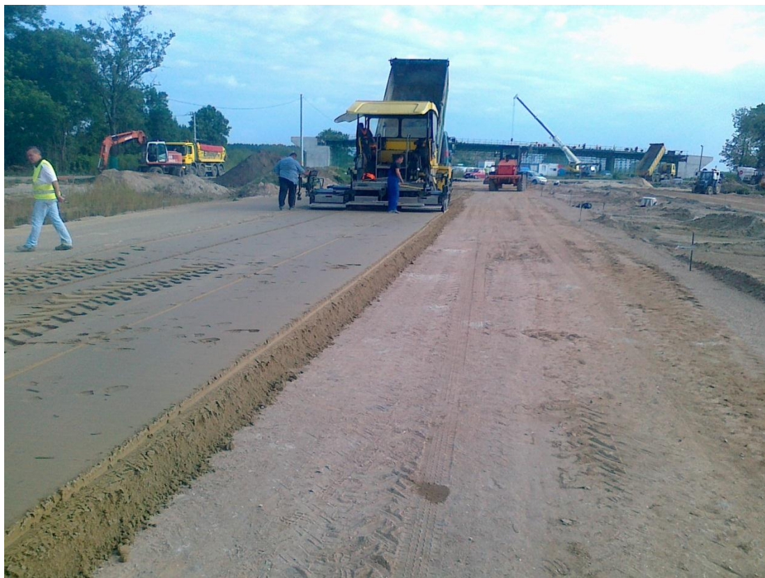
Fot. 1 Stabilizacja cementem km 262+500 01.08.2011
