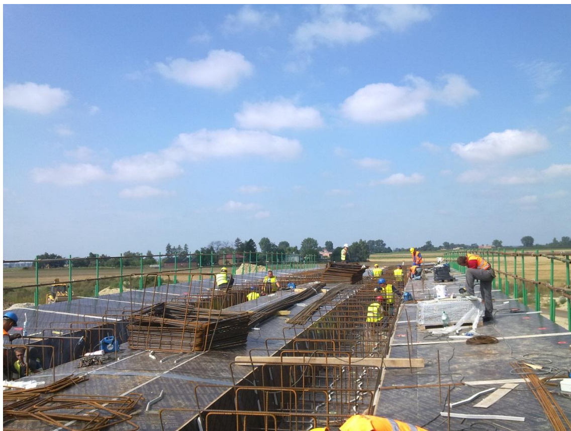
Fot. 9 Takt 7 - Prace zbrojarskie prowadzone na wiadukcie drogowym WD-219 23.08.2011
