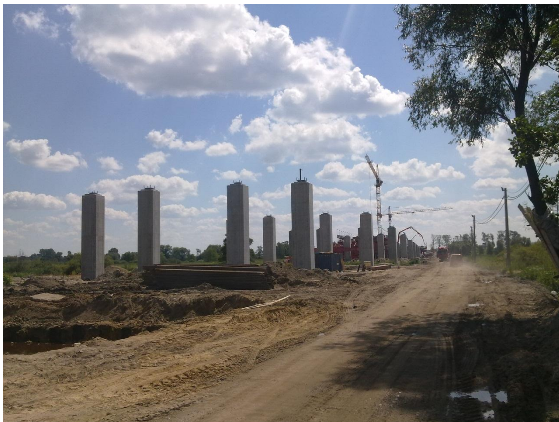
Fot. 7 Widok na ukończone filary estakady E-221 04.08.2011
