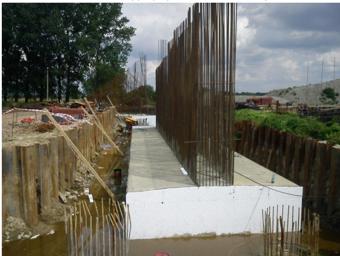
Fot. 6 Zabetonowane fundamenty podpory na moście autostradowym MA-226 02.08.2011
