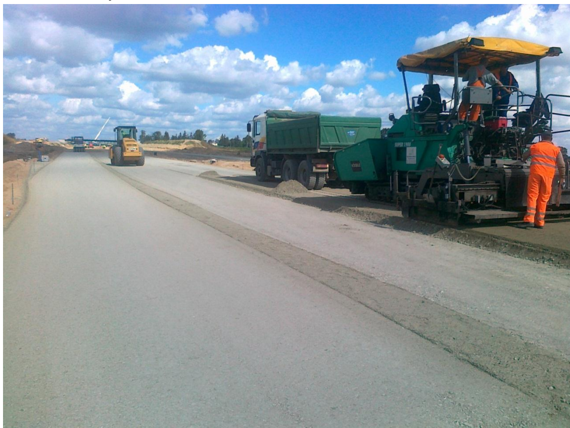
Fot. 4 Stabilizacja cementem 262+000 31.08.2011
