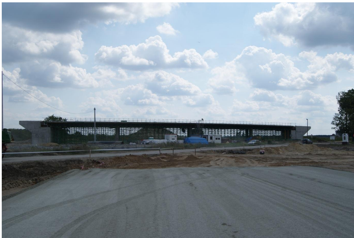
Fot. 16 Wiadukt drogowy WD-220 16.08.2011
