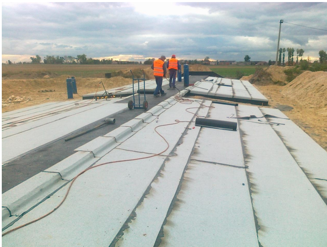
Fot. 18 Izolacja przepustu P24 14.10.2011
