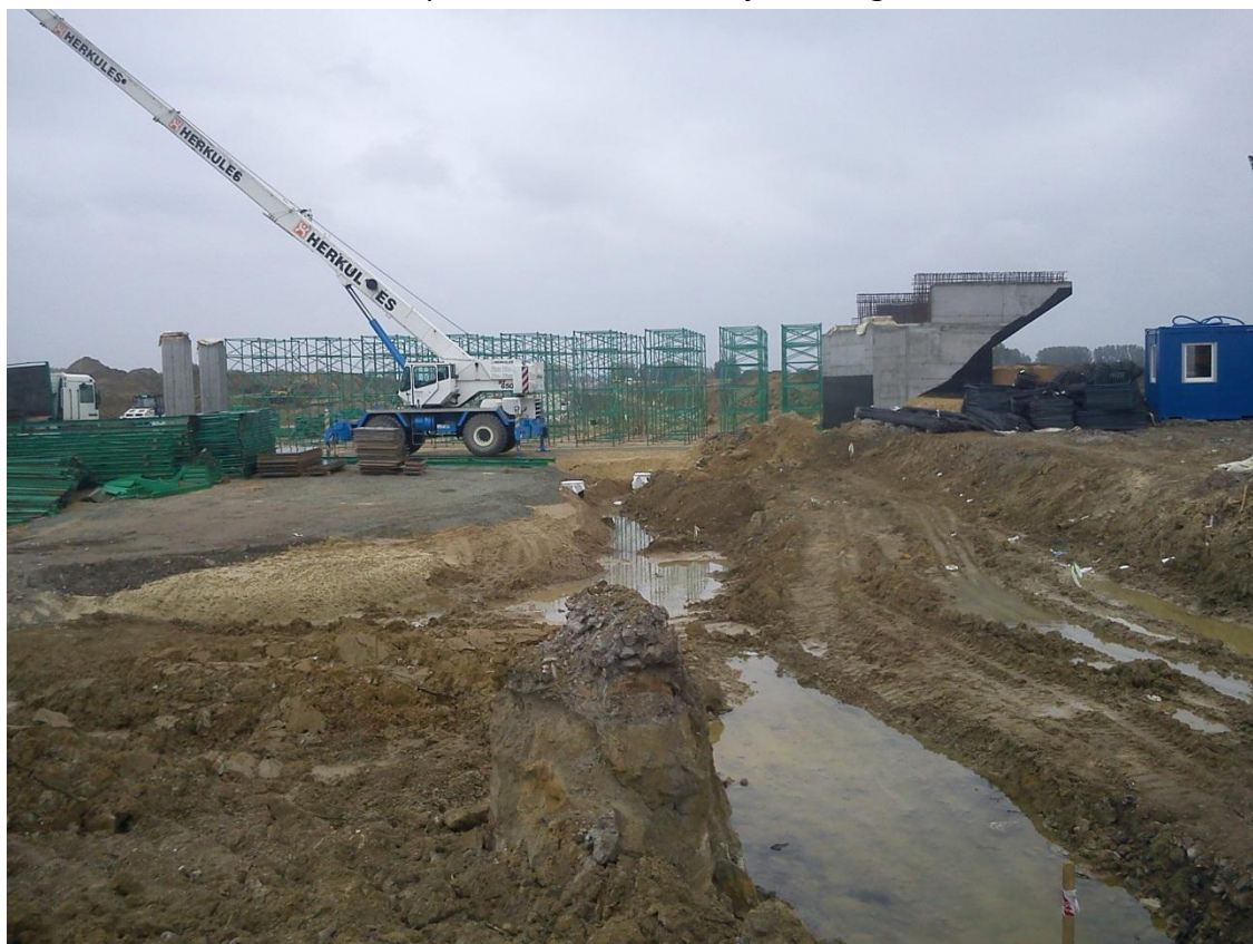
Fot. 12 montaż rusztowania pod deskowanie ustroju nośnego na WD-224
