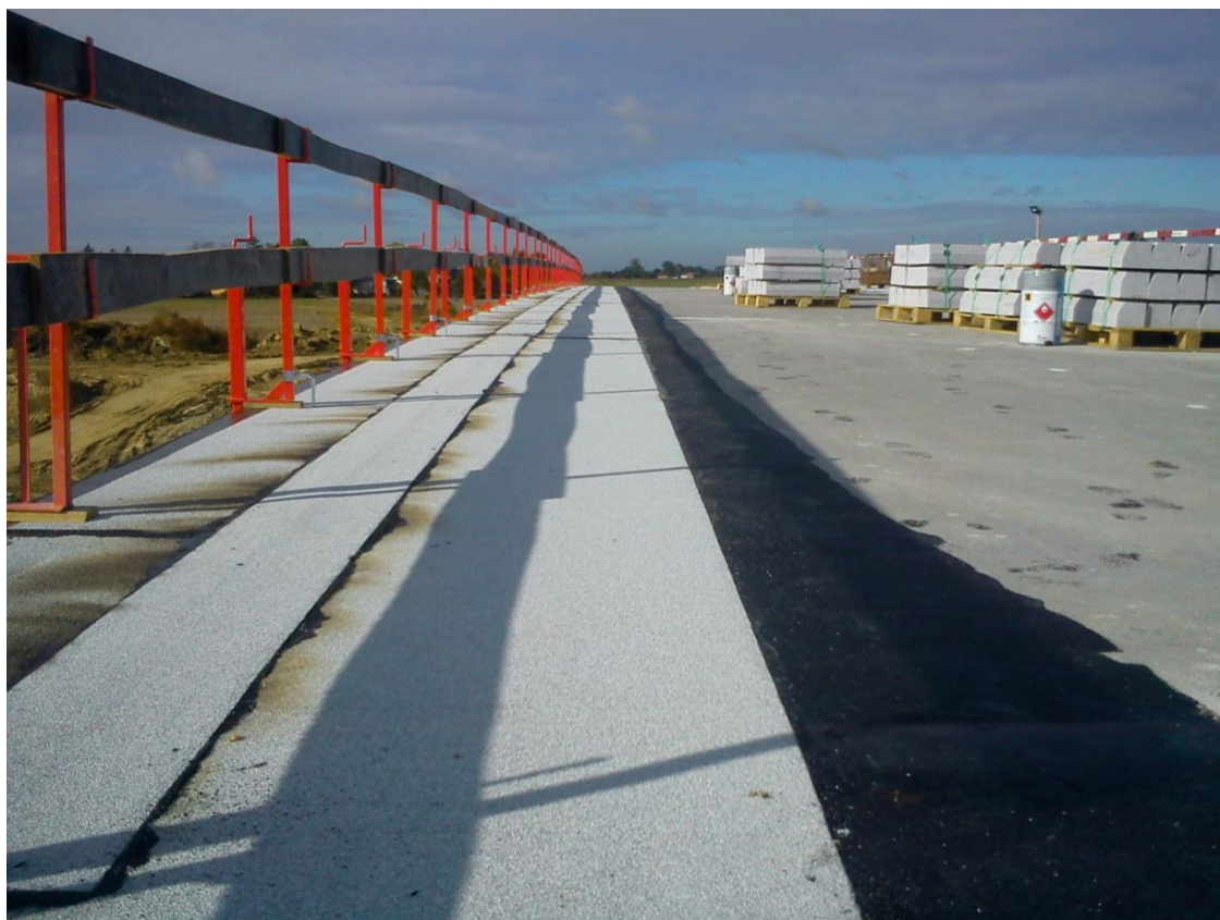
Fot. 7 hydroizolacja na WD-219 14.10.2011
