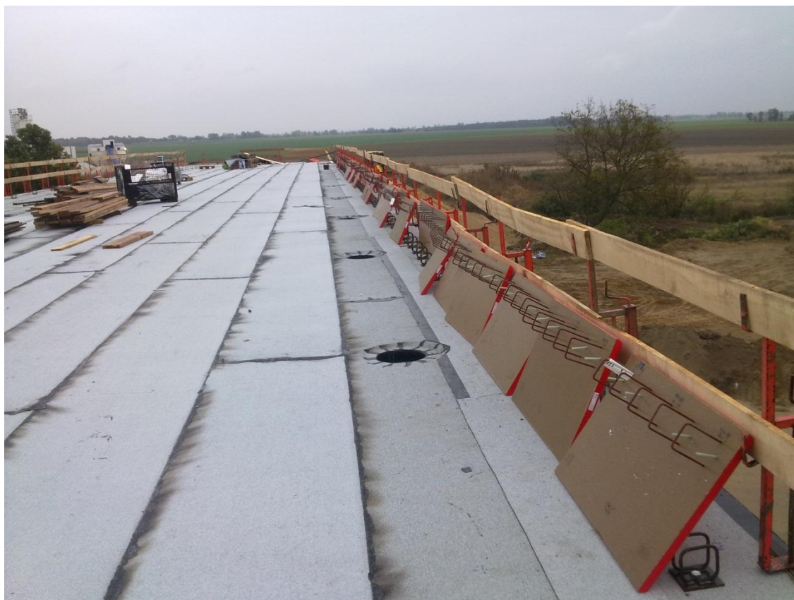
Fot. 11 montaż desek gzymsowych na WD-220 19.10.2011
