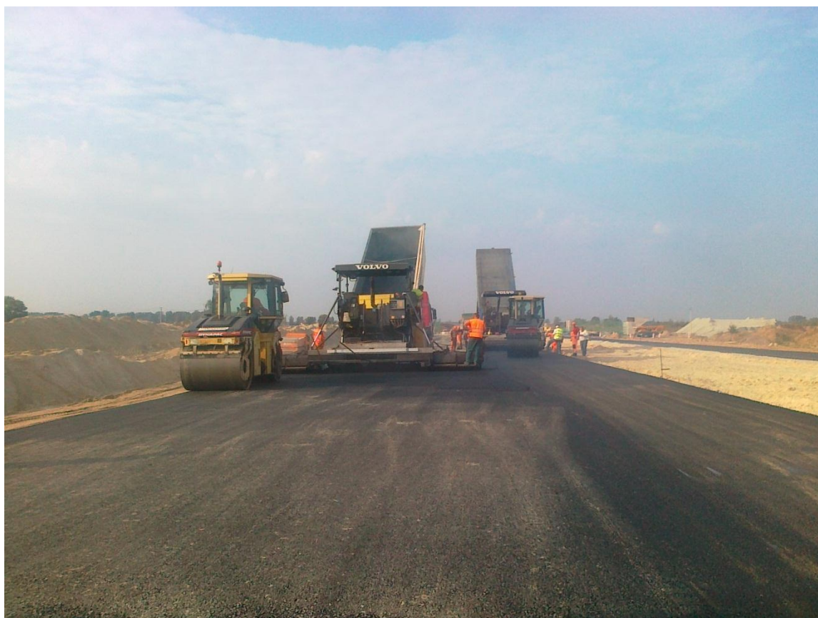
Fot. 16 Warstwa bitumiczna 268+300 04.10.2011
