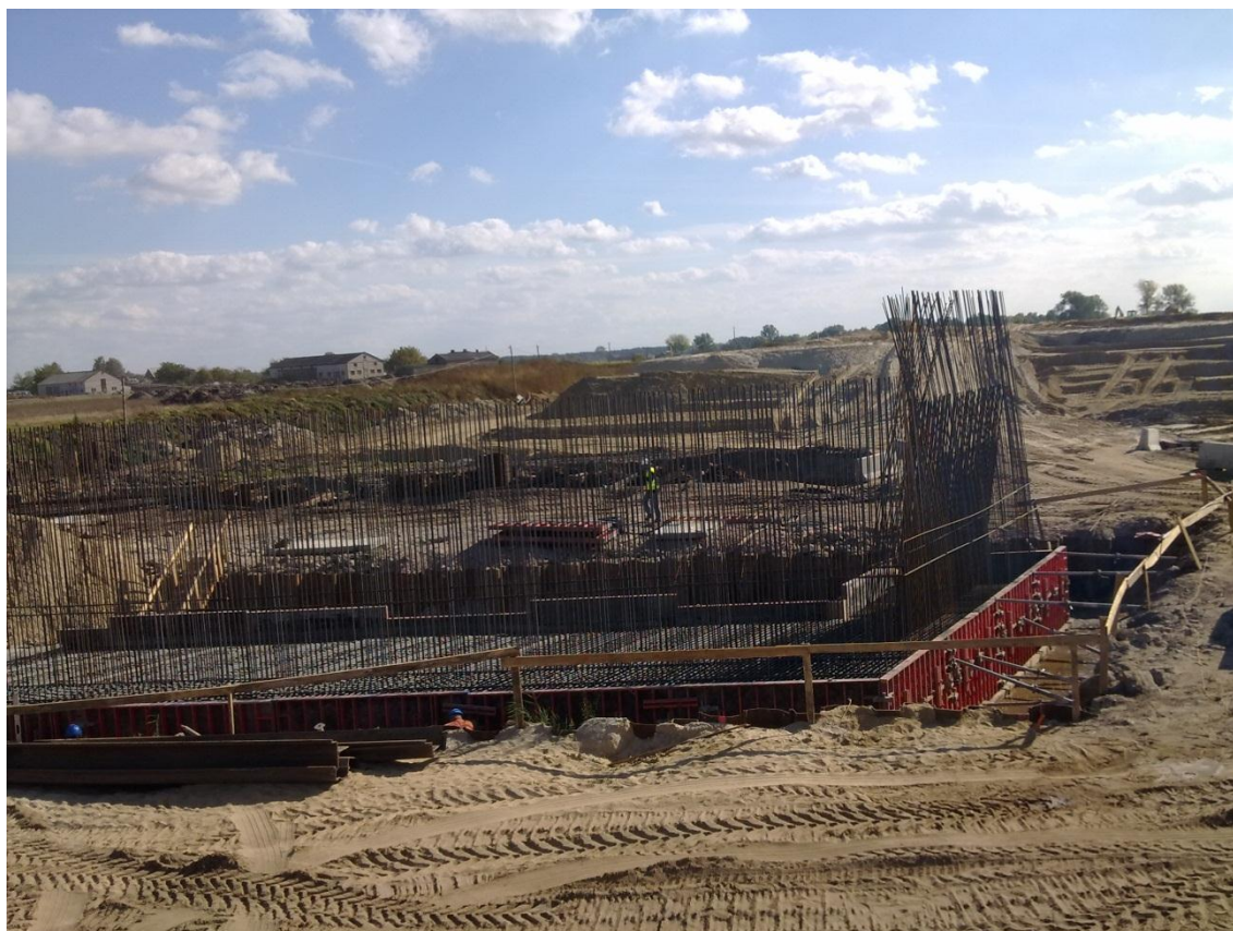
Fot. 3 Zbrojenie i szalowanie fundamentu podpory mostu MA-228 6.10.2011
