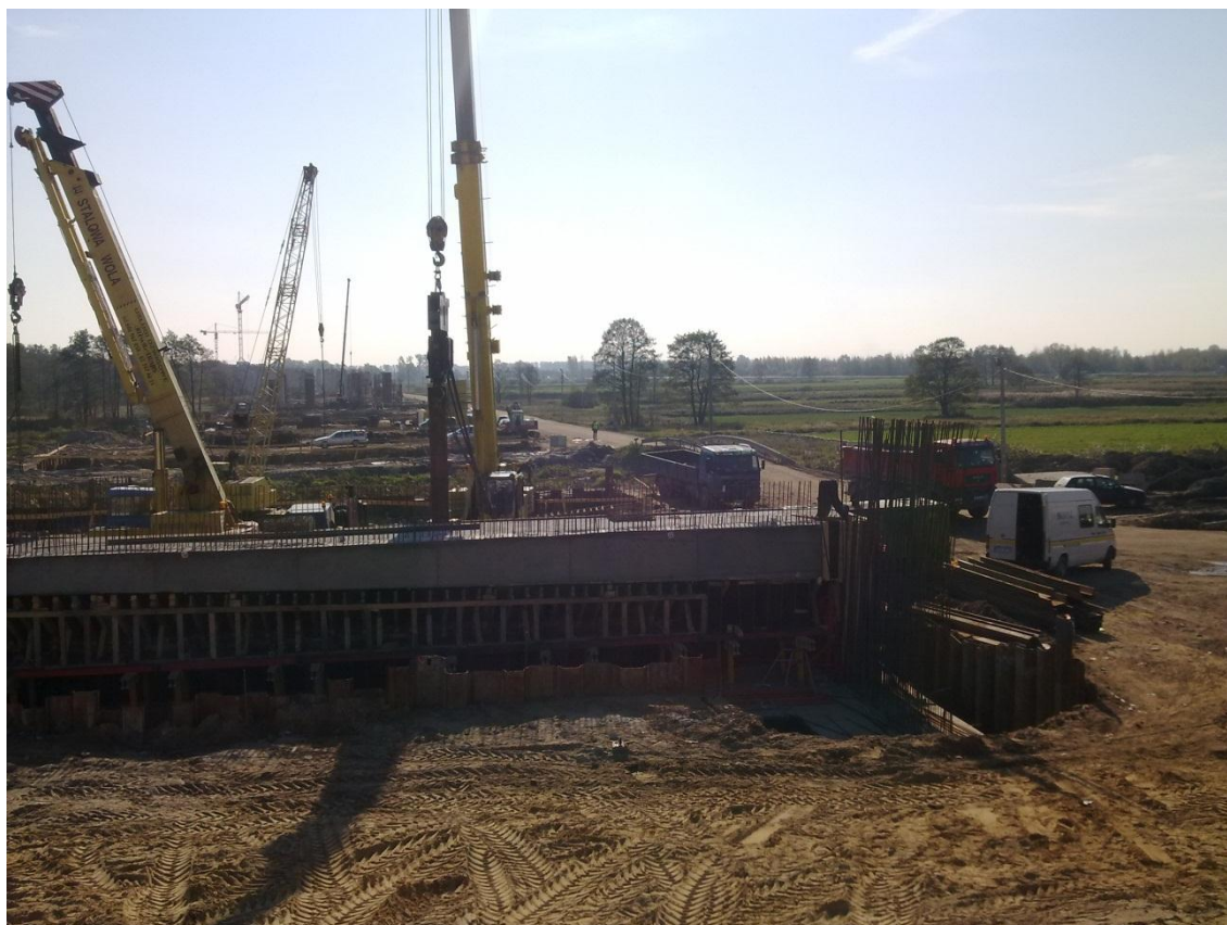
Fot. 9 Estakada E-221 widok na podporę 1 18.10.2011
