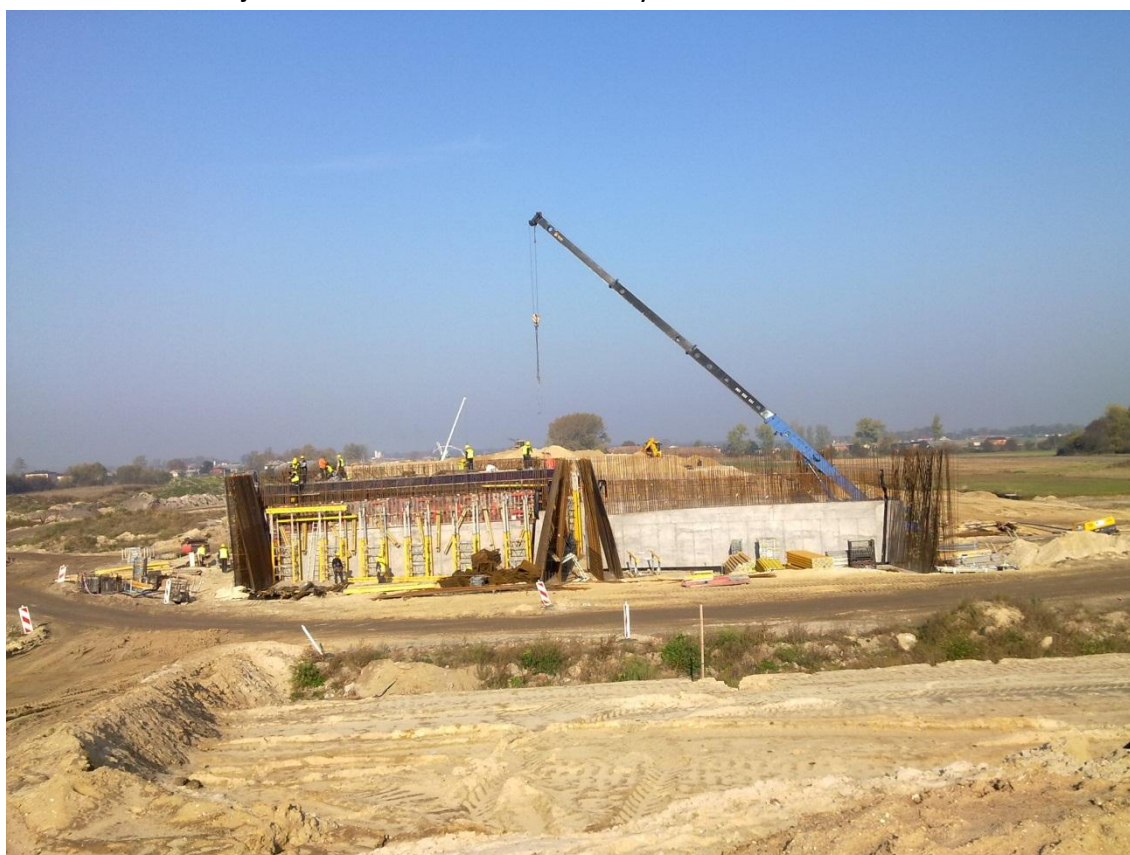
Fot. 14 Prace zbrojarskie na moście autostradowym MA-226 28.10.2011
