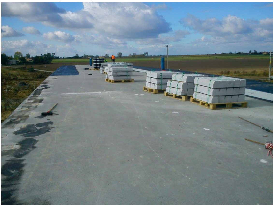
Fot. 6 Układanie hydroizolacji na obiekcie WD-219 12.10.2011
