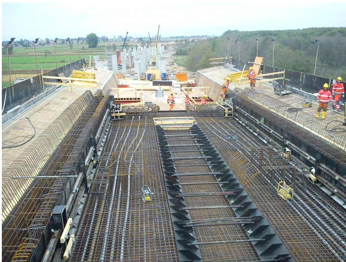
Fot. 5 Zbrojenie płyty dolnej - etap 1, takt 19, nitka lewa, estakada E-221 10.10.2011
