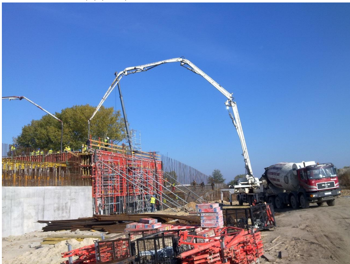
Fot. 10 betonowanie płyty ramy na moście MA-226 18.10.2011
