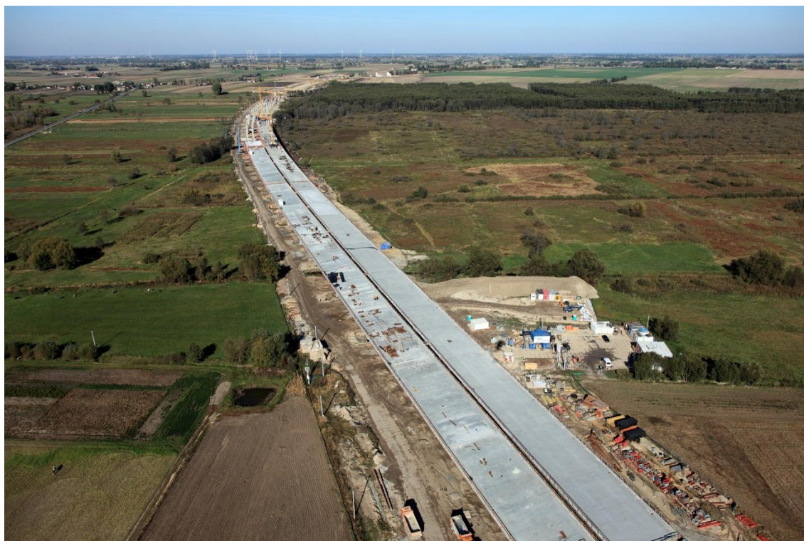
Fot. 13 Estakada E-221 widok z lotu ptaka 21.10.2011
