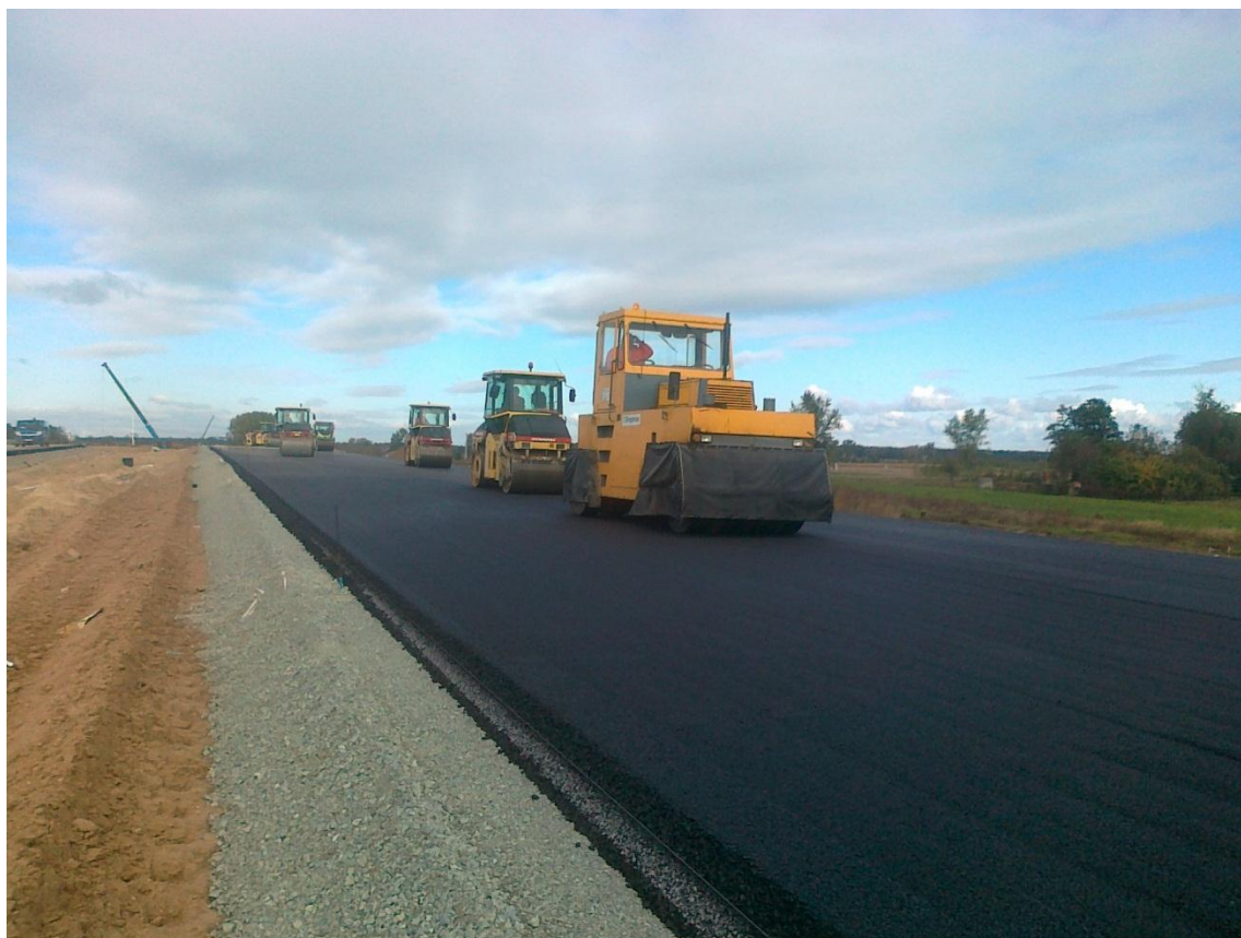
Fot. 17 Warstwa bitumiczna 267+300 14.10.2011
