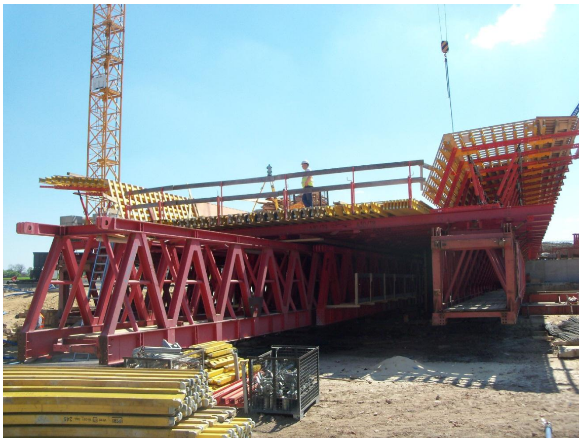
Fot. 3 Postęp w realizacji rusztowania pod ustrój nośny Estakady E-221 09.05.2011
