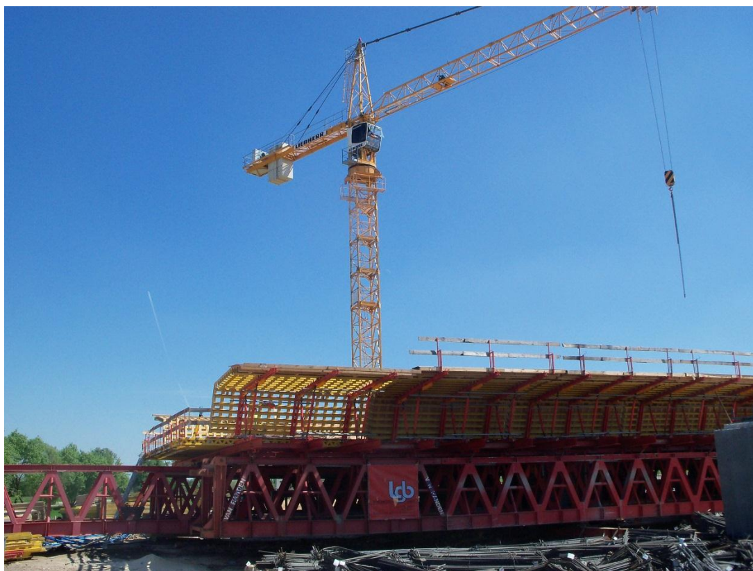
Fot. 2 Widok rusztowania i deskowania pod ustrój nośny na E-221 09.05.2011
