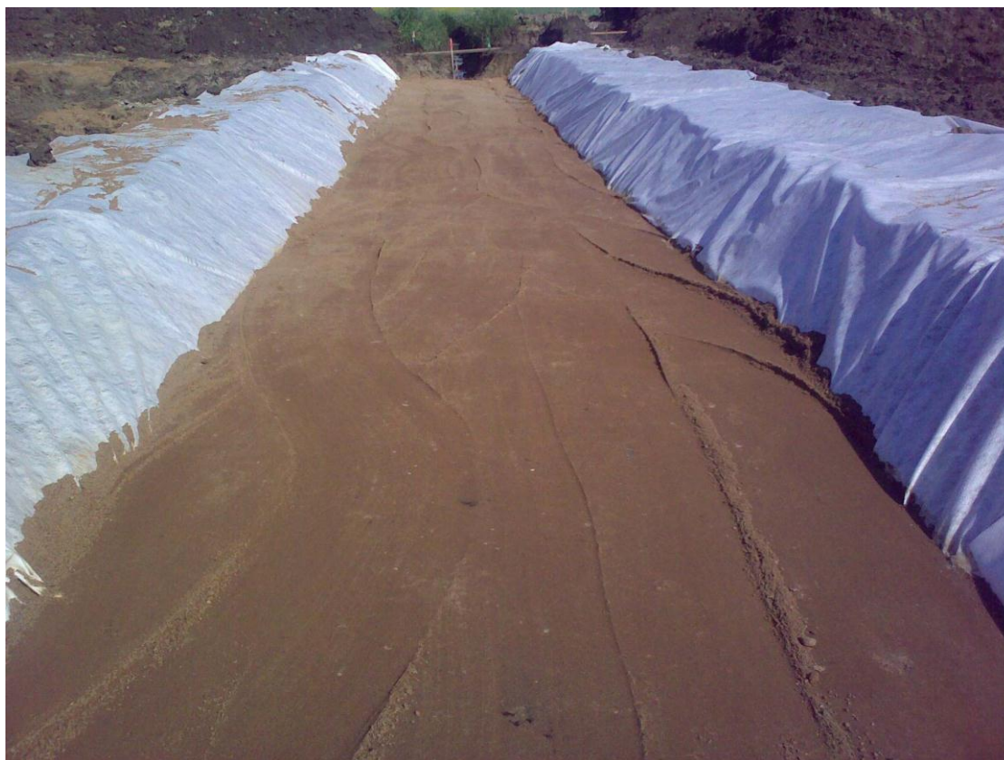
Fot. 12 Zasyпка przepustu P41 24.05.2011
