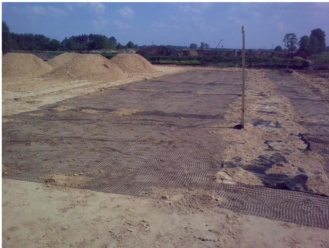
Fot. 8 Zbrojenie nasypu 268+400 19.05.2011
