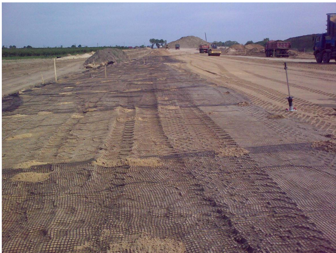
Fot. 13 Zbrojenie nasypu 263+200 26.05.2011
