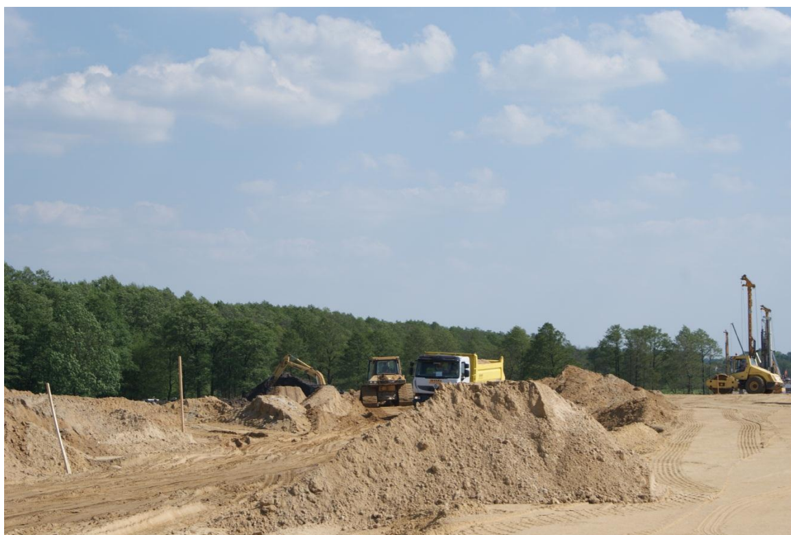
Fot. 22 Budowa nasypu w km 263+200 27.05.2011
