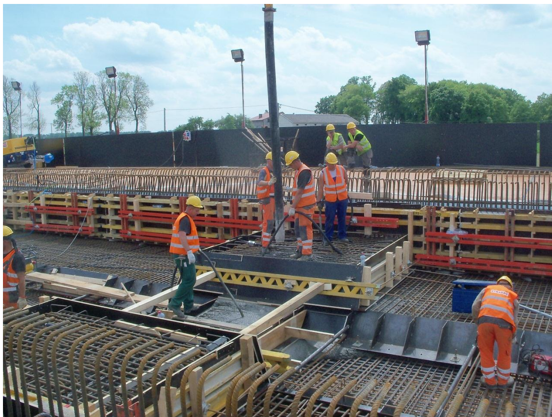
Fot. 5 Betonowanie poprzecznicy ustroju nośnego (takt 1) na Estakadzie E-221 18.05.2011
