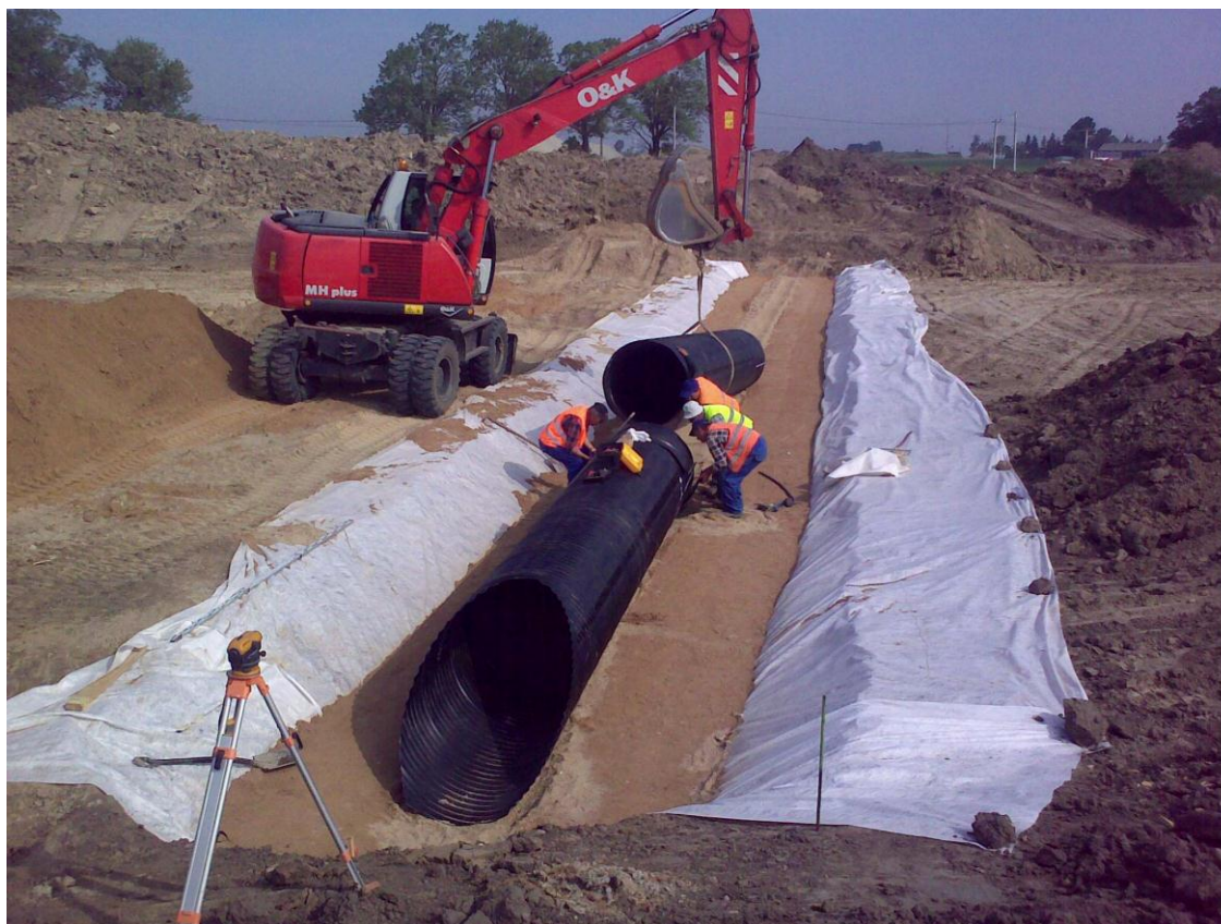
Fot. 9 Montaż przepustu P42 20.05.2011
