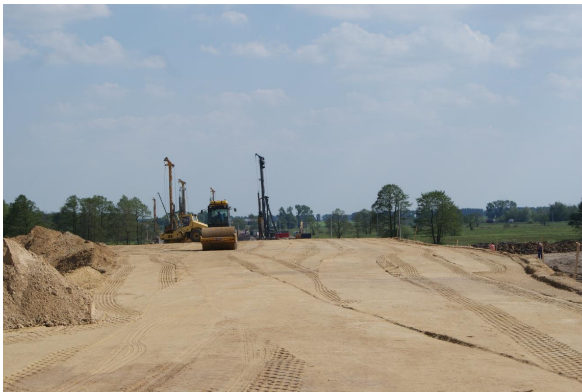
Fot. 21 Budowa nasypu w km 263+200 27.05.2011
