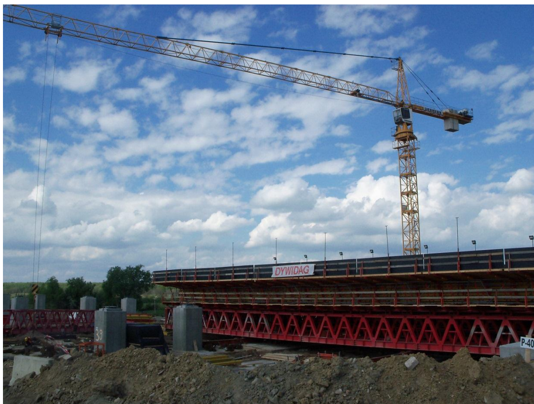
Fot. 6 Widok 1 taktu ustroju nośnego Estakady E-221 zaszalowanego i przygotowanego do betonowania 16.05.2011
