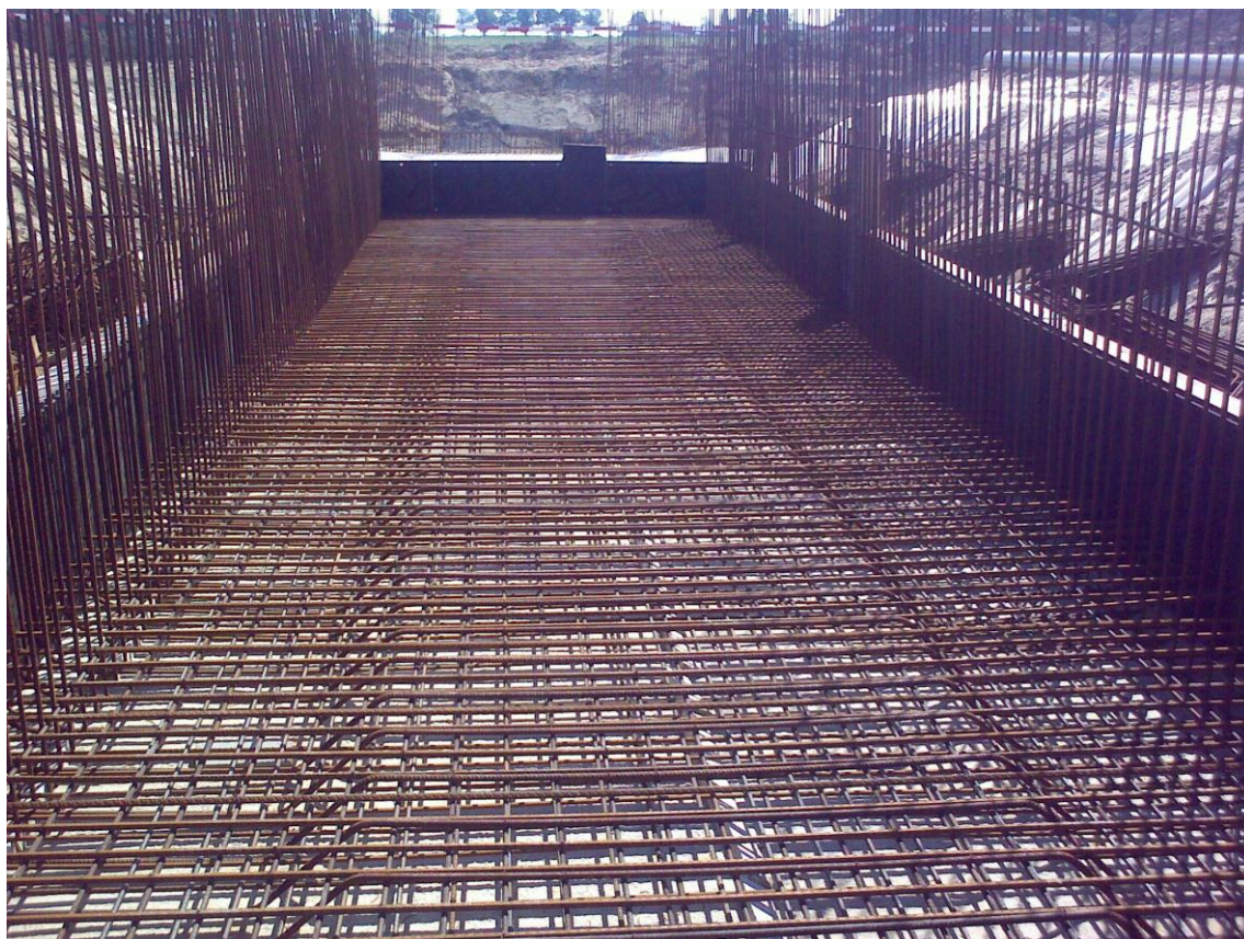
Fot. 7 Zbrojenie przepustu P19 19.05.2011
