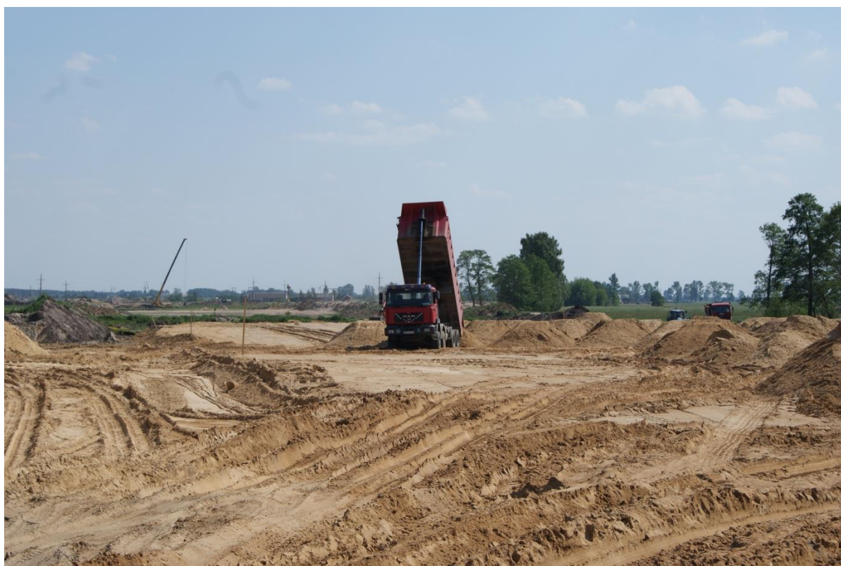
Fot. 20 Wymiana gruntu w km 268 27.05.2011
