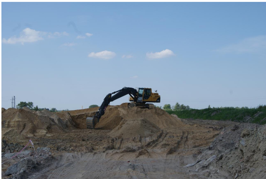
Fot. 19 Wykonywanie nasypu na objeździe WD-224 27.05.2011
