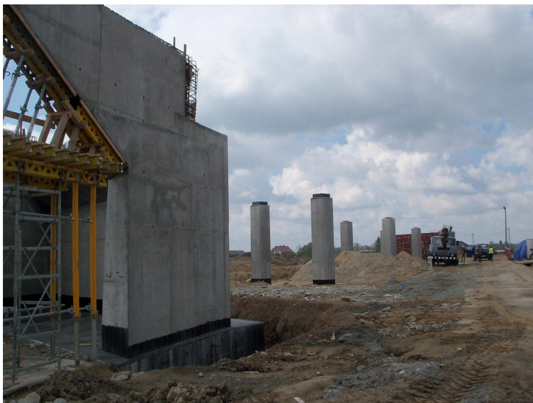
Fot. 1 Stan zaawansowania robót żelbetowych na wiadukcie WD-220 05.05.2011
