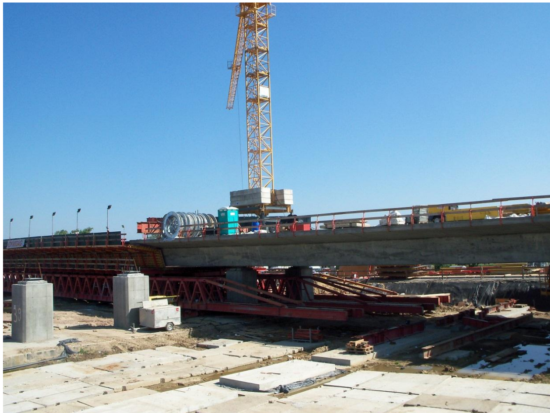
Fot. 18 Pierwszy takt po rozszalowaniu, drugi takt - szalunek pod ustrój nośny, E-221 31.05.2011
