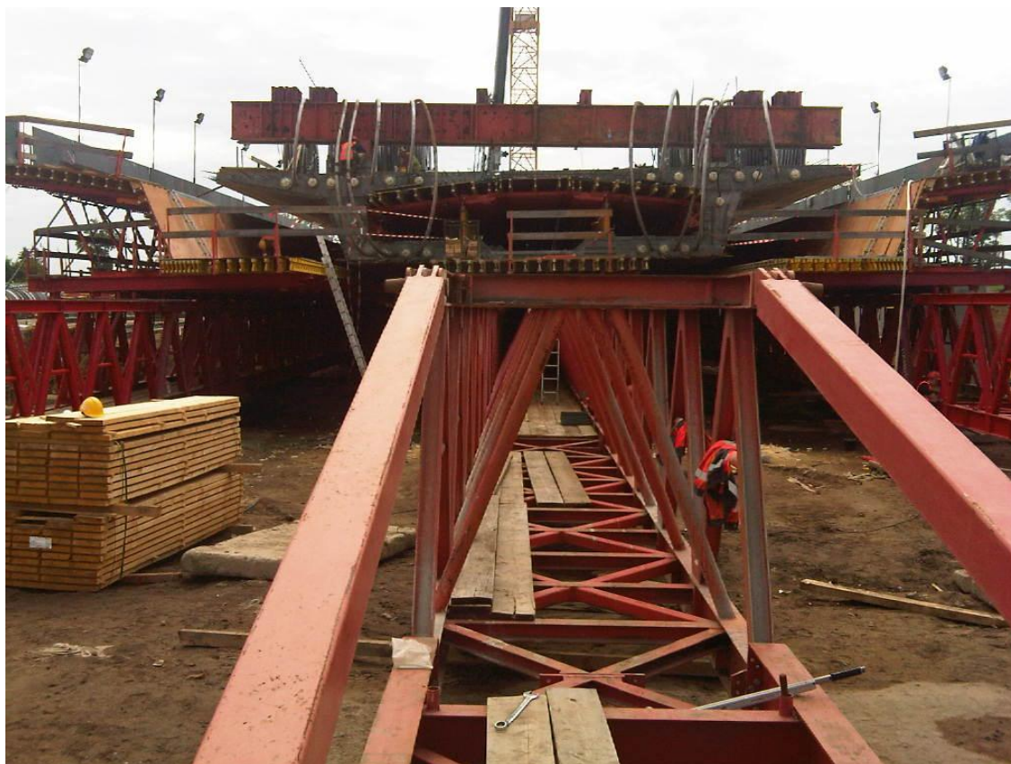
Fot. 17 Widok zabetonowanej skrzynki ustroju nośnego E-221 po rozszalowaniu 28.05.2011
