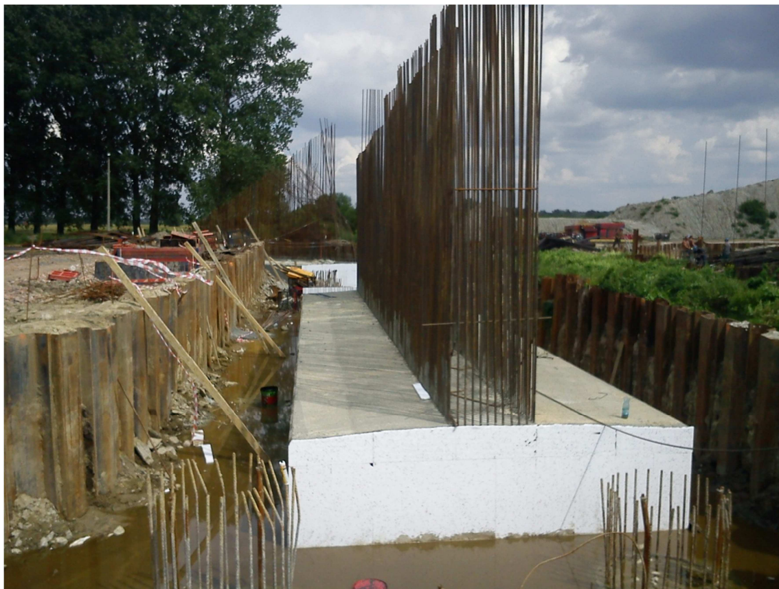
Fot. 19 Zabetonowane fundamenty podpory na moście autostradowym MA-226
