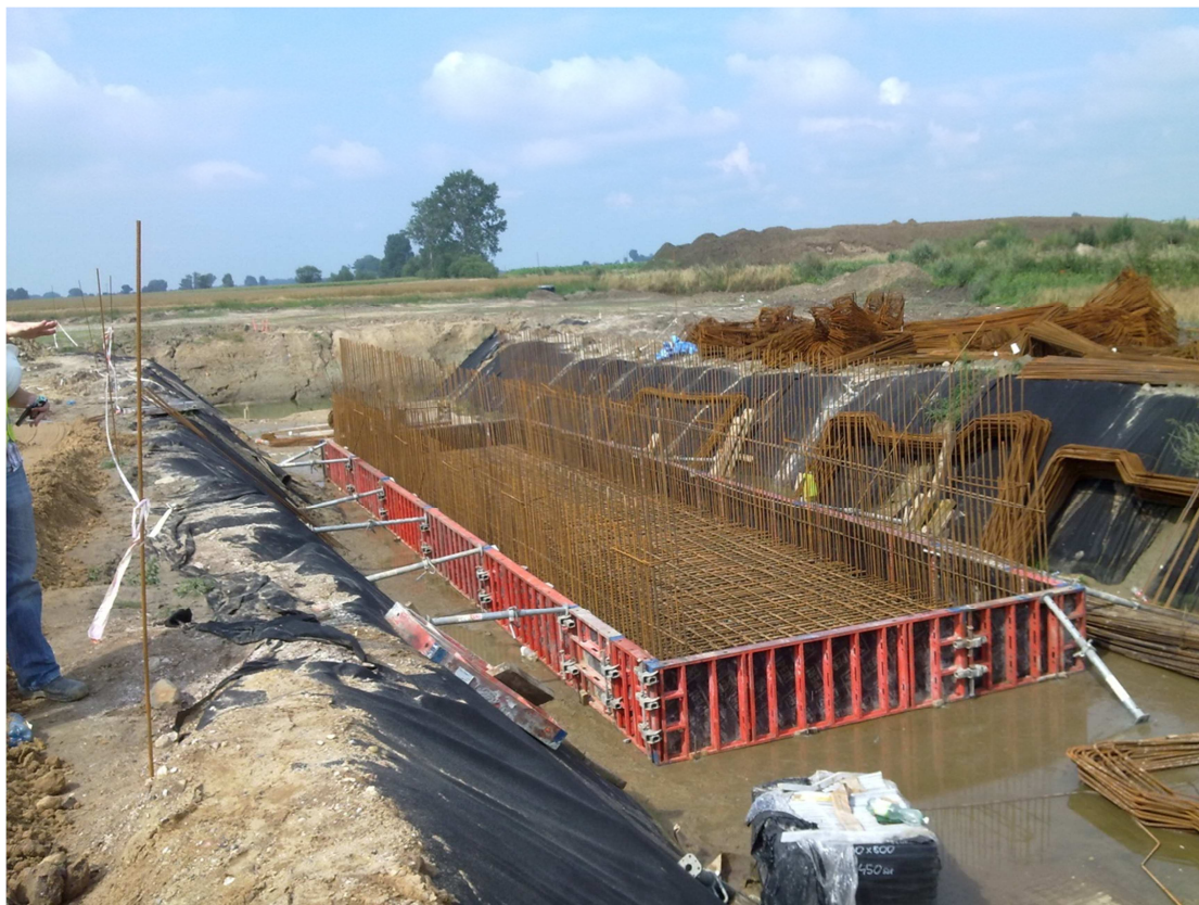
Fot. 11 Przygotowanie do betonowania płyty dennej przepustu P20 26.07.2011
