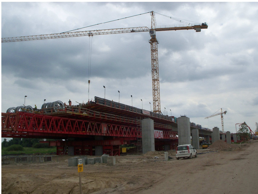
Fot. 2 Widok na Estakadę E-221, nitka lewa na wysokości podpory 3 19.07.2011
