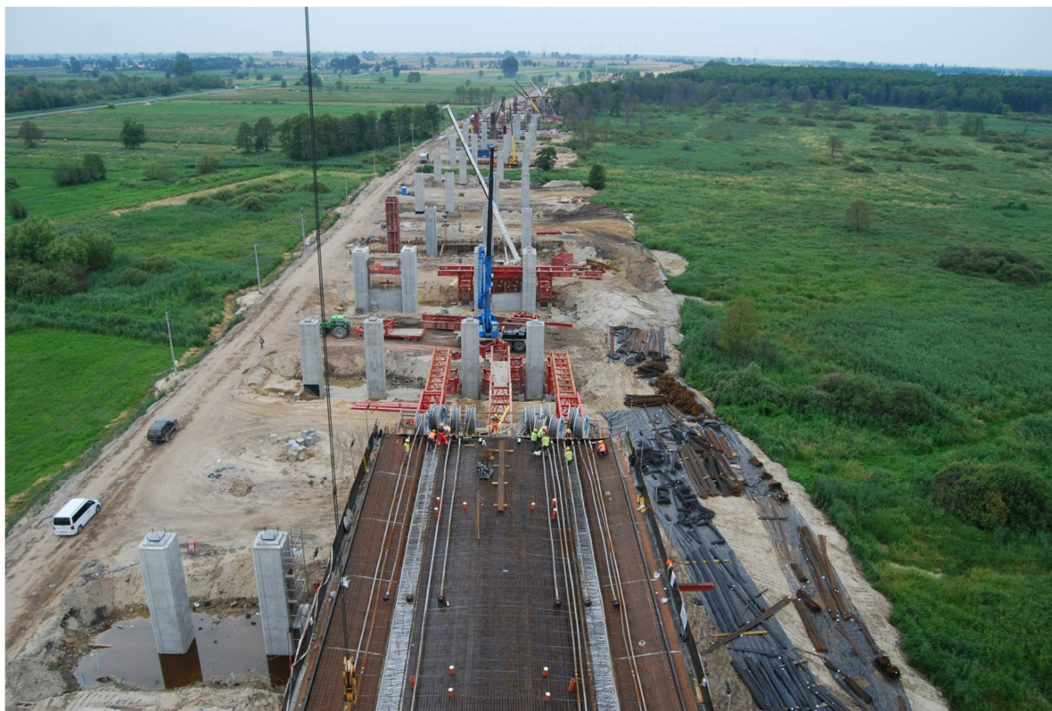
Fot. 6 Widok na estakadę E-221 od strony przyczółka południowego 19.07.2011
