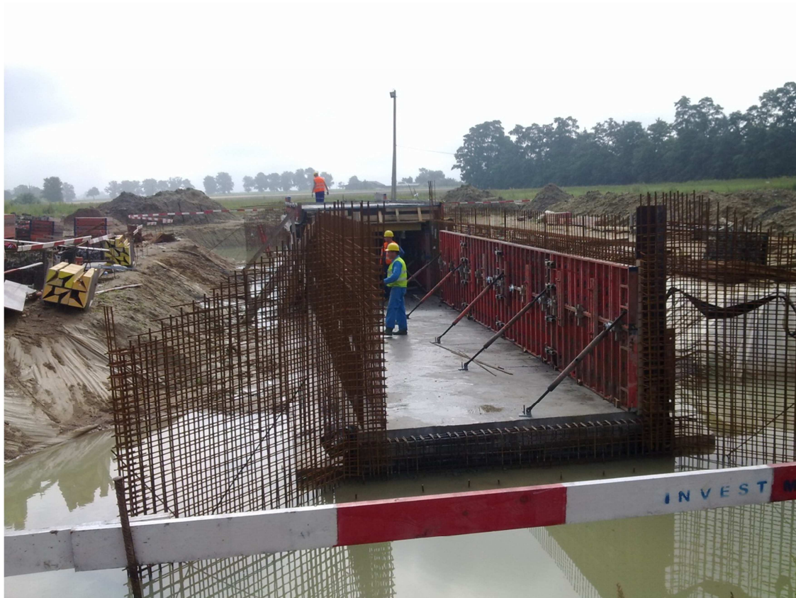
Fot. 13 Szalowanie ścian przepustu P19 26.07.2011
