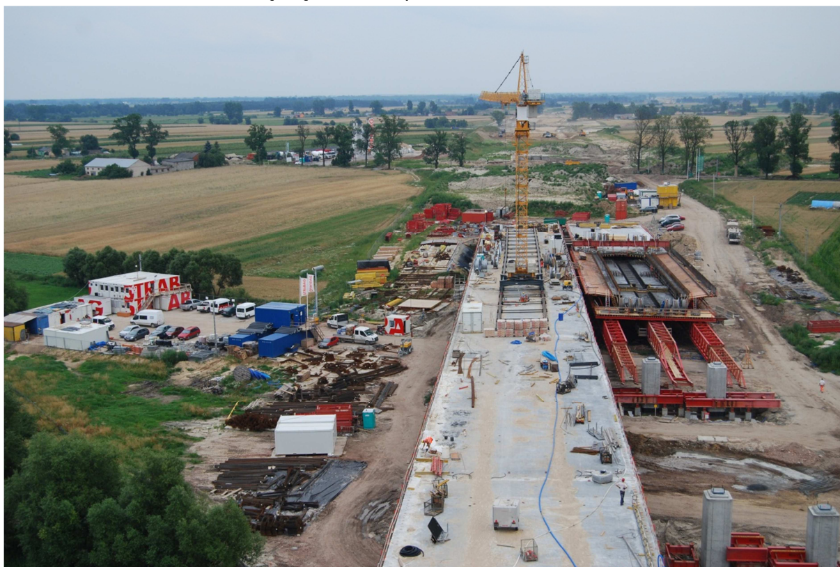
Fot. 7 Widok na zrealizowaną część estakady E-221 19.07.2011
