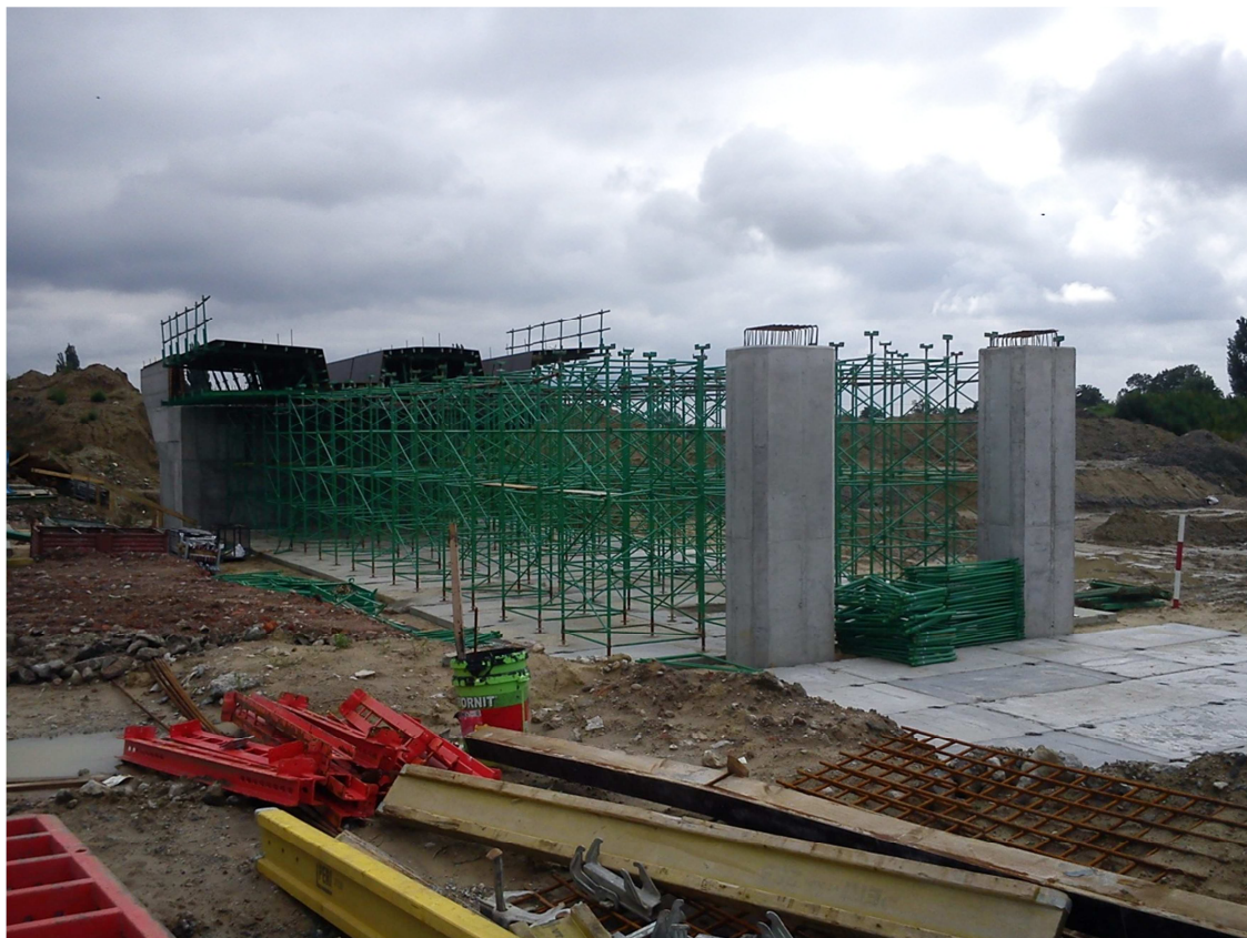
Fot. 14 Ustawianie rusztowania i szalunku na wiadukcie drogowym WD-219 28.07.2011
