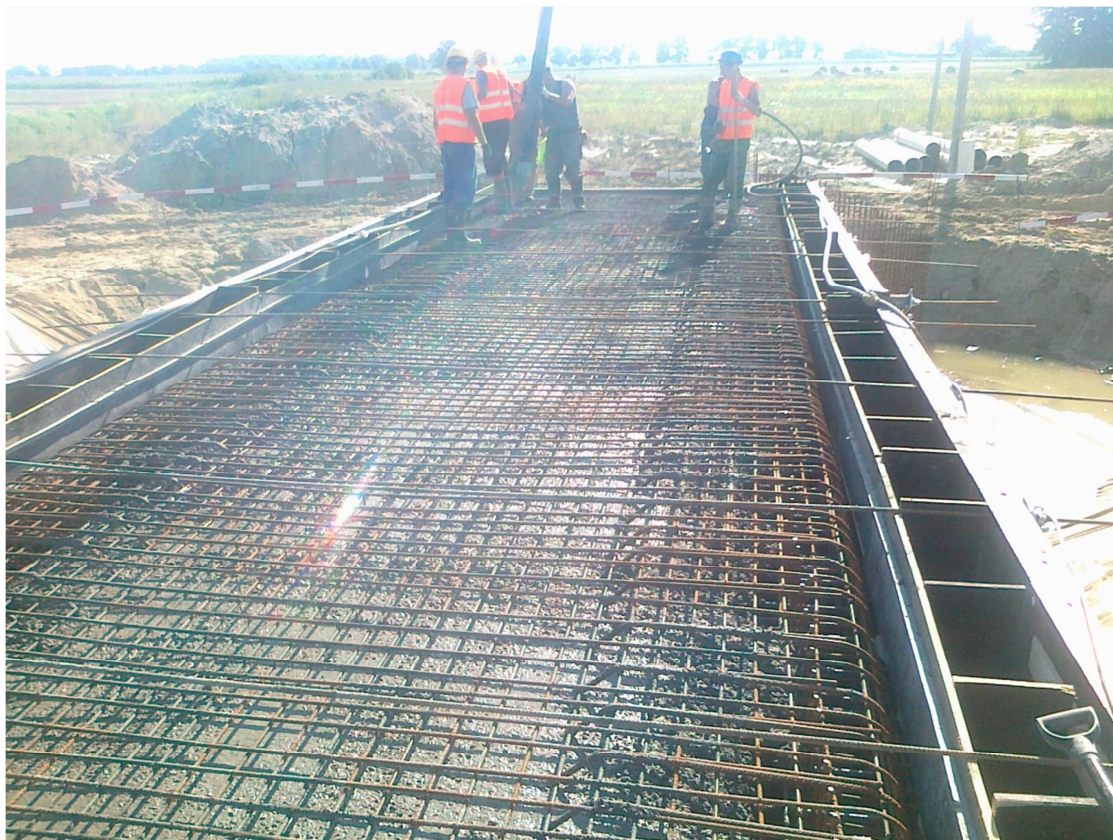
Fot. 20 Przepust P19
