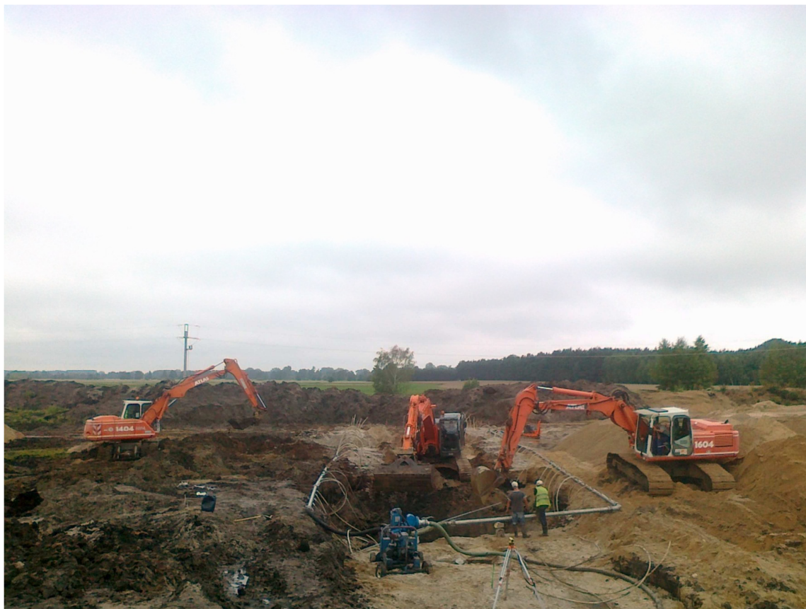
Fot. 17 Wymiana gruntu P22 28.07.2011
