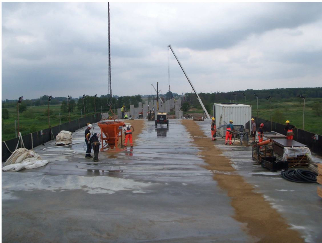
Fot. 9 Takt 7 - nita lewa, E-221, przygotowanie podłoża pod ustawianie szyn dla żurawia przemieszczającego się po ustroju nośnym Estakady 21.07.2011
