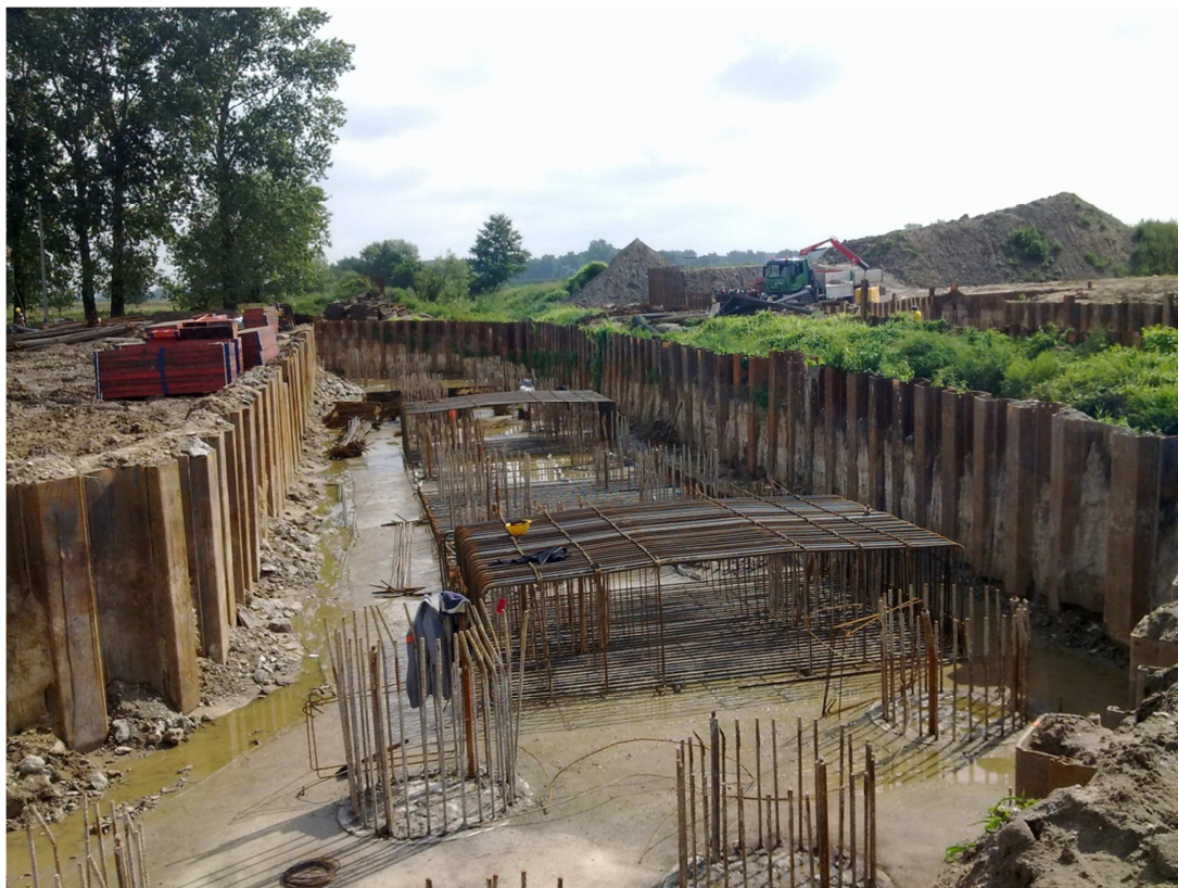
Fot. 10 Zbrojenie fundamentu ramy na obiekcie MA-226 2607.2011
