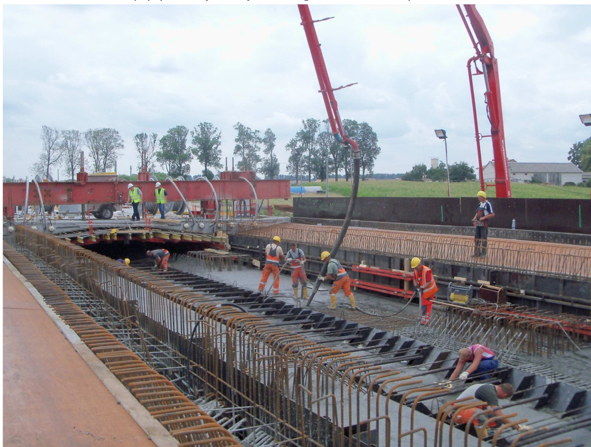
Fot. 3 Betonowanie płyty dolnej ustroju nośnego, takt 2, nitka prawa, E-221 19.07.2011
