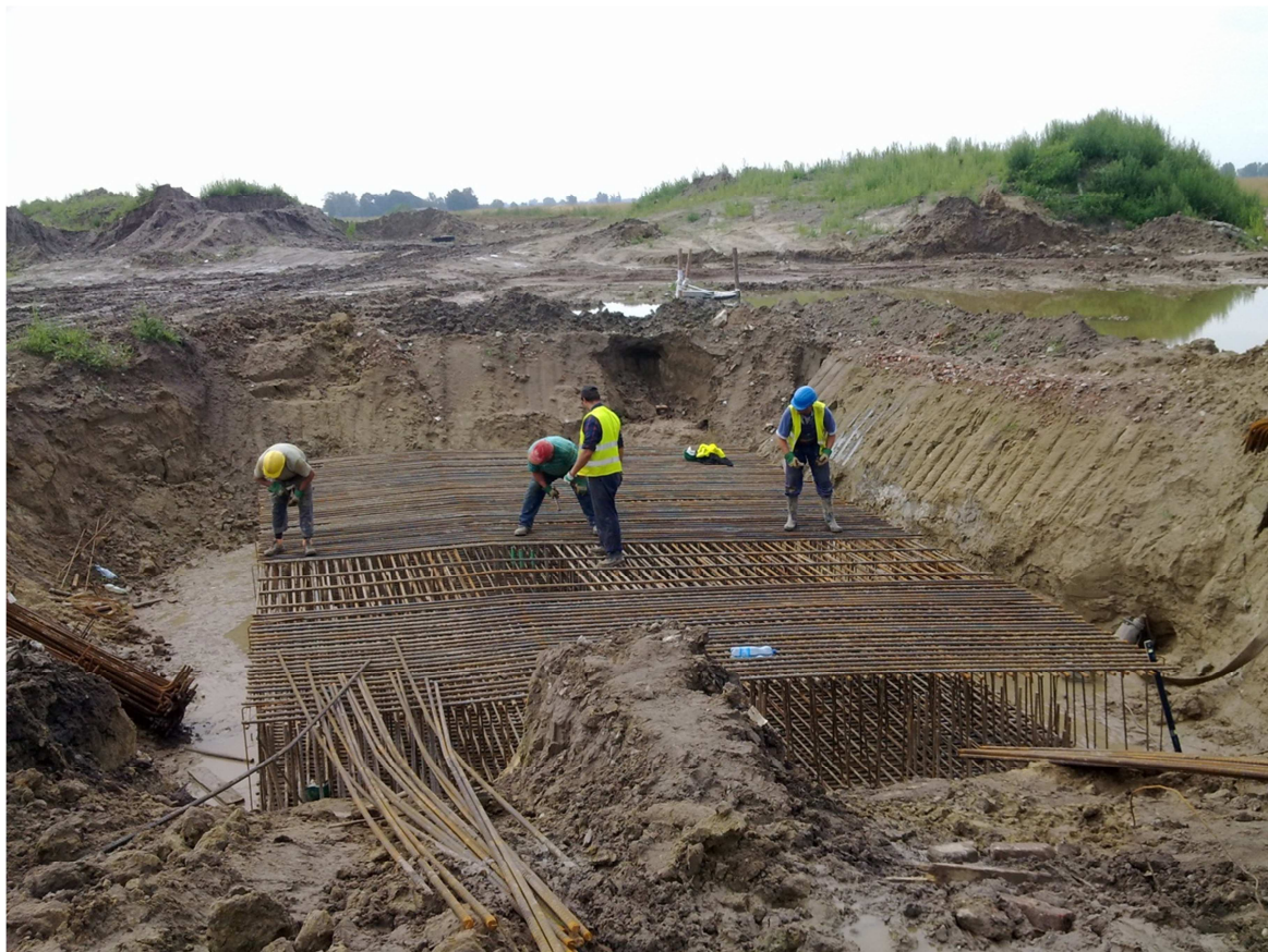
Fot. 12 Zbrojenie fundamentu podpory 3 na wiadukcie WD-224 26.07.2011
