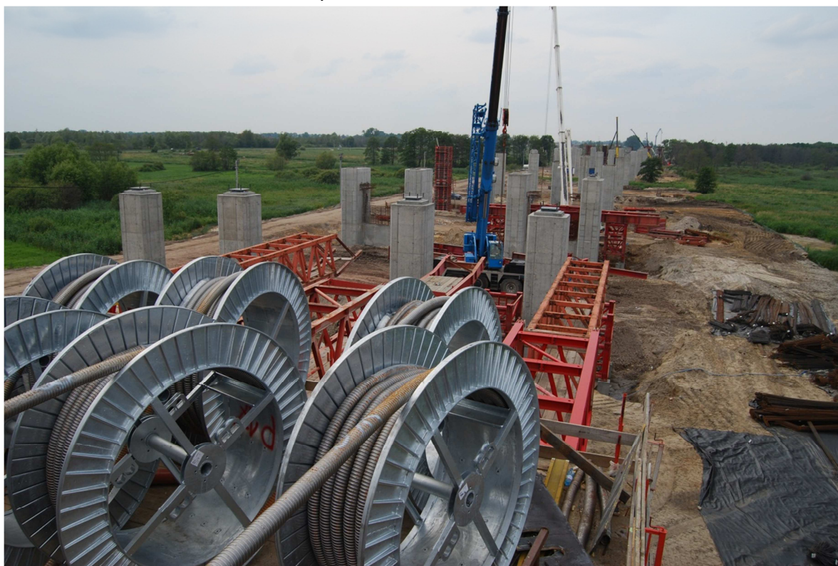
Fot. 5 Widok na zrealizowane filary na estakadzie E-221 19.07.2011
