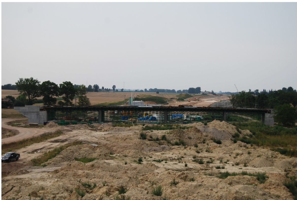
Fot. 8 Wiadukt drogowy WD-220 19.07.2011
