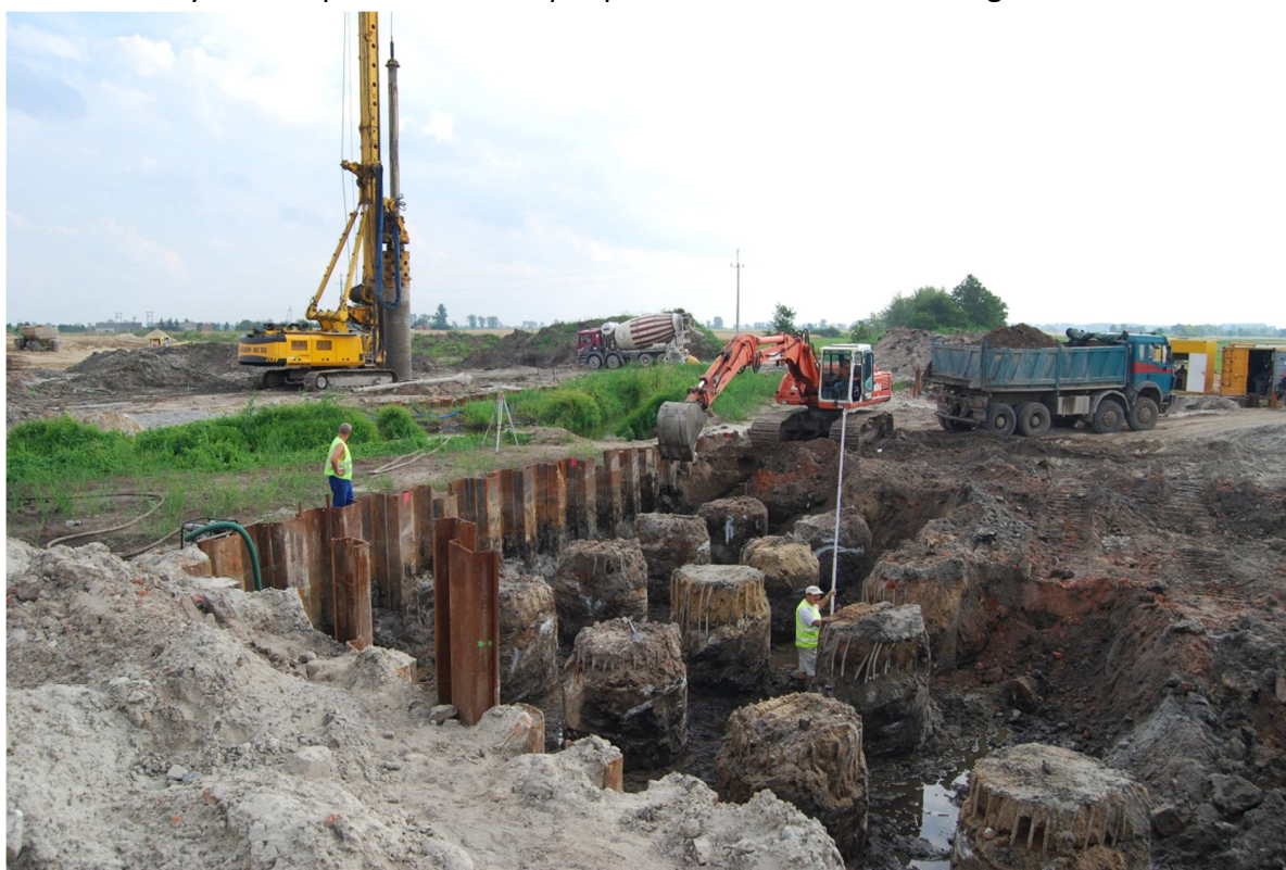
Fot. 4 Roboty ziemne prowadzone na podporze mostu autostradowego MA-228 19.07.2011
