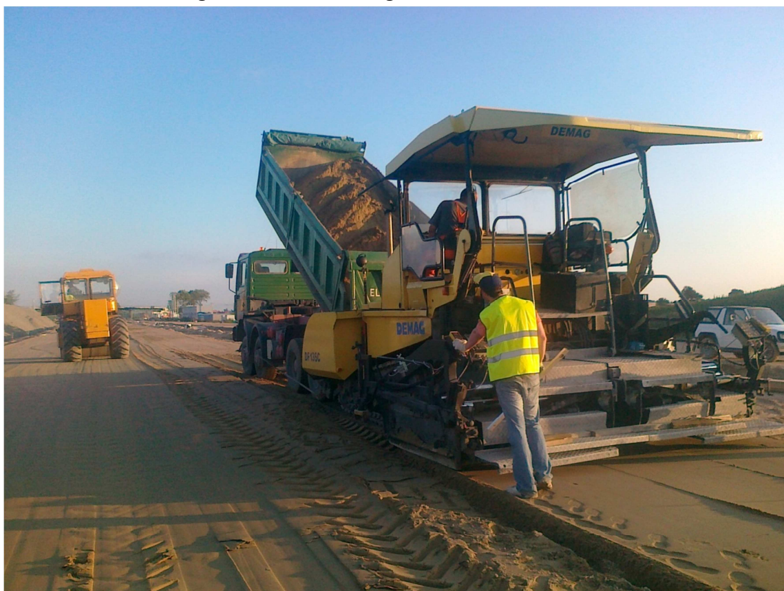
Fot. 18 Podbudowa z gruntu stabilizowanego 262+400 29.07.2011
