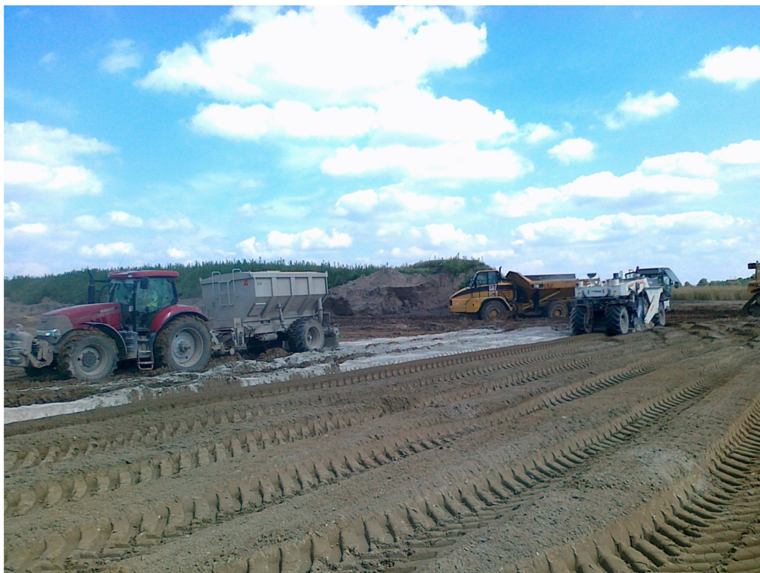
Fot. 16 Stabilizacja gruntu 265+700 13.07.2011
