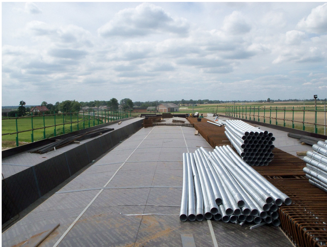
Fot. 1 Zbrojenie ustroju nośnego Wiaduktu WD-220 19.07.2011
