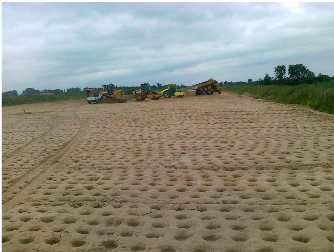
Fot. 15 Budowa nasypu w3 267+500 01.07.2011
