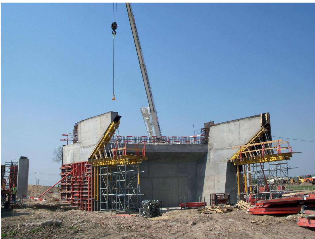
Fot. 8 Przycółek obiektu WD-220 w trakcie rozszalowywania 27.04.2011
