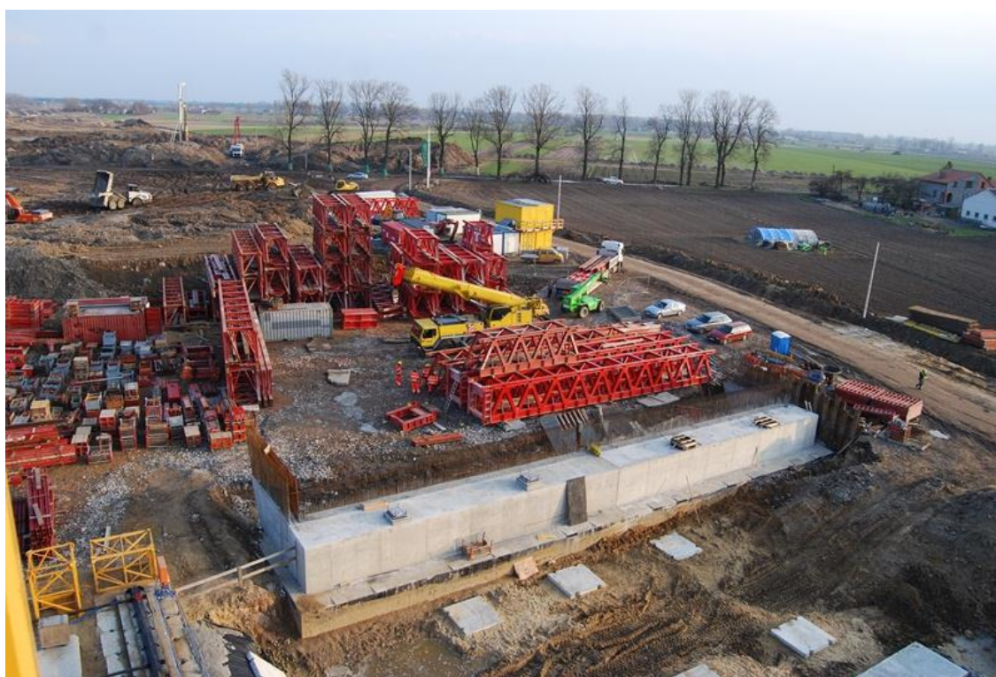
Fot. 20 Widok zabetonowanego korpusu przyczółka na Estakadzie E-221 06.04.2011
