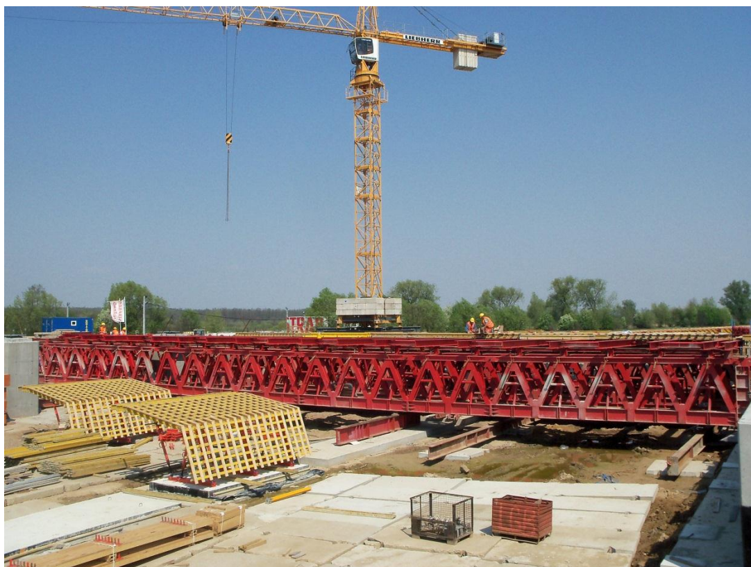
Fot. 12 Rusztowanie przesuwne do realizacji ustroju nośnego na Estakadzie E-221 27.04.2011
