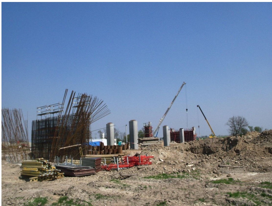
Fot. 10 Widok placu budowy na wiadukcie WD-220 27.04.2011
