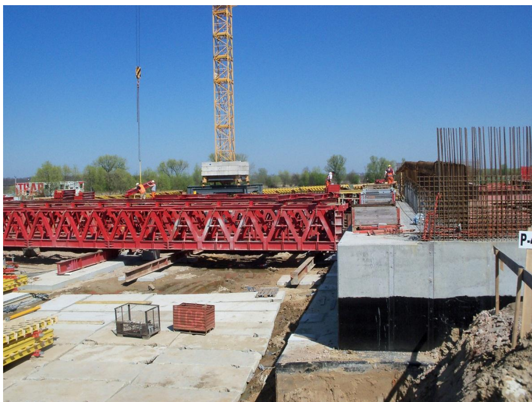
Fot. 6 Postęp robót związanych z budową ustroju nośnego na Estakadzie E-221 20.04.2011
