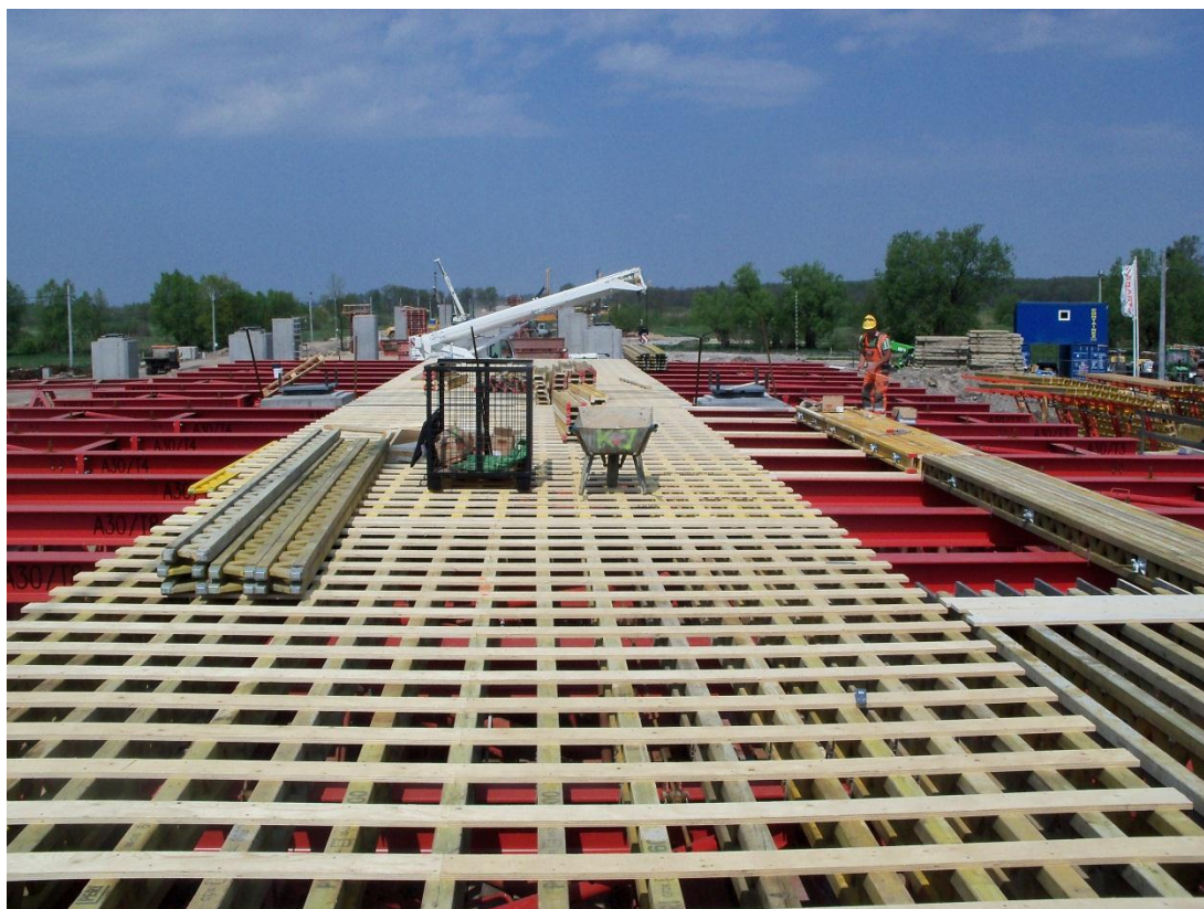
Fot. 13 Prace związane z realizacją szalunku dla skrzynki ustroju noszącej Estakady E-221 30.04.2011
