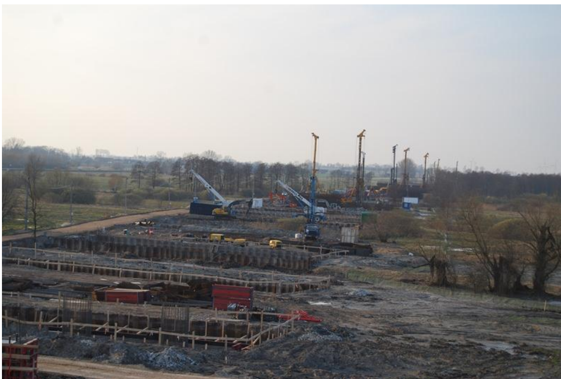
Fot. 18 Budowa Estakady E-221 06.04.2011
