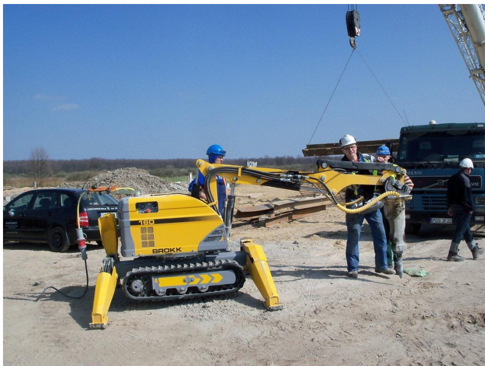
Fot. 3 Specjalistyczny sprzęt do skuwania głowic pali 18.04.2011
