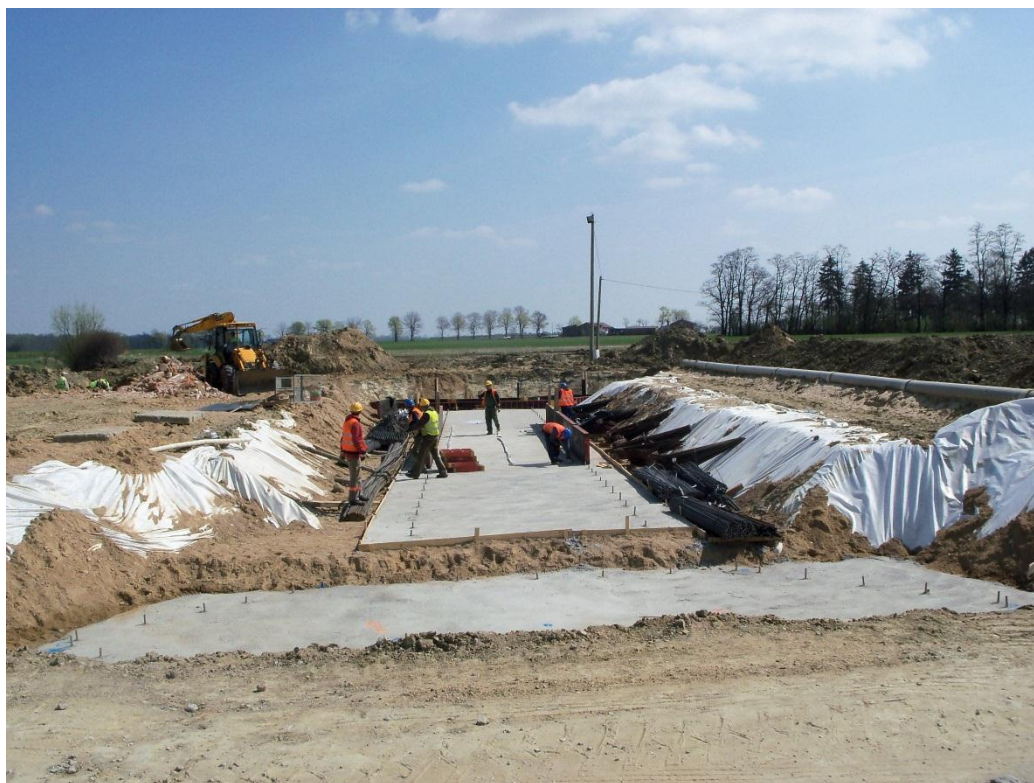
Fot. 5 Prace przygotowawcze pod zbrojenie przepustu P-19 18.04.2011
