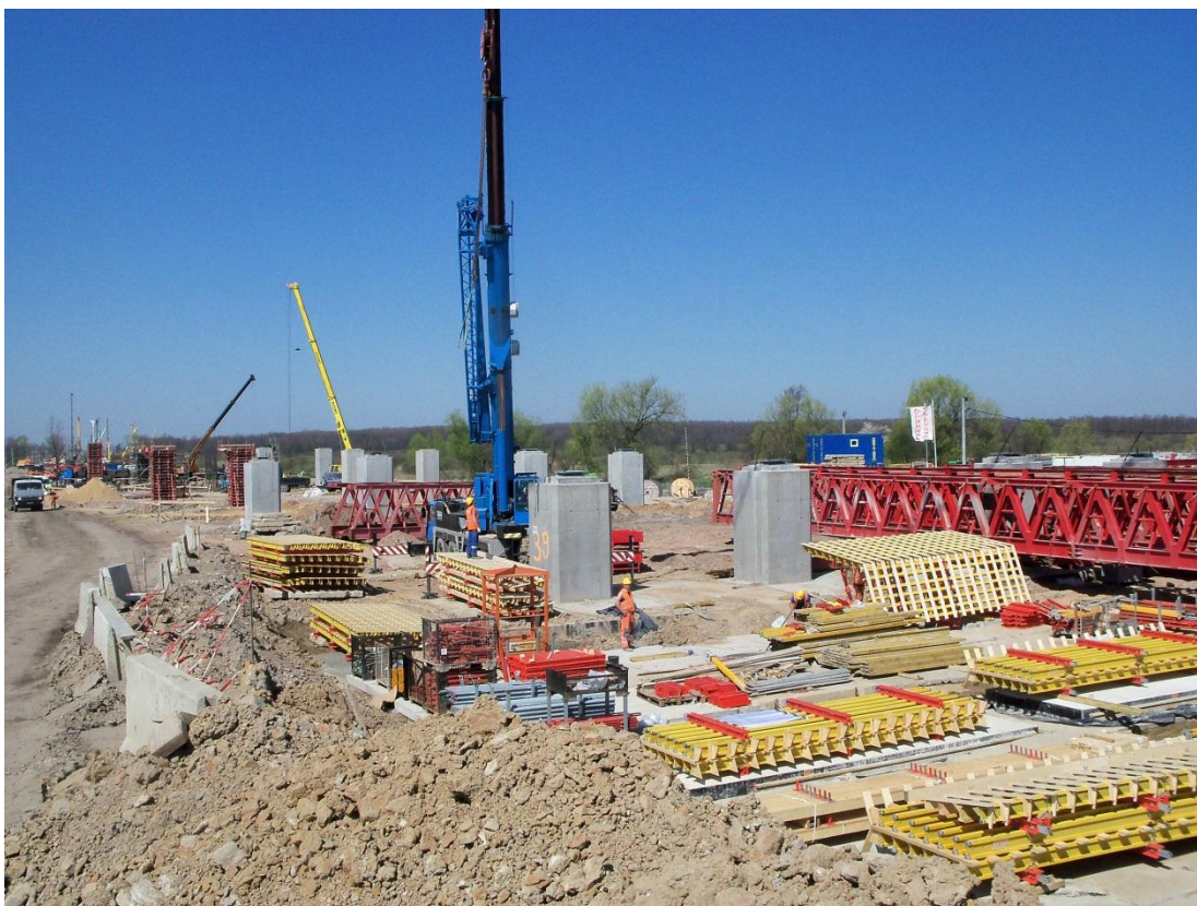
Fot. 7 Widok postępujących robót na Estakadzie E-221 20.04.2011
