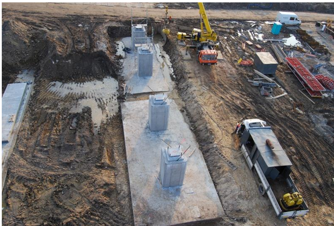
Fot. 19 Widok zabetonowanych filarów podpory 39 na Estakadzie E-221 06.04.2011
