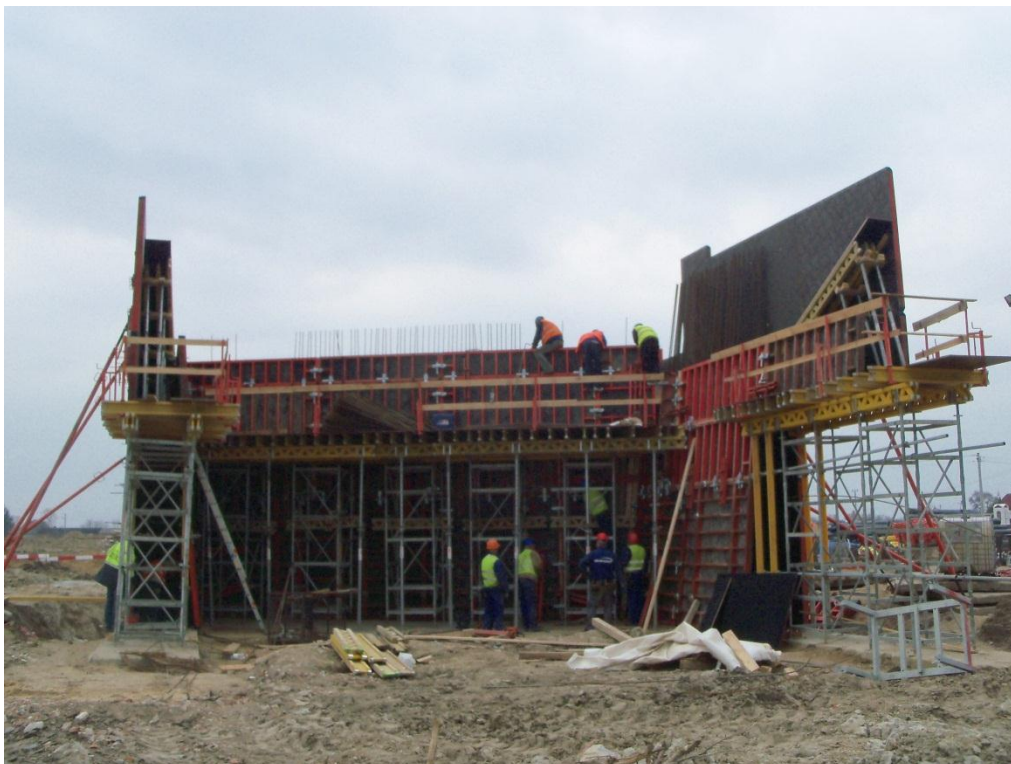
Fot. 2 Szalowanie przyczółka na obiekcie WD-220 12.04.2011
