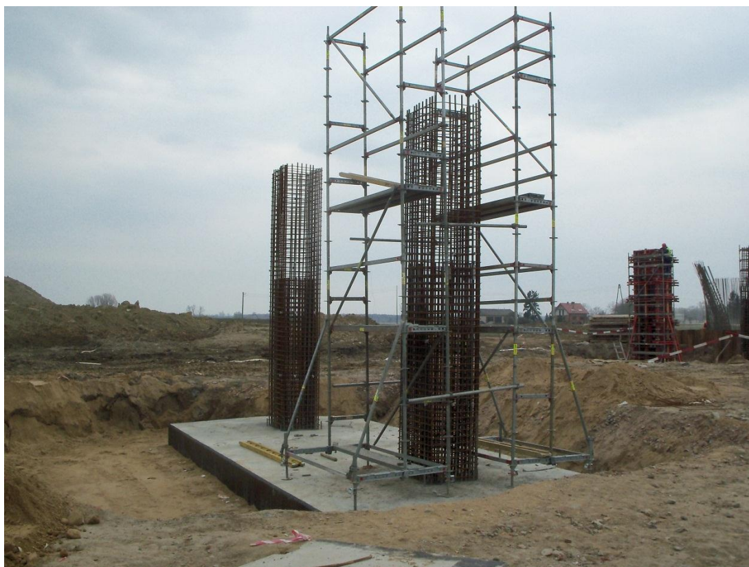
Fot. 14 Zbrojenie filarów WD-220 12.04.2011
