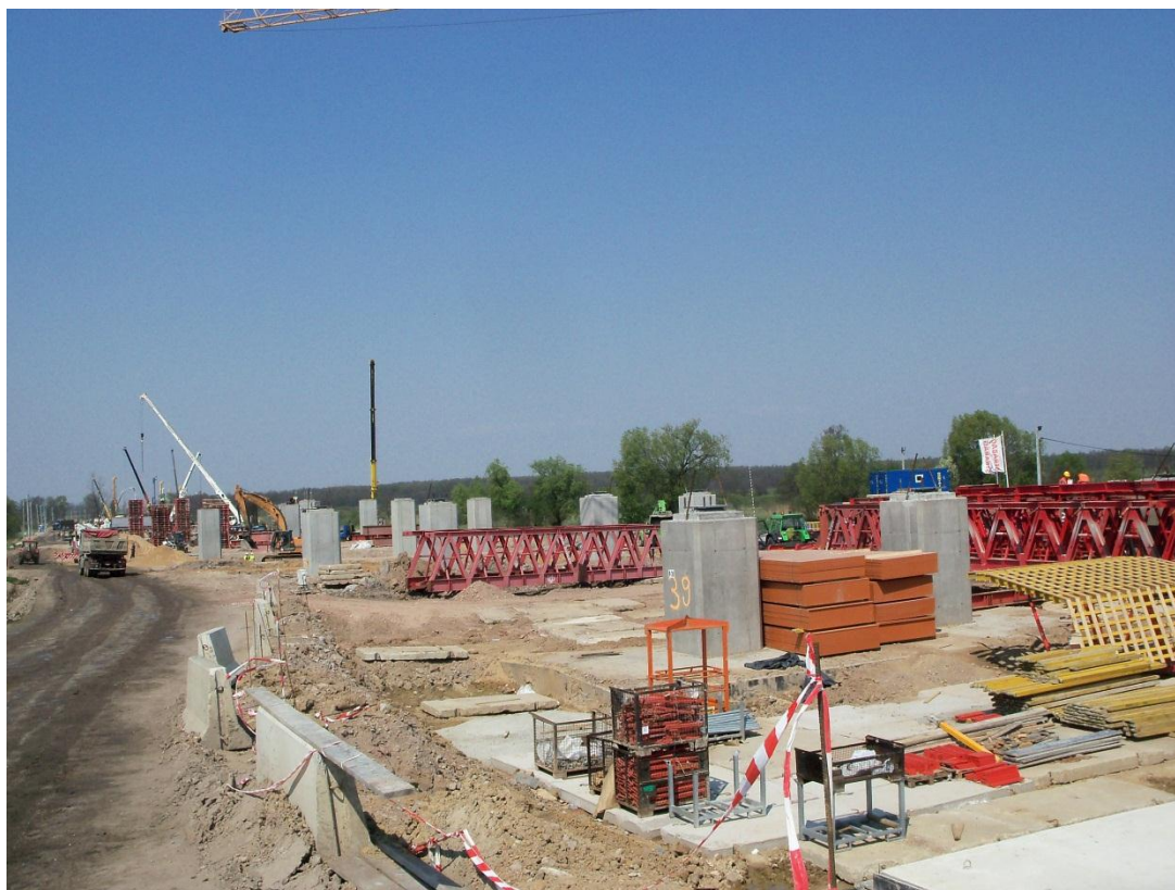
Fot. 11 Widok budowy Estakady E-221 od strony przyczółka południowego 27.04.2011
