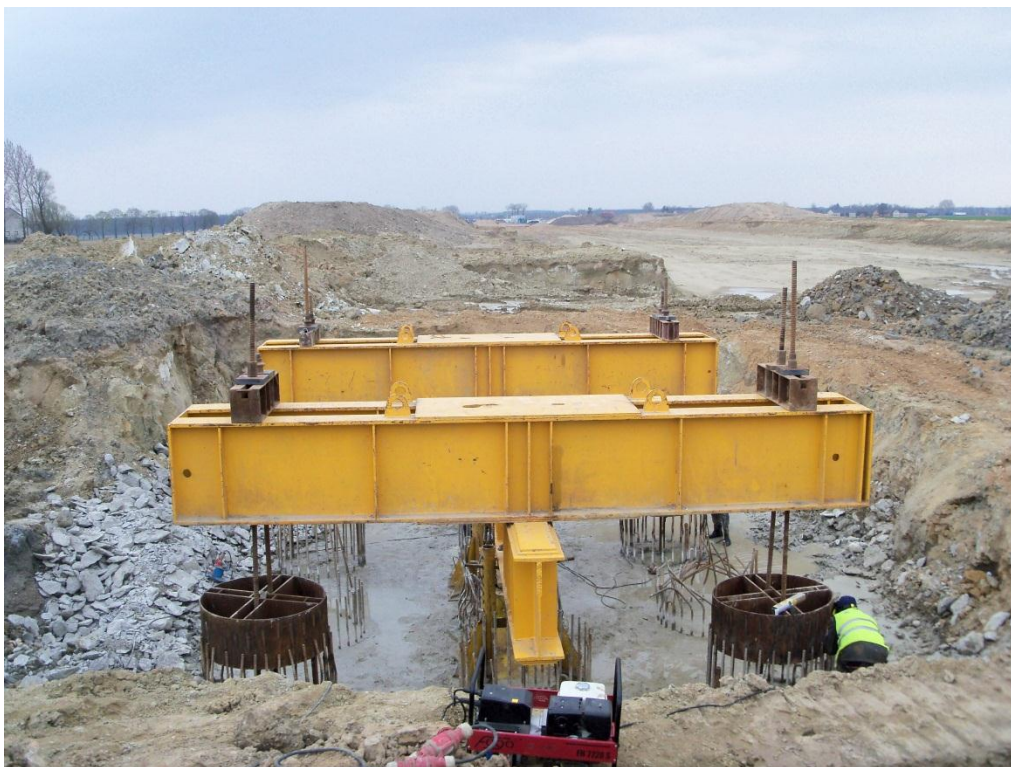
Fot. 1 Obciążenie próbne pala wielkośrednicowego metodą statyczną na obiekcie WD-219 12.04.2011
