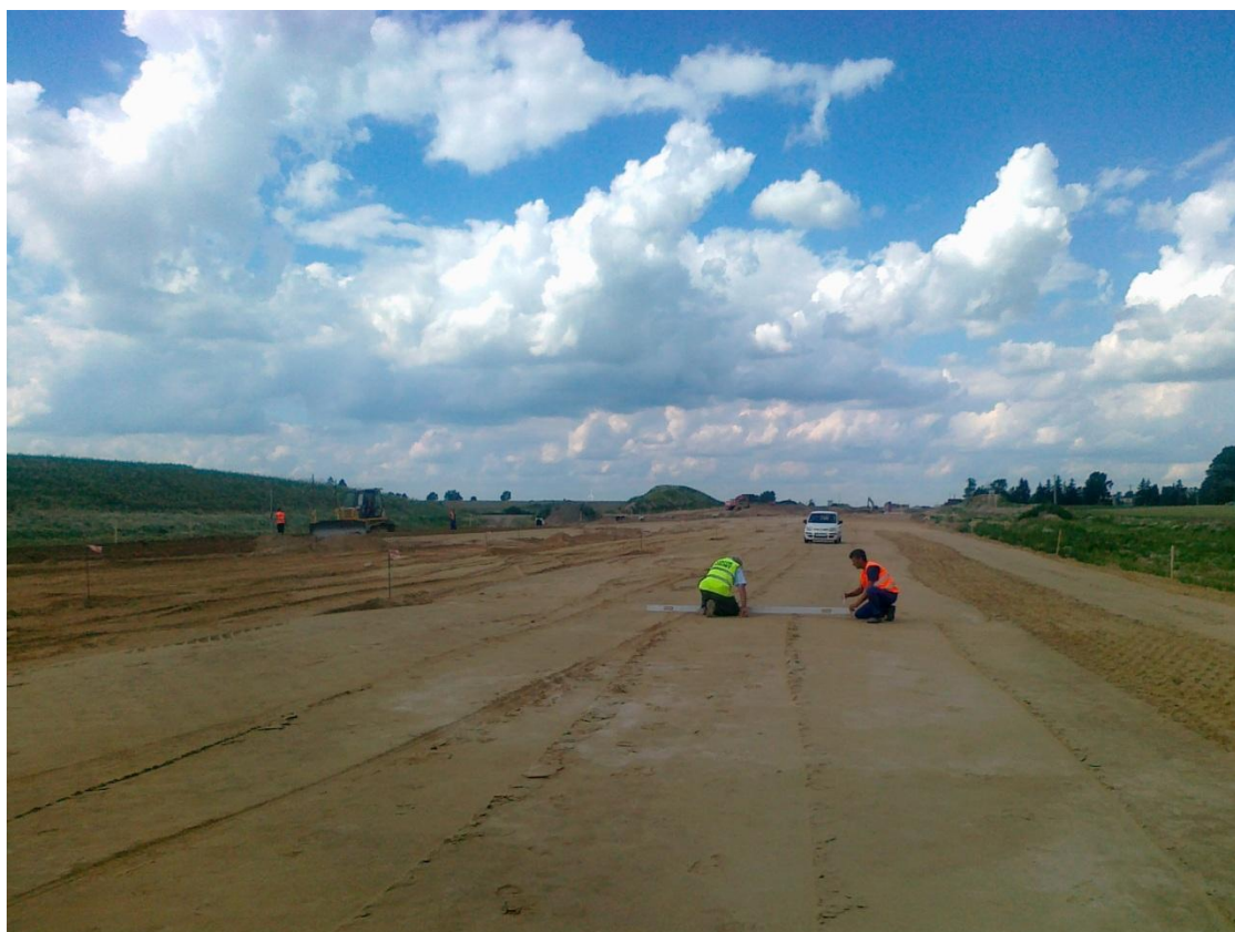
Fot. 18 Pomiary równości warswy nasypu 262+00 20.06.2011
