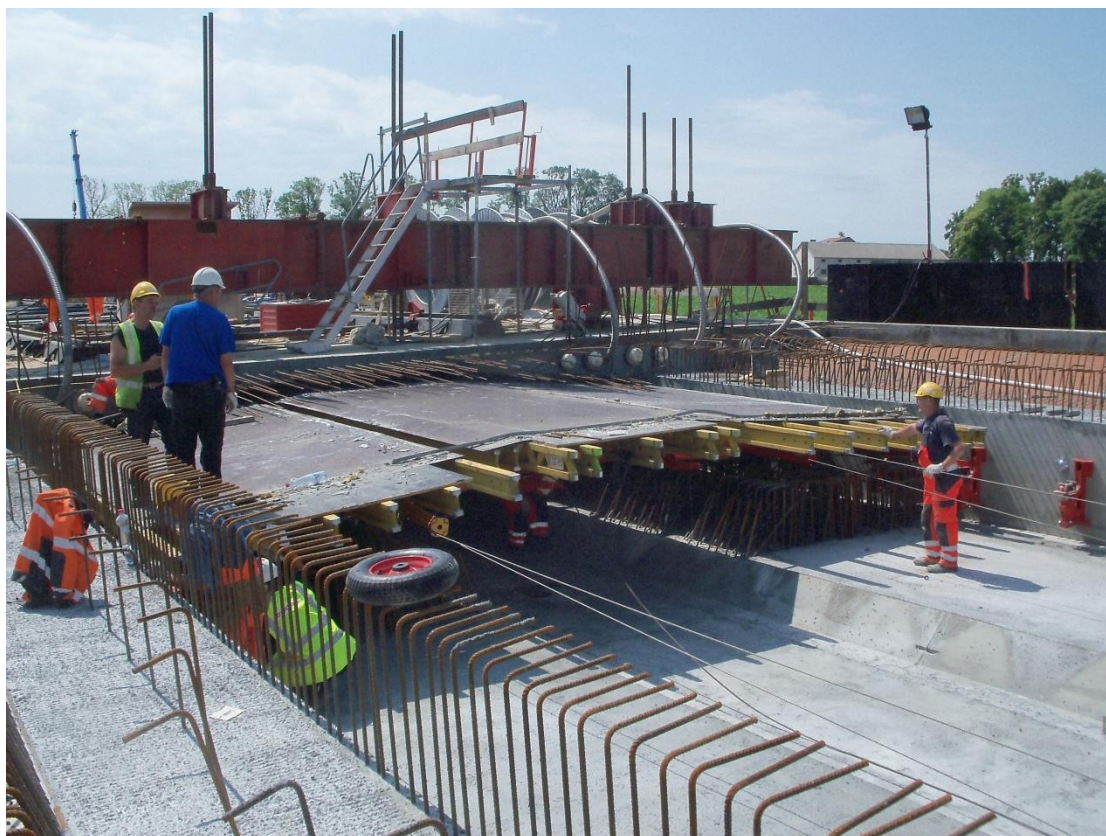
Fot. 6 Przesuwanie deskowania pod górną część skrzynki ustroju nośnego na E-221 15.06.2011
