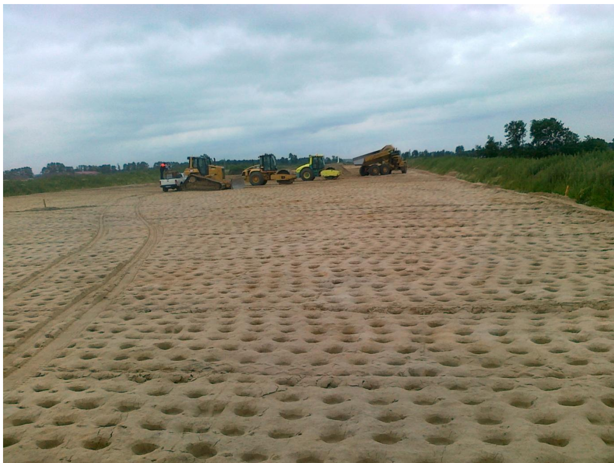
Fot. 21 Wykonywanie nasypów 267+500 28.06.2011
