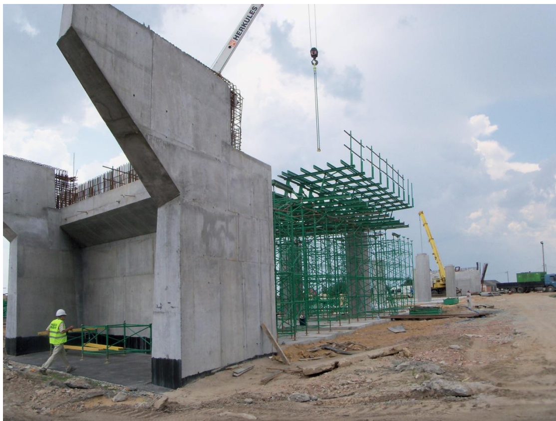
Fot. 13 Montaż rusztowania pod ustrój nośny na Wiadukcie Drogowym WD-220 21.06.2011
