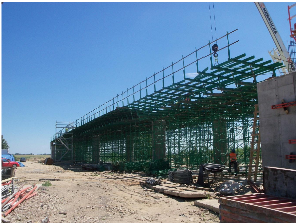
Fot. 12 Rusztowanie pod ustój nośny na wiadukcie WD-220 28.06.2011
