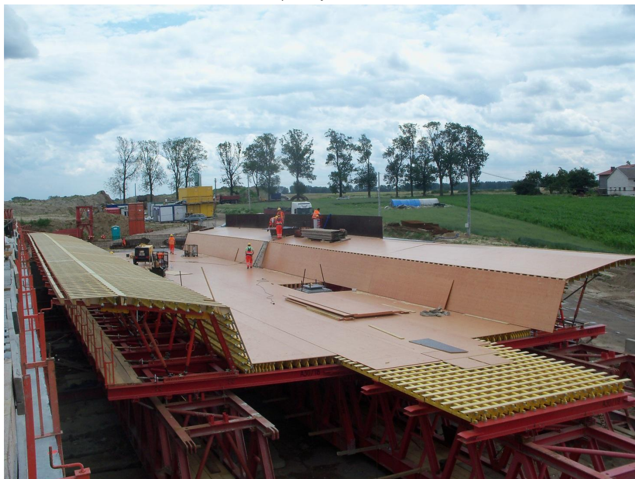
Fot. 8 Układanie szalunku na 1 takcie nitki prawej na Estakadzie E-221 21.06.2011
