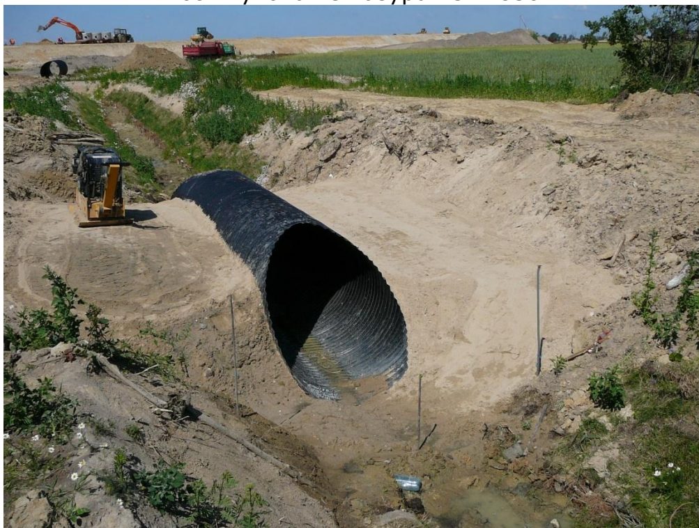
Fot. Montaż przepustu km 247
