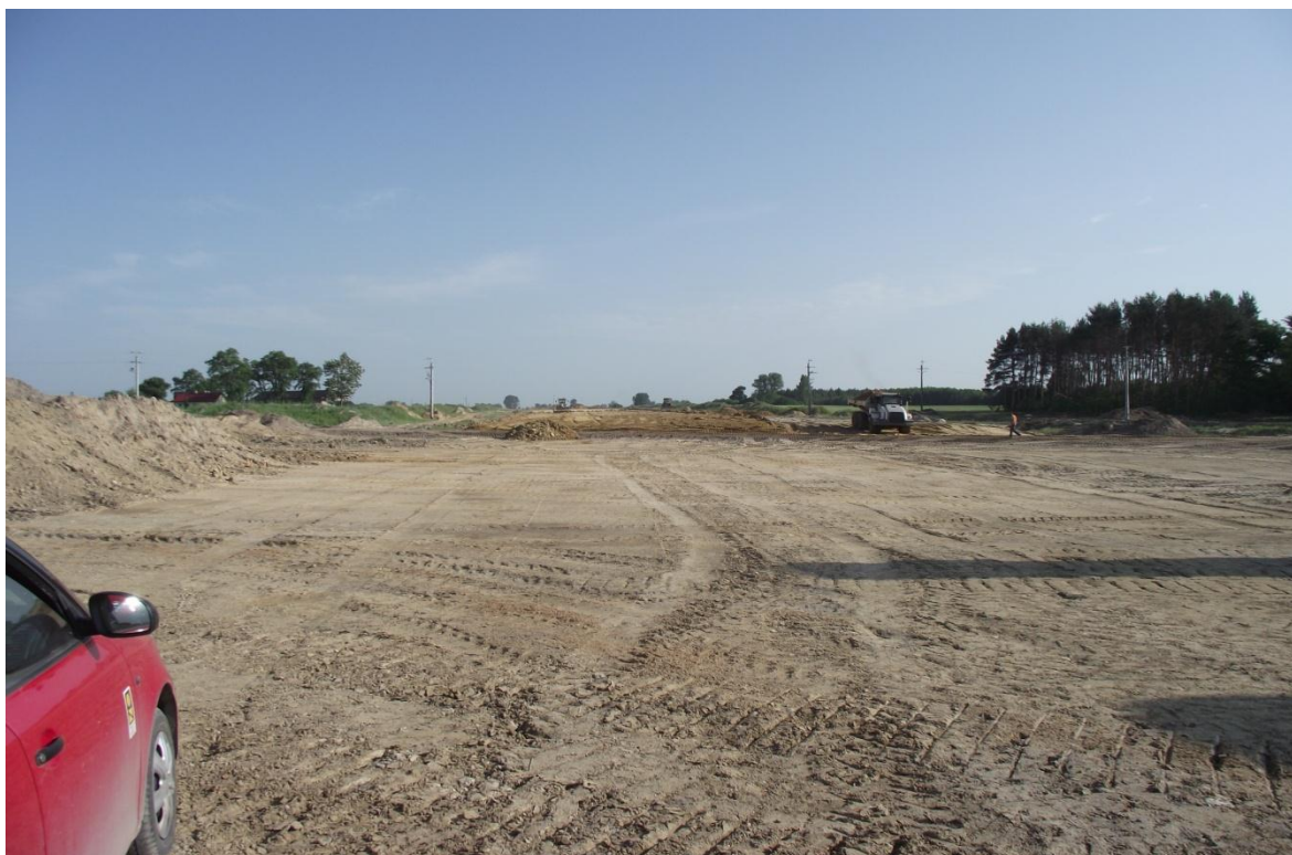
Fot. Powierzchniowa wymiana gruntu
