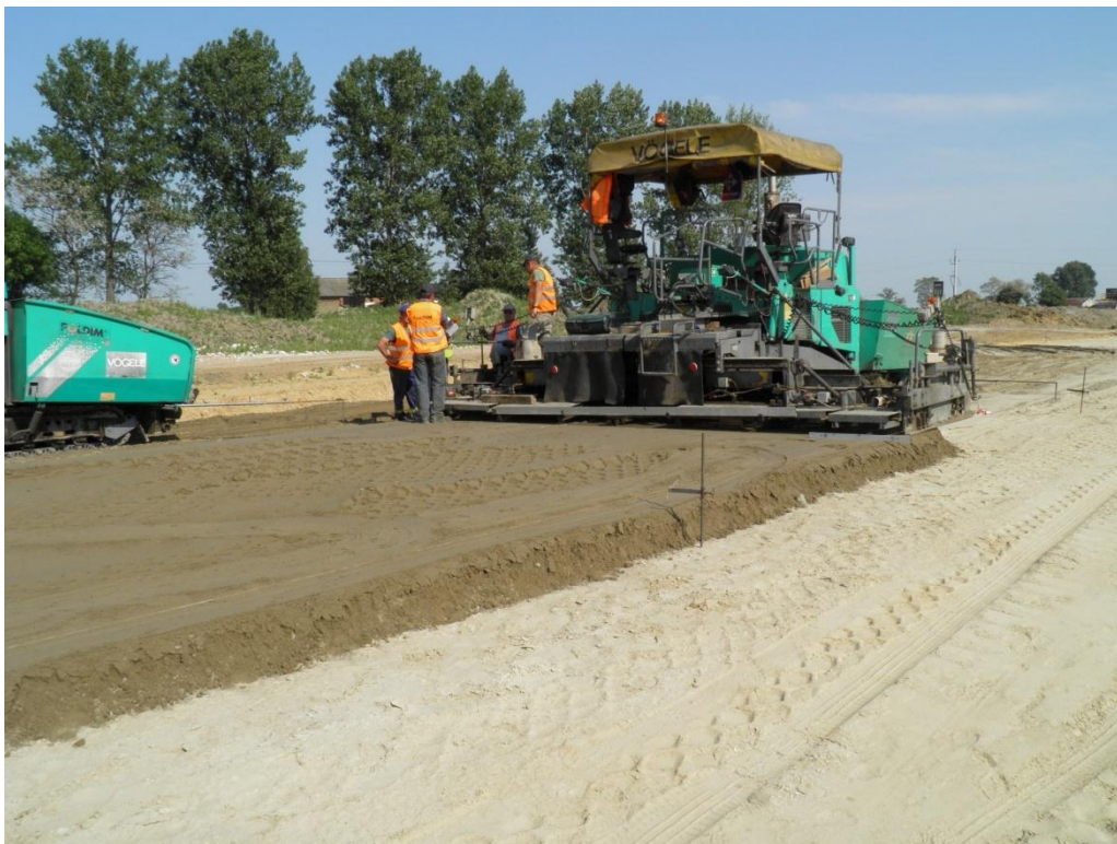
Fot. Wykonywanie stabilizacji R_m=5,0\text{Mpa}
