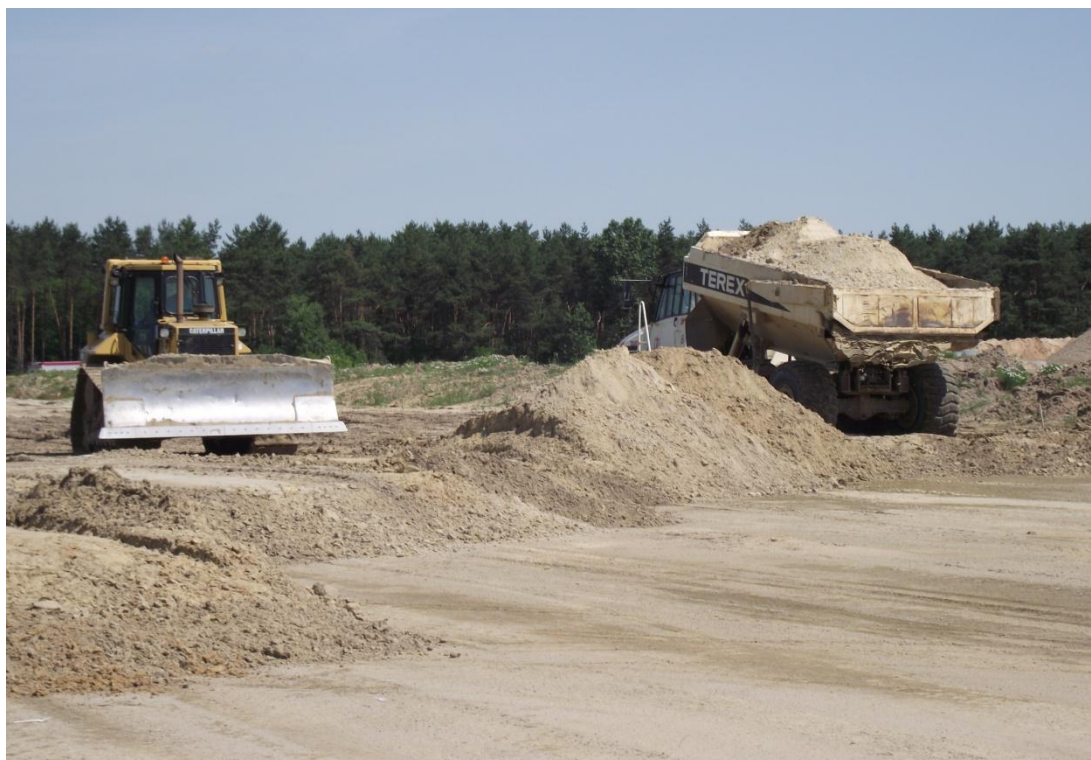
Fot. Wykonanie nasypu 257+850
