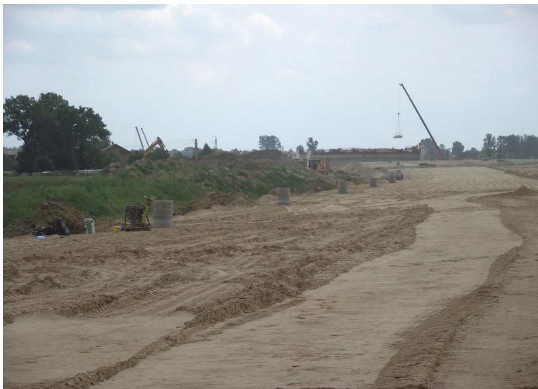
Fot. Montaż wpustów i przykanalików w km 250
