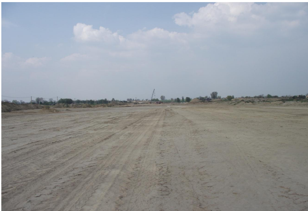
Fot. Wykonanie nasypu w km 257+400
