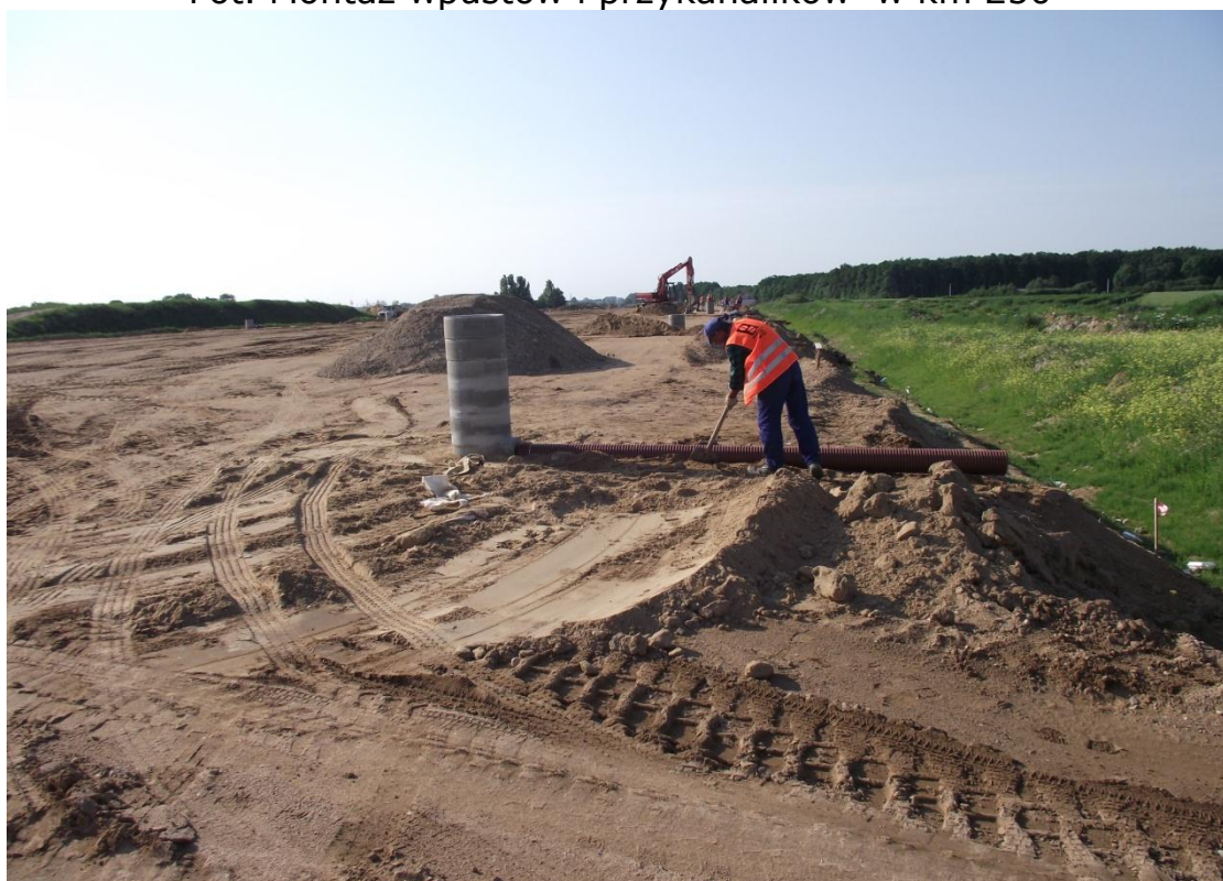
Fot. Montaż wpustów i przykanalików w km 248
