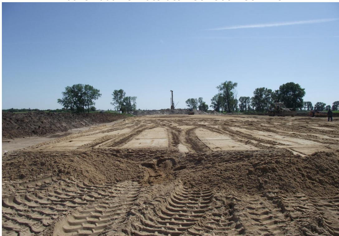
Fot. Wykonanie nasypu nad Ochnią w km 259+400
