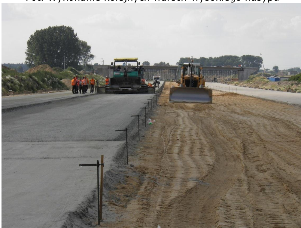
Fot. Warstwa podbudowy z kruszywa łamanego 0/31,5 stabilizowanego mechanicznie gr. 22 cm
