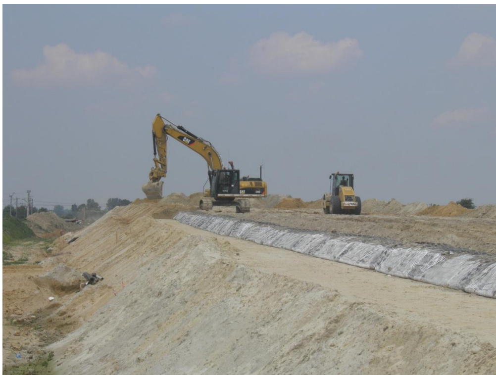
Fot. Wykonanie kolejnych warstw wysokiego nasypu
