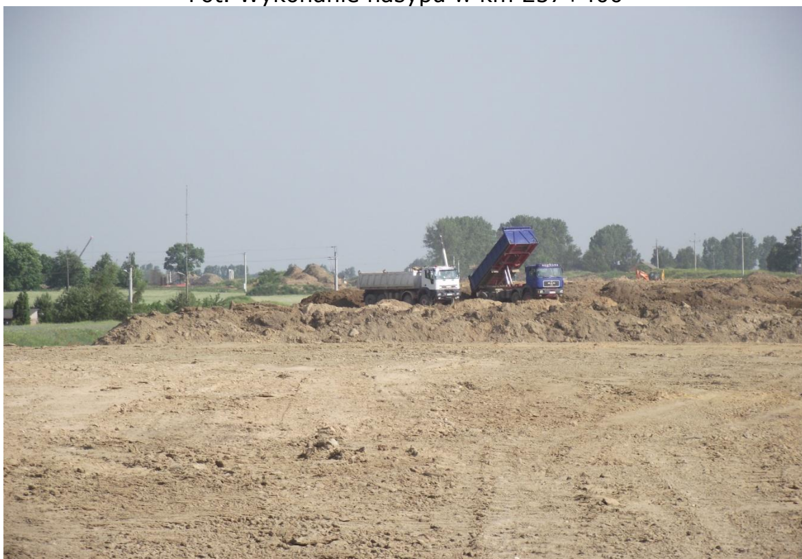
Fot. Nasyp przeciążający w km 256+600-256+750
