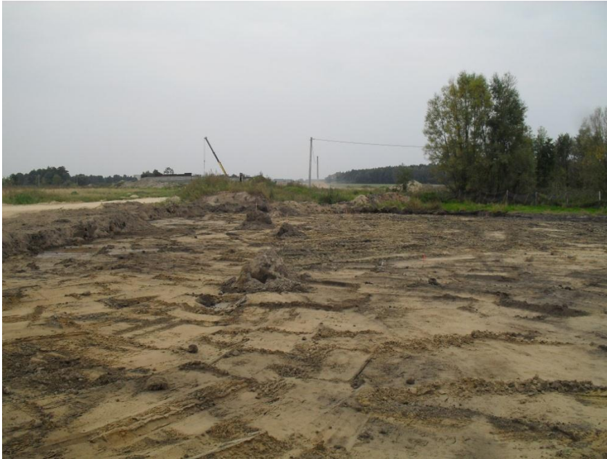
Fot1. Postępuje odhumusowanie w dolinie rzeki Maliny.
