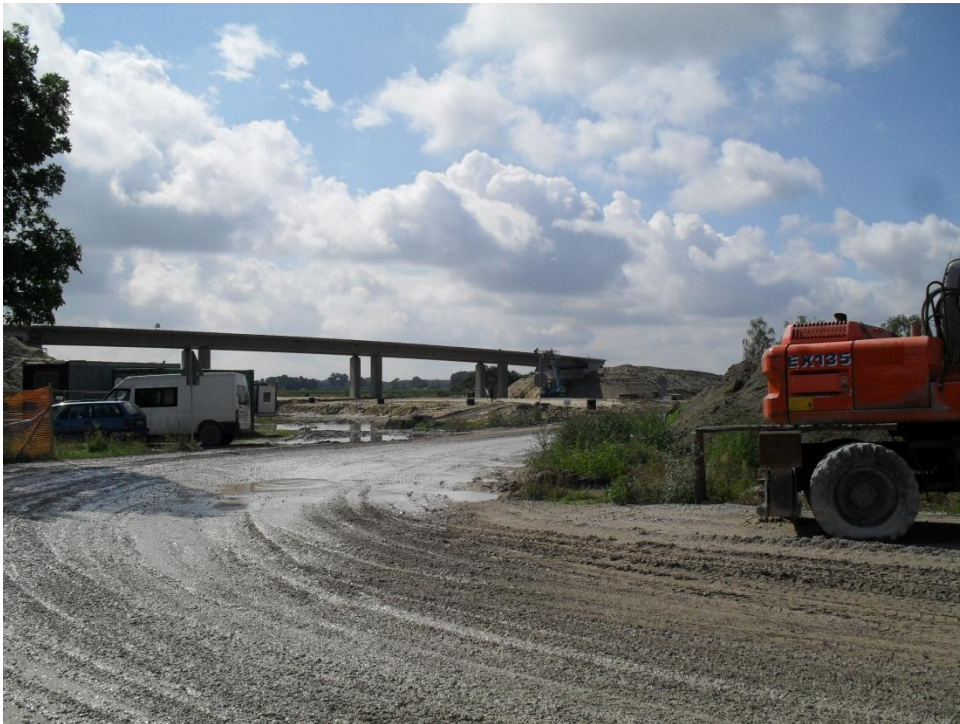
Fot2. Droga serwisowa zwilżona i zabezpieczona przed pyleniem km285+700.
