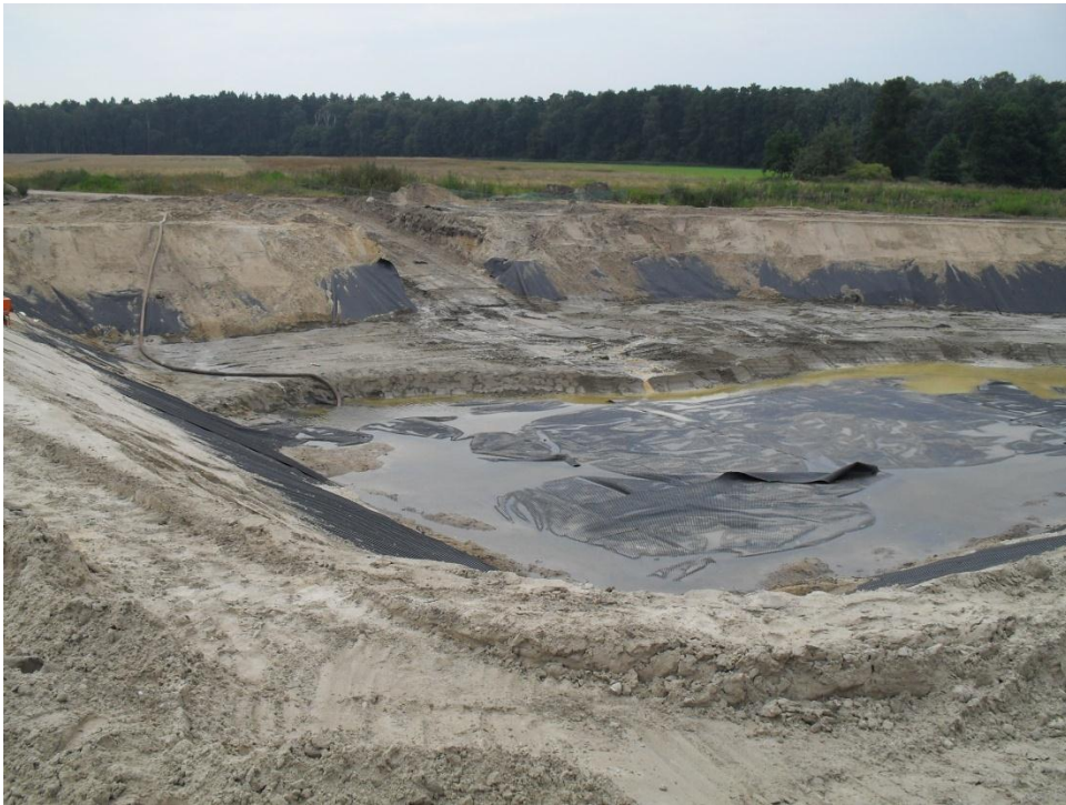
Fot1. Budowa zbiornika Ekologicznego w okolicach rzeki Maliny.
