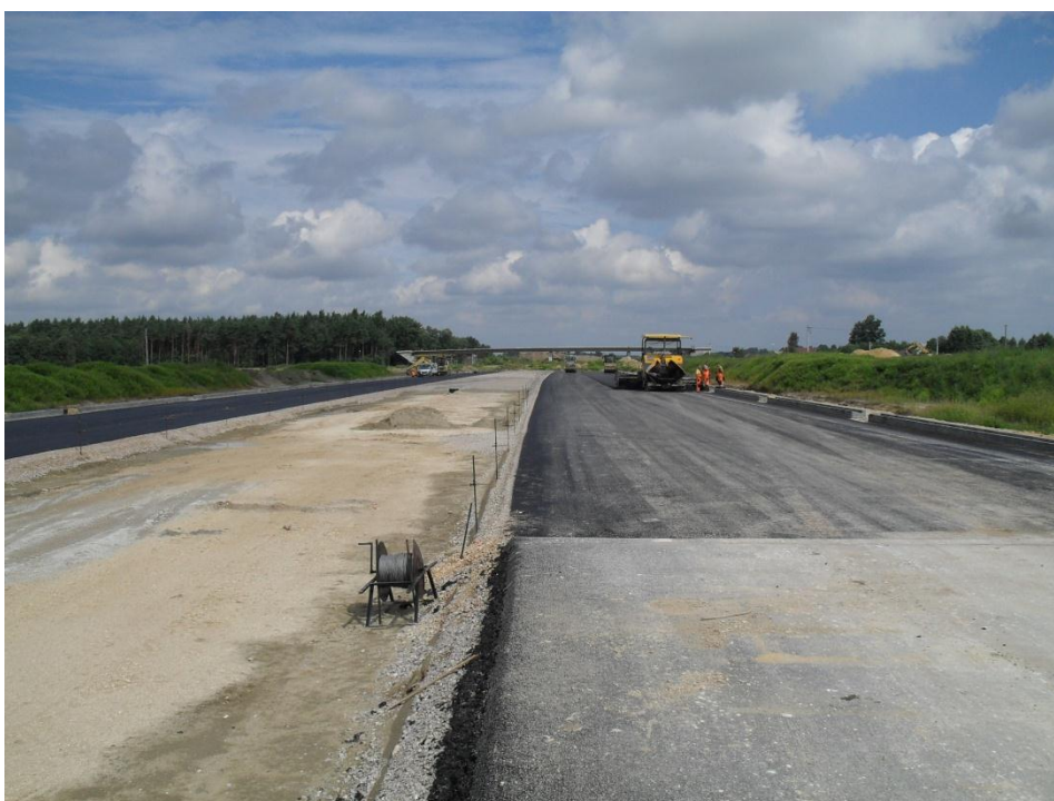
Fot 4. Prace drogowe w km 278+300
