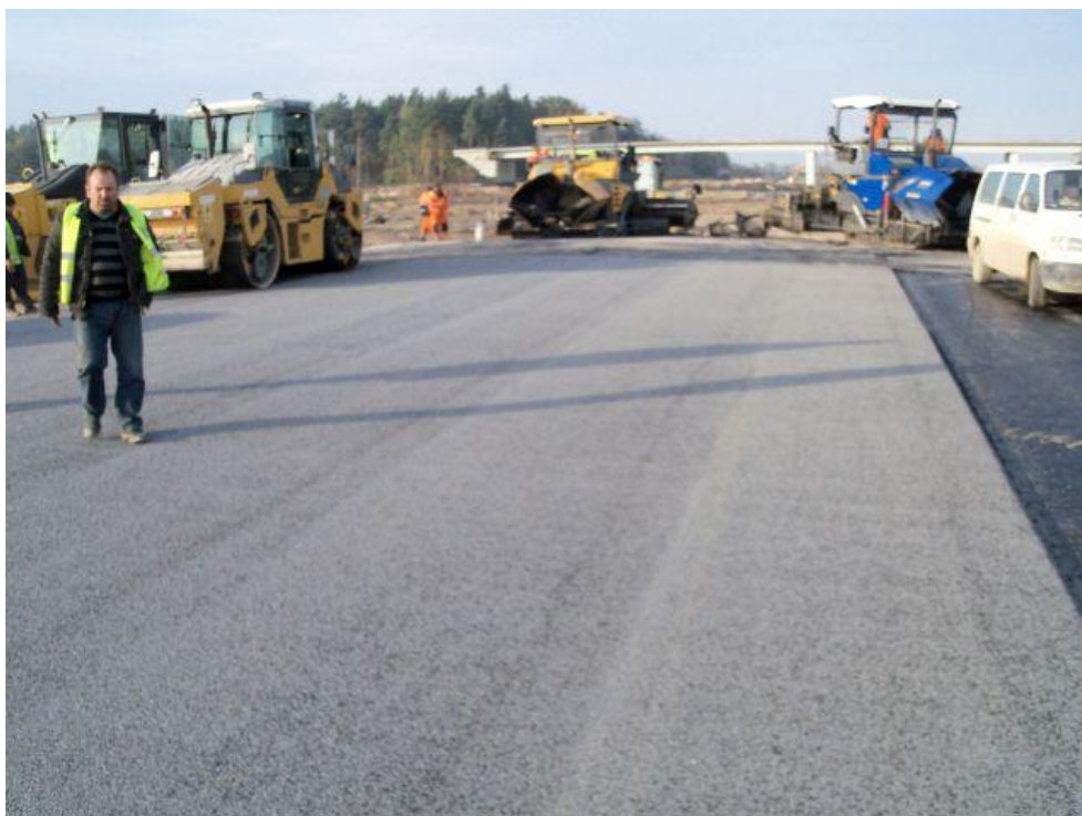
Zdjęcie 4. Odcinek próbny SMA w km 278+150 pas rozdziału, 27.10.2011
