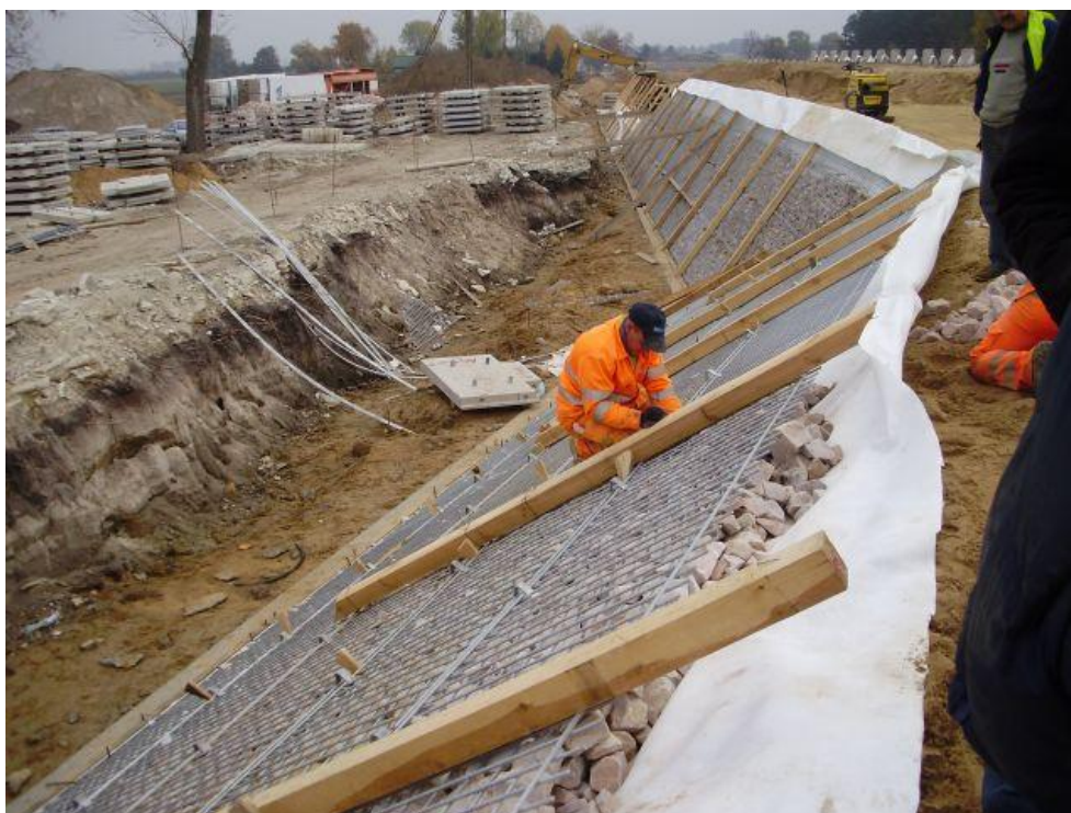
Zdjęcie 10. Umocnienie M2 dojazdu przy WD-230, 29.10.2011
