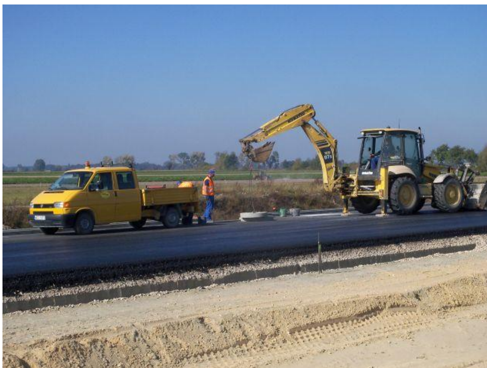
Zdjęcie 5. Wykańczanie studni ściekowych w km 272, 01.10.2011
