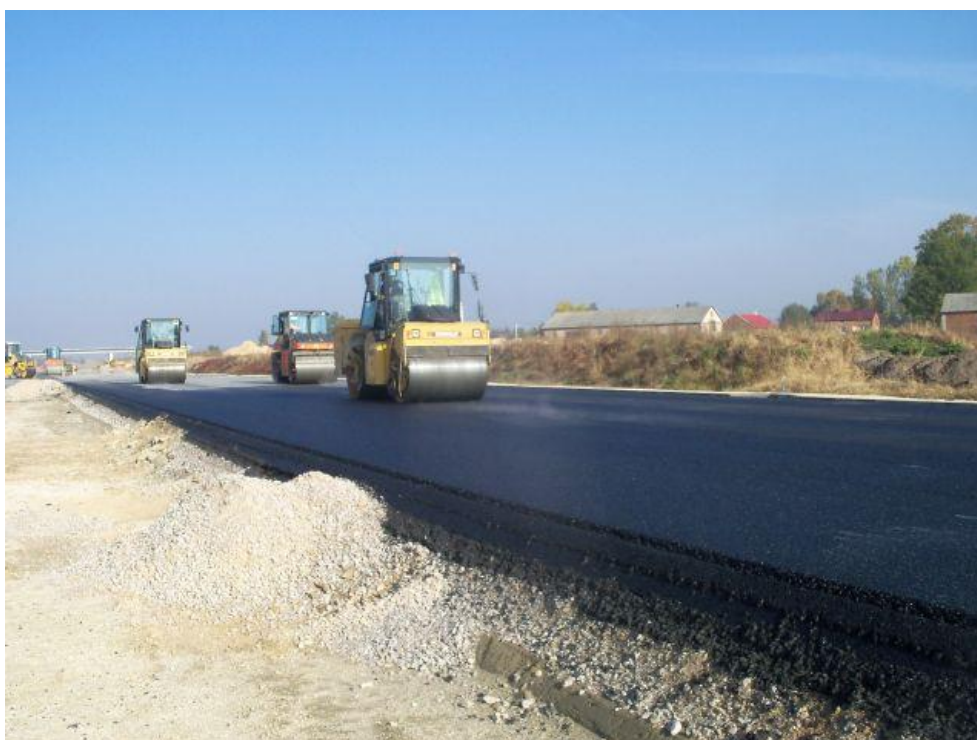
Zdjęcie 6. Warstwa SMA na odcinku 278+150 do 278+300, 28.10.2011
