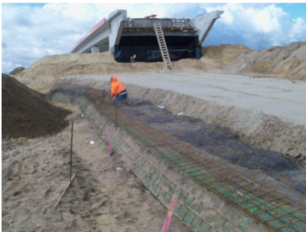
Zdjęcie 12. WD-237 skarpa nasypu zbrojona stalą, 12.10.2011
