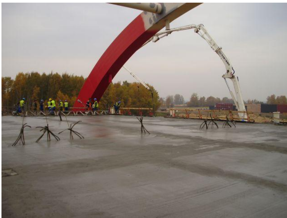
Zdjęcie 11. Kończenie betonowania płyty ustroju nośnego, 29.10.2011
