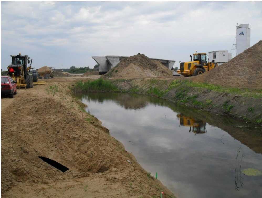
Fot4. Przesunięte siedlisko 91 zasiedlone przez płazy
