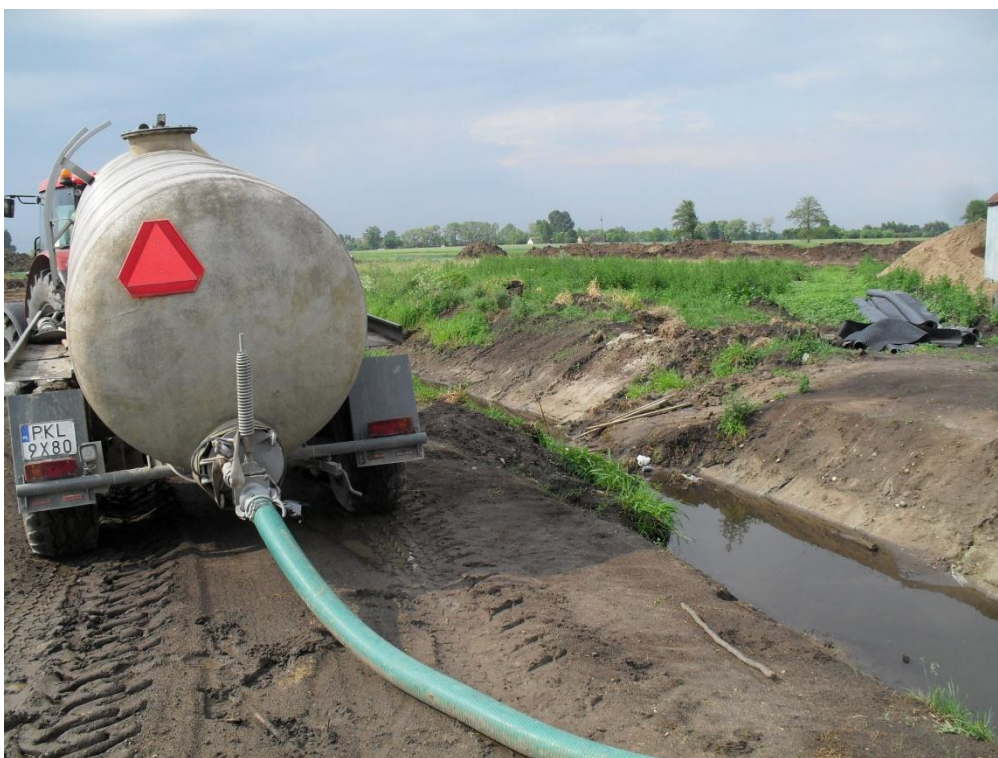
Fot5. Pobór wody do zraszania dróg serwisowych km 287+300
