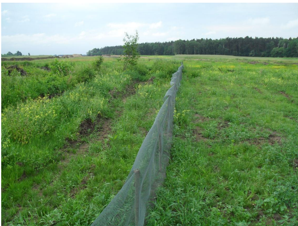
Fot3. Ogrodzenie siedliska 107 w km 277+200, przedłużone przez Wykonawcę na wniosek nadzoru
