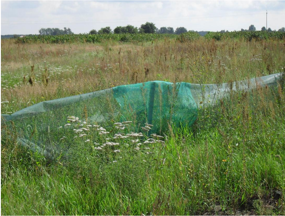
Fot2. Naprawiony fragment ogrodzenia herpetologicznego w km 284+500
