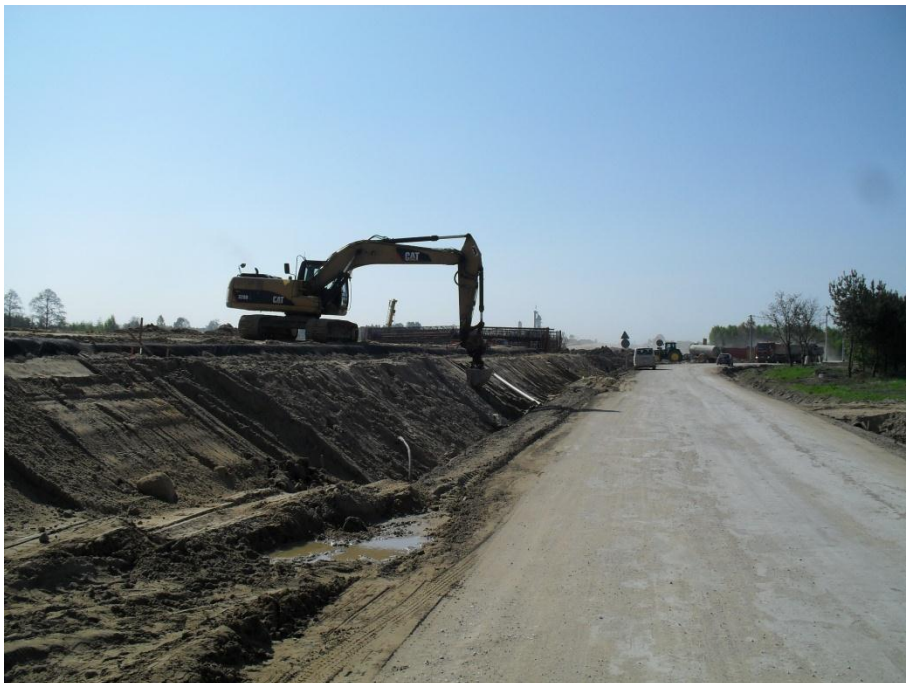
Fot1. Widok na budowę nasypu w km289+800
