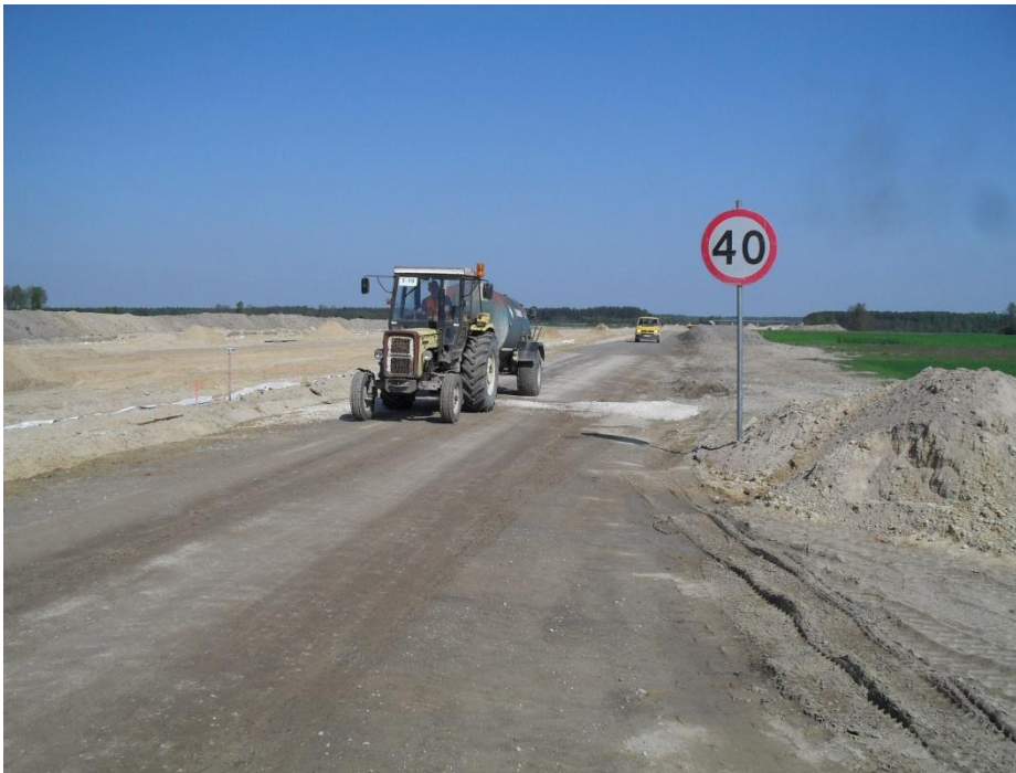
Fot5. Zraszanie dróg serwisowych km 281+000
