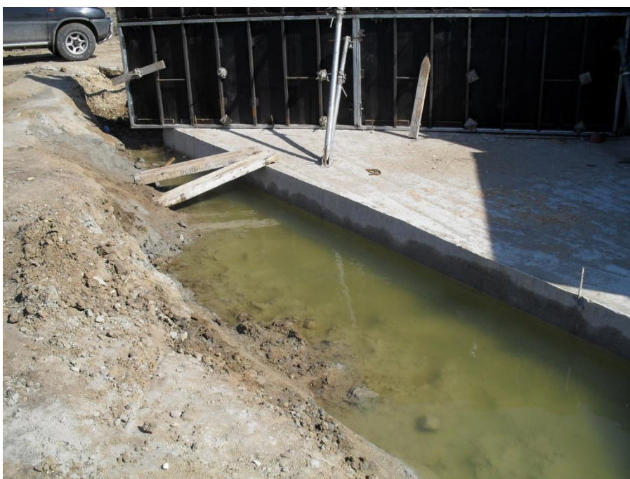
Fot3. Przy budowanych przepustach nie stwierdza się płazów, P-25 km 289+900
