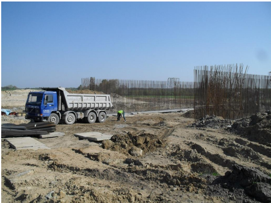
Fot2. Prace przy przejściu dla zwierząt PZ 239a
