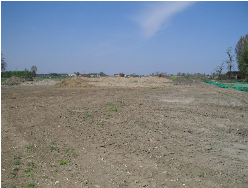
Fot2. Prace drogowe w 278+600
