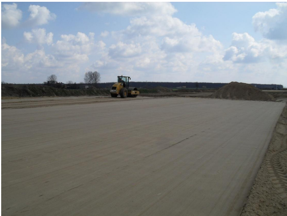
Fot3. Prace drogowe w km283+300
