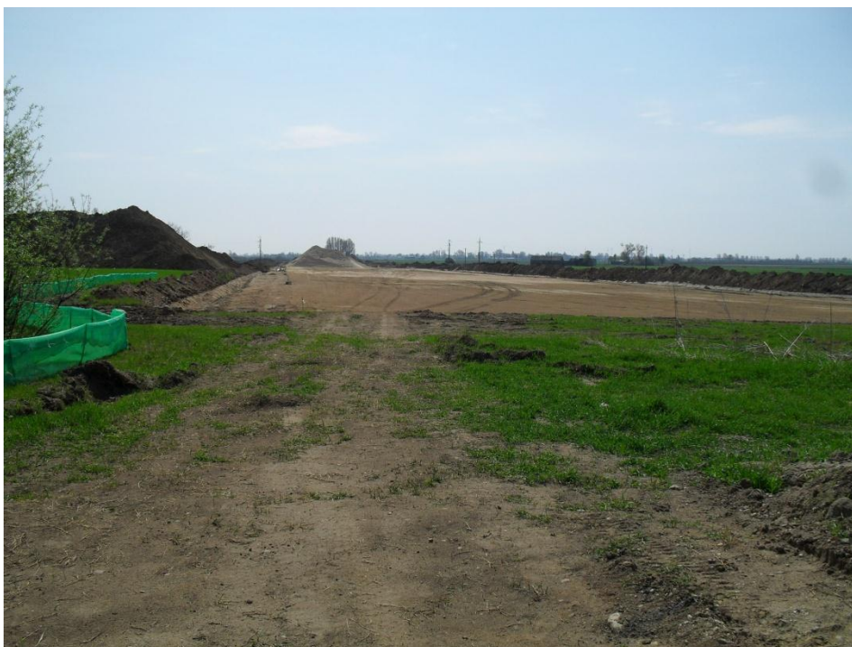
Fot1. Widok na częściowo nieodhumusowany pas drogowy km 284+100
