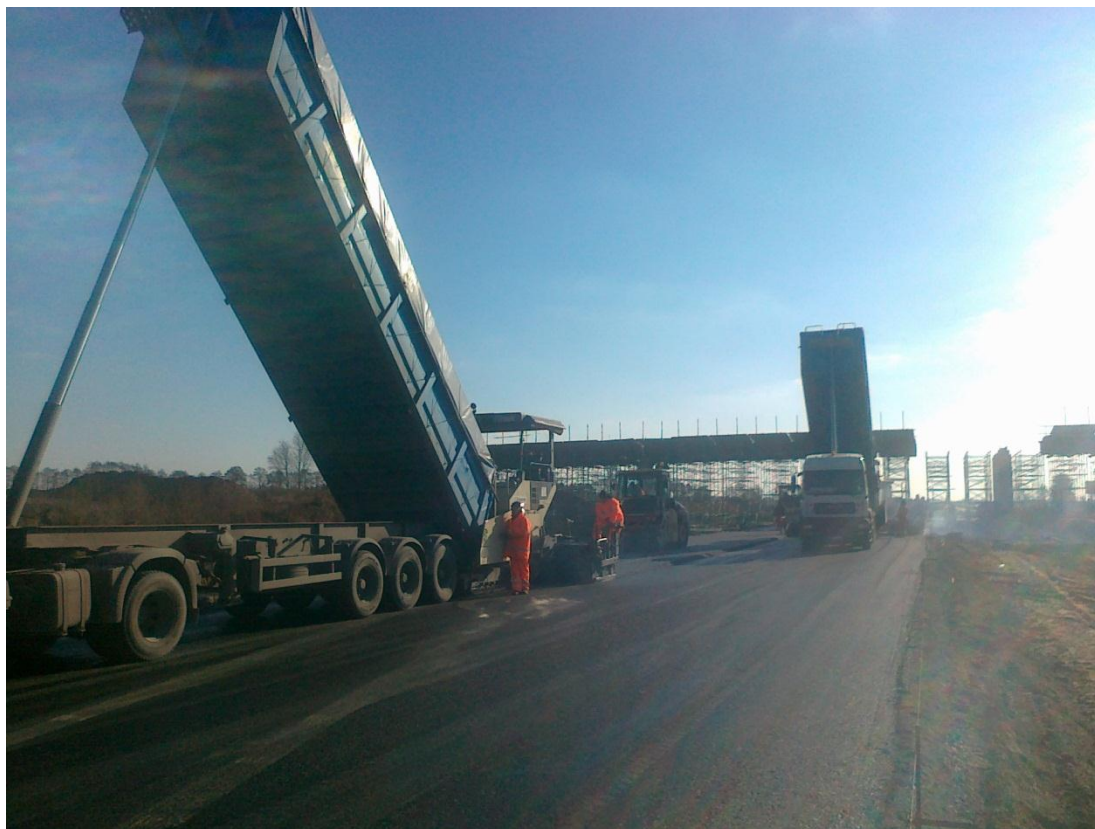
Fot. 16 Podbudowa bitumiczna 2w 268+100 11.11.2011
