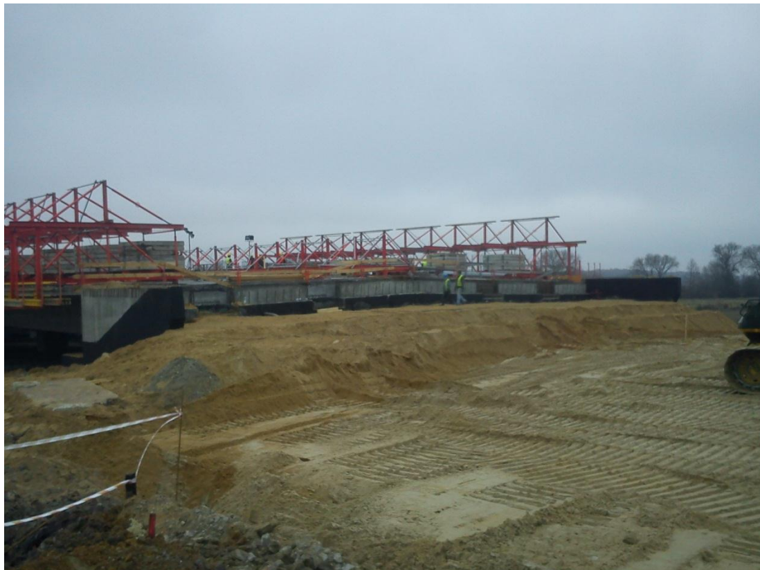
Fot. 4 Wykonanie zasyпки inżynierskiej na podporze nr 1 estakady E-221 10.11.2011
