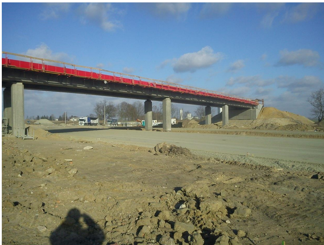
Fot. 17 Widok na obiekt WD-220 28.11.2011
