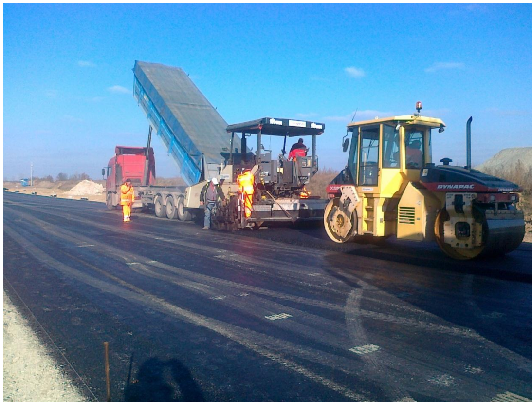
Fot. 14 Podbudowa bitumiczna 268+000 11.11.2011
