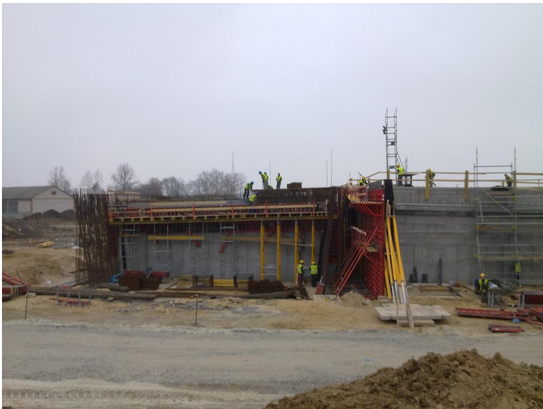
Fot. 6 Zbrojenie nitki prawej na obiekcie PG-225 15.11.2011
