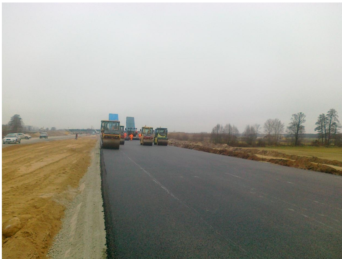
Fot. 15 Podbudowa bitumiczna 2w 268+600 13.11.2011
