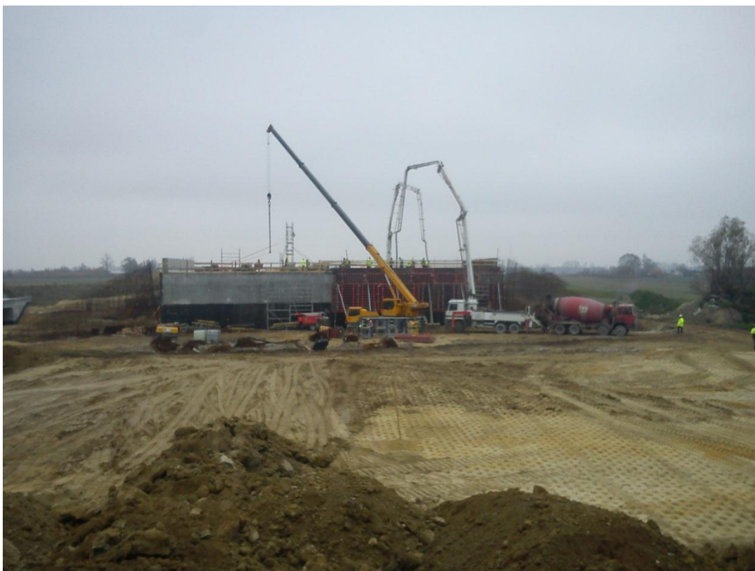
Fot. 5 Betonowanie ramy ustroju nośnego na moście autostradowym MA-228 L 10.11.2011
