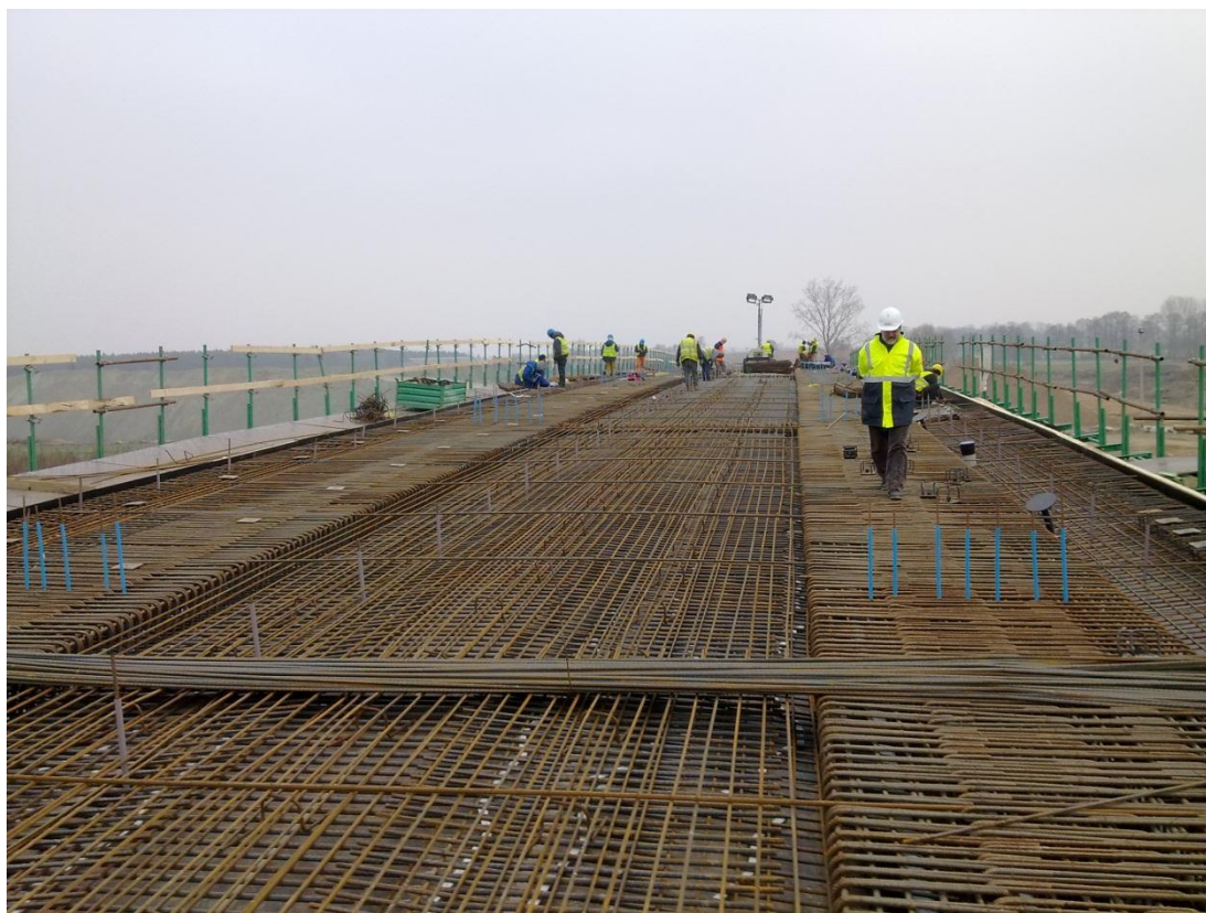
Fot. 9 Zbrojenie ustroju nośnego obiektu WD-227 24.11.2011
