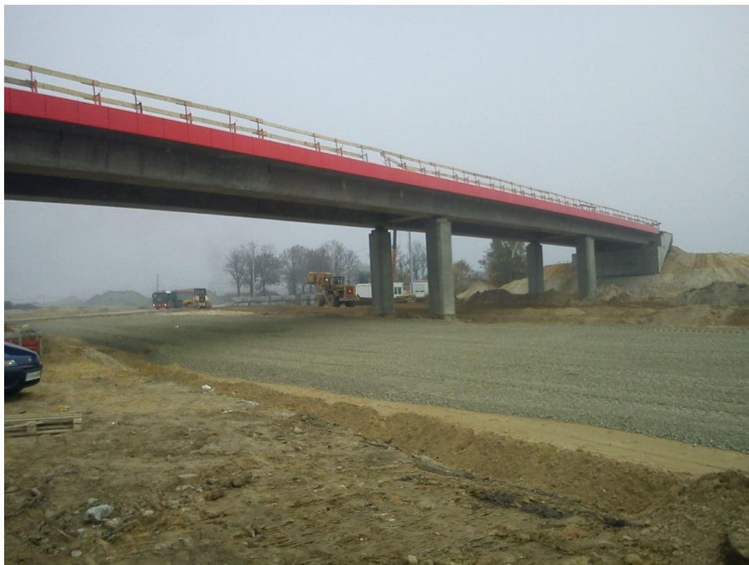
Fot. 1 Montaż desek gzymsowych na wiadukcie drogowym WD-220 3.11.2011
