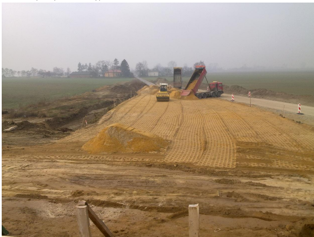
Fot. 8 Wykonywanie nasypu do wiaduktu WD-219 24.11.2011
