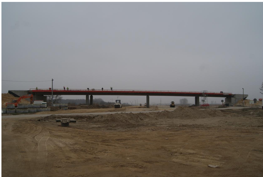
Fot. 7 Prace na wiadukcie drogowym WD-220 15.11.2011
