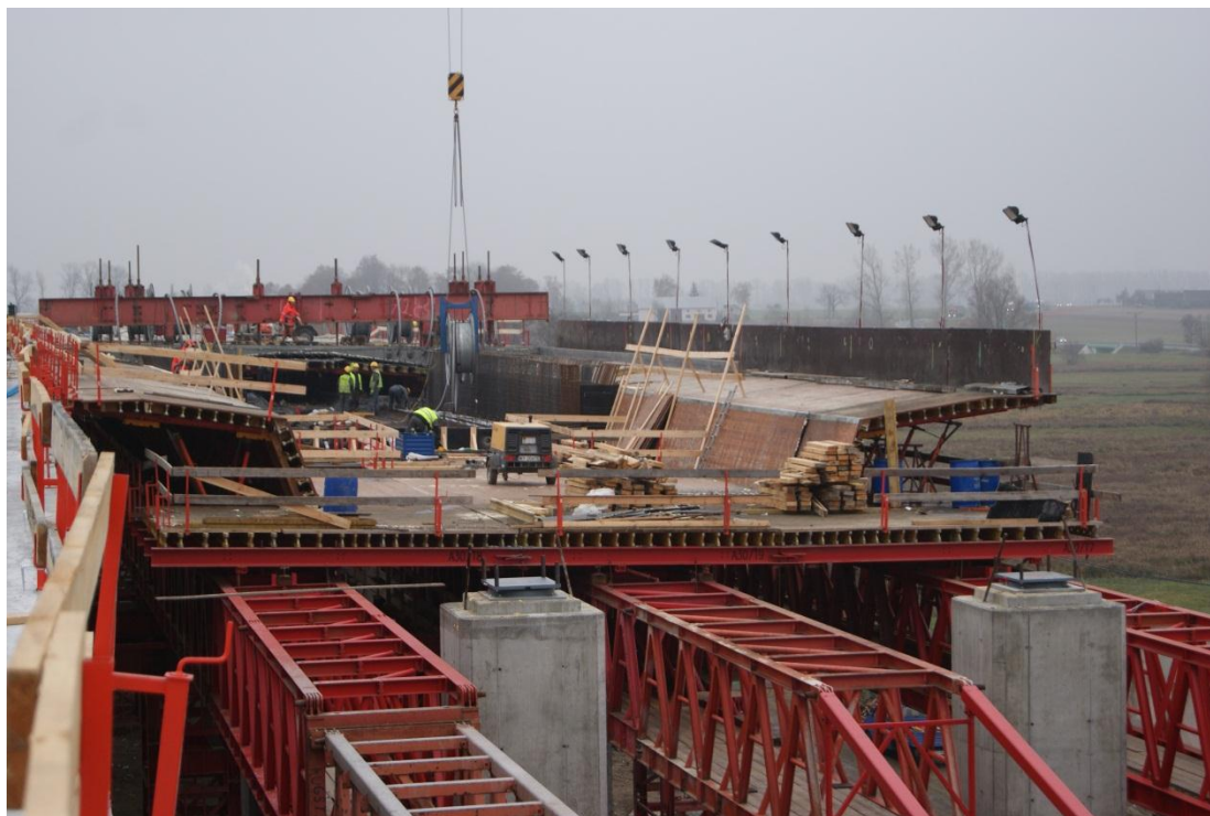
Fot. 18 Prace zbrojarskie i wżięganie kabli na przęśle estakady E-221 - nitka lewa 15.11.2011
