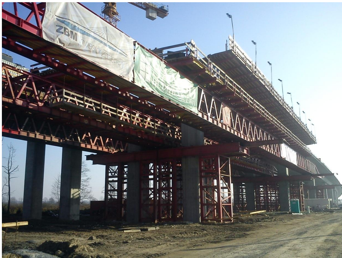
Fot. 2 Wózek do realizacji pręseł ustroju nośnego estakady E-221 07.11.2011
