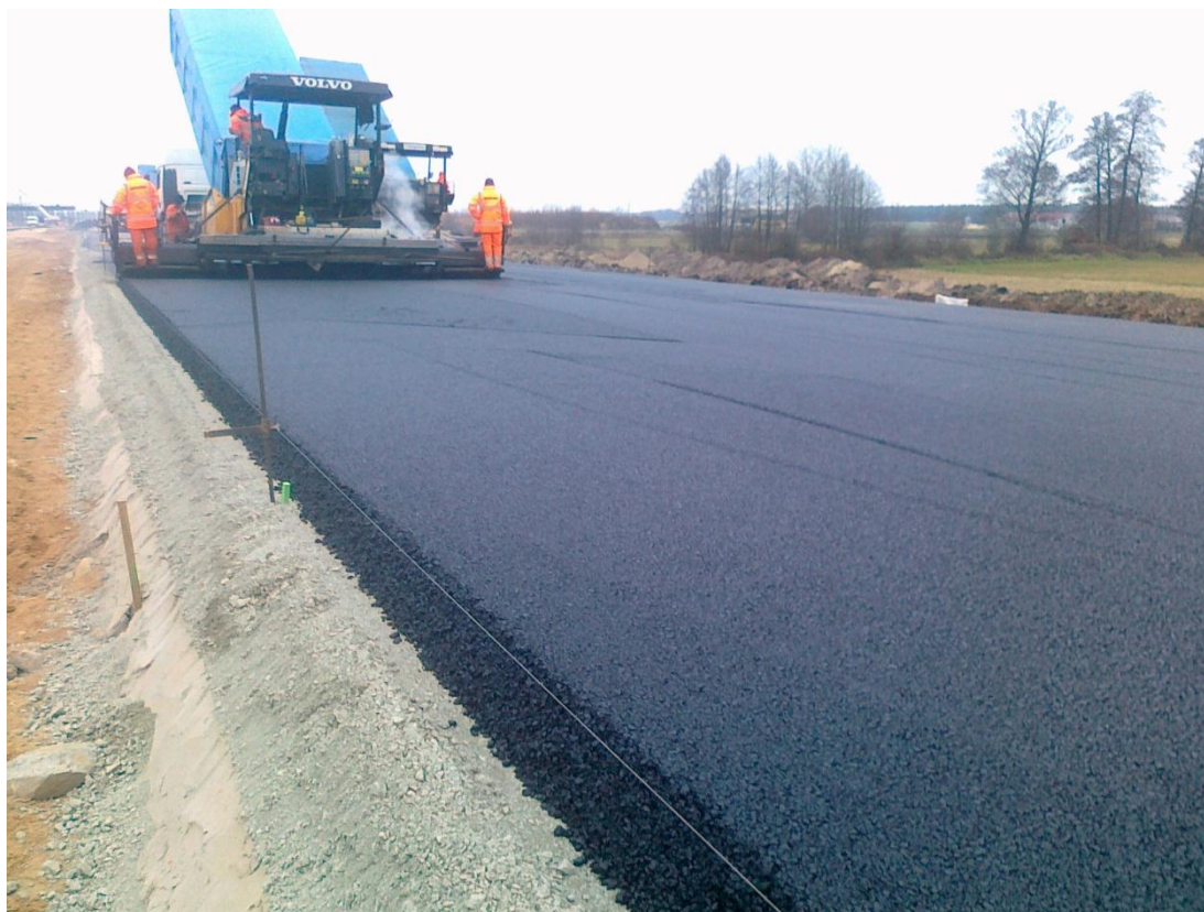
Fot. 13 Podbudowa bitumiczna 268+400 13.11.2011
