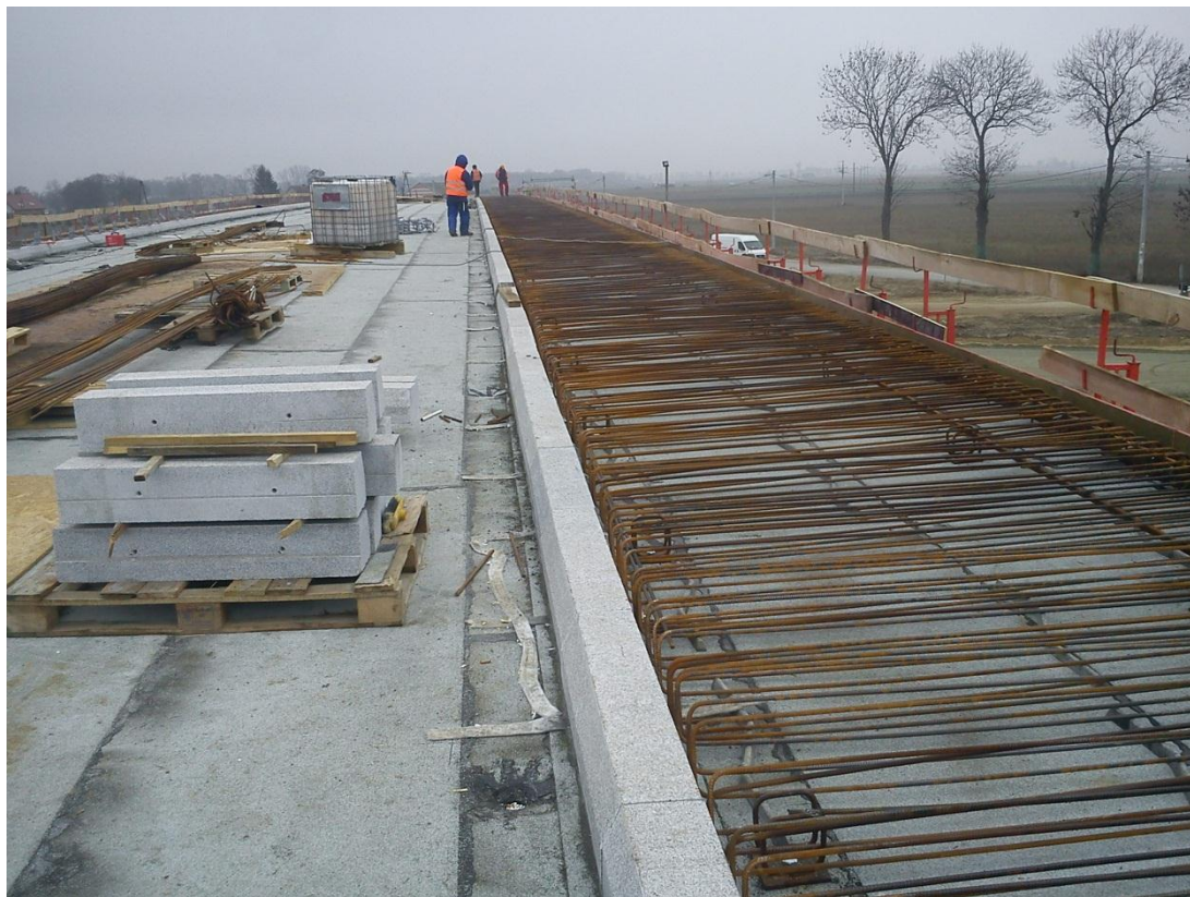
Fot. 3 Zbrojenie kap chodnikowych i wykonywanie krawężników na wiadukcie drogowym WD-220 10.11.2011
