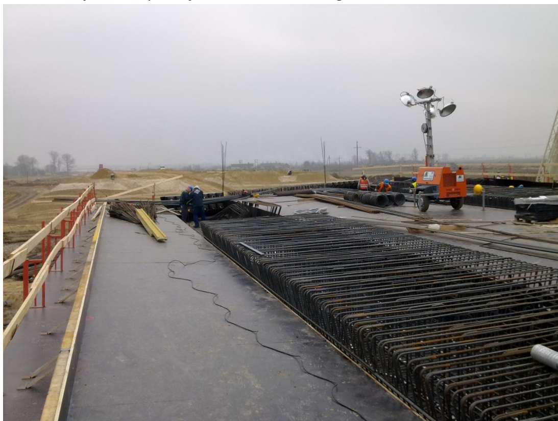
Fot. 10 Zbrojenie ramy lewej mostu autostradowego MA-228 24.11.2011
