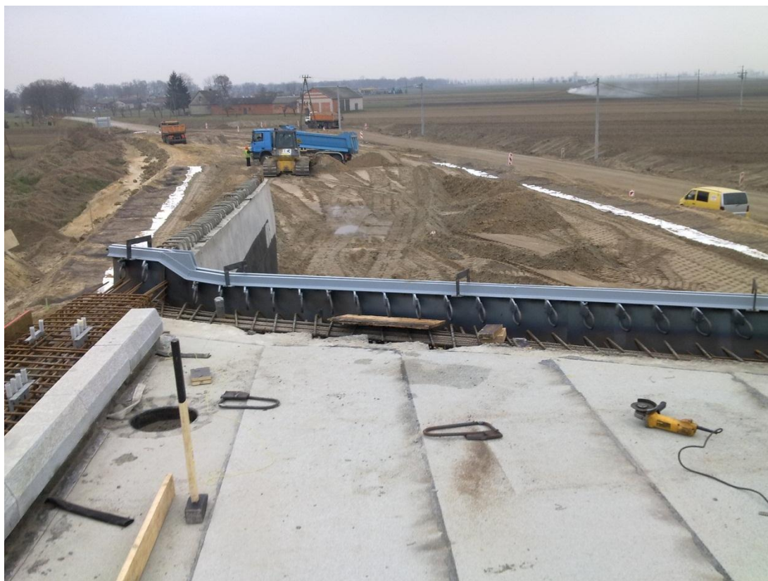
Fot. 11 Montaż dylatacji na wiadukcie WD-220 30.11.2011
