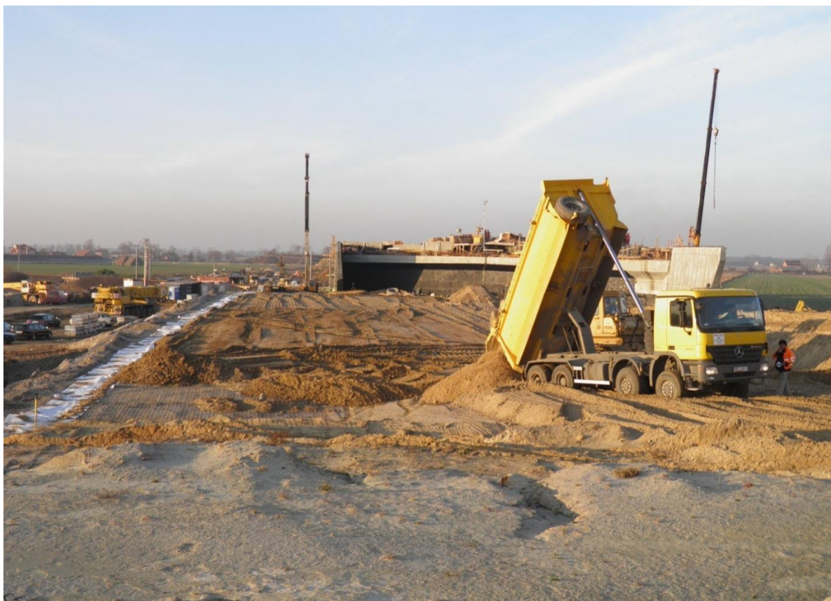
Wykonywanie warstwy nasypu w km 252+990-253+110
