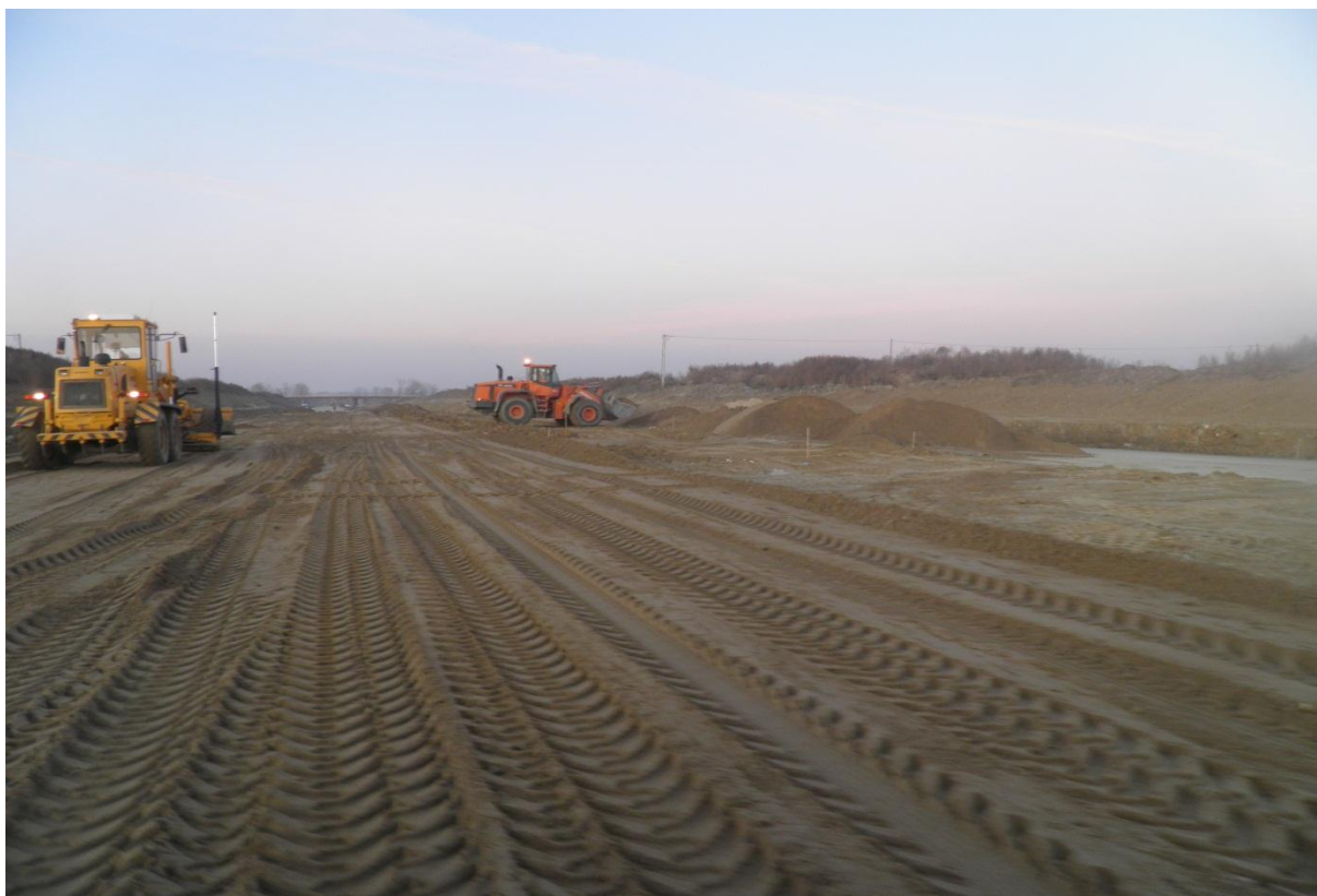
Wykonywanie warstwy mrozochronnej km260+300-261+000
