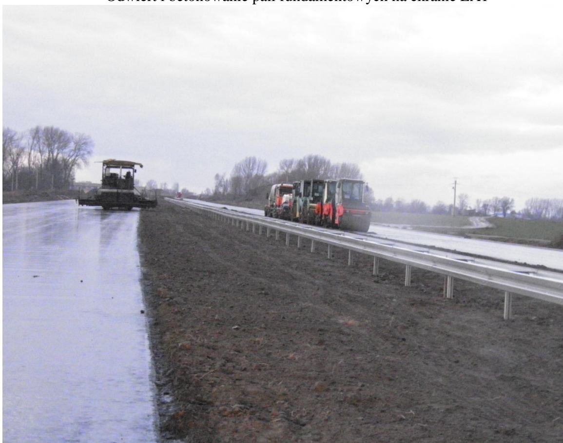
Wykonana bariera stalowa SP-07 km 246+600-246+900
