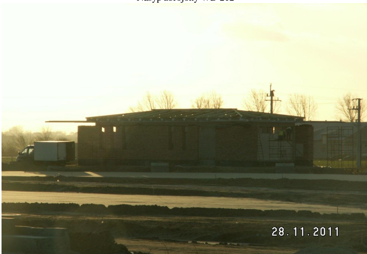
Budowa obiektów małej Architektury MOP Krzyżanów
