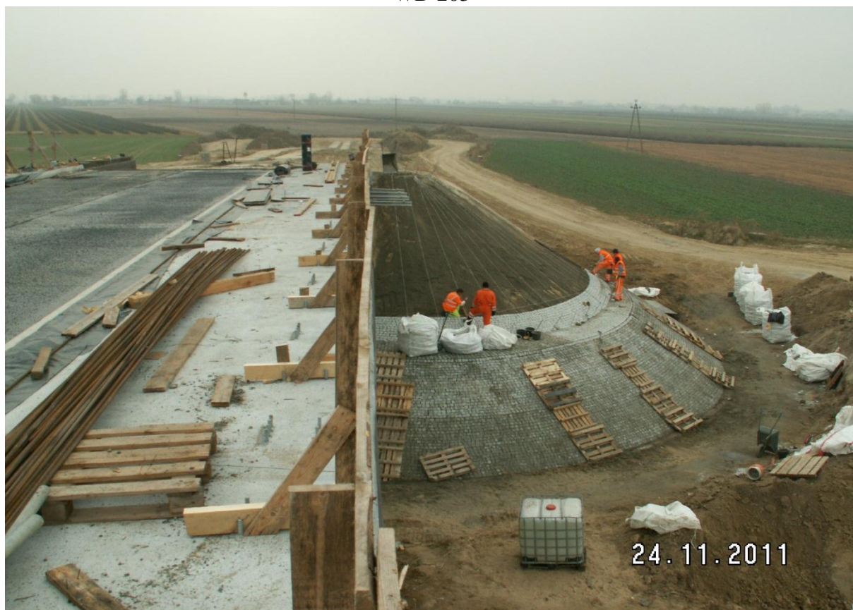
WD 204-umacnianie stożka kamienna kostka granitową
