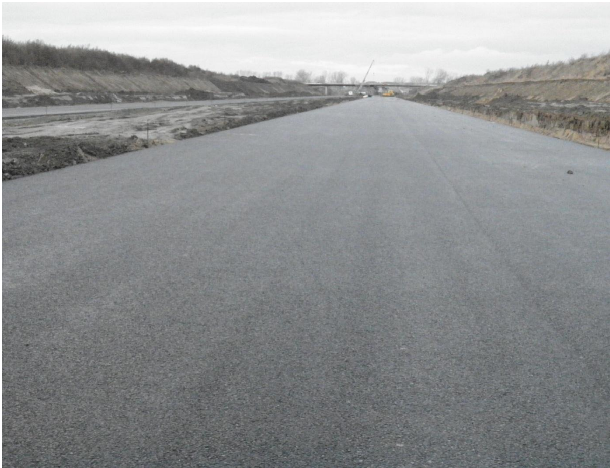
Wykonana I warstwa podbudowy z betonu asfaltowego o wysokim module sztywności km 260+350-261+000
