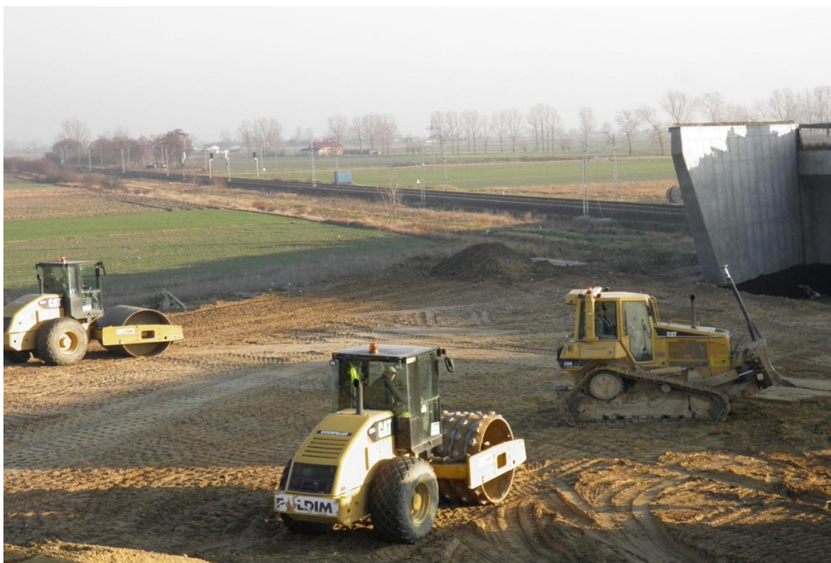
Wykonywanie warstwy nasypu w km 252+850-252+909
