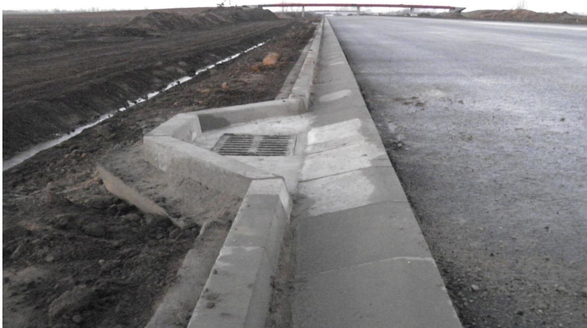
Ściek z prefabrykowanych elementów betonowych trójkątnych.
