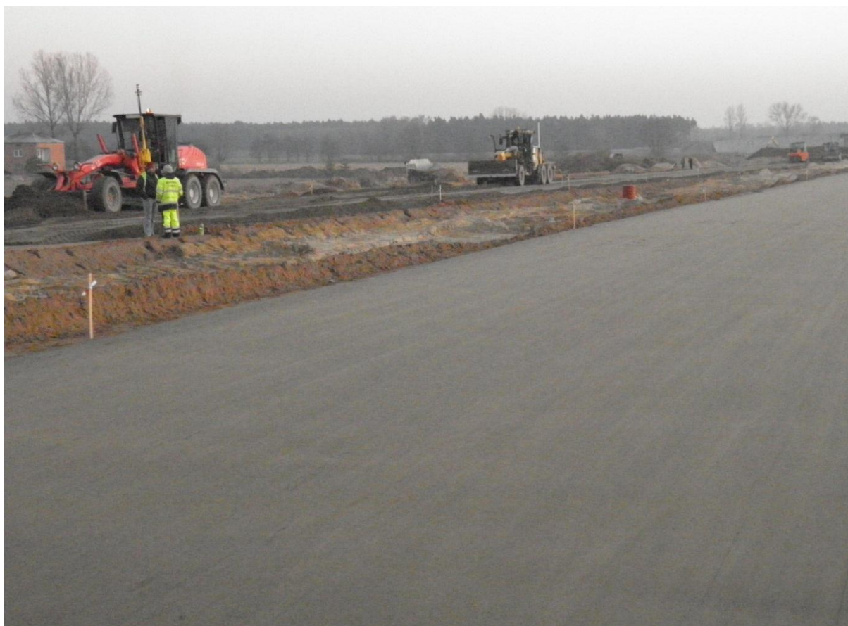
Wykonywanie warstwy kruszywa stabilizowanego cementem gr 20 cm o R_m=5\text{Mpa} km 256+200-256+500
