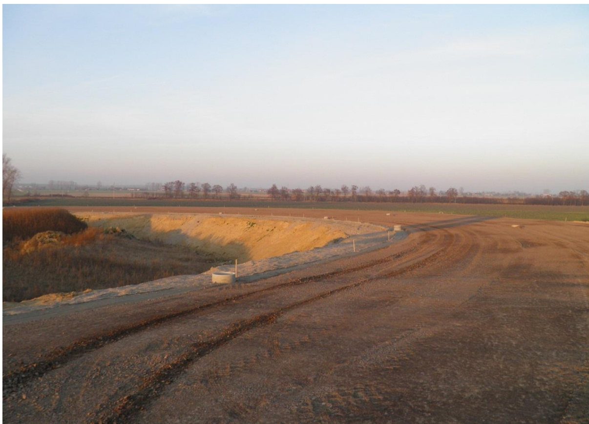
Wykonana I warstwa podbudowy z kruszywa łamanego 0/31,5 stabilizowanego mechanicznie ŁBC 0+200-0+380
