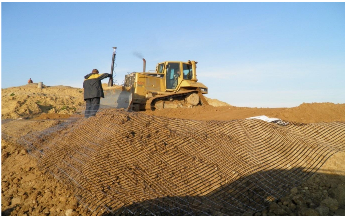
Zbrojenie wysokich skarp nasypu w km 252+850-252+909
