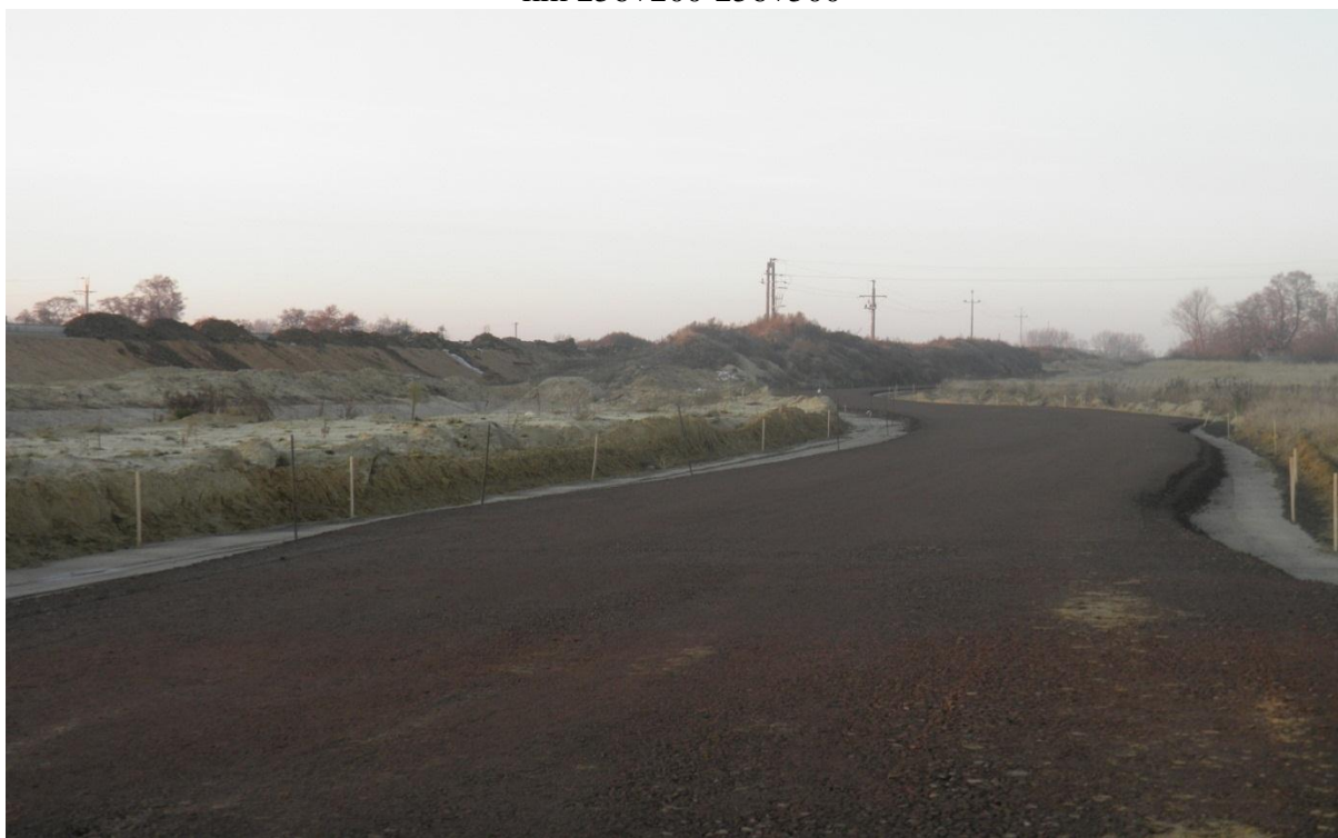
Warstwa podbudowy z kruszywa łamanego 0/31,5 stabilizowanego mechanicznie DW256LA
