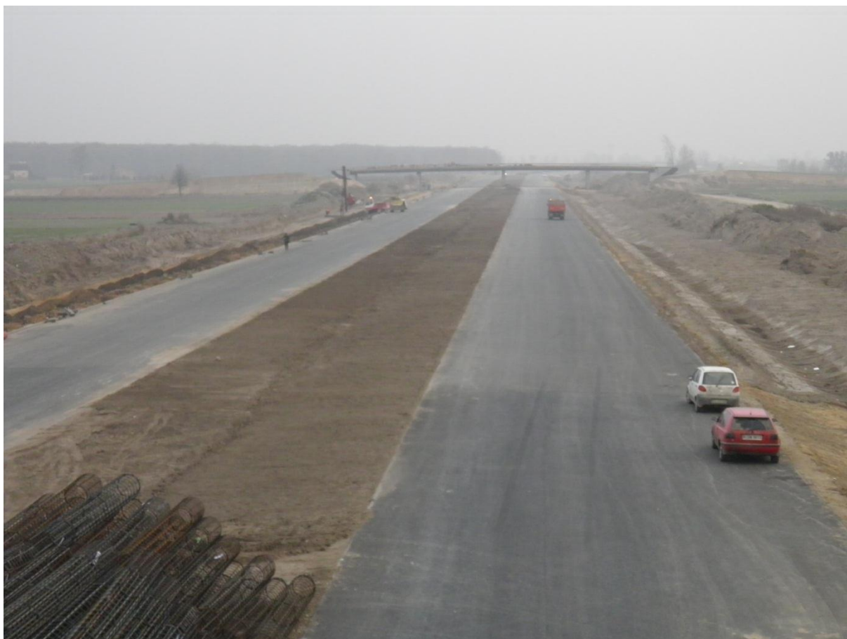
Humusowanie pasa środkowego, skarpy str. P km 247+950
