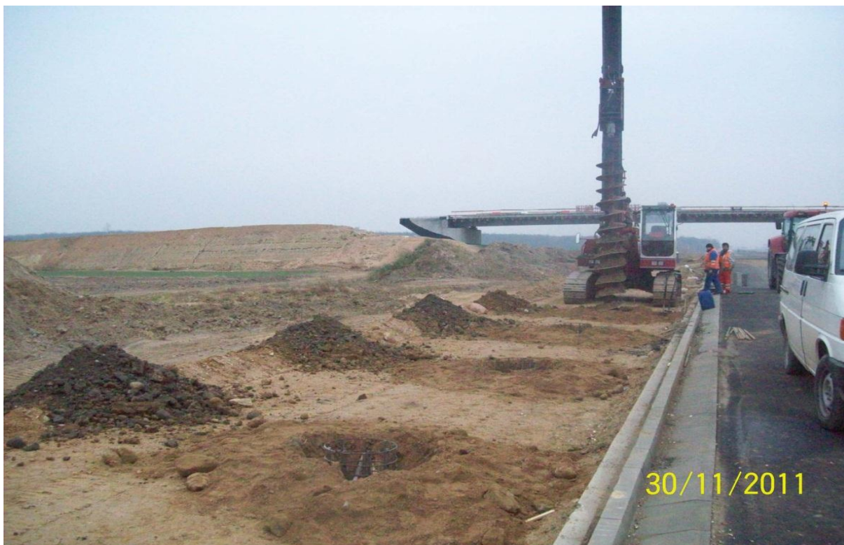
Odwiert i betonowanie pali fundamentowych na ekranie EA1
