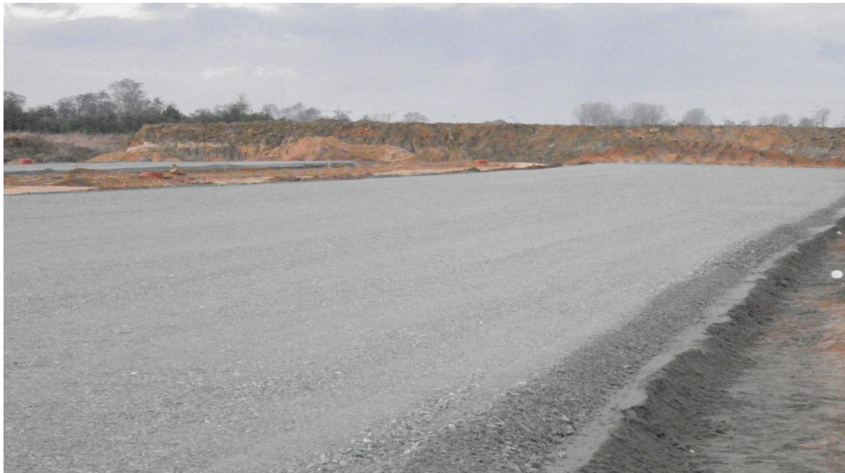
Wykonana I warstwa podbudowy z kruszywa łamanego 0/31,5 stabilizowanego mechanicznie km 256+600-258+750
