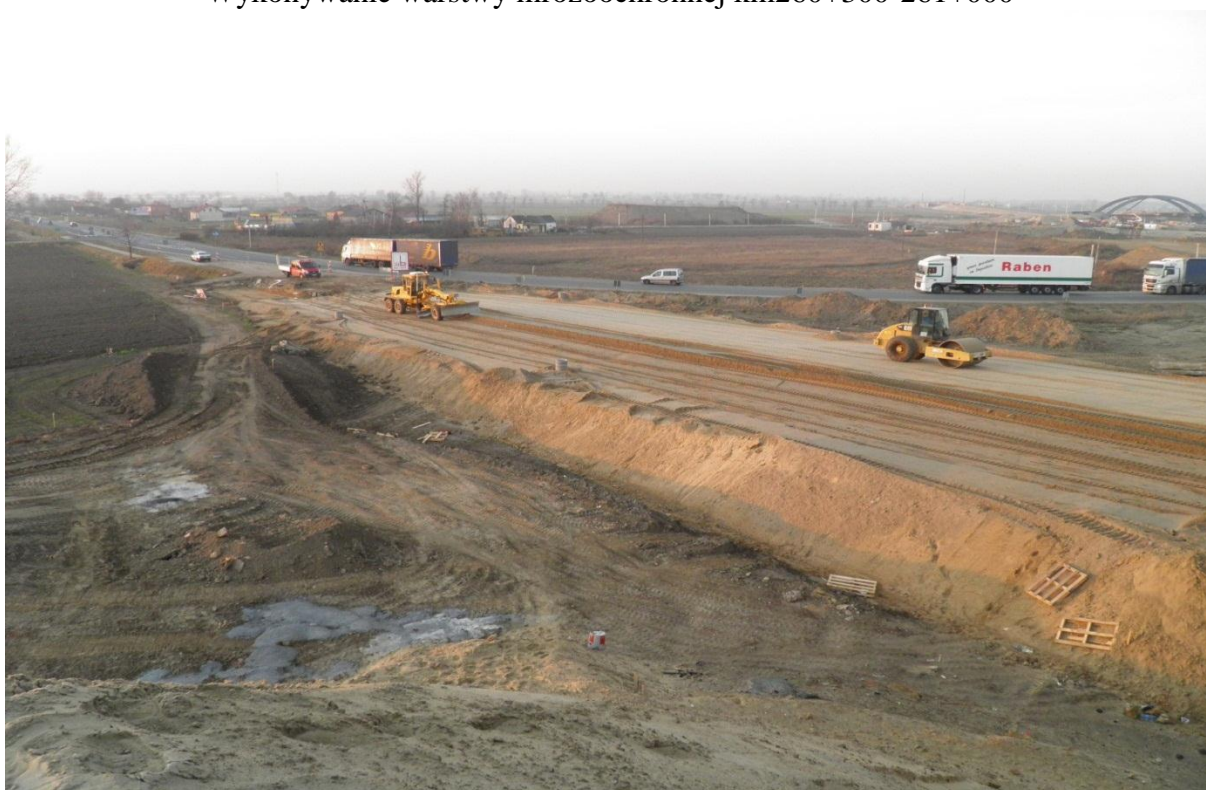
Wykonywanie górnej warstwy nasypuDK92 km 0+500-0+880
