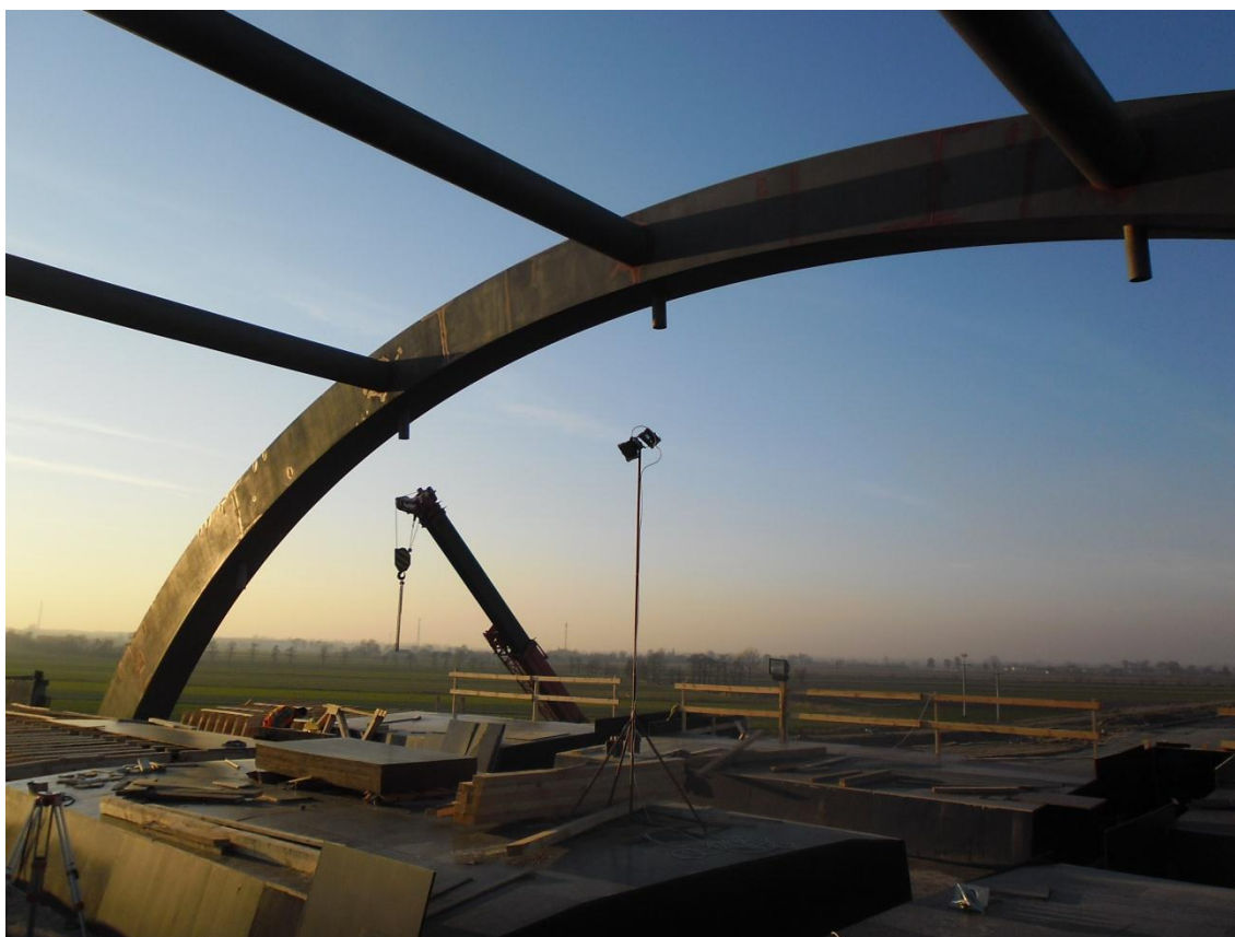
Szalowanie i zbrojenie płyty ustroju nośnego WD 210
