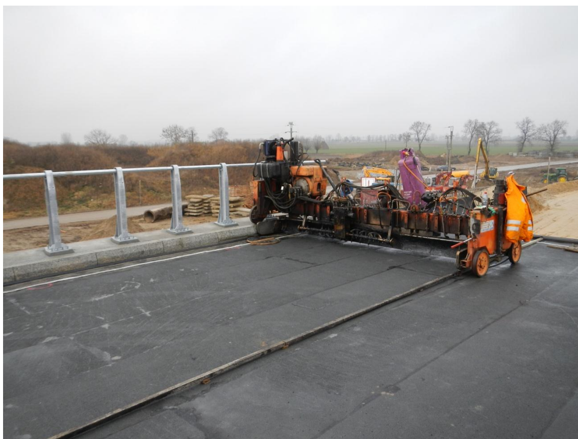
Przygotowania do asfaltu twardo lanego WA-208
