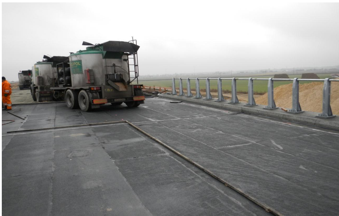
Przygotowania do asfaltu twardo lanego WA-208
