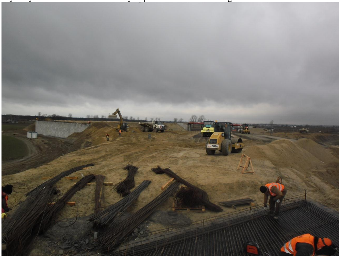
Zbrojenie płyty przejściowej obiektu WD-211 oraz prace przy ścianie oporowej na Węzle Kotliska
