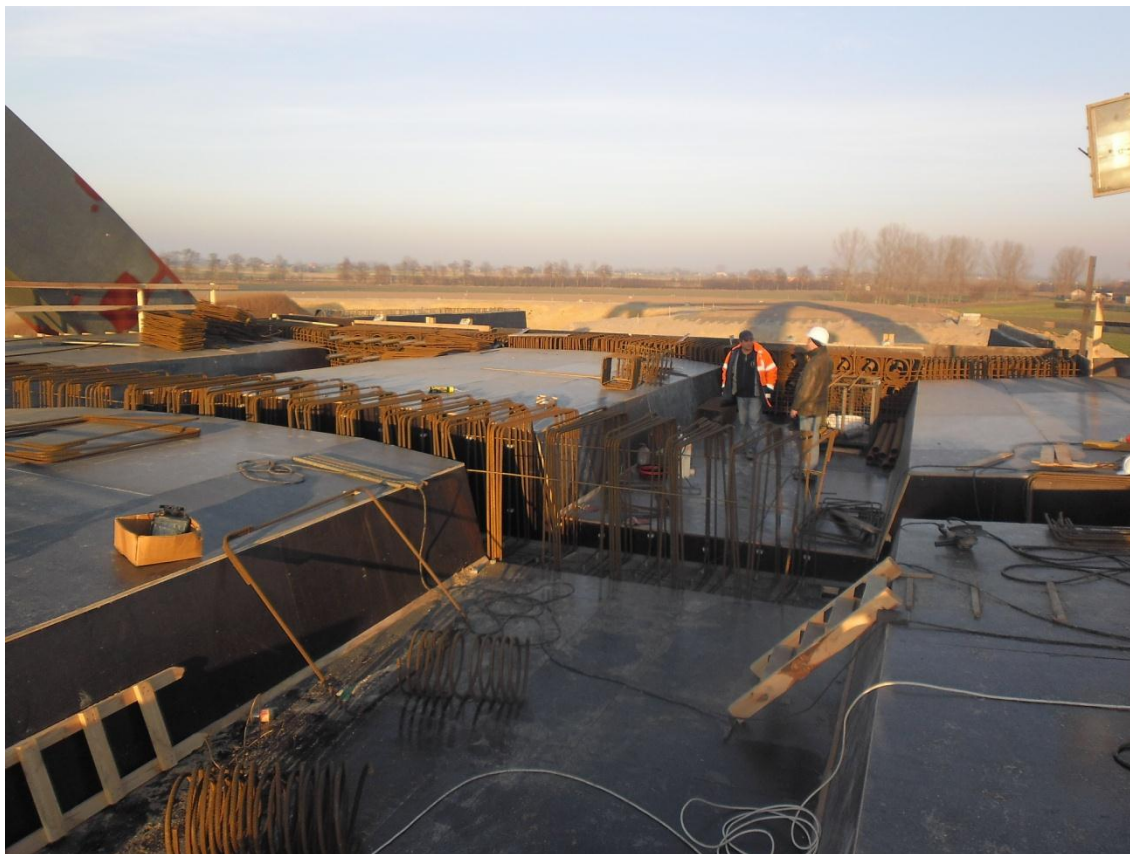
Szalowanie i zbrojenie płyty ustroju nośnego WD 210
