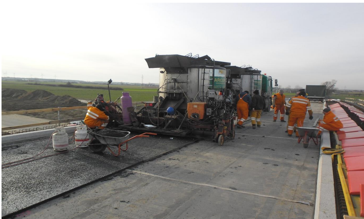
Asfalt twardo lany na obiekcie WD-207
