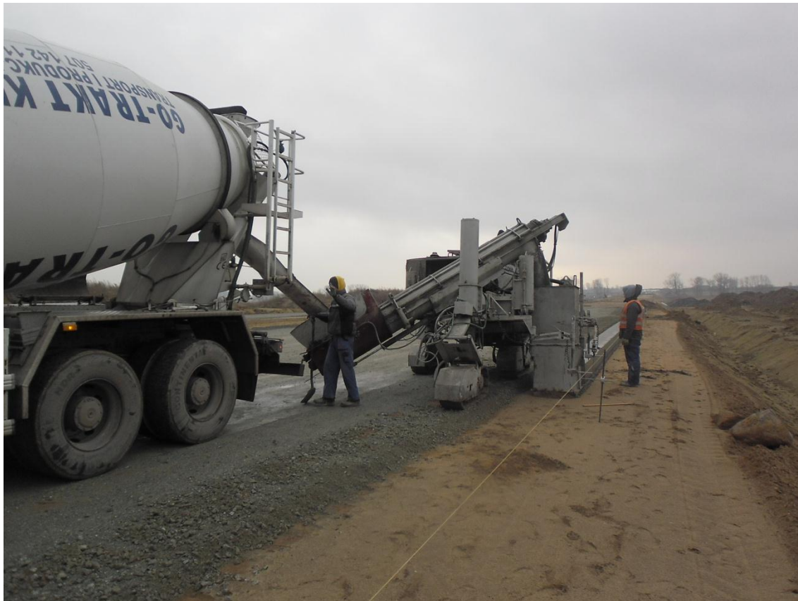
Wykonywanie łąw fundamentowych pod ścieki w technologii Power Curber
